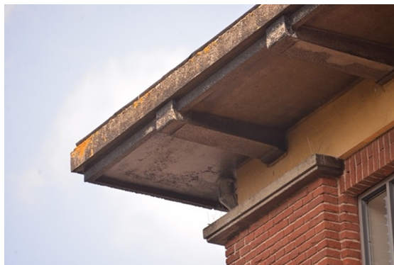
3) Detail van Schokbeton van granietgruisbeton. (foto 2023, P.J. De Vos, ELO)
