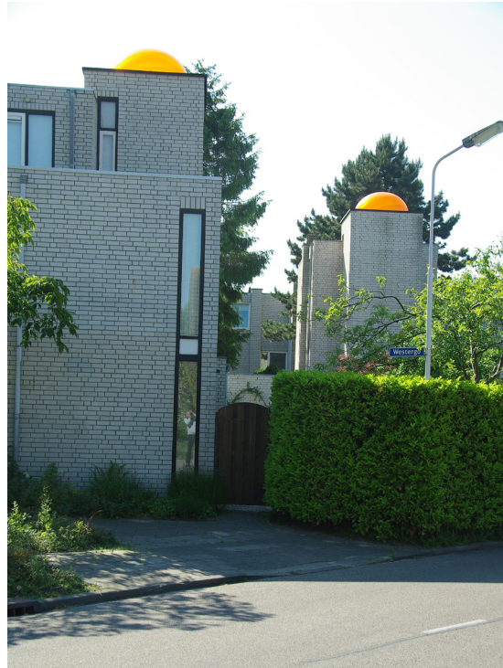
2) Koepelwoningen van Benno Stegeman (1973) met kalkzandsteen en een kunststoffen koepel. (foto Ronald Stenvert)
