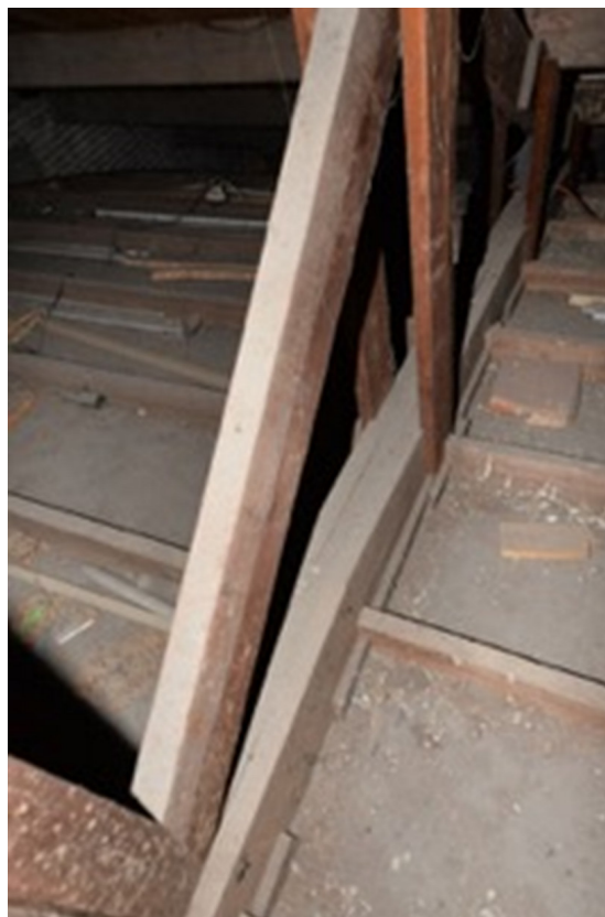
9) Detail spant met onderligger van drie lagen planken. (foto 2022, E.D. Orsel, ELO)
