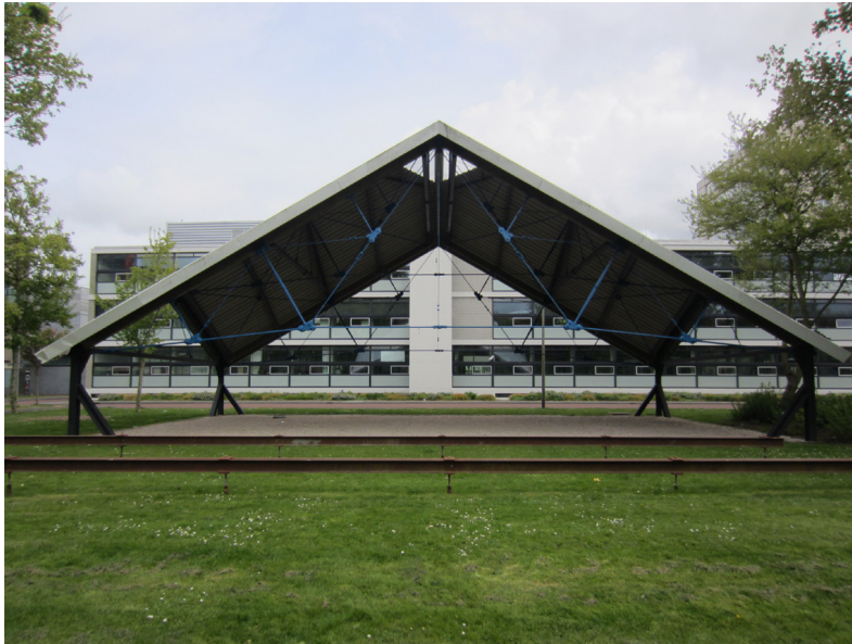
9) Tentoonstellingspaviljoen in Delft met polonceauspanten (blauw geverfd) afkomstig van de rijloods uit 1878 van de Doelen in Leiden (ELO, E.D. Orsel, 2017)
