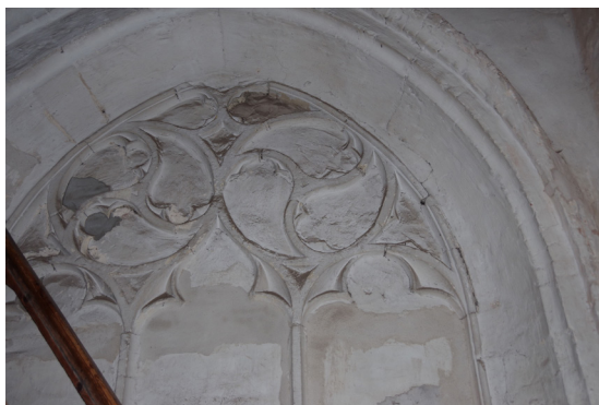
2) Deel van de dichtgezette traseringen in de Mariakerk uit het eerste kwart van de zestiende eeuw.
