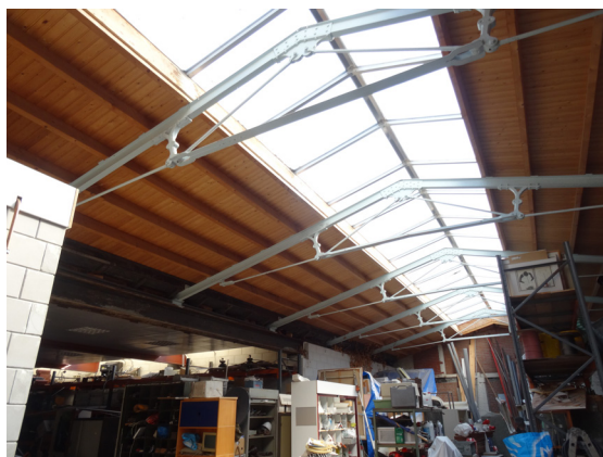
1) Leidse Polonceauspanten op een loods van de machinefabriek in Delft (ELO, E.D. Orsel, 2022)
