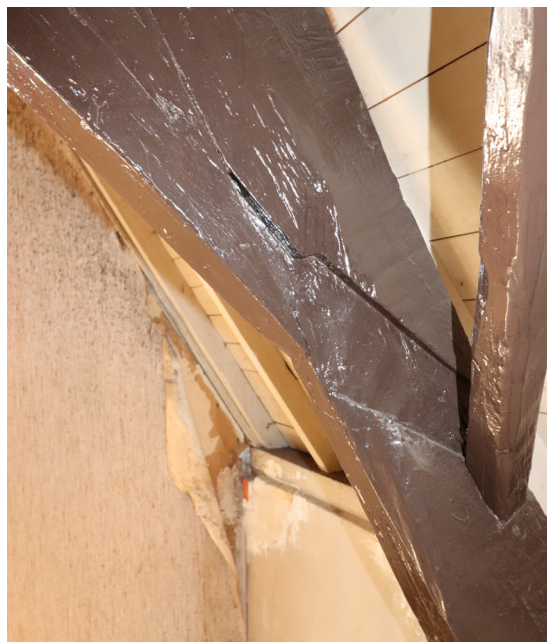
11) De keep voor een hakvormige lip in een hergebruikt spantbeen in Smedestraat 12 in Haarlem. (herkomst: Erfgoed Haarlem)
