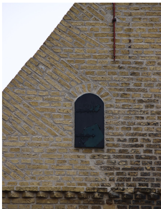
6) Oosterlaan 9 te Hollum, ventilatieopening voorzien van een luik dat inmiddels is dichtgezet. (foto R. Boter)
