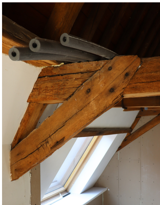
4) en 5) Doorsnede over de kapconstructie van Gedempte Oude Gracht 46 in Haarlem. Het lichter gekleurde korbeel is als enige van naaldhout. (herkomst: Erfgoed Haarlem)
