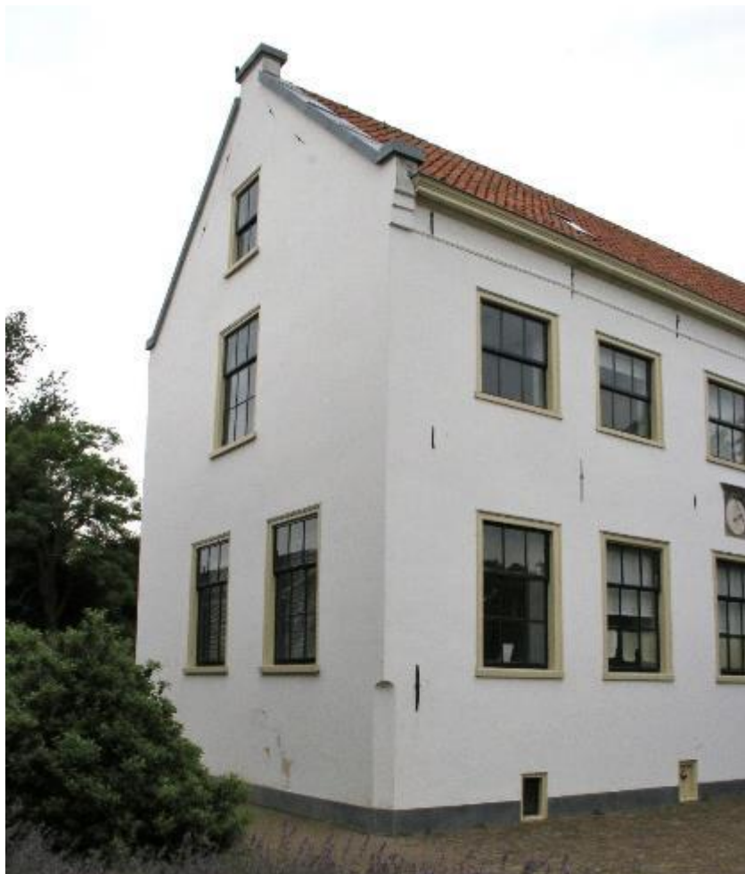
afbeelding 136 Foto van de westgevel gezien vanaf de binnenhof 2022.
