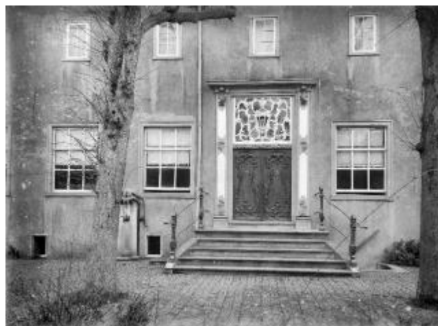
afbeelding 56 Foto van de zuidgevel met trap en entree van het Weeshuis 1923. Fotograaf W.C.L.A. Scheepens 26 November 1923 (Rijksdienst Cultureel Erfgoed, Amersfoort, 2022) 06830
