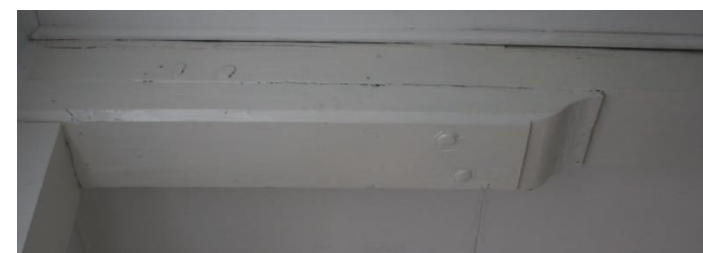
afbeelding 148 Foto van moerbalk (bouwtijd) met sleutelstuk (1924). Noordgevel bel-etage noordgevel bel-etage (0.06) 2022.
