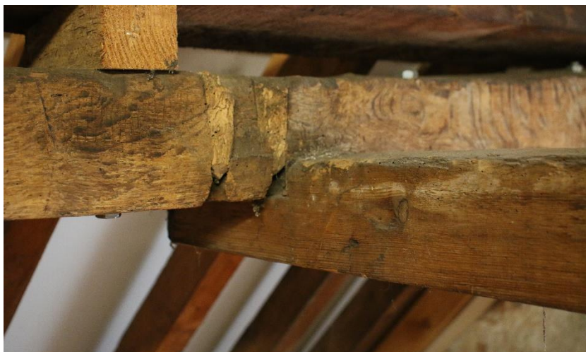
afbeelding 158 Foto van flieringbalk 2022. Links naast de hangbalk zijn twee doorgezaagde vlotgaten met houtprop zichtbaar.
