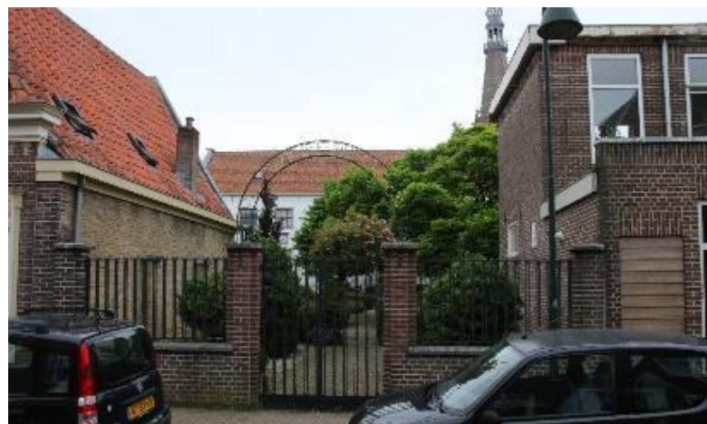
afbeelding 91 Foto van de toegangspoort met hekwerk daterend uit de jaren dertig (XX) gezien vanuit de Bagijnhof in de richting van het binnenhof en de zuidgevel van het Weeshuis 2022.
