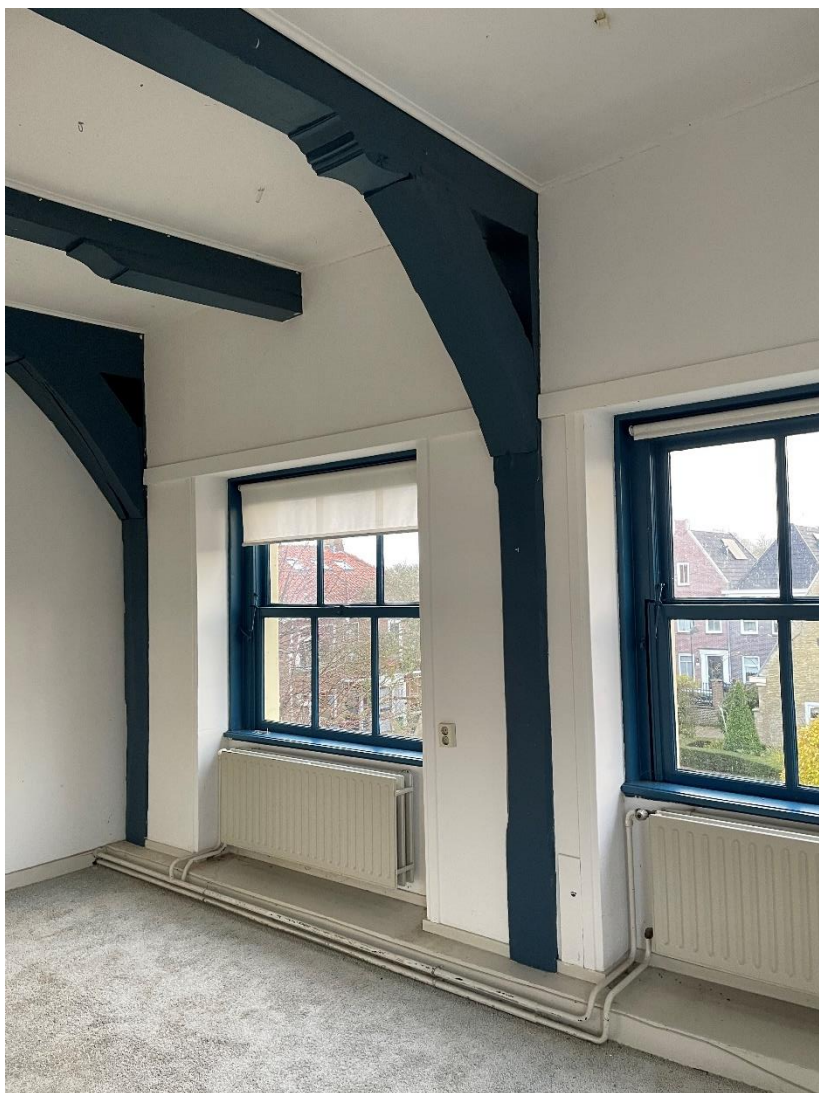
afbeelding 149 Foto zuidgevel verdieping (1.03) 2022. Moerbalk, sleutelstuk, korbeel, muurstijl en tussenbalk, met sleutel uit bouwtijd.
