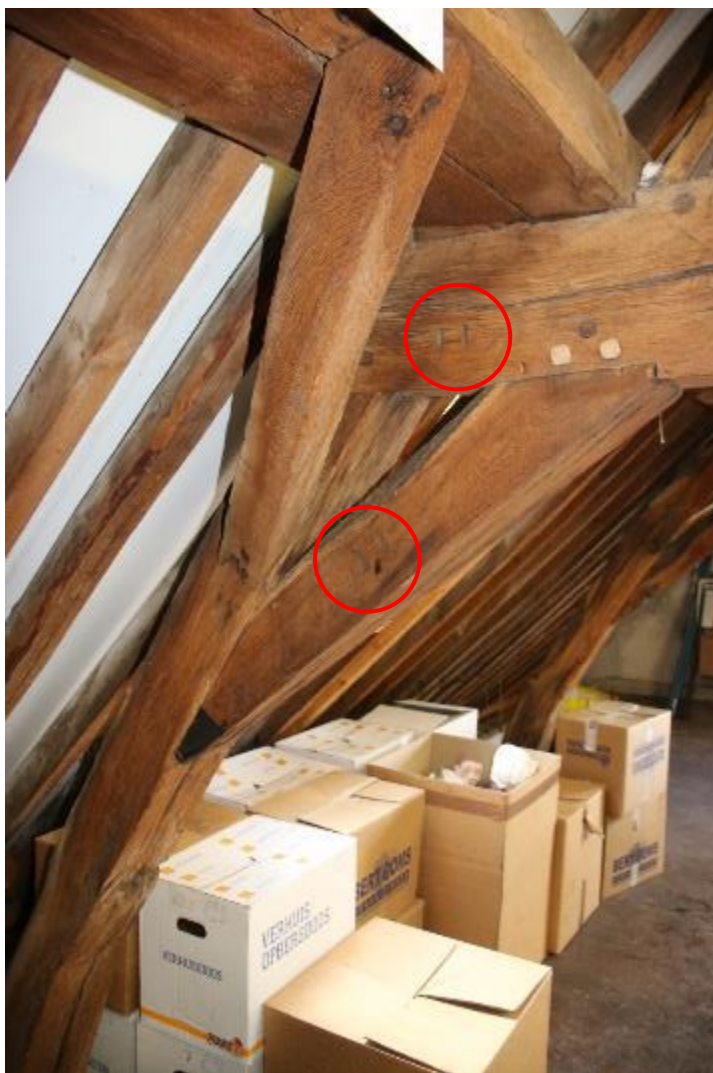
afbeelding 165 Foto juk1 zuid telmerk II op korbeel en dekbalk 2022.
