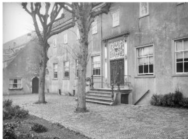
afbeelding 57 Foto van de zuidgevel van het Weeshuis 1923. Links de aanbouw uit 1647. Fotograaf W.C.L.A. Scheepens 26 November 1923. (Rijksdienst Cultureel Erfgoed, Amersfoort, 2022) 06829
