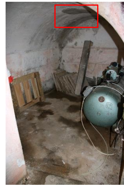
afbeelding 177 Foto's ruimte -2.01 kelder 2022. In het rode kader de reparatie in het gewelf. Op de foto links is aan de rechts de gepleisterde buitenzijde van de zuidgevel voorzien van een nis zichtbaar.
