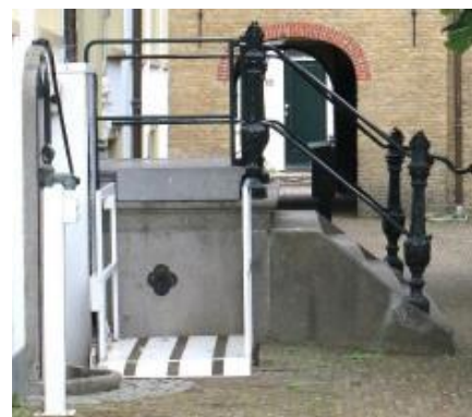
afbeelding 130 Foto van het zijaanzicht van het bordes en de trap 2022. Op de voorgrond de plateaulift en centraal in de hardsteen zijwand de vierpas met ventilatierooster.12
