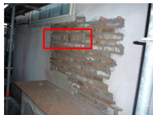
afbeelding 107 Foto N5 vernieuwd metselwerk en fragment rollaag 2009. (ME2, 2022) 17112009 f9
