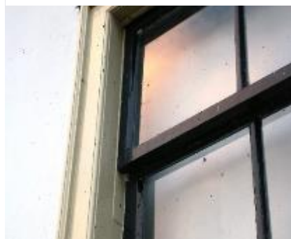
afbeelding 123 Detail van dagkant met aangeheelde kozijnstijl 2022.
