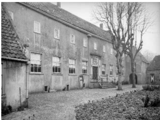
afbeelding 55 Foto zuidgevel Weeshuis 1923. Links de aanbouw aan de westzijde. Rechts de klokgevel van het poortgebouw en rouwkamer. Fotograaf W.C.L.A. Scheepens 26 November 1923 (Rijksdienst Cultureel Erfgoed, Amersfoort, 2022) 06828
