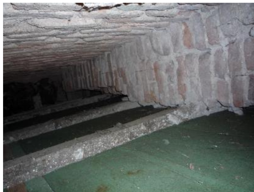
afbeelding 108 Foto's schacht noordwand gezien vanaf zolder boven regentkamer tussen as-9 en as-102009. Links en rechts anderhalfsteens gevelmetselwerk en boven recenter metselwerkXX. Onder is het regelwerk en houten schot van de ruimte 1.17 zichtbaar. (ME2) 09092009
