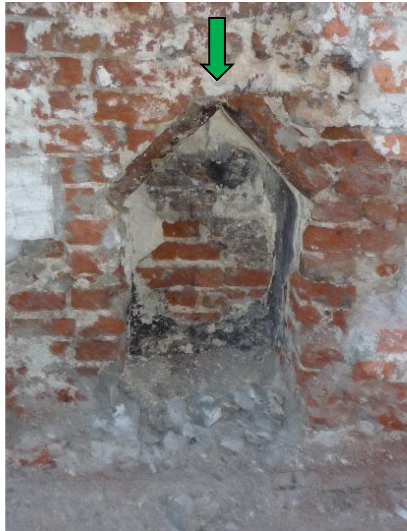
afbeelding 140 Foto W1 links: fragment westgevel boven maaiveld. Het pleisterwerk is afgebikt. Midden en links zijn twee nissen in het metselwerk zichtbaar. Midden op de foto een nis circa 60cm hoog en 30cm breed, een keperboog van twee bakstenen (groene pijl). De nis vertoont sporen van pleisterwerk en roet. Uiterst links iets lager de keperboog van een kleinere nis (rode pijl). Foto W1 rechts; detail van de grote kaarsnis.. De kaarsnissen bevinden zich ter hoogte van het maaiveld aan de linker zijde van de voormalige doorgang naar het souterrain, te zien op de plattegrond uit 1924. (ME2) 28 30112009 P1020760 en foto-1
