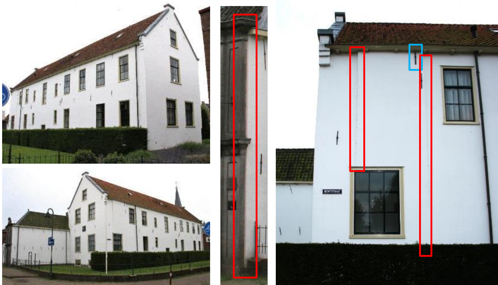
afbeelding 99 Foto's Weeshuis en Poortgebouw2022. Links boven: noordgevel en westgevel Weeshuis. Links onder: noordgevel Poorthuis, oost- en noordgevel Weeshuis. Midden: gevelfragment toont de naar de noordgevel omgezette hardsteen gevelbekleding en kroonlijsten van het PoortgebouwRechts: fragment noordgevel Weeshuis. In het rode kader het uitbollende geveldeel zichtbaar door de sprong in het pleisterwerk. In het blauwe kader gevelanker van de toegevoegde stalen trekstang ter vervanging van de deels verwijderde moerbalk van de zolderverdieping op as 9.
