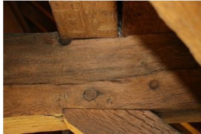
afbeelding 163 Foto juk1 met toognagel verbinding tussen korbeel en dekbalk 2022.
