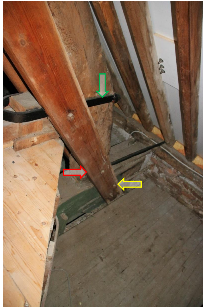
afbeelding 175 Links: Foto jukkant as-9 zuid gezien vanuit het oosten 2022. Onder: de verhoogde zolder vloer boven de Regentenkamer. De vurenhouten hulpconstructie daterend uit 1924 is aangeduid met pijlen. Rode pijl: spantbenen aan weerszijde tegen het juk bevestigd met stalen boutverbinding. Groene pijl: stalen trekstang bevestigd om de krommers voor opname van spatkrachten. Blauwe pijl: houten trek balk, onderdeel van de hulpconstructie en plafondconstructie van de Regentenkamer. Foto rechts: jukkant as-9 noord gezien naar het westen. Gele pijl: spantbeen met stalen boutverbinding aan groene moerbalk bevestigd.
