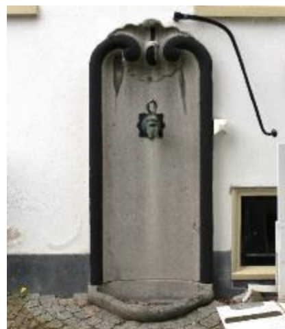
afbeelding 125 Foto van hardsteen nis met waterpomp en lekbak F3 2022.
