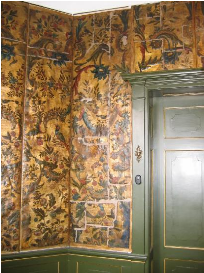
afbeelding 86 Restauratie Goudleerbehang 2009-2010. Foto links en boven: westwand boven en links van de entree. De lichtere vlakken en lijnen tonen dat de vlakken zijn samengesteld. Foto midden onder: detail met voorstelling van een tropische vogel. Foto rechts onder: strijklicht toont een relief in het materiaal bestaande uit een wafelruit motief. (ME2, 2022)
