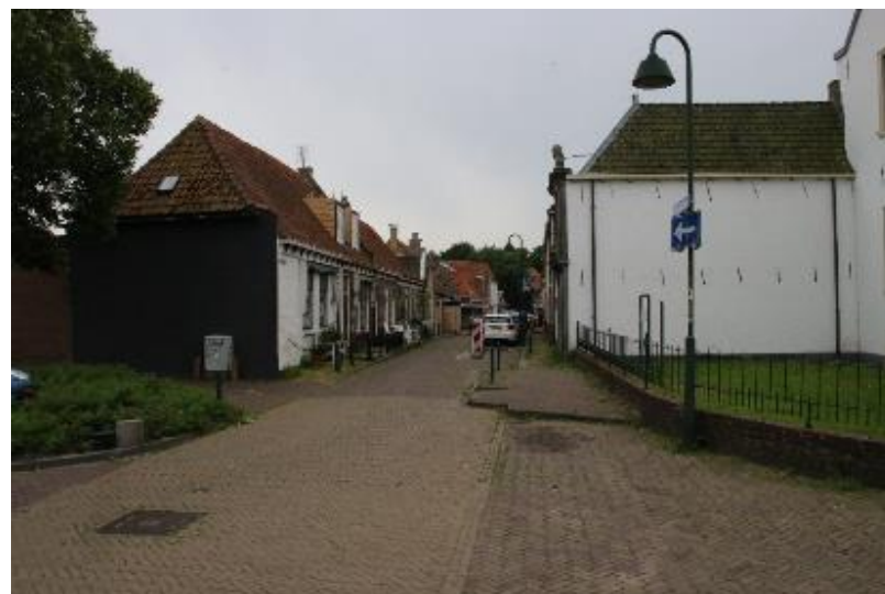
afbeelding 95 Foto Torenstraat gezien naar het zuiden. Rechts de zijgevel van het poortgebouw en oostgevel van het Weeshuis 2022.
