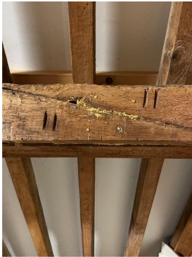
afbeelding 170 Foto gespijkerde grenen hangbalk tegen de onderzijde van fliering1 zuid as-6-7 2022. Detail: Schuine liplas voorzien van gehakt paringsmerk II.
