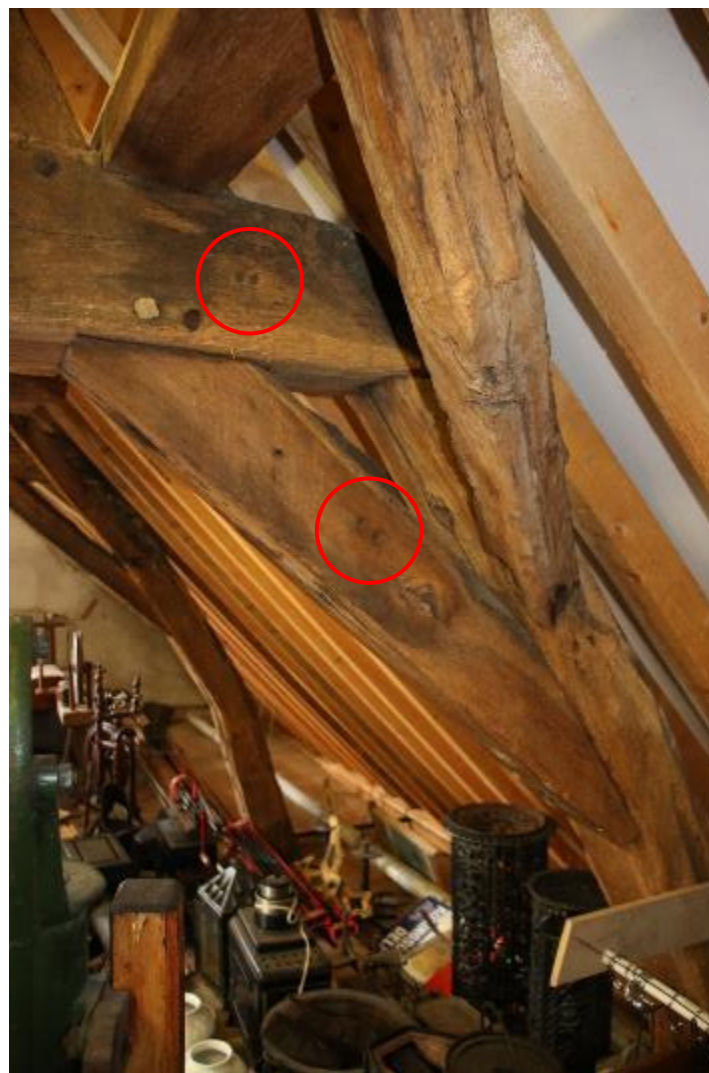
afbeelding 166 Foto juk1 noord telmerk O O op korbeel en dekbalk 2022.
