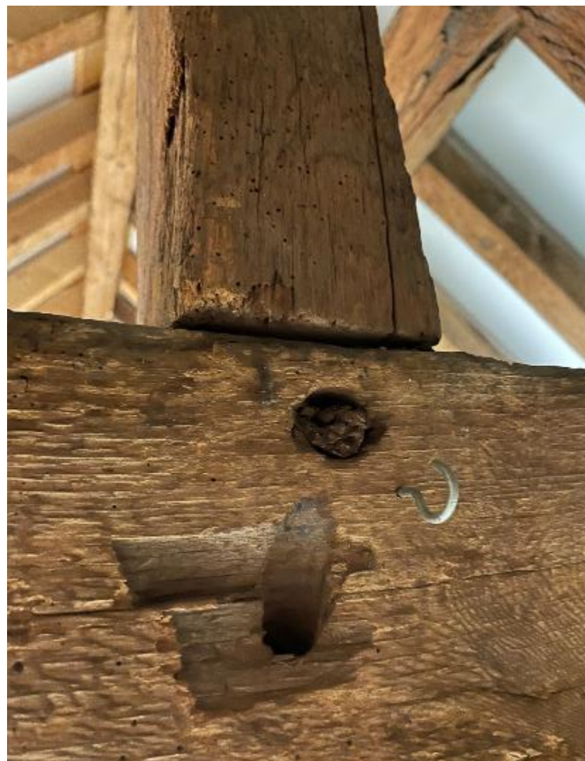
afbeelding 169 Foto juk2 as-7 2022. Links: verbinding dekbalk-nokstijl en nokstijl-nokbalk met toognagel. Rechts: onder; rondom het vlotgat is hout weggestoken, boven; toognagel verbinding nokstijl.
