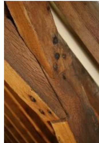
afbeelding 164 Foto juk1 zuid met gespijkerde verbinding tussen korbeel, windschoor en krommer 2022.
