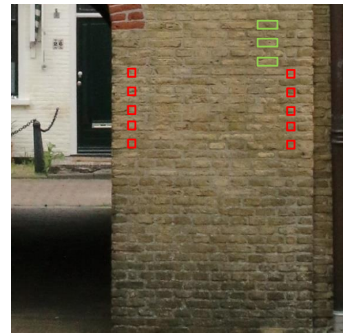
afbeelding 144 Foto hoekoplossing 2022. Boven: klezoor (rood) in koppenlaag ter plaatse van vensters en hoek. Onder: klezoor (rood) in koppenlaag ter plaatse van beëindiging en hoek. Kop (groen) in strekken laag ter plaatse van hoek rechts van wege een oneven aantal koppen.
