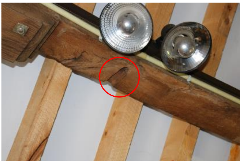
afbeelding 167 Foto fliering noord van juk2 as-0 2022. Vlotgat in onderzijde.
