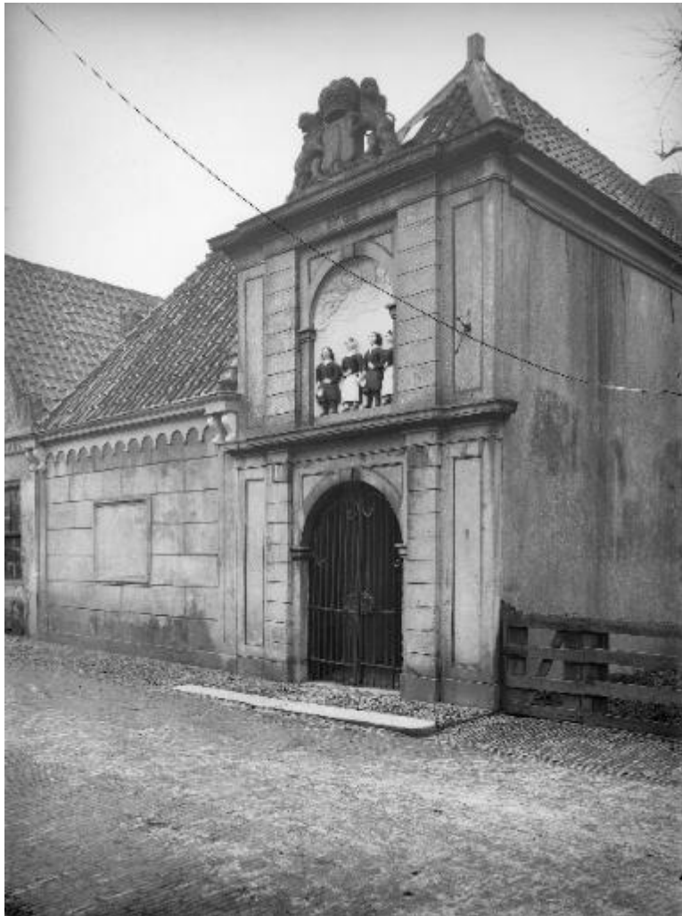
afbeelding 49 Foto poortgebouw en rouwkamer (links) 1923. Uiterst rechts is boven de nok de boogvormige beeindiging van de klokgevel van het poortgebouw zichtbaar. De blinde gevel van de aanbouw links van het poortgebouw is voorzien van geblokt pleisterwerk en omlijst kader. Fotograaf W.C.L.A. Scheepens 26 November 1923 (Rijksdienst Cultureel Erfgoed, Amersfoort, 2022) 06826
