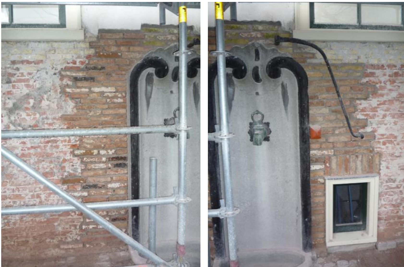
afbeelding 135 Zuidgevel. Foto's Z5 ter plaatse van waterpomp 2009. Vernieuwd ingeboet metselwerk na restauratie. (ME2)
