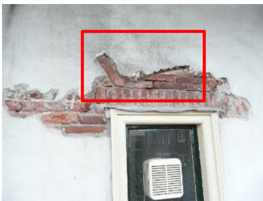
afbeelding 106 Foto N3 rollaag 2009. Het kozijn is gedateerd 1924. Boven de rollaag is een aanzet van een ontlastingsboog zichtbaar 2009. (ME2, 2022) 17112009
