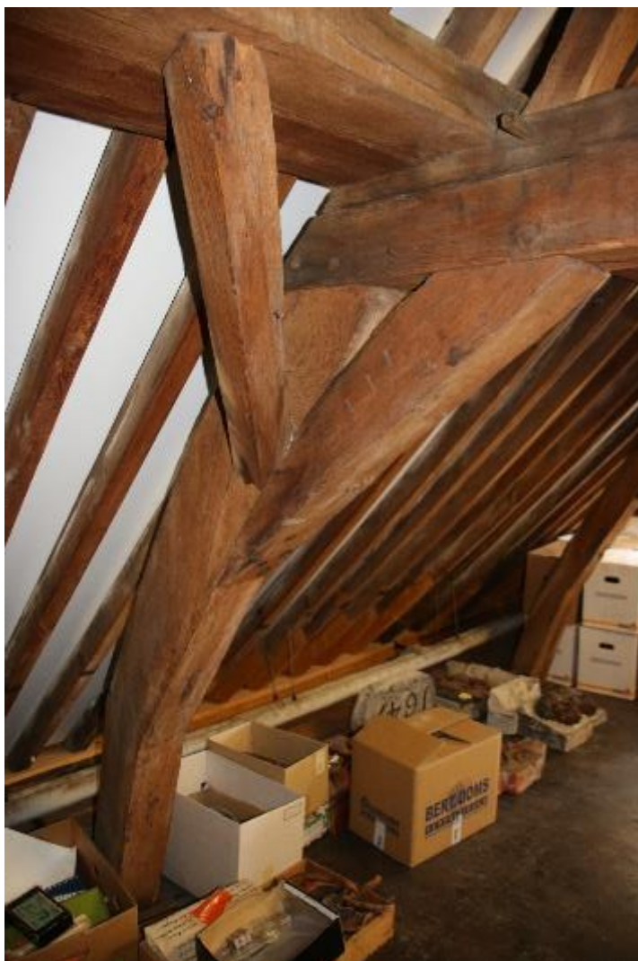
afbeelding 160 Foto juk1 gezien naar het westen 2022. Links spant1 zuid, dubbele flieringbalk. Rechts spant1 noord enkele flieringbalk.
