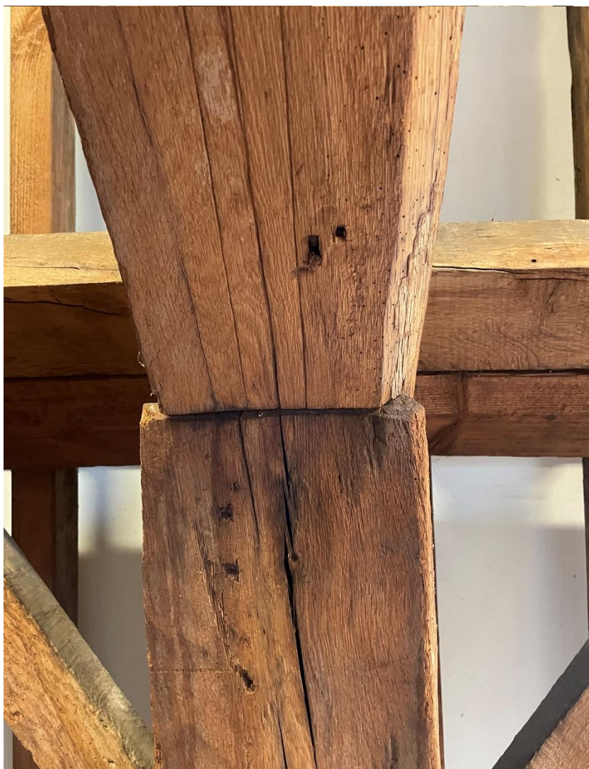
afbeelding 171 Foto spantbeen en dekbalk voorzien van kraslijnen 2022.
