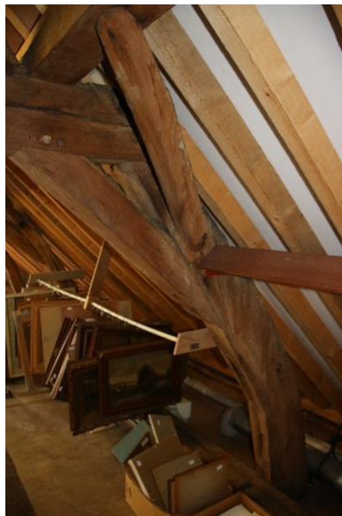
afbeelding 160 Foto juk1 gezien naar het westen 2022. Links spant1 zuid, dubbele flieringbalk. Rechts spant1 noord enkele flieringbalk.
