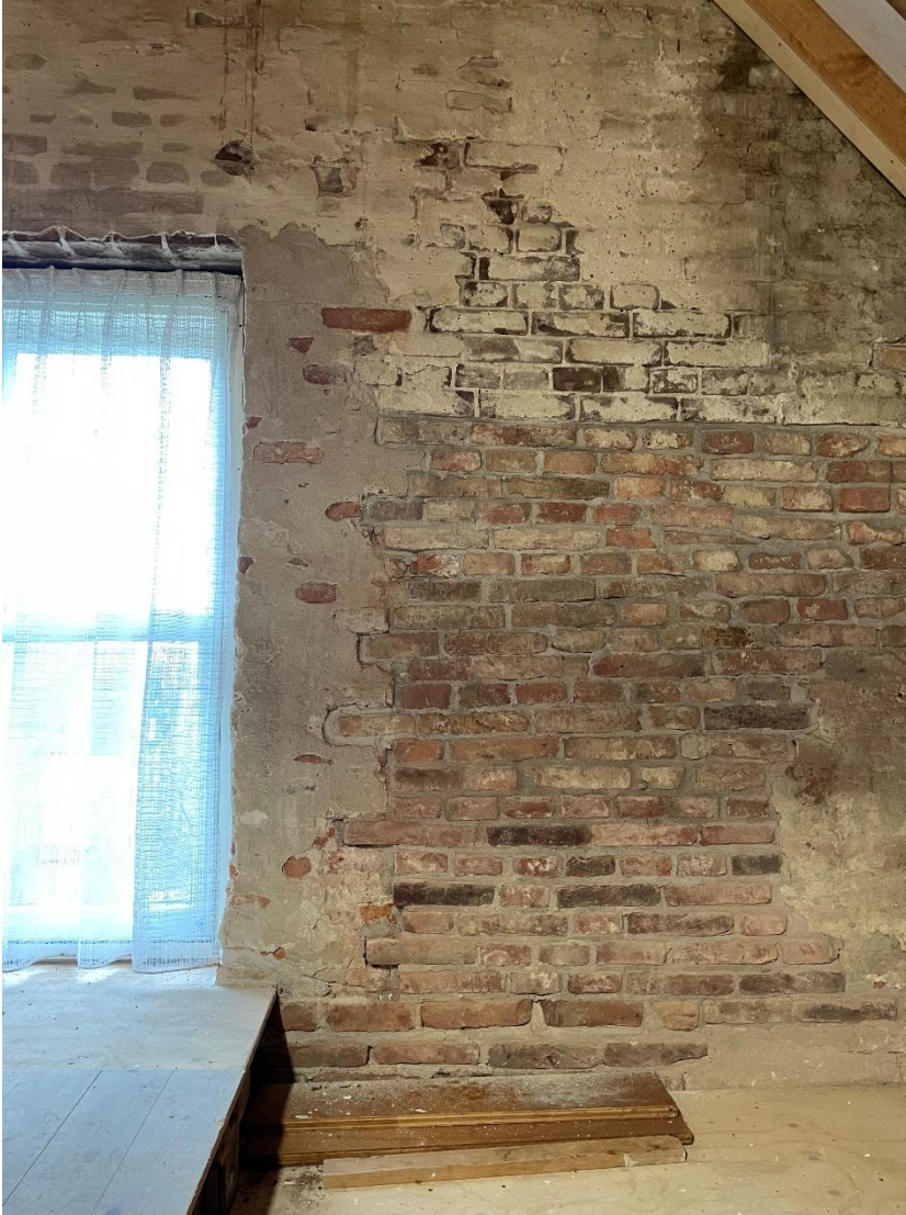
afbeelding 112 Foto zolder ruimte 2.06 gevelwand oost 2022. Rechts van het venster zijn bouwsporen van het versleepte schoorsteenkanaal zichtbaar.
