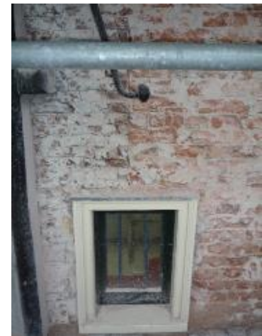
afbeelding 134 Zuidgevel. Foto's Z5 ter plaatse van waterpomp voor restauratie 2009. Bouwsporen van vertandingen en dichtgezette sparingen zichtbaar na afbikken van pleisterwerk (ME2) 24112009 26112009
