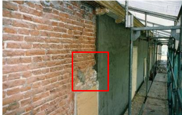
afbeelding 103 Foto N1 omstreeks 1990. Afgebikt metselwerk overwegend in staand verband. Tussen bovenkant kozijn merk B en onderkant goot bevinden zich circa 20 lagen metselwerk in staand verband voorzien van een lichte kalkvoeg. (SHWM, 2022)
