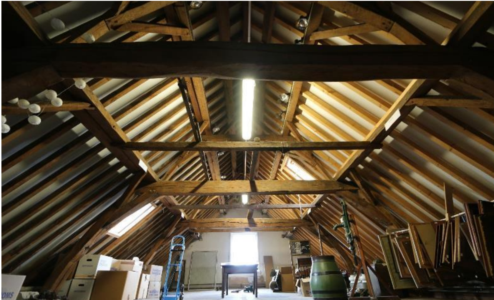
afbeelding 153 Foto overzicht van de westelijke zolder gezien naar het westen 2022. Gestapelde dekbalkjukken. Juk 1 staat op de moerbalk. Juk 2 staat op juk 1. Juk 1 met krommers en juk 2 met geschoorde nokstijl. Flieringbalken over de beide jukken voorzien van inkepingen voor de sporen. In het midden van elk stramien bevinden zich grenen hangbalken tussen de flieringbalken van juk 1.
