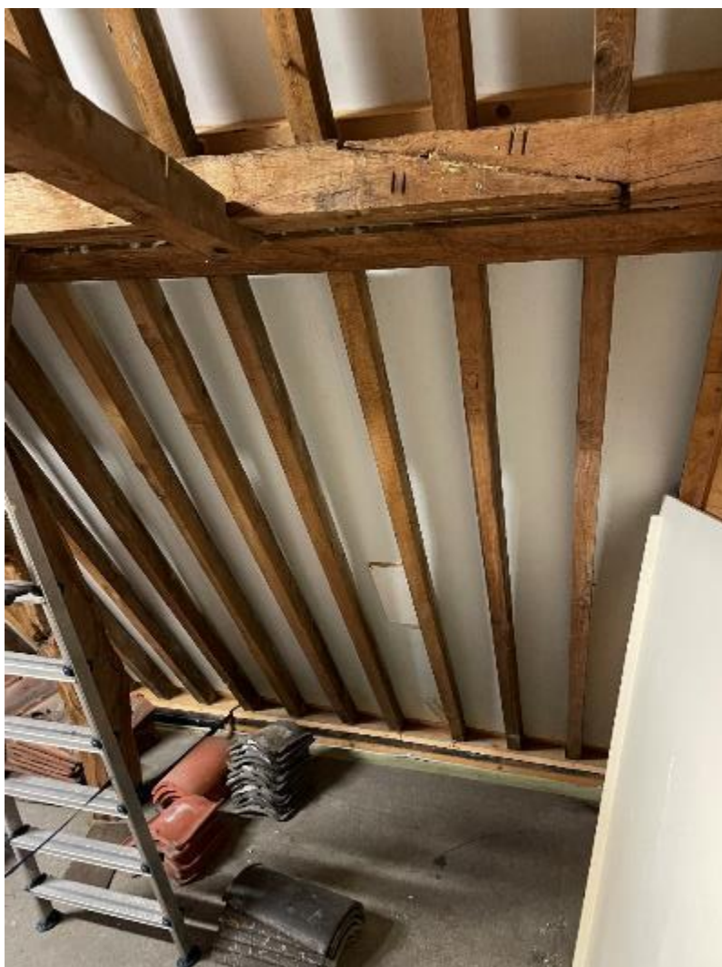
afbeelding 170 Foto gespijkerde grenen hangbalk tegen de onderzijde van fliering1 zuid as-6-7 2022. Detail: Schuine liplas voorzien van gehakt paringsmerk II.
