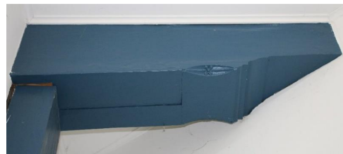
afbeelding 146 Foto van moerbalk met sleutelstuk opgelegd op muurstijl (1978) noordgevel bel-etage (0.05) 2022.
