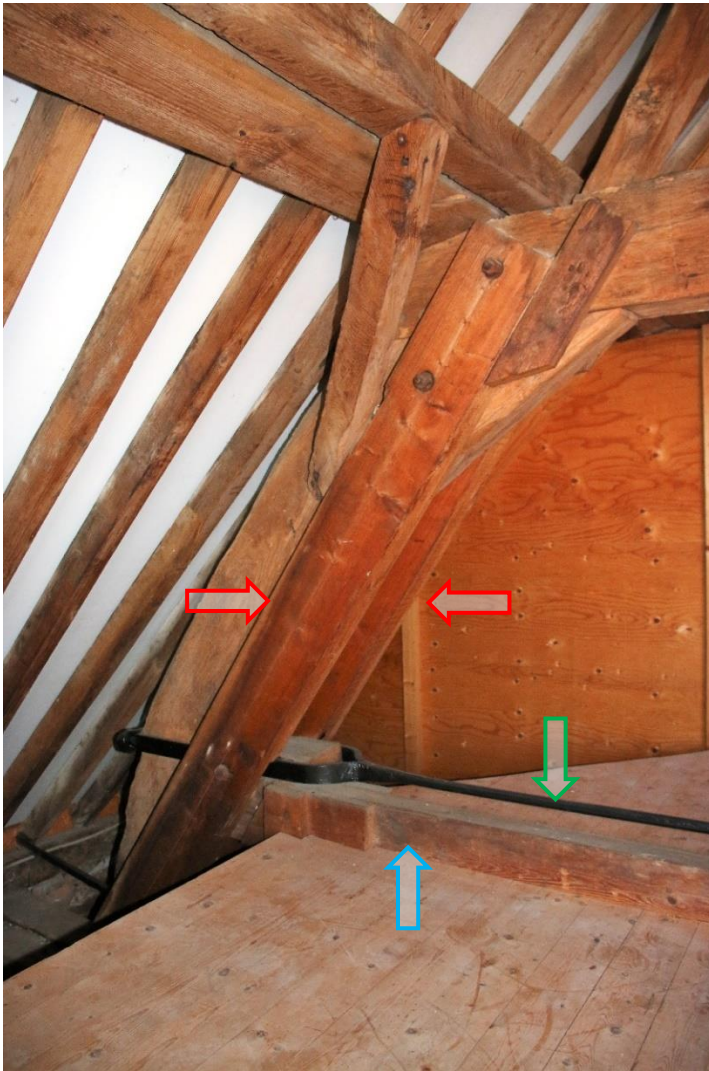
afbeelding 175 Links: Foto jukkant as-9 zuid gezien vanuit het oosten 2022. Onder: de verhoogde zolder vloer boven de Regentenkamer. De vurenhouten hulpconstructie daterend uit 1924 is aangeduid met pijlen. Rode pijl: spantbenen aan weerszijde tegen het juk bevestigd met stalen boutverbinding. Groene pijl: stalen trekstang bevestigd om de krommers voor opname van spatkrachten. Blauwe pijl: houten trek balk, onderdeel van de hulpconstructie en plafondconstructie van de Regentenkamer. Foto rechts: jukkant as-9 noord gezien naar het westen. Gele pijl: spantbeen met stalen boutverbinding aan groene moerbalk bevestigd.
