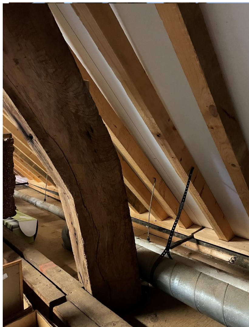
afbeelding 172 Foto van krommer op as-3 noord 2022. Links van de krommer is een dubbele bovenliggende vurenhouten balk zichtbaar. Rechts: het ijzeren anker naast de kanalen verankert de krommer aan het muurwerk. De ophanging van de verdiepingsvloer is verwijderd tijdens de verbouwing in 1978 vanwege de nieuwe indeling. (SHWM, 2022)
