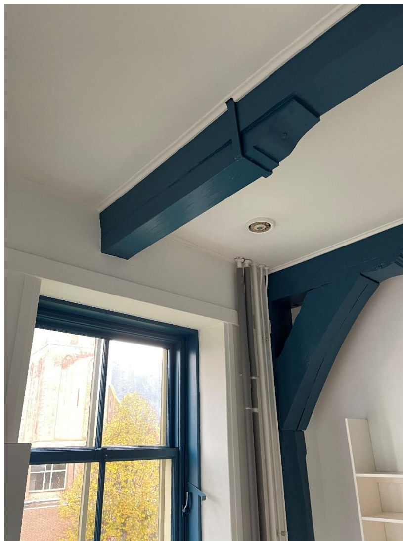
afbeelding 150 Foto noordgevel verdieping (1.09) 2022. Tussenbalk met sleutelstuk voorzien van ijzeren strop.
