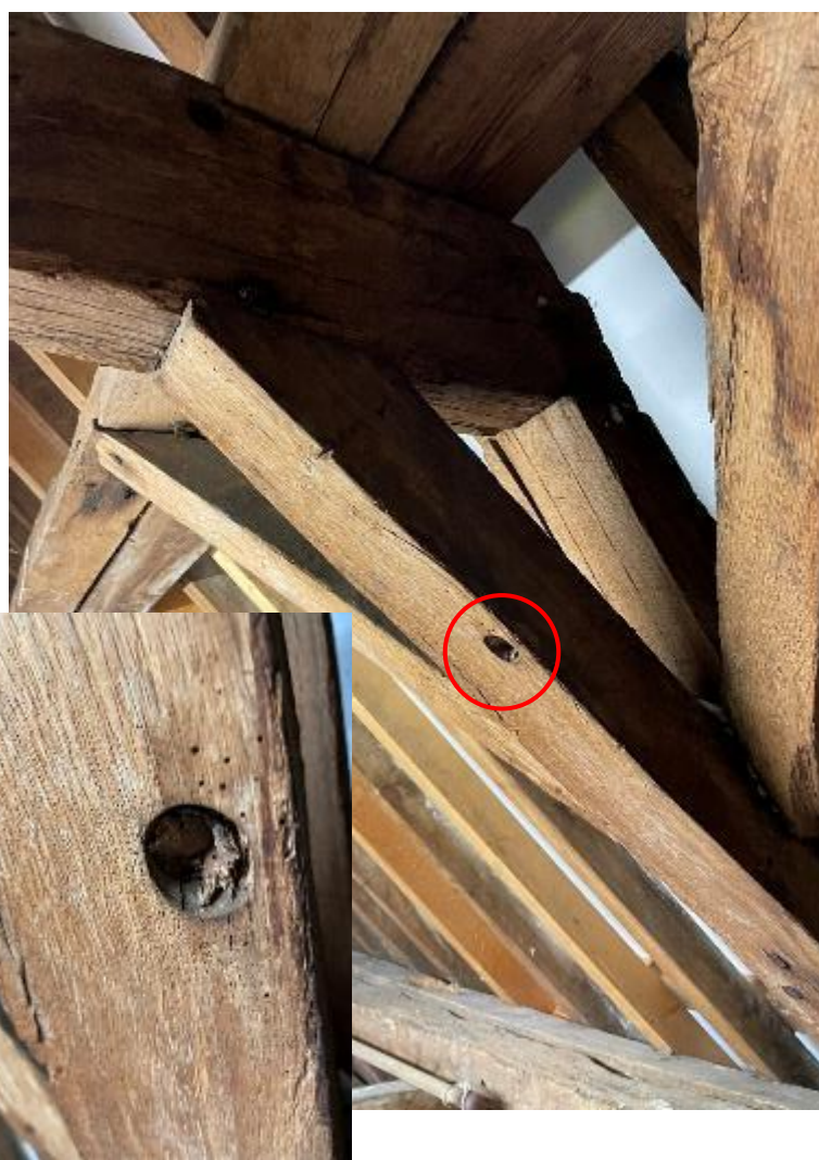
afbeelding 168 Foto juk2 zuid as-7 2022. Vlotgat in korbeel met houtprop.167
