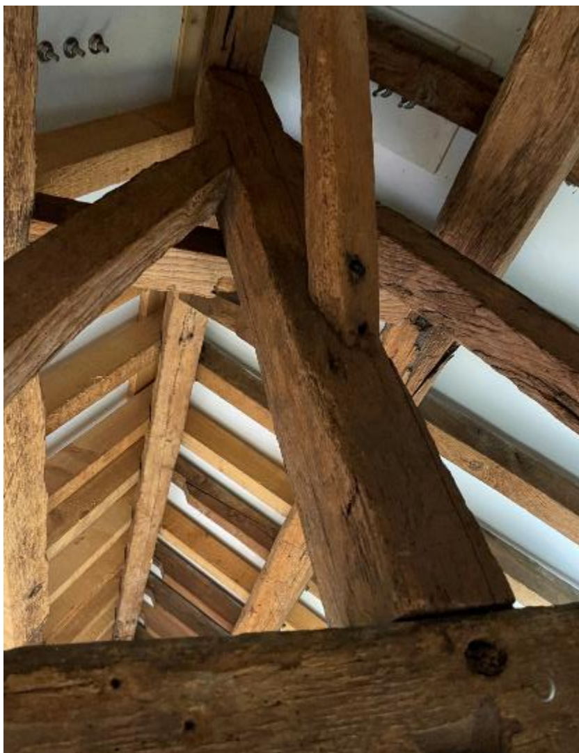
afbeelding 169 Foto juk2 as-7 2022. Links: verbinding dekbalk-nokstijl en nokstijl-nokbalk met toognagel. Rechts: onder; rondom het vlotgat is hout weggestoken, boven; toognagel verbinding nokstijl.
