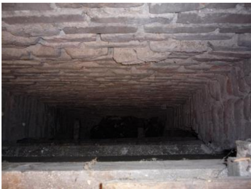
afbeelding 108 Foto's schacht noordwand gezien vanaf zolder boven regentkamer tussen as-9 en as-102009. Links en rechts anderhalfsteens gevelmetselwerk en boven recenter metselwerkXX. Onder is het regelwerk en houten schot van de ruimte 1.17 zichtbaar. (ME2) 09092009
