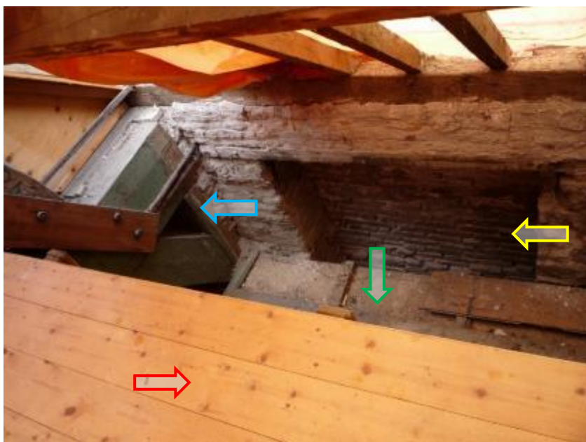
afbeelding 173 Zolder (2.05) tijdens de restauratie 9 september 2009. Foto van de noordwand rechts van de moerbalk op as-9. Bij de rode pijl de verhoogde vloer boven het plafond van de regentenkamer (1.18). Bij de groene pijl het plafond boven de noordelijke zijkamer (1.17) van de regentenkamer. Bij de gele pijl een halfsteens in halfsteensverband dichtgezette gevelopening in de noordgevel tussen as-9 en as-10. Bij de blauwe pijl de moerbalk met sleutelstuk en muurstijl op as9. (ME2, 2022)
