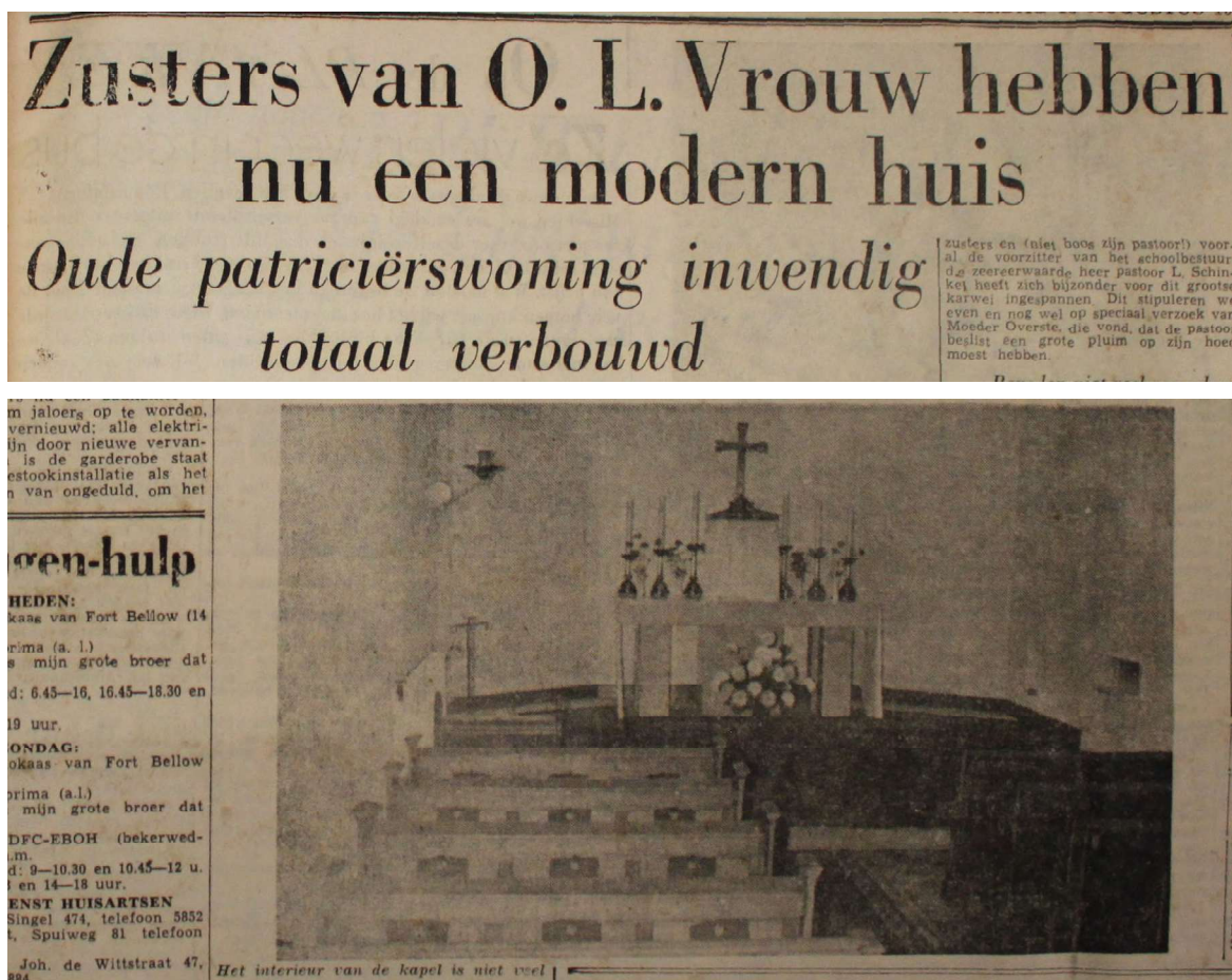
Afb. 45 Na de oplevering van de verbouwing van het zusterhuis werd er een flink artikel aan gewijd in de Nieuwe Dordsche Courant van 13 augustus 1960. Op de foto is de inrichting van de kapel te zien. (Met dank aan A. Balm-Kok)
