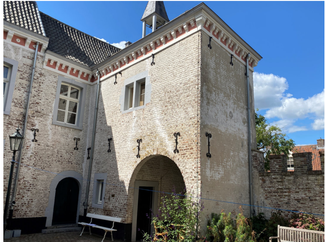
Aanzicht van bouwdeel D en de overgang naar bouwdeel C vanuit het binnenhof. Duidelijk is de lagere goothoogte van deze volumes te zien en de afwijkend vormgegeven consolefries. De getoogde deuropening is in het verleden verplaatst geweest, een weinig verhullende inboeting getuigt hiervan. Een veronderstelde mogelijk open ruimte D.0.2 (naast de poort) kent geen sporen van een dichtzetting hiervan en kan daarmee vooralsnog niet worden aangetoond.
