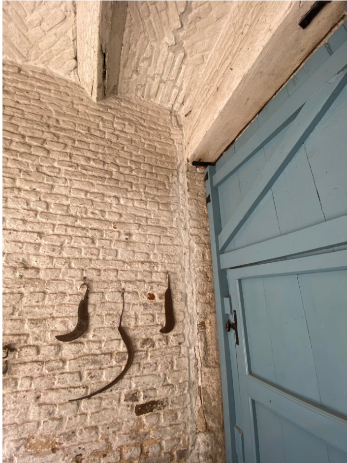
Overeenkomstig de overzijde van de doorgang is ook hier een dichtgezette sleuf zichtbaar tot bovenzijde van de houten latei van de poort.
