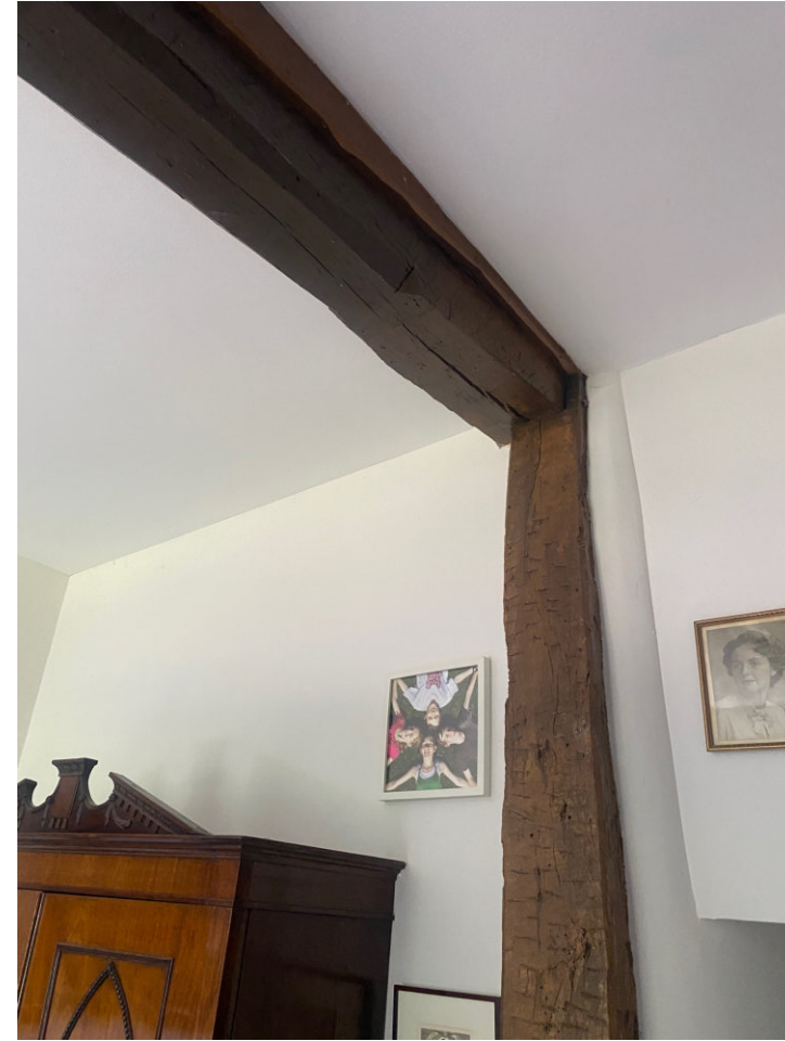
Stijl en dekbalk onder gebintstel 9 aan noordelijke zijde geschaafd en voorzien van kapellen tegen de buitenzijde van de zuidelijke wand van bouwdeel A. De meest noordelijke krommer staat ongeveer 60cm binnen de stijl.
