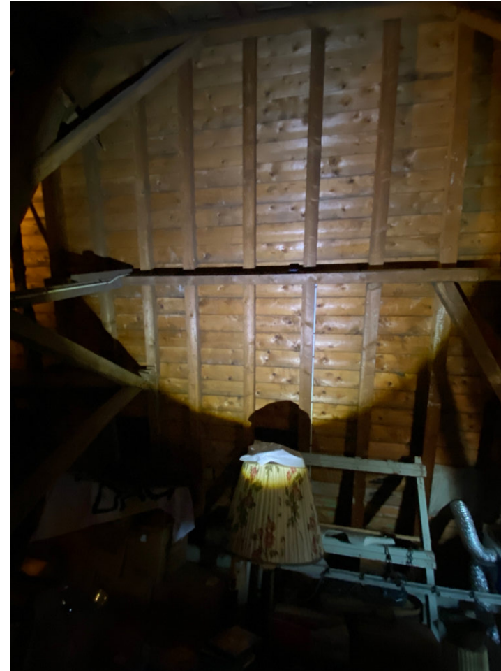
Travee IX in westelijke richting met louter vuren sporen en naaldhouten gording
