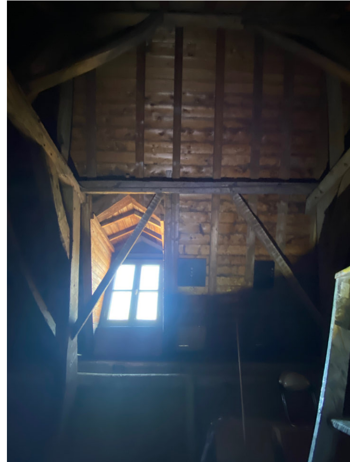
Travee X in oostelijke richting met dakkapel, eiken gording en vuren sporen. De schoren zijn uitgevoerd in divers hergebruikt materiaal.
