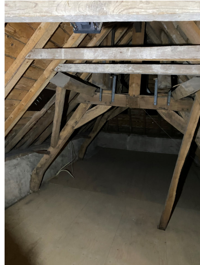
Zicht in de kap van bouwdeel D. In deze kap is een bescheiden gebint geplaatst en is een tijdens de restauratie in 1953-1955 klokkenstoel ingebracht. De kap was tot de restauratie een op zich staande kap maar is verbonden met de kap van bouwdeel C. De vloer is voorzien van houten platen, er kon niet worden vastgesteld welke afwerking de onderliggende troggewelven in deze kapruimte gekend heeft.
