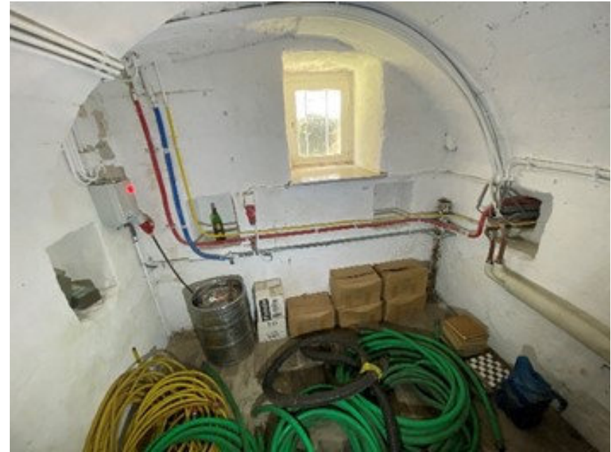
Ribloze kelder A.-1.2 in mergel met kruin in oost-westelijke richting. In deze kelder zijn enkele vierkante sparingen op dezelfde hoogte aanwezig, onduidelijk is de functie hiervan, dit kunnen mogelijk kaarsnissen zijn geweest. Het venster is ingebracht in bouwfase 7.
