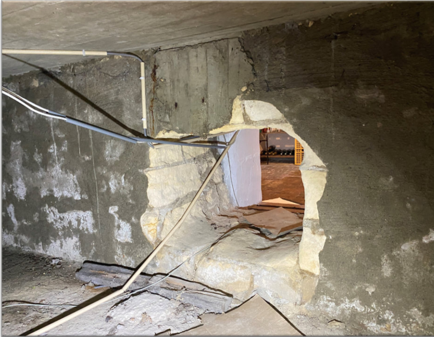
Doorgang van kelder bouwdeel A naar bouwdeel B door de mergel eindwand van bouwdeel A.
