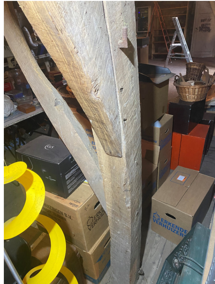
Detail draagconstructie. In deze stijl zijn (zeer uit het lood) duimen aanwezig.
