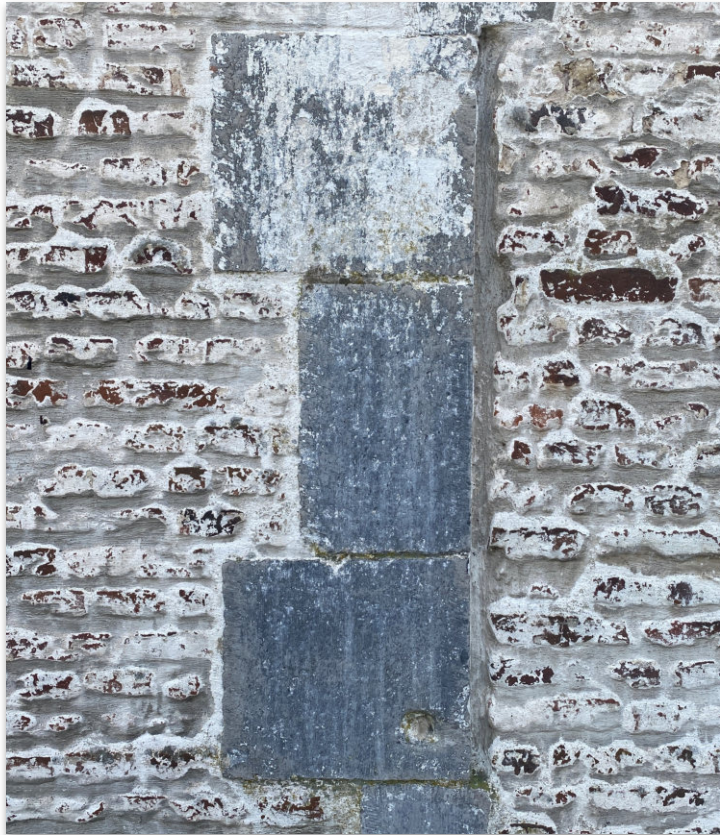
De oorspronkelijke vensters (meest kloosterkozijnen in naamse steen en mergel, incidenteel een kruiskozijn) zijn dichtgezet met een ander formaat baksteen. Het formaat van de baksteen van de dichtzetting komt overeen met het formaat baksteen dat gebruikt is in bouwdelen C, D en E.
