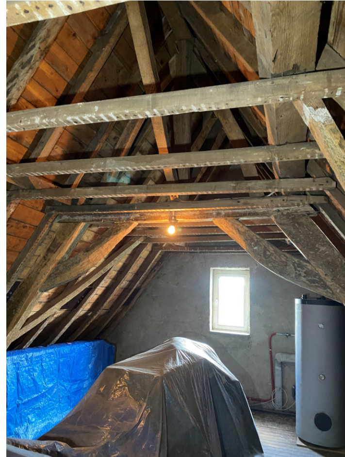
Kapverdieping C.2.1 waarin (voorheen geschilderde maar al langere tijd afgekrabde) krommers en korbelen zichtbaar zijn en de draagconstructie van een in het verleden toegepast verlaagd plafond. De afdrukken op de dragers laten afdrukken van rietlatten en stucwerk zien, deze ruimte is historisch dus gebruikt als verblijfsruimte, mogelijk in de 19 de eeuw..
