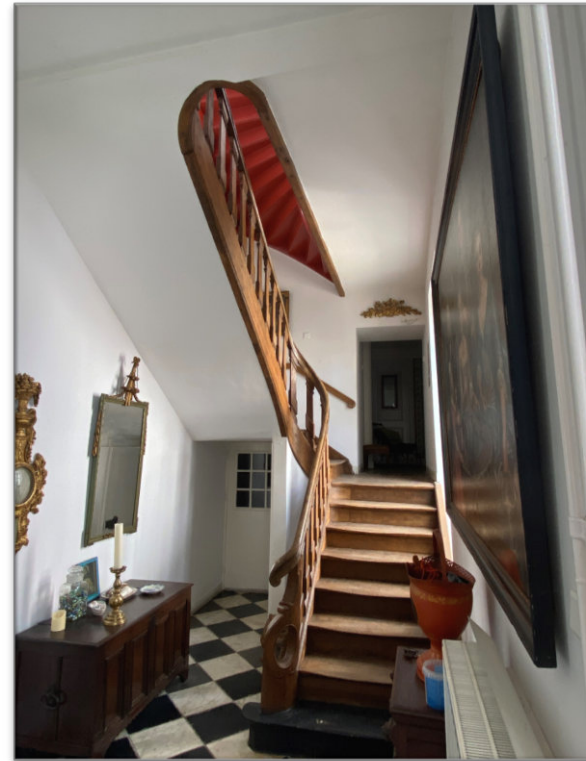
Overzichtsfoto van de bordestrap. Deze trap verbindt het maaiveld met het niveau van de etage boven de gewelfde kelders van bouwdeel A.
