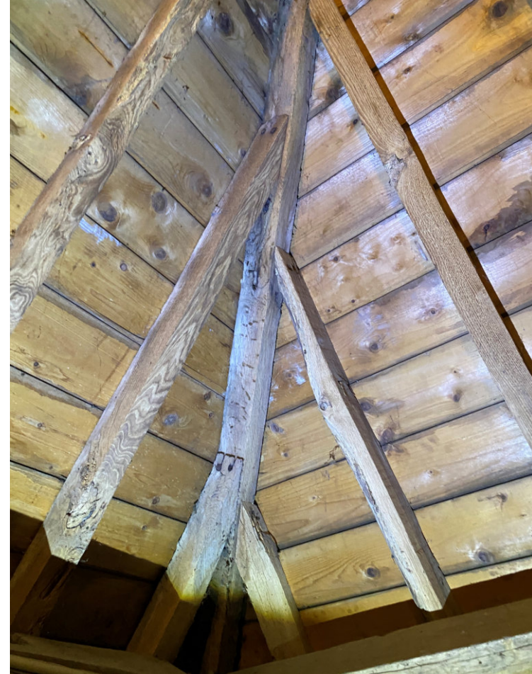
Hoekkeper travee VIII in zuidelijke helft waarop geen opmerkelijke zaken te bespeuren zijn:
