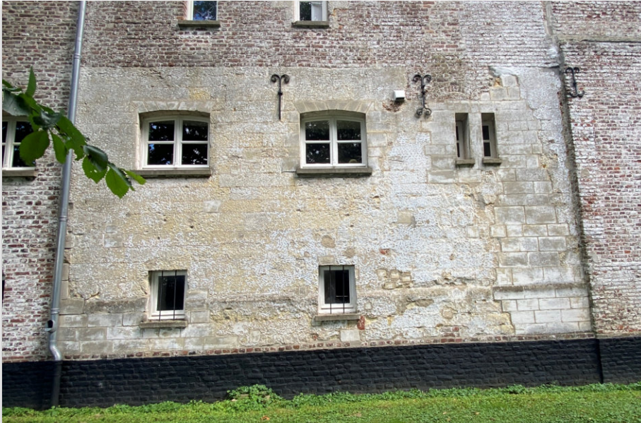
Overgang tussen oorspronkelijke west- en zuidzijde van de mergelkern. Zichtbaar zijn kopse zijden van de mergelblokken die de hoek om gaan en de bouwnaad markeren tussen bouwfasen I en II.
