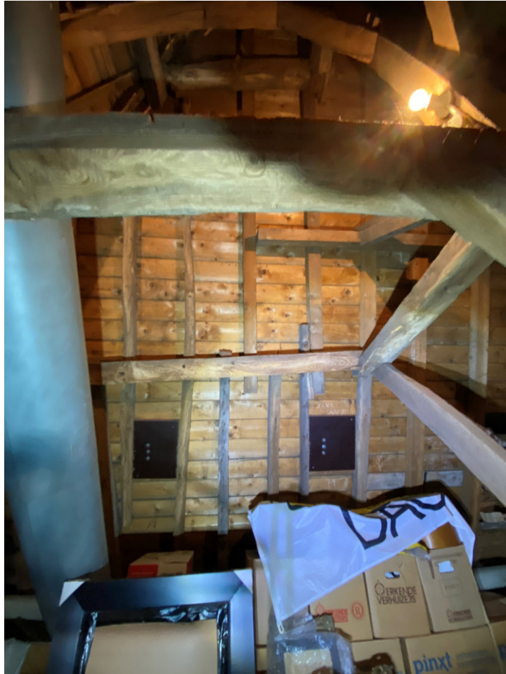
Travee VIII (noordelijke helft) in oostelijke richting met gaten tbv toognagels voor de voormalige dakkapel in de gording.
