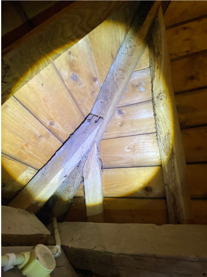
Bevestiging sporen aan hoekruiter in travee 1, noordoostelijke hoek. Bezaging, bevestiging en afwerking van de sporen komt overeen in zowel het afgewolfde gedeelte als de langskap waarmee de sporen in dezelfde bouwfase kunnen worden gedateerd.
