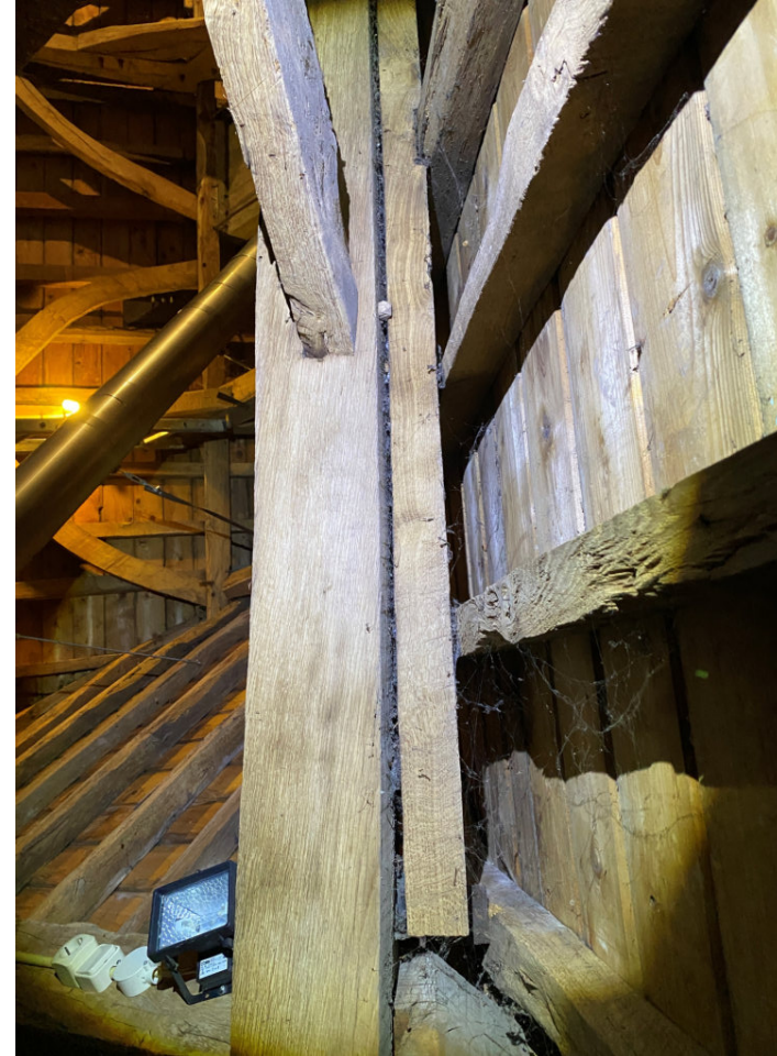
Uitvulling tussen gording en sporen in travee I zuidelijke zijde, noodzakelijk na extreme vervorming van deze gording.
