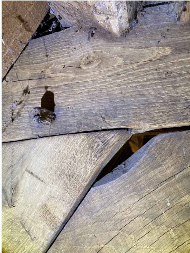
Knoop krommer/korbeel/dekbalk met geschaafde kapellen als bijvoorbeeld in gebintstel 2.
