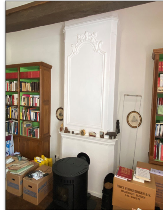
Schouw met stucwerk voorzien van C-voluten en kroonachtig centraal element waarbij oorspronkelijk een omstuct balkenplafond.
