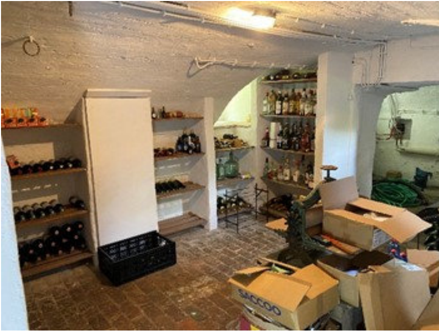
Ribloze kelder A.-1.1 in mergel met kruin in noord-zuidrichting. Aan het plafond zijn enkele gesmede ringen aanwezig, De vloer bestaat uit machinaal gefabriceerde straatklinkers.
