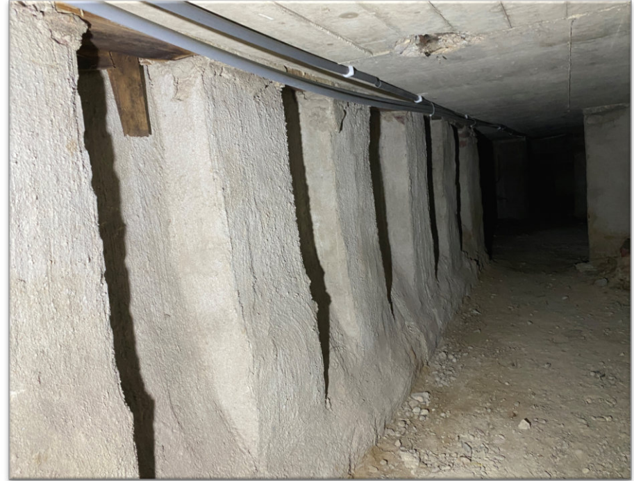
Zicht in kruipruimte onder bouwdeel B op ingekast muurwerk en betonnen vloer t.b.v. funderingsherstel tijdens de restauratie in 1953-1955.
