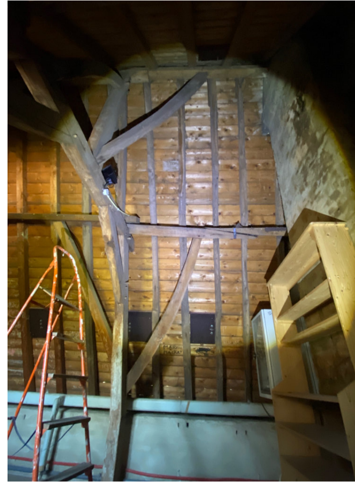
Travee XI in westelijke richting waarop de sporen uit bouwfase IV ingekeept in de eiken gordingen zijn.
