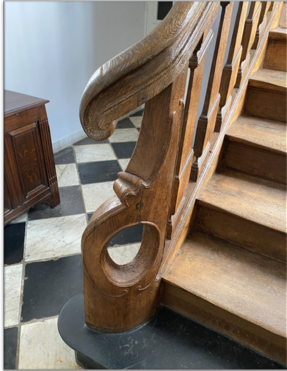
Detail van wrongstuk/hoekbaluster van de trap waarin zowel c-voluten als strakke balusters aanwezig zijn wat in aanvulling op het stucwerk in de zaal duidt op een overgangsfase tussen Louis XV en Louis XVI-stijl en daarmee is te dateren tussen 1770 en 1795.
