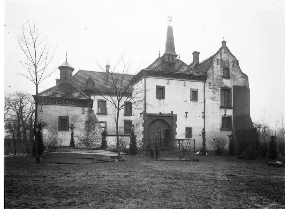
Historisch zicht op noordgevel Ten Hove waarin de oorspronkelijke kapvorm van bouwdeel D zichtbaar is, een lagere ommuring zonder kantelen tussen bouwdelen D en E en de opvallende "steunbeer" in bouwdeel C. Opvallend is verder de rijke ornamentering van de dakvlakken (crêtes, hoekpinakels, siersmeedwerk op dakdoorvoeren) in 19 de eeuwse stijl.
