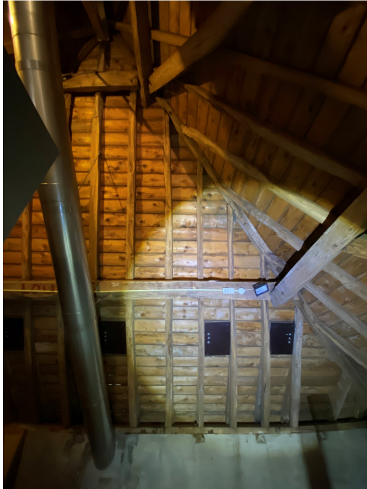
Travee I (zuidelijke helft) in oostelijke richting.
