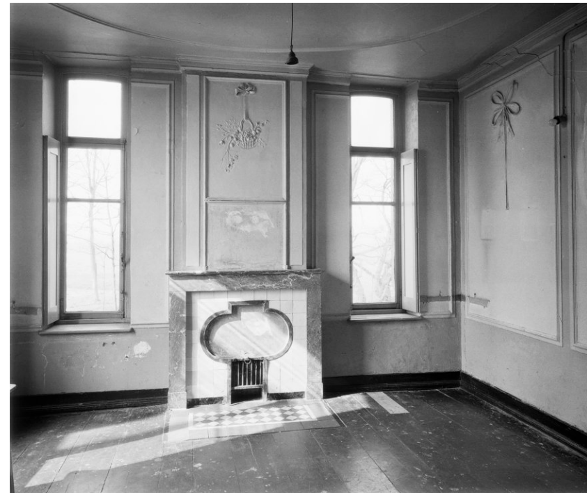
Historisch zicht op sleutelhaard en oorspronkelijke vensters in B.0.3. De voornamelijke indruk die de centrale schouw door de rijzige vensters krijgt is bij de restauratie door het dichtzetten van de vensters aangepast.
