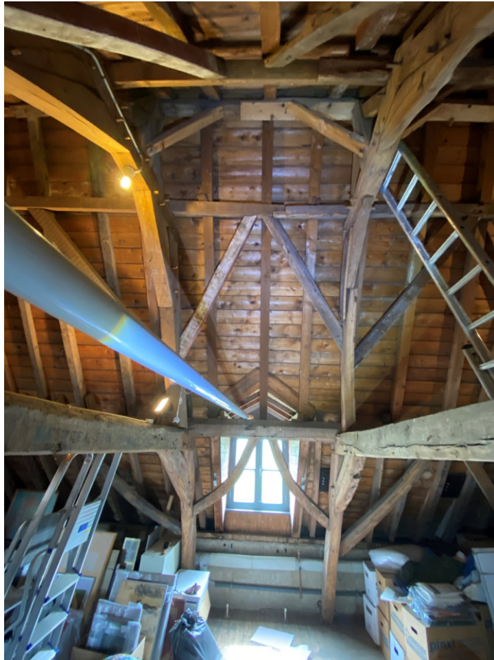
Travee IV in zuidelijke richting waarop vernieuwde sporen
