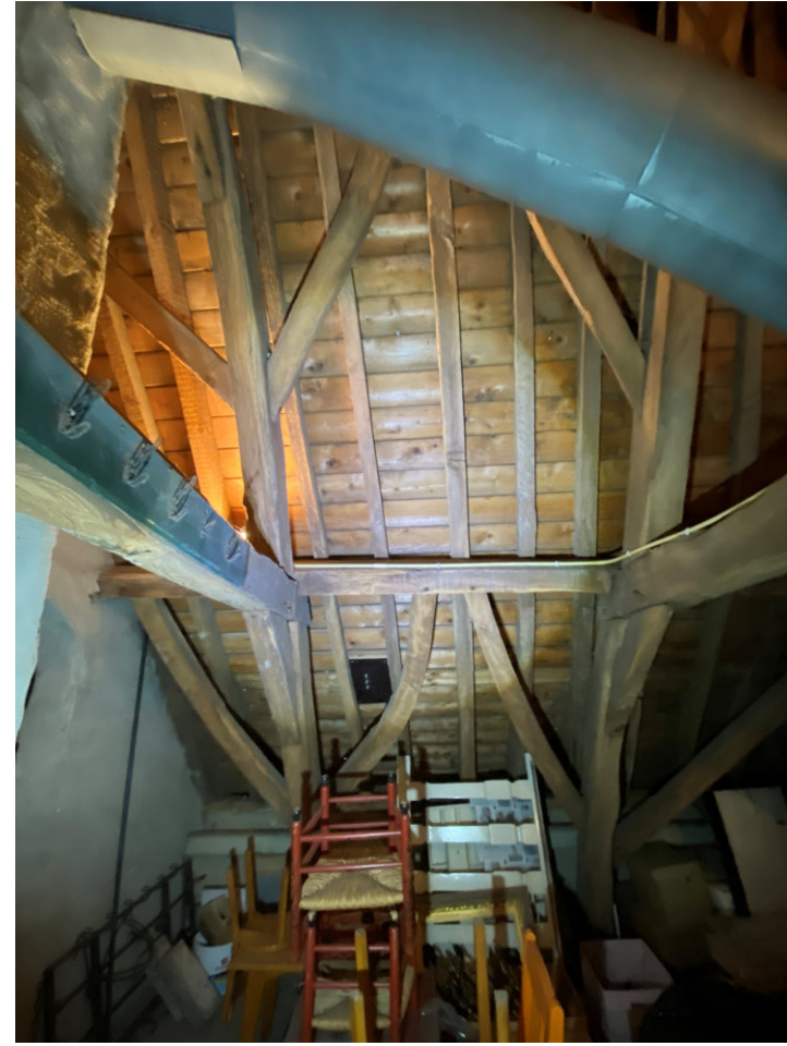
Travee VII in zuidelijke richting
