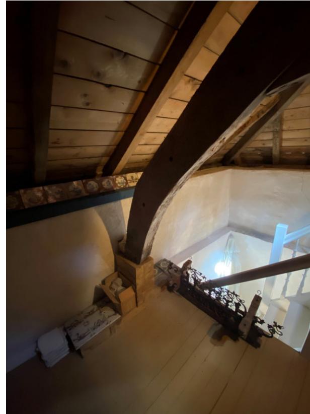
Afwijkende hoogte oorspronkelijke vloerbalken ten opzichte van de huidige vloer.
