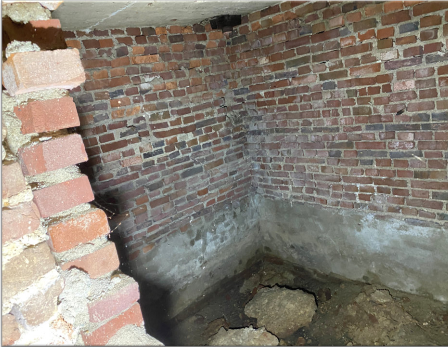
Zicht op fundamente van oorspronkelijke toren in zuidoostelijke hoek bouwdeel B. Bovenop deze fundamente het opgaand werk van het gerealiseerde balkon tijdens de restauratie in 1953-1955.
