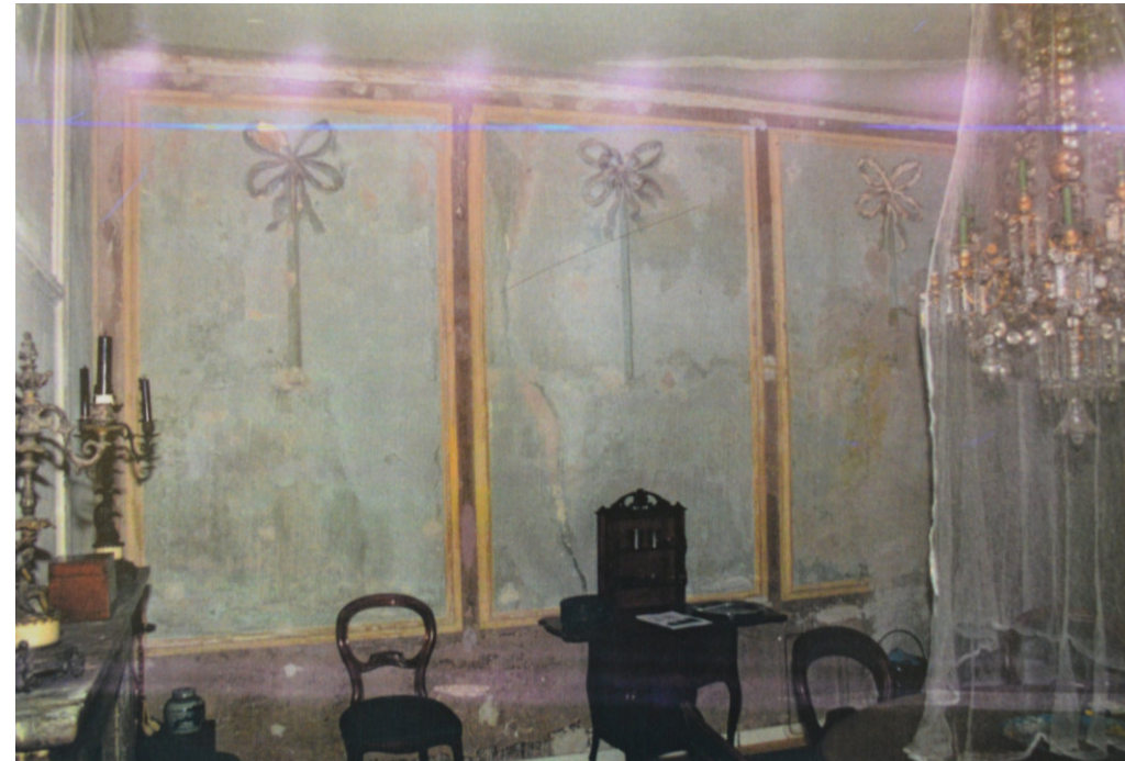
Foto van de toestand van de stijkkamer B.0.3 voor aanvang van de restauratie van het stucwerk, het plafond en het kleuonderzoek dat uiteindelijk tot een kleurwijziging heeft geleid.
