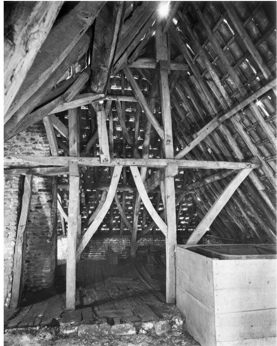
Zicht in de onbesloten kap ter plaatse van de overgang tussen bouwdeel A en B voor restauratie in 1953-1955. Opvallend is de oorspronkelijke houten vloer en de aanwezigheid van een watertank aan de rechter zijde. Op de voorgrond beneden zijn mergelblokken zichtbaar: de oorspronkelijke buitenmuur van bouwdeel A vanuit de binnenzijde bekeken. De gebintconstructie in bij deze aansluiting is in zijn geheel buiten bouwdeel A geplaatst.
