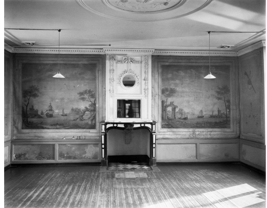
Historisch zicht in de zaal B.0.1 in oostelijke richting. Belangrijkste afwijking met de huidige situatie is de aanwezigheid van de wandbehangsels in situ op deze foto en de aanwezigheid van de lambrisering.
