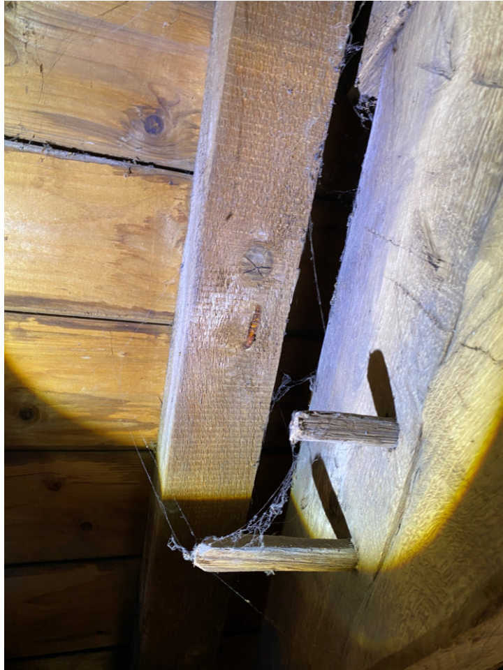
Vurenhouten spoor, machinaal gezaagd, tijdens restauratie in 1953-1955 conform bestek geplaatst.
