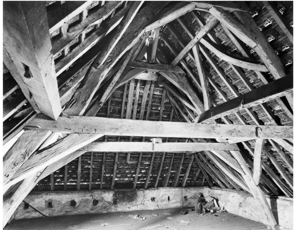
Historisch zicht in de kap in het oostelijke gedeelte van bouwdeel B. Zichtbaar is de onbeschoten kap en de afvolging. Het model dakpan kan van binnenuit ook worden gedefinieerd als een kruispan (of Bouletpan), in Nederland sinds 1877 en onder andere gefabriceerd door firma Gebr. Laumans in Tegelen. Op deze foto is niet het interne rookgaskanaal te zien dat is geïntroduceerd ter vervanging van de oorspronkelijke externe schoorsteen.
