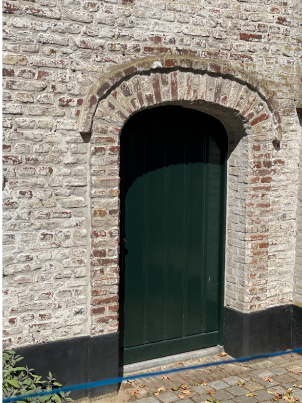
Verplaatste deur tijdens de restauratie in 1953-1955
