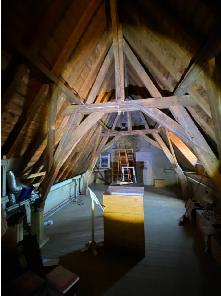
Gebintstel 8 met rechte korbelen en schoren in fijnere bezaging en strakkere uitvoering.
