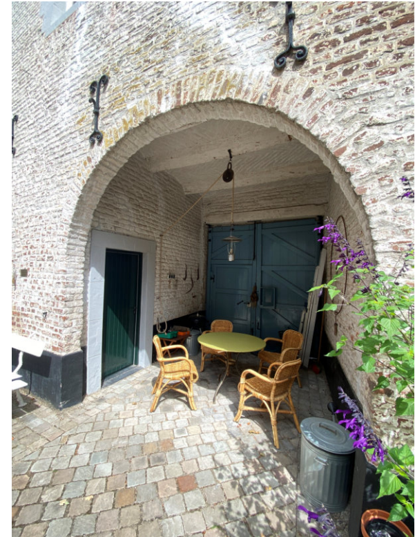
Zicht op de onderdoorgang van poortgebouw bouwdeel D vanuit het binnenhof.
