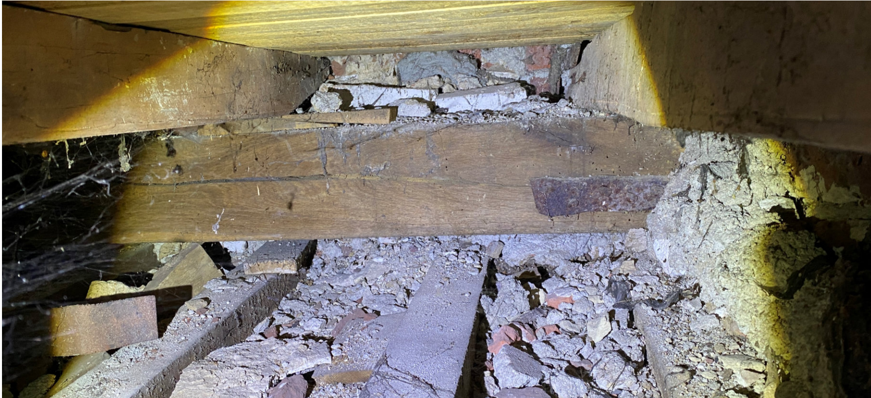
Foto van strijkspant en strop zichtbaar in zuidoostelijke hoek. Het onderliggende plafond (geen historisch stucplafond) lijkt van een nieuwe draagconstructie voorzien te zijn, de strijkbalk is wel oorspronkelijk en voorzien van smeedijzernen nagels in de strop. De bovenliggende vloer is vernieuwd tijdens de restauratie in 1953-1955.
