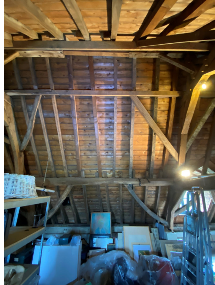
Travee III in zuidelijke richting waarop vernieuwde sporen boven onderste gording.
