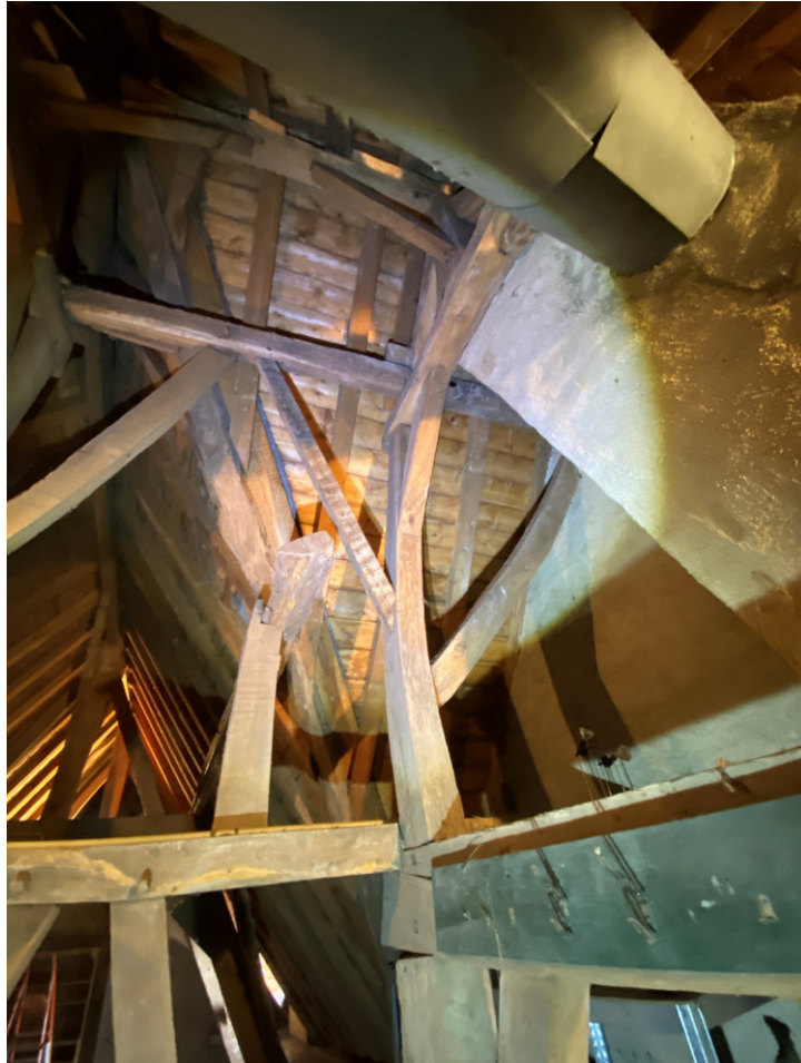
Travee VII in noordelijke richting. Hier is de complexe knoop en de benodigde aanpassing voor een logische afdracht van de belastingen zichtbaar. Vernieuwde sporen, hoekkeper in eiken.
