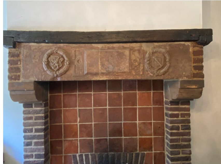
De schouw voorzien van de historische wapenstein met het wapen van familie Bormans gedateerd 1609 (tijdens de restauratie opgegraven en hier als boezem geplaatst). De schoorstenen zijn in schoon metselwerk uitgevoerd en de wapenstein wordt door consoles gedragen in natuursteen van vergelijkbare kleur als de wapenstein. De achterwand van de schouw is bezet met ingebrachte hergebruikte plavuizen.
