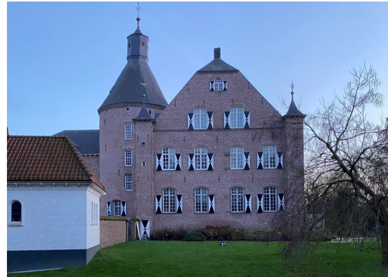
Foto van kasteel Aldengoor te Haelen. Opvallend zijn hier ook de kleine hoektorens. Telefonisch contact met de huidige eigenaresse heeft geleid tot de constatering dat de torens toiletten bevatten. Of dit in de historische situatie ook zo was is niet te verifiëren, onbekend is of een gedegen bouwhistorisch onderzoek heeft plaatsgevonden bij de restauratie. Bron foto: auteur.
