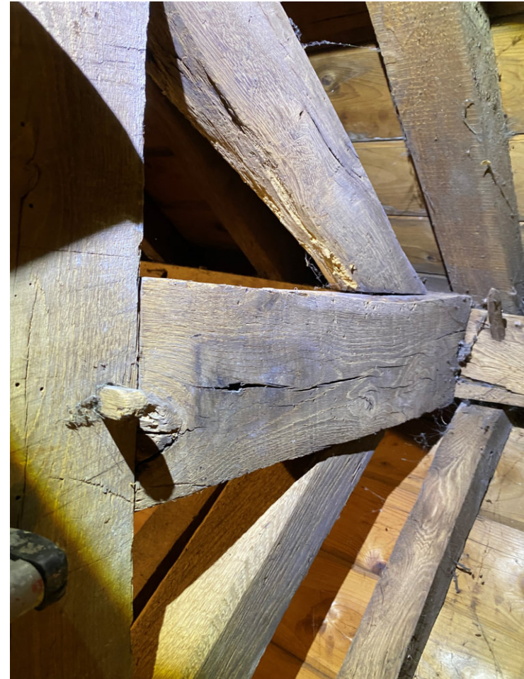
Afdruk en nagelgat zichtbaar in gebintstel 2
