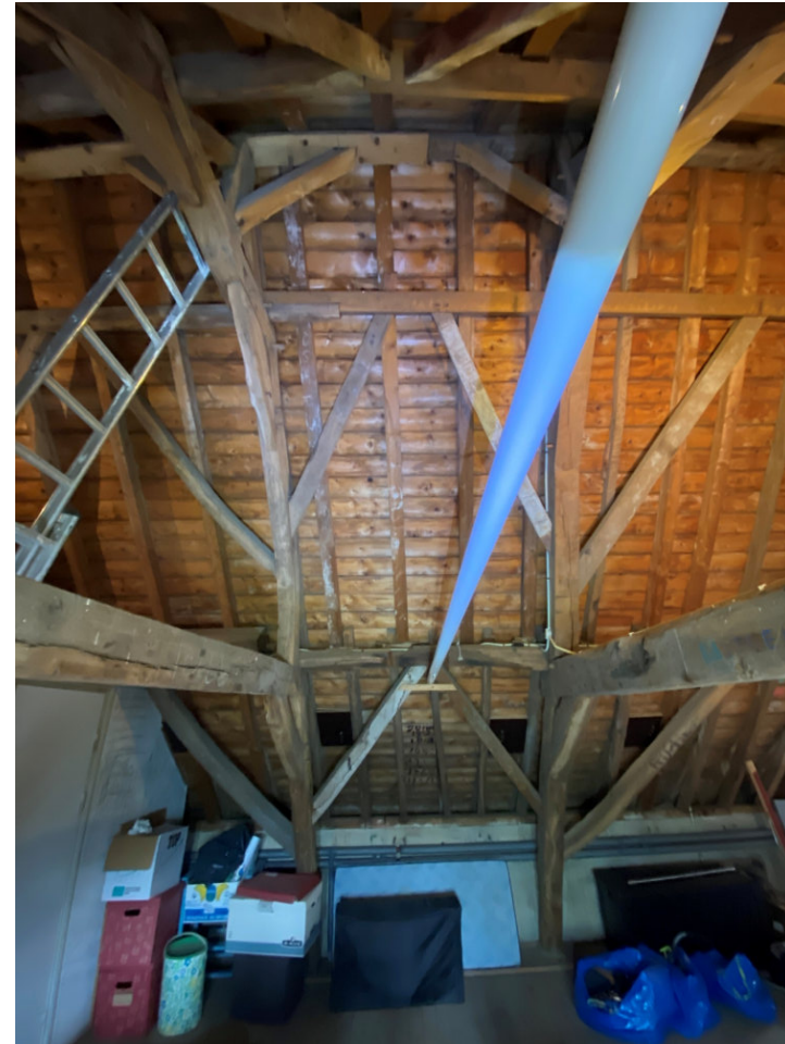
Travee IV in noordelijke richting. Vervangen sporen boven eerste gording en las in nokgording.
