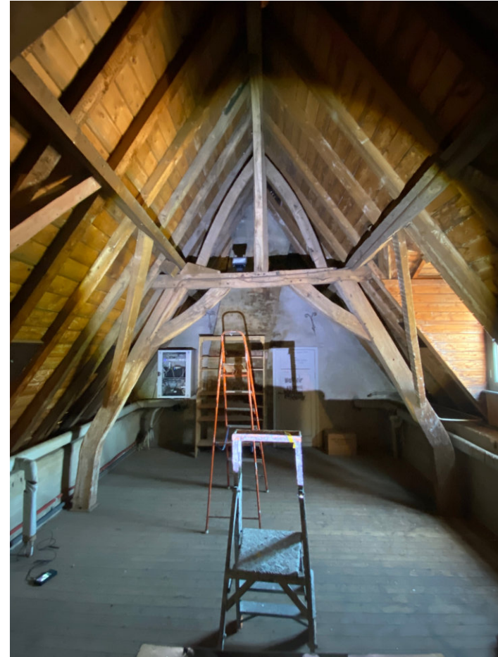
Gebintstel 9 met kromme korbelen en schoren in rustiekere uitstraling.
