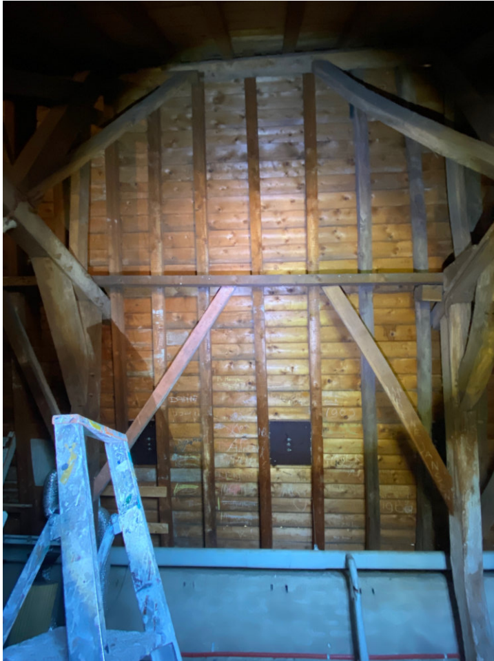
Travee X in westelijke richting waarop (naast twee oorspronkelijke rechts) sporen in vuren zichtbaar zijn evenals vernieuwde schoren. Daarnaast ligt de naaldhouten gording bovenop de oorspronkelijke eiken
