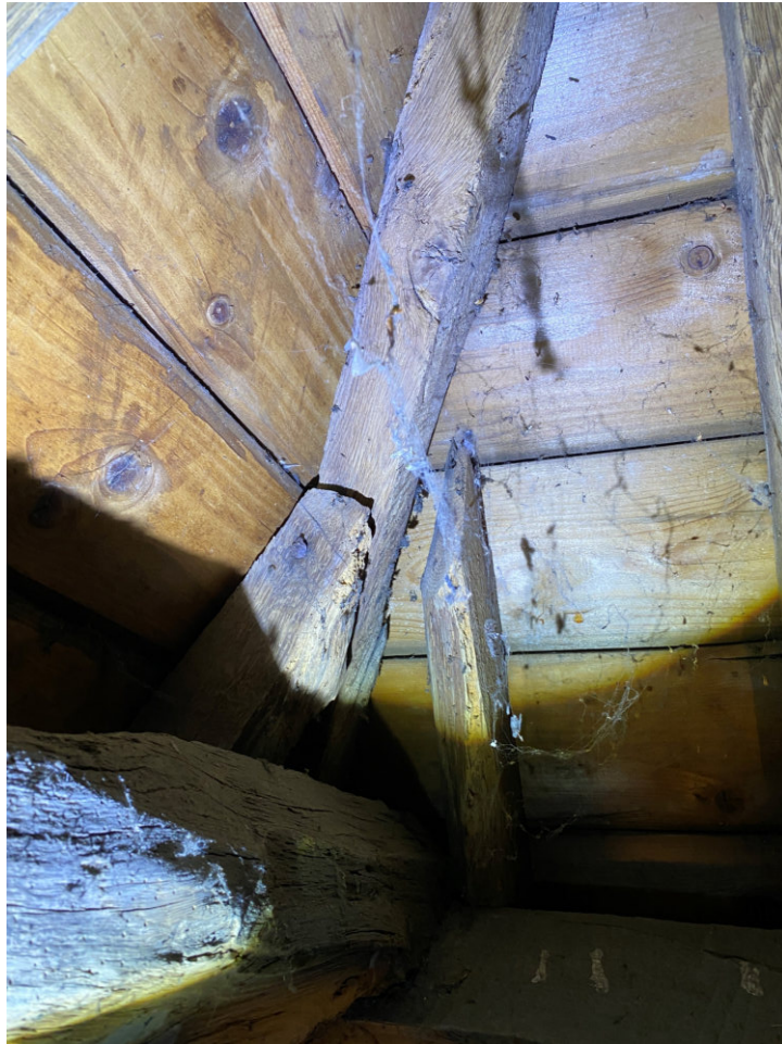
Hoekkeper travee I zuidelijke zijde waarop geen opmerkelijke zaken te bespeuren zijn.
