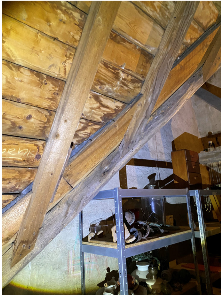
Hoekkeper travee VII noordelijke helft waarop geen opmerkelijke zaken te bespeuren zijn
