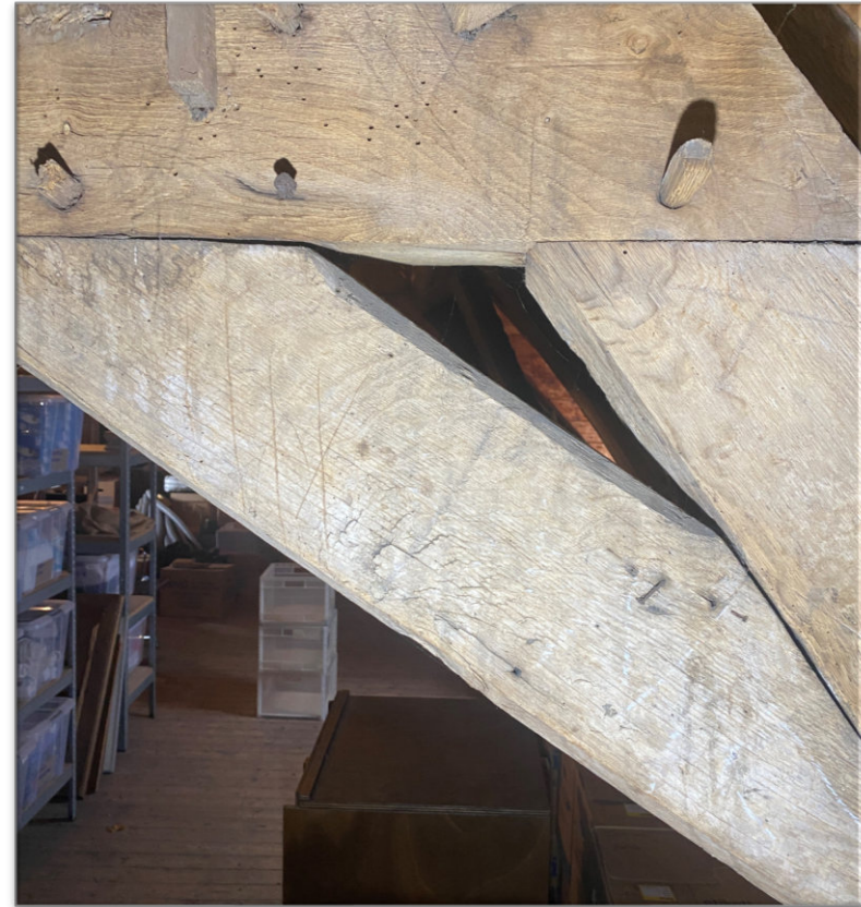
Detail van knoop tussen krommer, korbeel en debalk waarin alleen gekraste telmerken aanwezig zijn. Het korbeel, de krommer de debalk zijn in de driehoek waar deze elkaar opsluiten rondom voorzien van een aangeschaafde kapel (in kasteel Soelen, kort na 1578, komt dit ook voor, bron: Leo Wevers).
