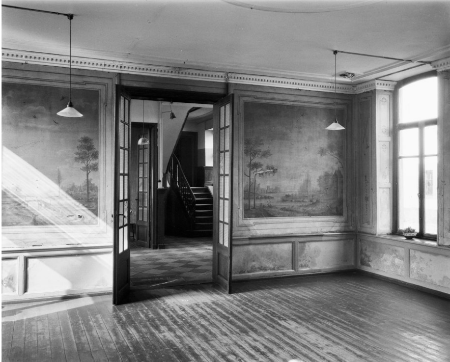
Historisch zicht in de salon in westelijke richting. De porte-brisée is duidelijk zichtbaar evenals de lambrisering en de geschilderde wandbespanning. De vensters zijn de stolpvensters met tussenroedes in 19 de -eeuwse stijl en de dagkanten zijn voorzien van gedecoreerde panelen of blindluiken. De lambrisering en het gros van de panelen is spoorloos verdwenen ten tijde van de restauratie in 1953-1955.
