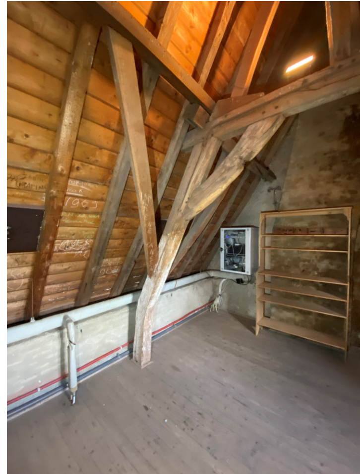
Overzicht gebint in bouwdeel A. Doordat deze krommers een wat hoekiger voorkomen hadden dan de constructie boven bouwdeel B zou het logisch zijn dat deze bij de aanpassingen van de topgevel en de sporen zou horen. Nadere beschouwing laat echter zien dat gebintstel 9 duidelijk typologische overeenkomsten heeft met gebintstellen 1 t/m 8. Dendrochronologisch onderzoek kan uitsluitsel geven over de bouwfase. Meervoudige kapconstructie, volgens Kappen in Nederland referentie 213 d'Erp te Baarlo. Kromstijlgebint en nokgebint met gordingen ipv flieringen in eiken voorzien. Gedateerd algemeen XVI, in referentie na 1578, type l.b.k+n. Het kromstijlgebint is handbezaagd. Dakbeschoot in naaldhout evenals betimmering dakkapel en versterking sporen rond dakkapel.
