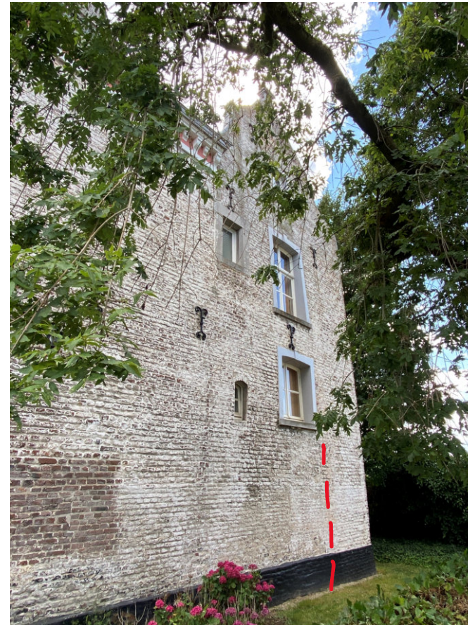
De noordelijke gevel van bouwdeel C en de overgang naar bouwdeel D. De kleine vensters links van de centrale as zijn tijdens de restauratie ingebracht, bij de vensters in de centrale as zijn nog sporen (ontlastingsbogen) zichtbaar van eerdere vensters, de huidige vensteromlijstingen passen bij de overige 18 de eeuwse aanpassingen. In de noordwesthoek zijn tijdens de restauratie restanten van de fundering van een mogelijke toren met waterput aangetroffen en heeft aanmerkelijk herstelwerk van metselwerk in deze hoek plaatsgevonden. Het bouwvlak van deze toren is vermeld op de kadastrale minuut uit 1817, in rood gestippeld waar de toren naar buiten zou zijn gekomen.
