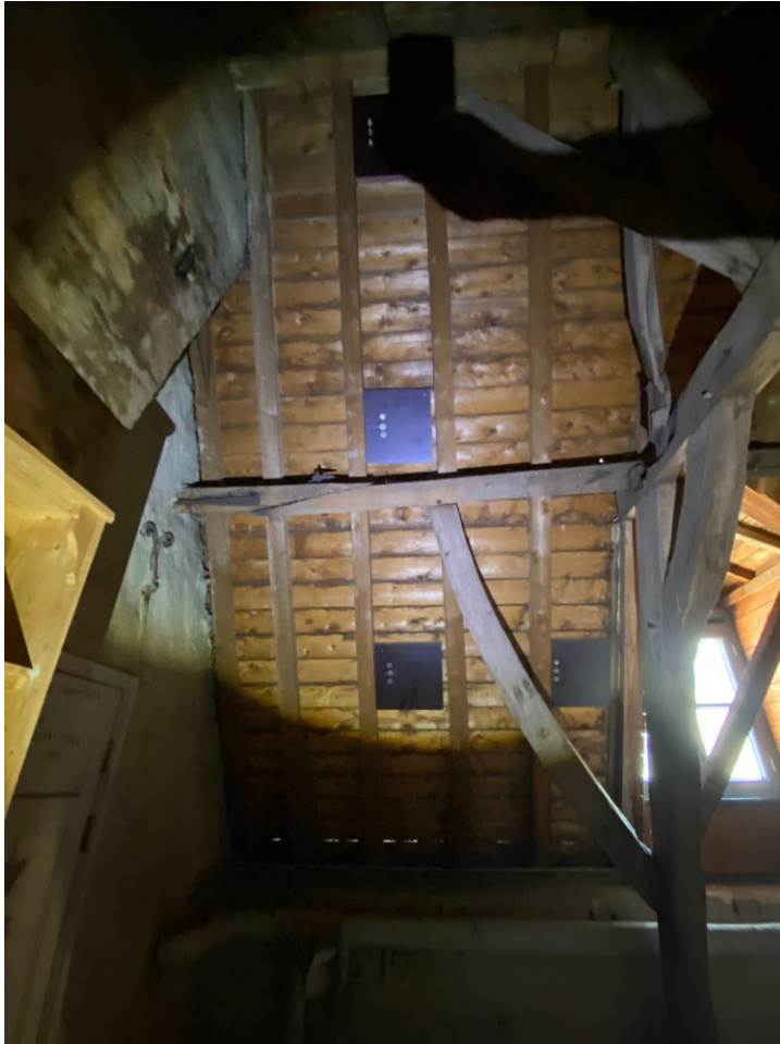
Travee XI in oostelijke richting met schoren en gordingen in eiken en sporen in vuren.
