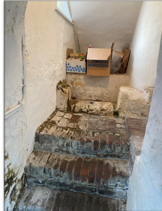
Zicht in hal A.0.1 waarin de oorspronkelijke trap uit de bouwtijd van bouwdeel B (en loop van de trap) zichtbaar zijn. De huidige 18 de eeuwse trap naar de eerste verdieping begint achter deze trap te stijgen.
