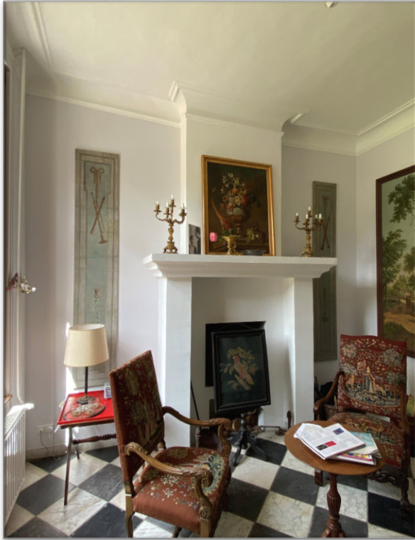
De schouw in de hal is ingebracht ten tijde van de restauratie ten behoeve van verwarming van de toenmalige eetzaal in deze ruimte. Historische foto's laten hier een centraal geplaatste entree deur zien naar de achtergelegen stijkkamer (B.0.3). De vloer- en plafondbewerking zijn historisch geïnspireerd echter ze stammen uit de restauratiefase.
