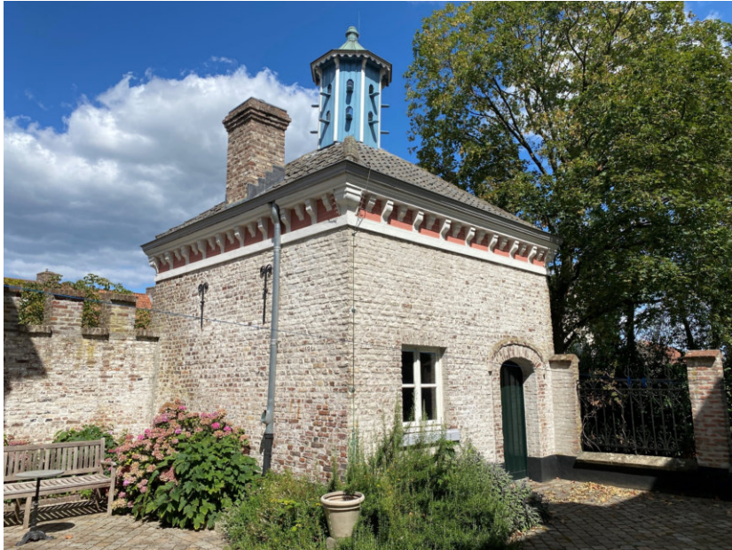
Aanzicht van bouwdeel E vanuit het binnenhof. De toegangsdeur en het raam zijn gewijzigd ten tijde van de restauratie in 1953-1955 evenals de schoorsteen (de huidige schoorsteen is in fase VIII gerealiseerd). De consolelijst heeft dezelfde thematiek als bouwdeel C en kleine hoekpaviljoens passen bij bouwstijl van 17 de eeuwse kastelen. De muurankers passen stilistisch echter bij bouwdeel B, deze zijn mogelijk later ingepast bij aanpassing van vloerconstructie en/of niveau.
