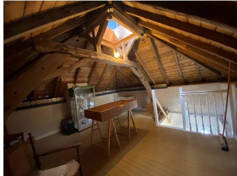
De kapverdieping van bouwdeel E is voorzien van nieuwe sporen en beschieting. Het toegepaste gebint sluit niet aan op de vloerbalken wat een verplaatsing zou suggereren (waar door klezorbeëindigingen in het metselwerk buiten geen bewijs voor gevonden kan worden) of een afwijkende vloerhoogte.
