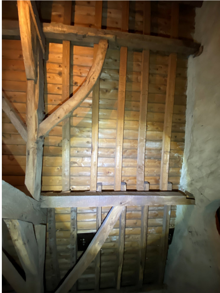
Travee VI in zuidelijke richting waarop vernieuwde sporen boven onderste gording
