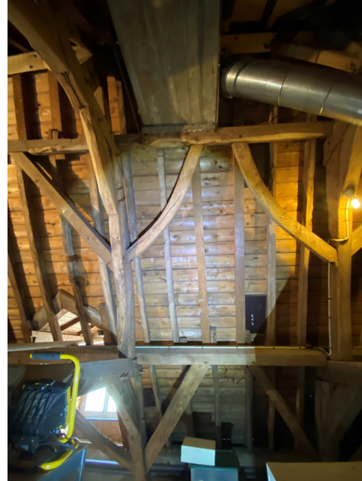
Travee II in noordelijke richting. Vernieuwde sporen incidenteel en ingevoegde ondersteuning voor schoorsteen.
