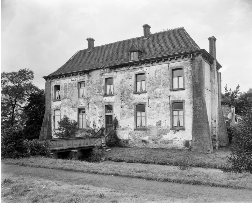
Historisch zicht op zuidzijde bouwdeel B. Opvallend zijn de steunberen op de hoeken (waaronder in elk geval onder de zuidoostelijke funderingen van een toren zijn aangetroffen), afwijkende positie dakkapel en dakdoorvoeren, de externe rookgasafvoer in de oostgevel. De gevel als geheel is zichtbaar gestuct geweest doch door verwerking en oorlogsschade deels ontleisterd. De oorspronkelijke brug is nog zichtbaar evenals de 19 de eeuwse vensters.
