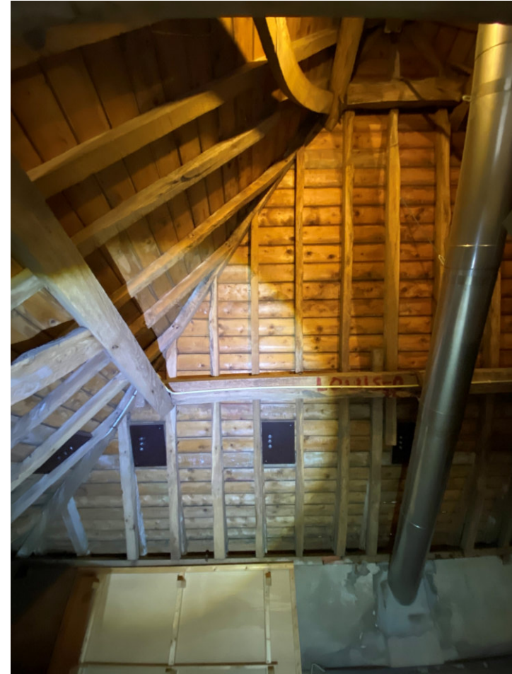
Travee I (noordelijke helft) in oostelijke richting:
