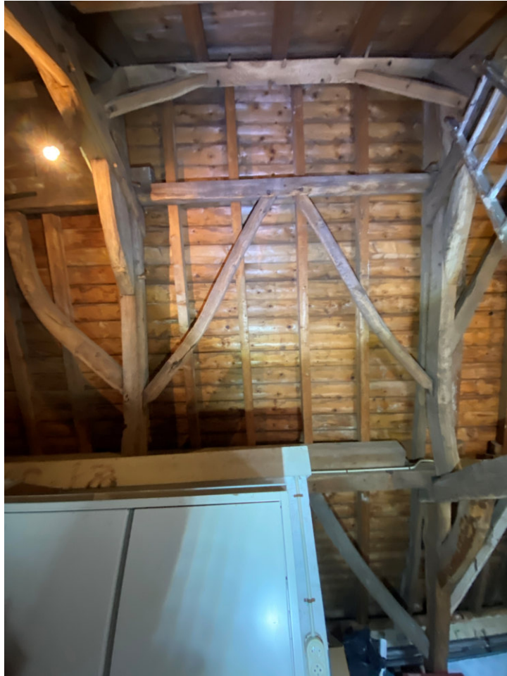
Travee V in noordelijke richting. Vervangen sporen, nokgording is omgekeerd.
