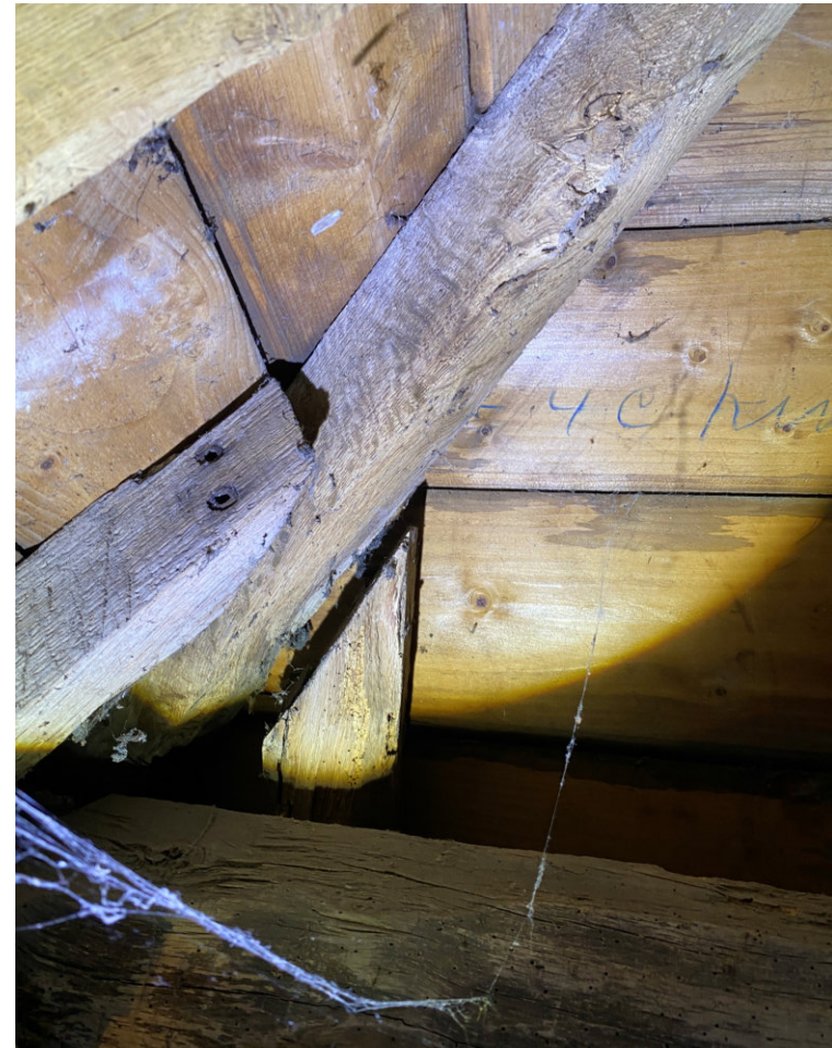
Hoekkeper travee I-noordelijke zijde waarop geen opmerkelijke zaken te bespeuren zijn.:
