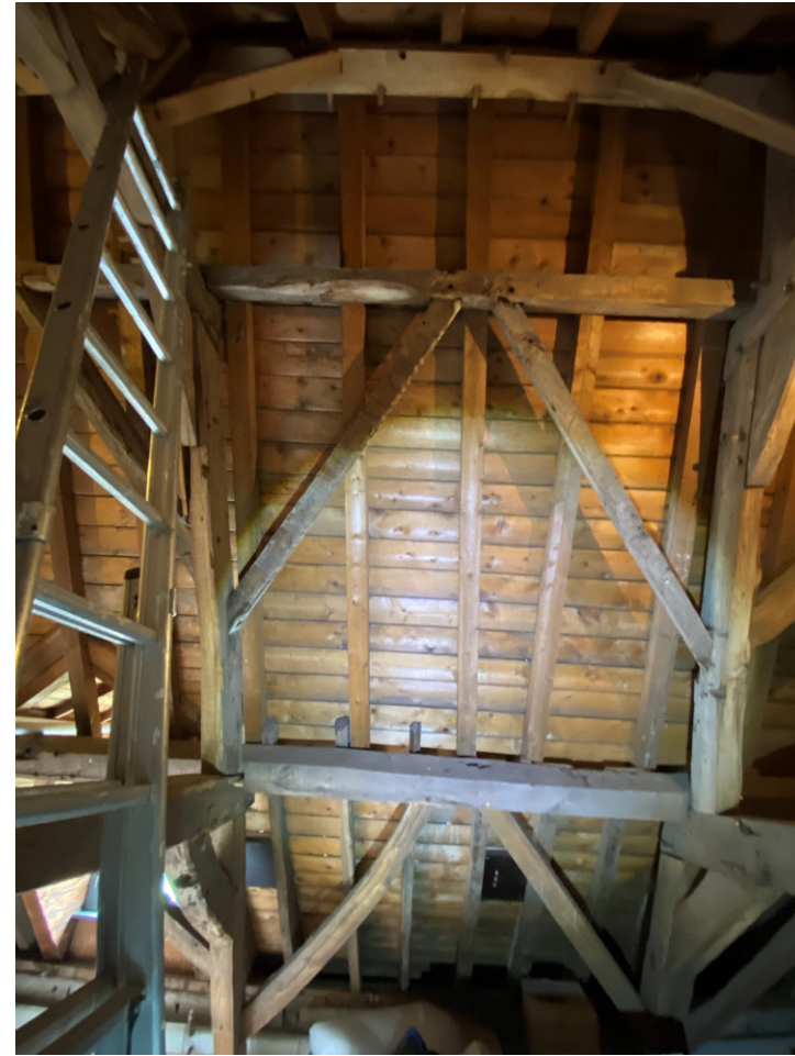
Travee V in zuidelijke richting waarin vernieuwde sporen boven onderste gording.
