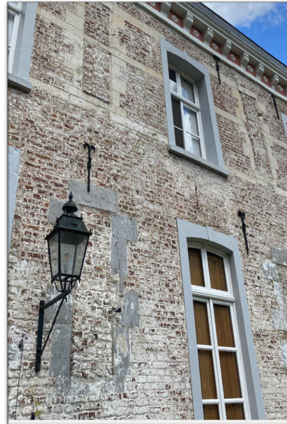
De secundair ingebrachte vensters met gestucte lijst in algemeen 18 de -eeuwse stijl. Op de begane grond is de negge van de kozijnen veel kleiner dan op de etage: de formele ruimtes op de begane grond hebben aanmerkelijk diepere dagkanten die het licht naar binnen begeleiden en ruimte bieden voor vouwblinden die (in elk geval in de salon) op historische foto's zichtbaar waren. De kozijnen zijn 20 ste eeuws van uitvoering en zijn tijdens de restauratie ingebracht.
