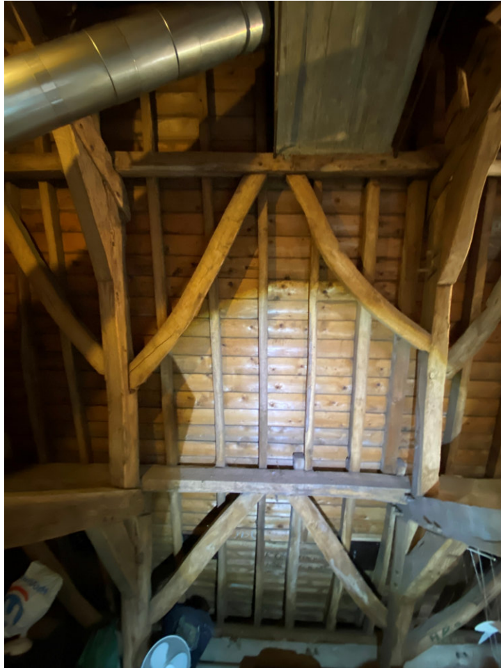
Travee II in zuidelijke richting waarop incidenteel vernieuwde sporen
