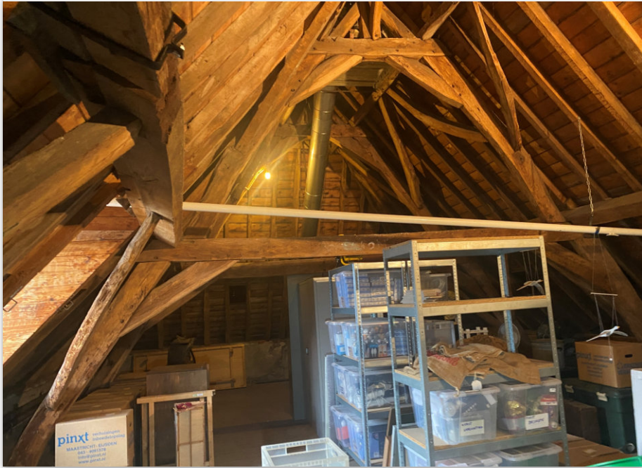
Overzicht van gebinten in blok B. Naar Kappen in Nederland van H. Janse is deze gebintvorm stilistisch te dateren XVIc. De telmerken zijn niet in dezelfde stijl aangebracht maar wel doorlopend uitgevoerd.
