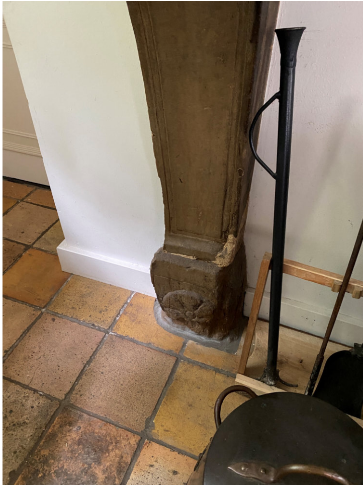
Basement met sterrenwiel als centraal motief. De vloerafwerking bestaat uit later ingebrachte plavuizen.
