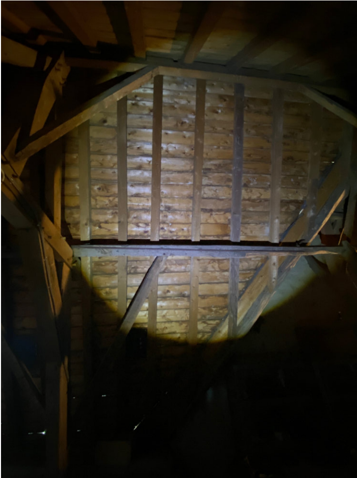
Travee IX in oostelijke richting met eiken gording en sporen in vuren.
