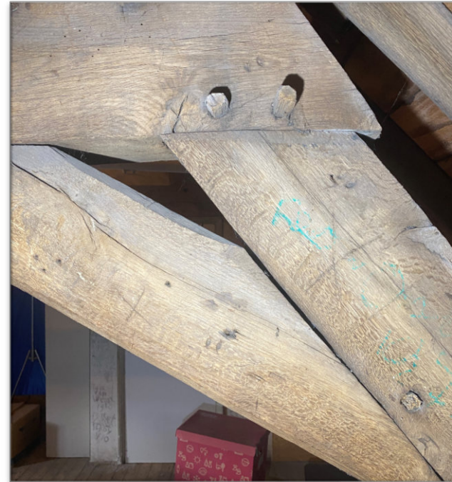
Detail van knoop tussen krommer, korbeel en dekbalk waarin zowel gekraste pasmerken (kruisvorm) als met een guts gehakte telmerken aanwezig zijn. Het korbeel is hier voorzien van een aangeschaafde kapel.
