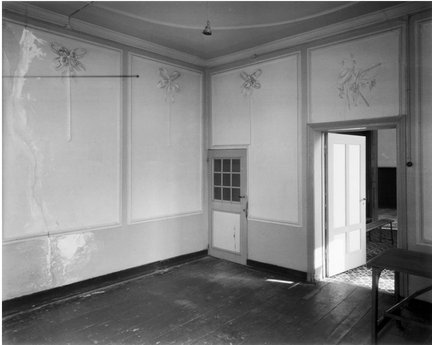
Historisch zicht op stijlkamer B.0.3 richting de hal. De oorspronkelijke toegang is nu vervangen door een schouw. De afleesbaarheid van de hoofdstructuren in het pand zijn daarmee verstoord. De oorspronkelijke houten vloer is hier nog aanwezig.
