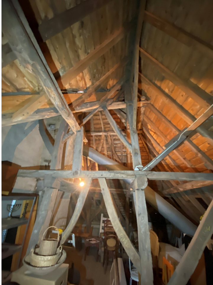
Overzichtsfoto steunconstructie op overgang tussen bouwdelen A en B geplaatst buiten bouwdeel A.
