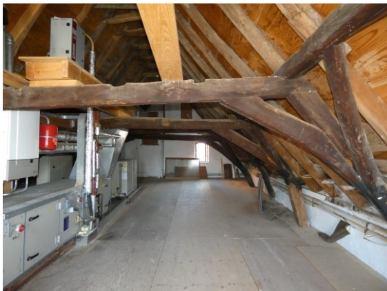
Afbeelding 3.95 De kapconstructie naar het oosten gezien. Waarvoor de loeven in de voorste jukdekbalk dienden, is onduidelijk: in de andere dekbalken ontbreken ze.
