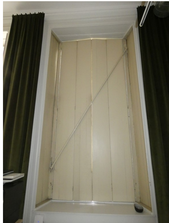
Afbeelding 3.39 De gesloten vensterblinden, met sluitboom.
