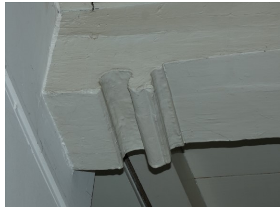
Afbeelding 3.68 Een origineel sleutelstuk op de begane grond, met de moerbalk uit één stuk gesneden.
