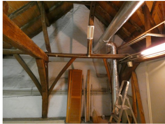
Afbeelding 3.23 De scheidingsmuur op de zolder van het voorhuis, naar het zuiden gezien. De ezelsruggen van de oudere zijgevel van bouwdeel 1b tekenen zich in de muur af.
