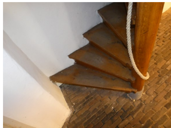
Afbeelding 3.99 Het onderste deel van de spiltrap.
