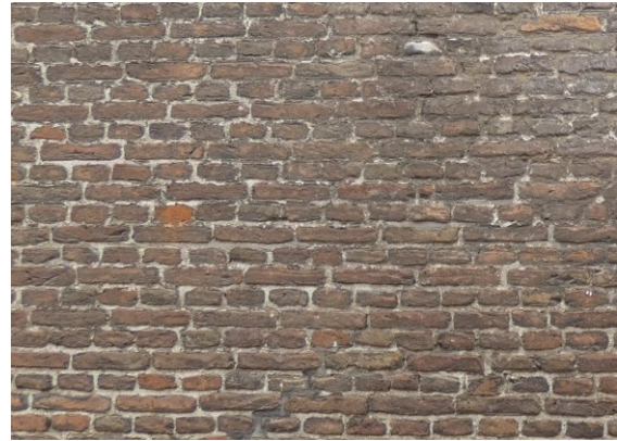
Afbeelding 3.104 Het metselwerk van de straatgevel.
