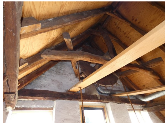
Afbeelding 3.96 De hijnsinstallatie.
