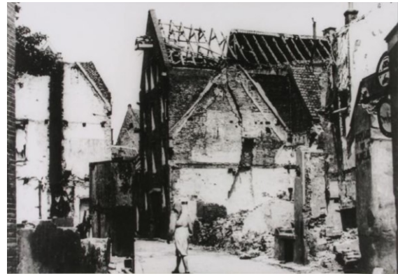
Afbeelding 2.22 Oorlogsschade aan het pakhuis, februari 1945. Bron: beeldbank Erfgoed Centrum Zutphen, 0250-P 10075.
