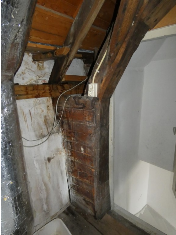
Afbeelding 3.60 De aftimmering tegen de krommer, naast de deur van de trapopgang.
