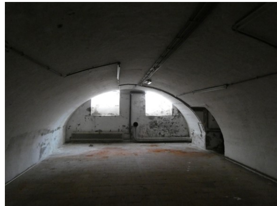
Afbeelding 3.22 De noordelijke kelder, naar de straat gezien.
