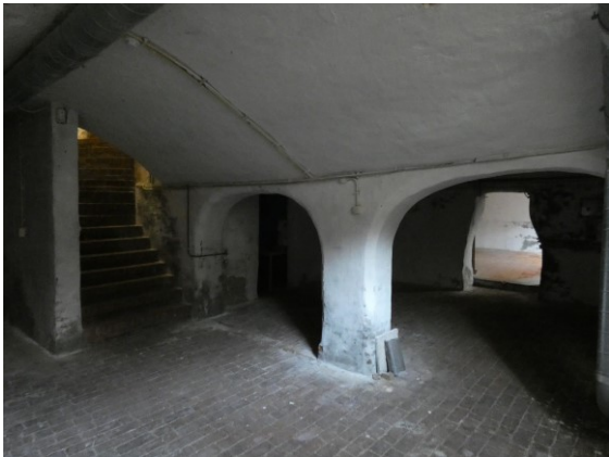
Afbeelding 3.20 De gekoppelde kelder met scheibogen en links de trap vanuit het zuidelijke voorhuis. Rechts achteraan de doorgang naar de andere kelder.
