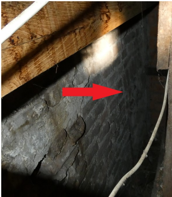
Afbeelding 3.25 De achtergevel net onder de muurplaat, met rechts sporen van een klein dichtgezet venster. De pijl wijst op het linker uiteinde van een segmentboog.
