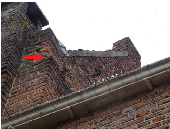
Afbeelding 3.88 De topgevel van het tussenlid is geplaatst op de tuitgevel van het pakhuis. De rode pijl wijst de verspringing in het metselwerk aan.
