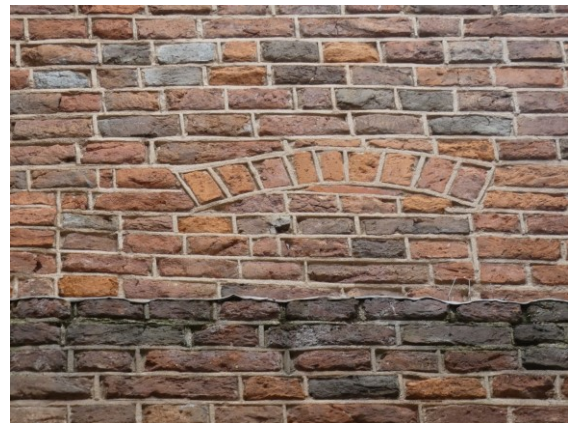
Afbeelding 3.19 Geen dichtgezet venster maar een historiserende beklamping. Let ook op het zeer onregelmatige metselverband. Een loodstrip markeert de horizontale versprings van de muur.
