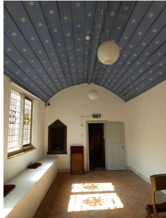
Afbeelding 3.75 De schuilkapel met het tongewelf naar het westen gezien. Links in de korte wand de omlijste muurnis.
