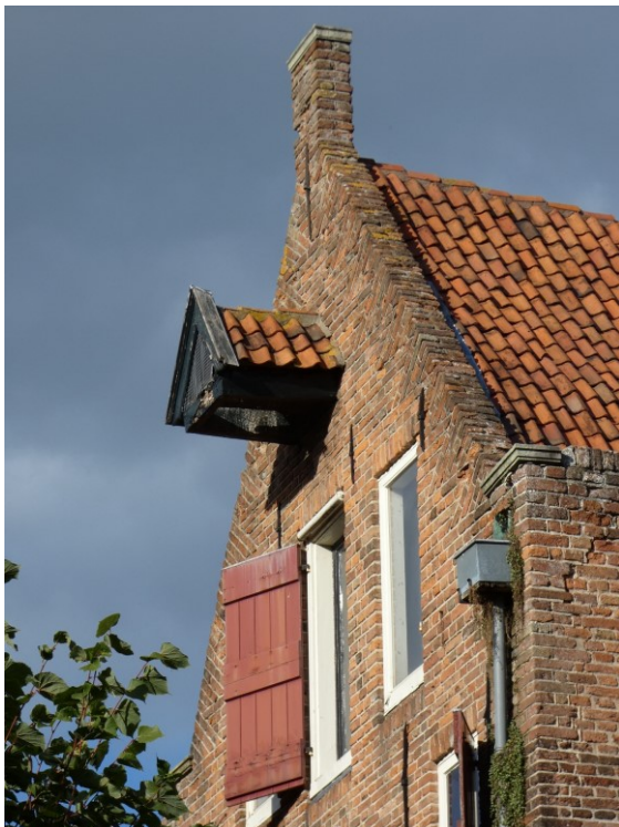
Afbeelding 3.81 De in 1961 opnieuw opgemetselde top van de pakhuisgevel, met de hijskast, vlechtwerk en natuurstenen afdekplaten.
