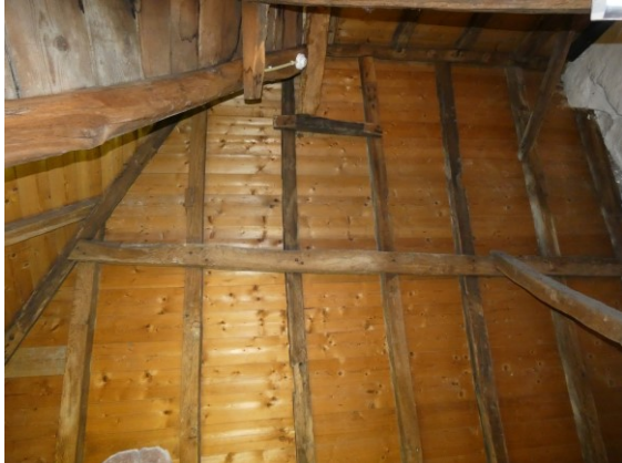
Afbeelding 3.28 De nok van de langskap aan de voorzijde. Linksboven de versleepte schoorsteen, rechtsboven de scheidingsmuur. In de sporen zijn sleuven zichtbaar: tekenen van eerder gebruik.
