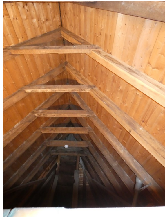
Afbeelding 3.30 De dwarskap naar het westen gezien. Helemaal achteraan de versleepte schoorsteen.
