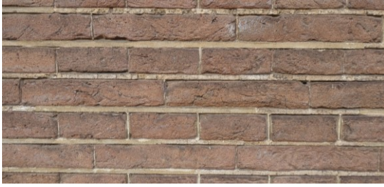
Afbeelding 3.13 Schoon metselwerk in kruisverband met gesneden voegen en smalle stootvoegen.
