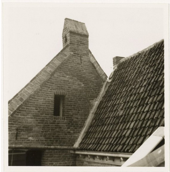
Afbeelding 3.89 De top van de tuitgevel tijdens de restauratie van 1961-1963. Rechts van het venster zijn sporen van een dichtgezet venster zichtbaar.
