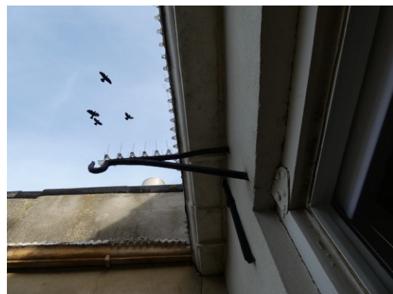
Afbeelding 3.15 Een detail bovenin gevel B: deze haak boven het linker zoldervenster.
