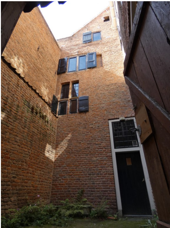
Afbeelding 3.87 De achtergevel van het pakhuis.
