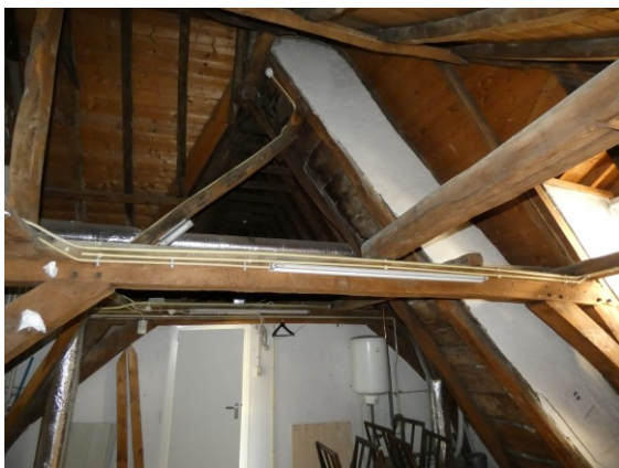
Afbeelding 3.29 De kap naar het westen gezien, met rechts de versleepte schoorsteen en links een kreupele stijl op de jukdebalk.
