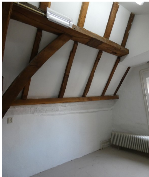
Afbeelding 3.24 De achterzijde van de zolder van bouwdeel 1a. Direct onder de muurplaat valt het uitkragende metselwerk op. Een gat rechts onder in de fliering wijst op een verwijderde windschoor.
