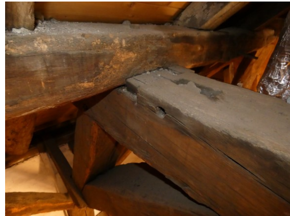
Afbeelding 3.32 Sporen van hergebruik op een jukdebalk in bouwdeel 1b: een ongebruikt pengat.
