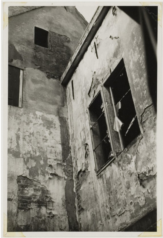
Afbeelding 2.24 Achterzijde van het pakhuis (links) en de vensters van de schuilkapel in deplorabele staat, 1956. Bron: beeldbank Erfgoed Centrum Zutphen, SZU002024531.
