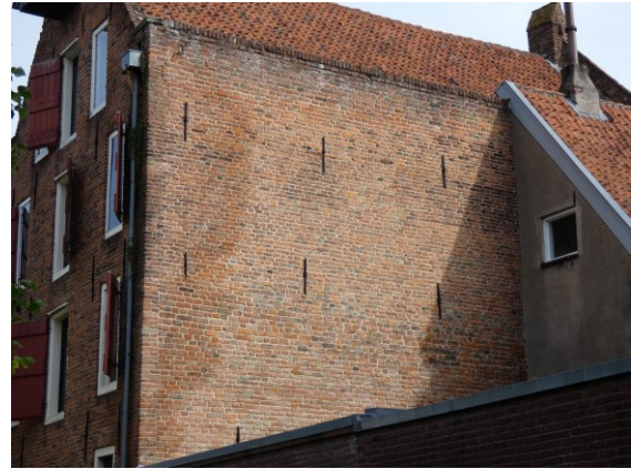
Afbeelding 3.90 De rechter zijgevel, met rechts de aanbouw op het aangrenzende perceel.
