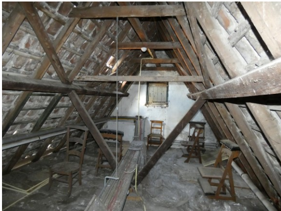
Afbeelding 3.70 De zolder van het tussenlid naar het oosten gezien. Bovenin rust een langs balk op de hanenbalken.
