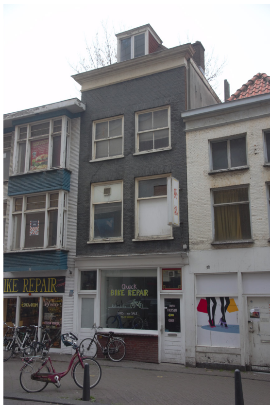
2) Gedempte Gracht 675 in 2019. Het pand dankte zijn uiterlijk hoofdzakelijk aan twee bouwfases uit circa 1877 en 1889-1890. (foto P.J. Bosman)
