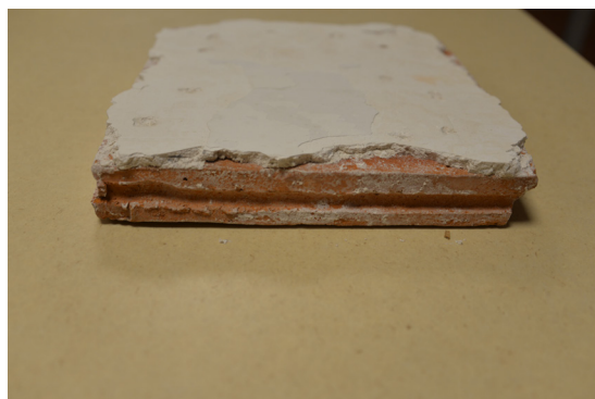
3) Zijkant en gepleisterde voorzijde klamptegel Apothekersdijk 25. (foto ELO, E.D. Orsel)
