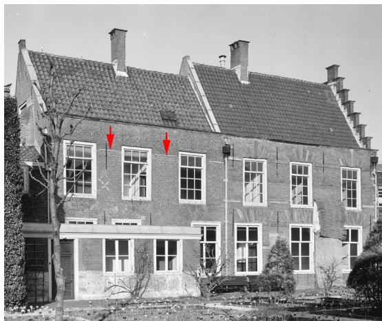
7) Foto uit 1964 van Vijfde Binnenvestgracht 7a in Leiden. In het bouwdeel links van het Staten-college is tussen de verhoogde vensters het voeglood zichtbaar van de in 1620 vermoedelijk verhoogde borstwering. (RCE, 88634)
