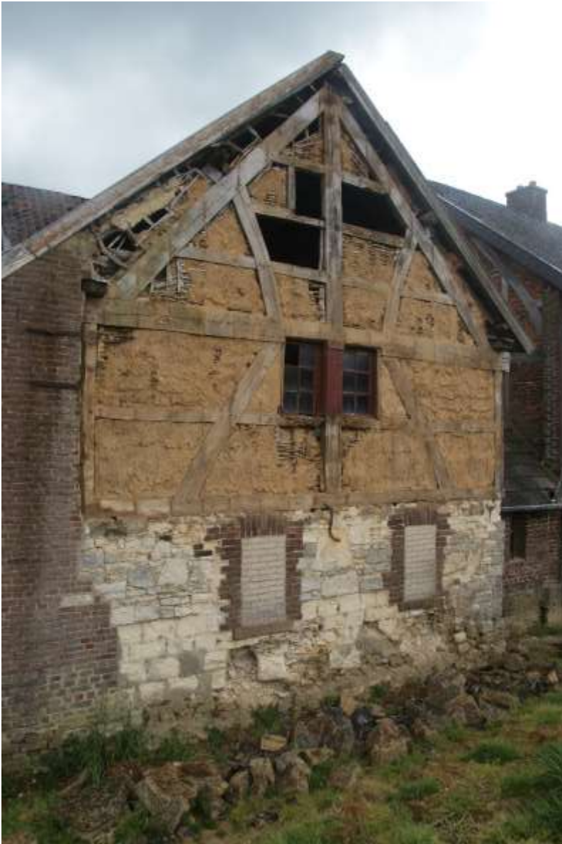
Figuur 51: Vijlense kalksteen op een fundering van vuursteenkeien in de achtergevel van bouwdeel 3b van het woonhuis in vakwerk. In de onderste 4 lagen hebben de stenen steeds dezelfde hoogte. In de lagen daarboven zijn verschillende afmetingen door elkaar gebruikt.
