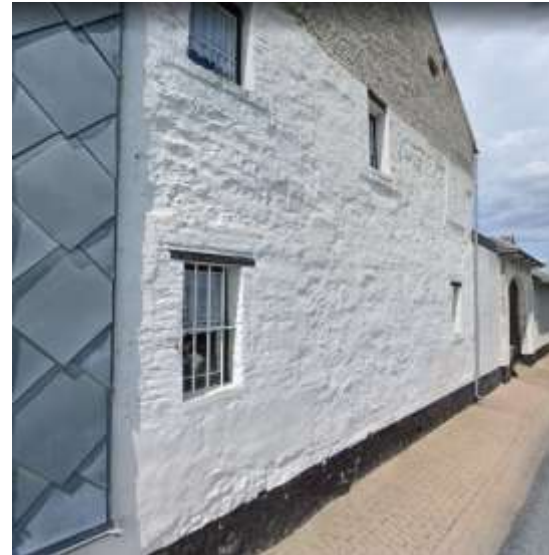
Figuur 58: Vijlense kalksteen onder een laag kalkwitsel aan de straatgevel van hoeve Höf, Harles 22 (1738) bron datering van Agt J.F. 1983 p. 33.
