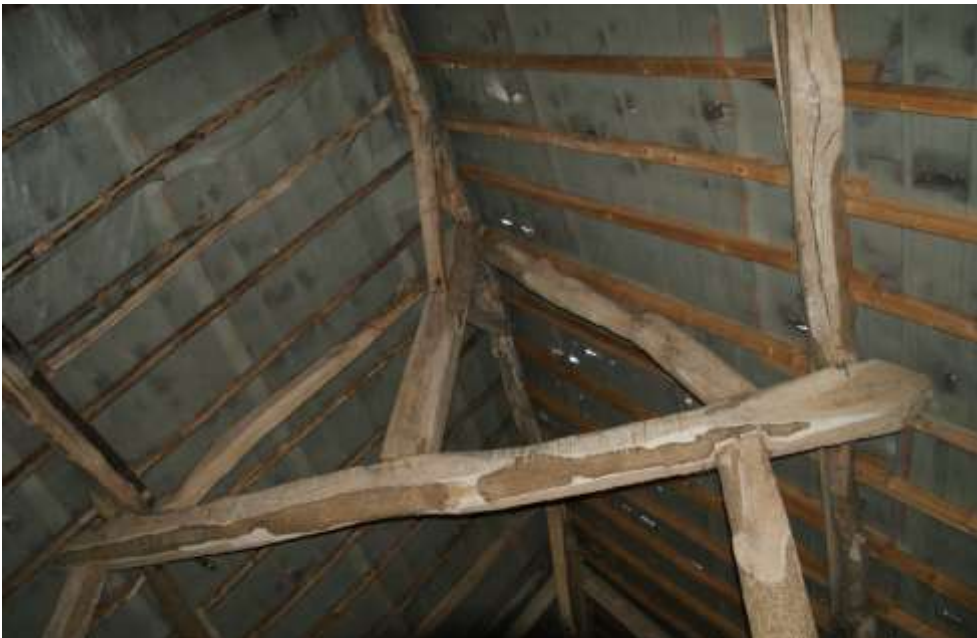
Figuur 13: Constructiehout met bast in de grote schuur (gebouw 3) hier eik, es en wilde-kers. De daksporen zijn van grove den (links). De grenen sporen (rechts) zijn in 1991 aangebracht en vallen buiten de scope van dit onderzoek.
