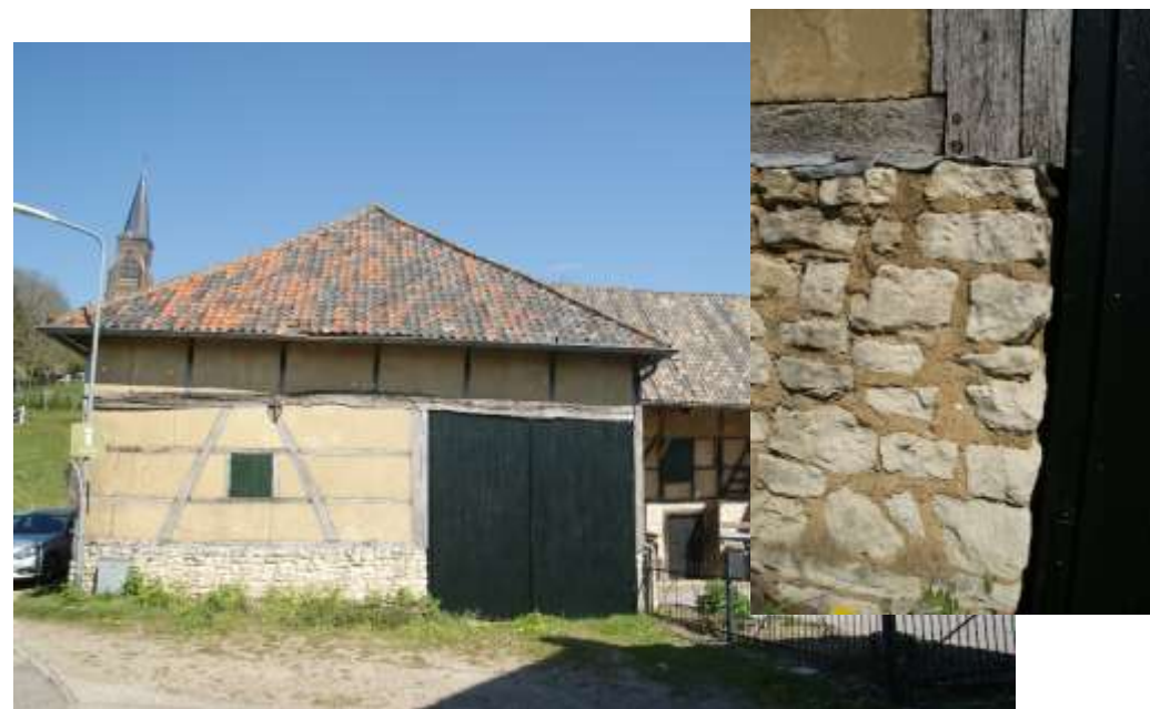
Figuur 54: Vijlense kalksteen in de plint van de schuur van hoeve Pannes Vijlenstraat 57 in Vijlen (XVIII) bron datering registerblad Rijksmonumentnr: 36709)
