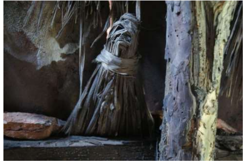
Figuur 109: Dertailopneme stropop onder de Oud-Hollandse pannen in het dakvlak van bouwdeel 3a.
