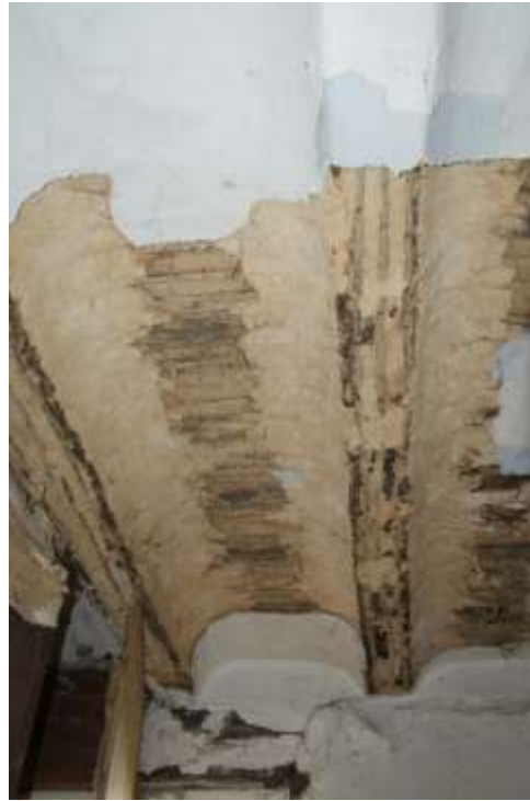
Figuur 29: Gespelderd plafond van wilgentwijgen met daarop leempleisterwerk en kalkwitsel in de vakwerkwoning (bouwdeel 3a).
