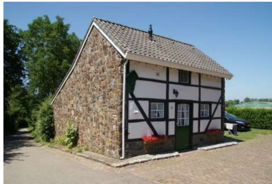
Figuur 76: Cottessen: Kopgevel van het woonhuis bij hoeve Termoeren (XVIII), Cottessen 8, van Epener kolenzandsteen. Af en toe zit er een vuursteen tussen. (bron: datering registerblad Rijksmonument 36650)
