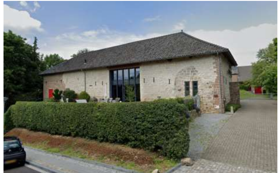
Figuur 61: Vijlense kalksteen hoeve St. Adalbert, Bloemendalstraat 11 in Vaals (foto: GoogleMaps)
