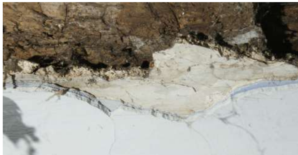
Figuur 97: verschillende lagen kalkwitsel op het leempleisterwerk van het plafond van bouwdeel 3a. een van de lagen is blauw dit zou vliegen weren (bron: Eggen 2016 p. 231)
