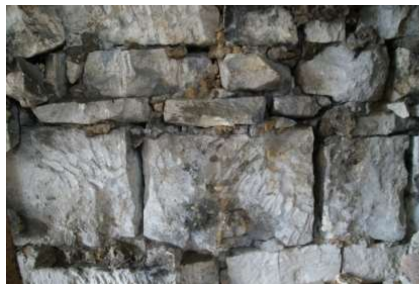
Figuur 50: Vijlense kalksteen in de wand van de schouw in het vakwerk- woonhuis (gebouw 3) met bewerkings- sporen van een beitel. Hier is leem als mortel gebruikt omdat deze beter bestand is tegen de hitte dan kalkmortel.
