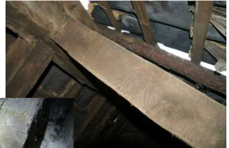
Figuur 14: Eikenhout in de kap van bouwdeel 3a herkenbaar aan de mergstralen. Daarboven een rondhouten spoor van grove den. Op het eikenhout zijn nog net de sporen van een kraanzaag te zien.
