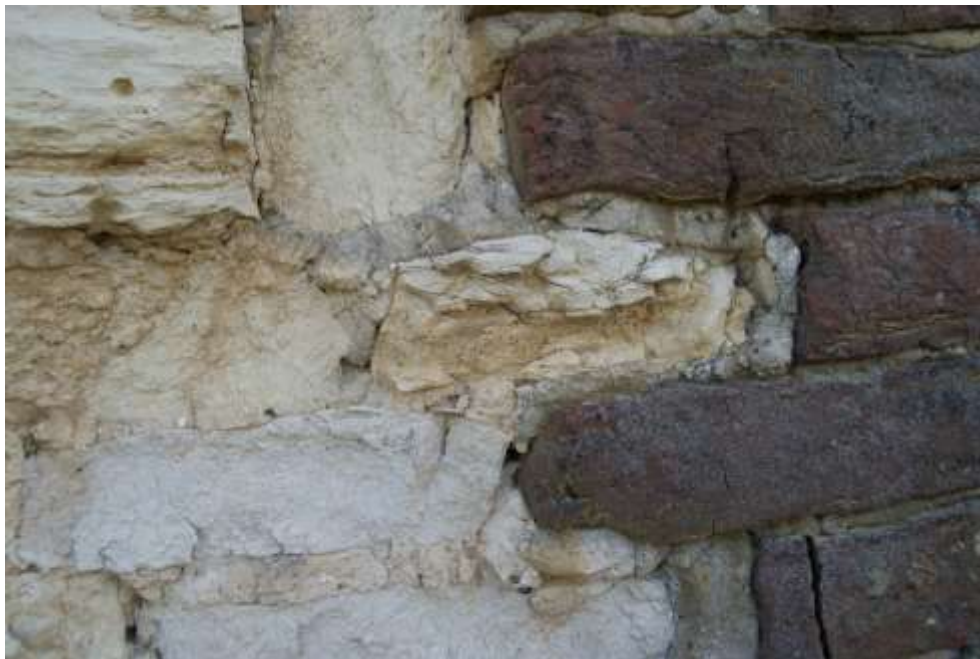
Figuur 95: met kalkspecie gemetselde Vijlense kalksteen en veldbrandstenen in de achtergevel van de uitbreiding van het vakwerkhuis (bouwdeel 3b).
