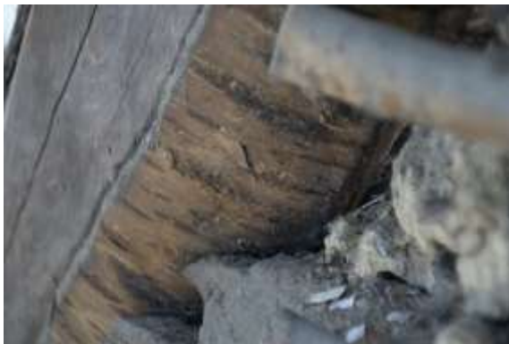
Figuur 16: Wilde-kers (links) en Es (rechts) in de kapconstructie van de grote schuur. Herkenbaar door de nog aanwezige bast. De bast van de Es wordt grover naarmate de boom ouder wordt. Hier nog de fijne bast (zie ook fig. 18)
