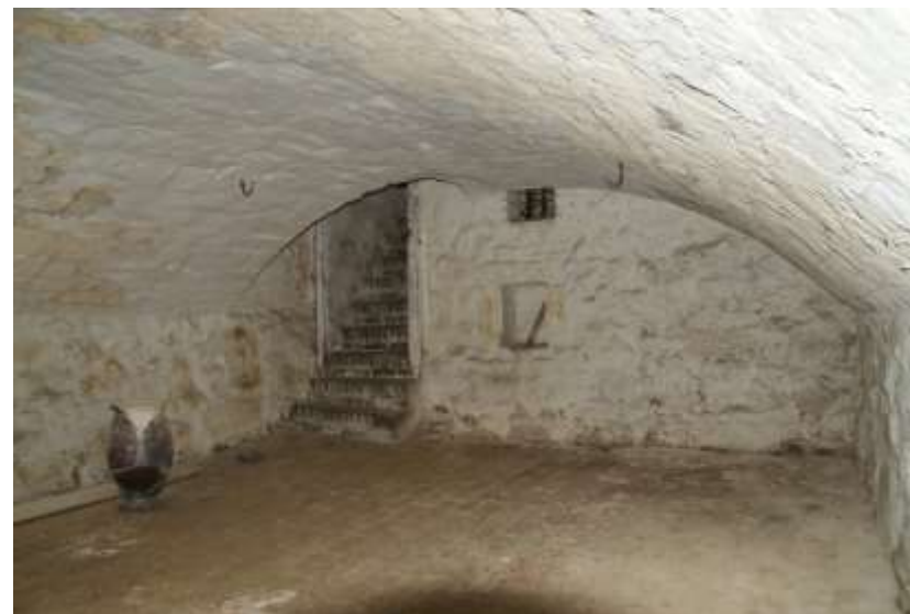
Figuur 41: Vuursteenkeien in de achtergevel van de kelder en de zijmuren met daarin de aanzet van het tongewelf bij de vakwerkwoning (gebouw 3). Beide voorzien van een laag kalkwitsel.
