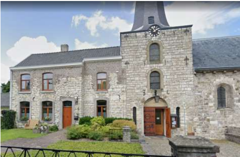
Figuur 64: Vijlense kalksteen bij de pastorie en kerk van Holset (foto: GoogleMaps). De toren is in 1736 volledig herbouwd en in 1841 hersteld. (bron datering: van Agt J.F. 1983 p. 18)
