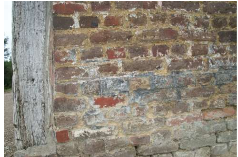
Figuur 104: Veldbrandstenen en kalkmortel in de voorgevel van de grote schuur bij bouwdeel 1b.
