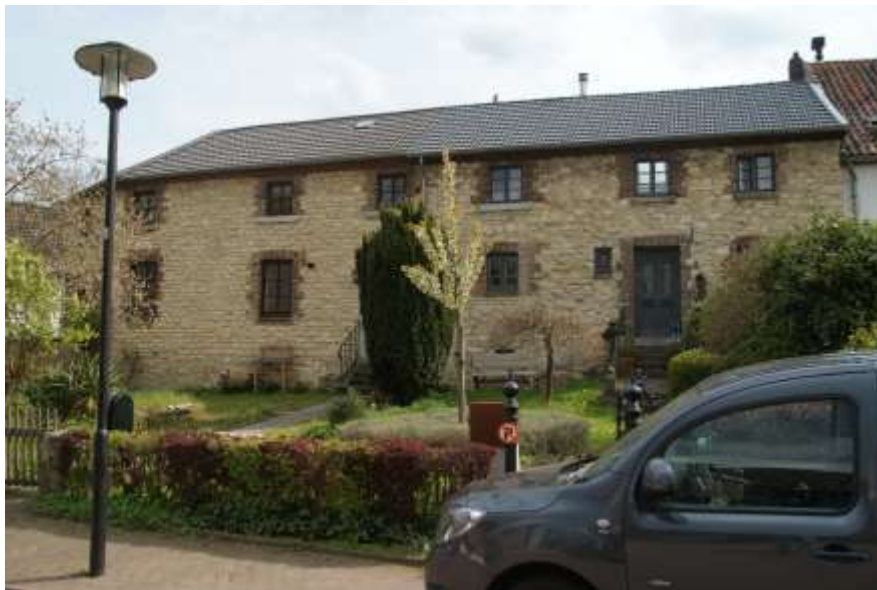
Figuur 60: Vijlense kalksteen in de plint van Oud Lemiers 31-33 in Lemiers (NL)
