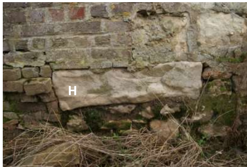
Figuur 78: Forse steen van Holset (H) op een fundering van vuursteenkeien als aanzet voor een inmiddels door baksteen vervangen hoekketting van de achtergevel van bouwdeel 3b. Daarboven, rechts, verweerde Vijlense kalksteen.
