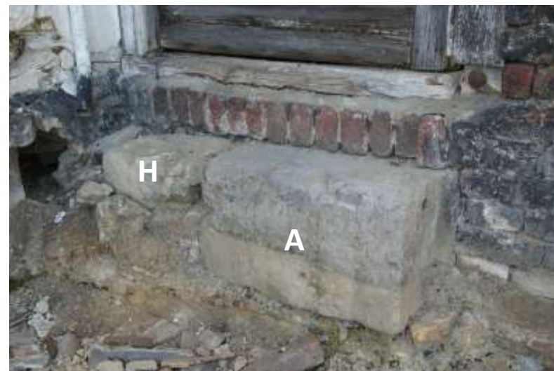
Figuur 86: Traptreden van hergebruikte Akense blauwsteen (A) en steen van Holset (H) bij de toegangsdeur van bouwdeel 3d.
