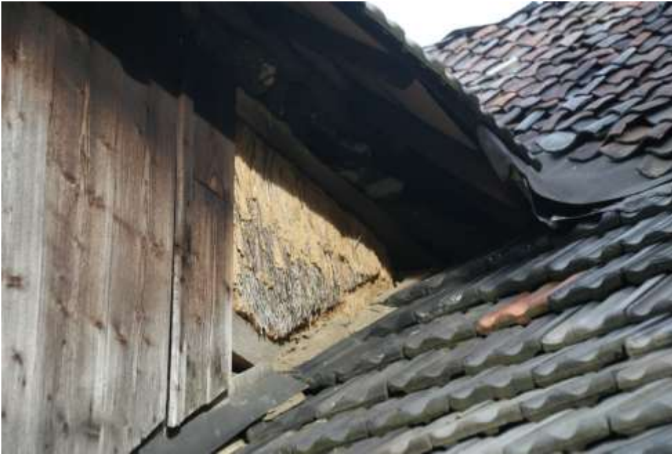
Figuur 111: Muldenpannen (rechts onder) op het dak van bouwdeel 3c en daarboven Oud-Hollandse panne op het dak van het vakwerkwoonhuis (bouwdeel 3a)
