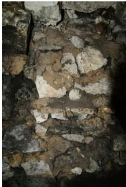
Figuur 100: leem gebruikt als metselmortel in de haardwand van bouwdeel 3a
