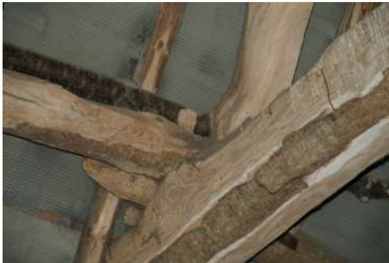
Figuur 16: Wilde-kers (links) en Es (rechts) in de kapconstructie van de grote schuur. Herkenbaar door de nog aanwezige bast. De bast van de Es wordt grover naarmate de boom ouder wordt. Hier nog de fijne bast (zie ook fig. 18)
