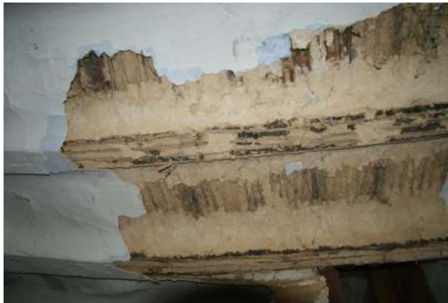
Figuur 101: leem als afwerking van de gespelderde plafonds in bouwdeel 3a
