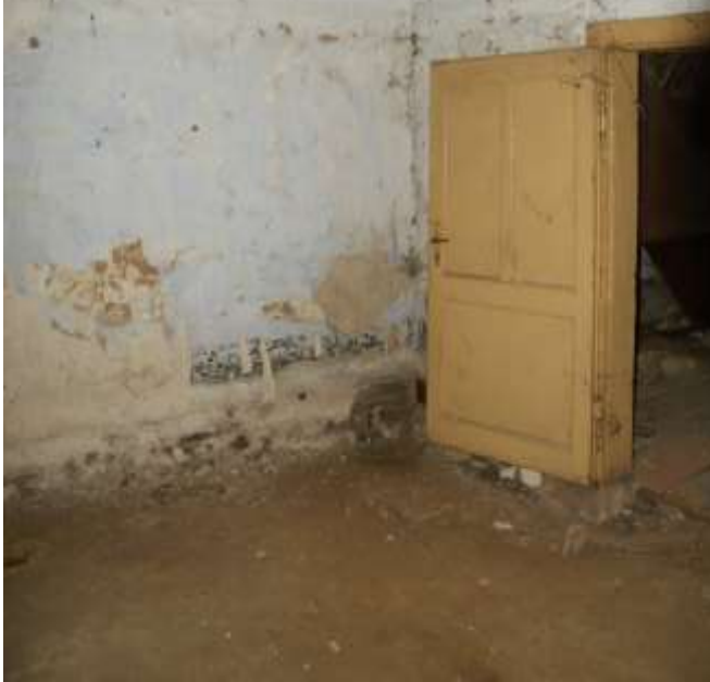
Figuur 103: leem mogelijk als oorspronkelijke vloerafwerking van bouwdeel 3b. Later werd daarover een houten vloer aangebracht.
