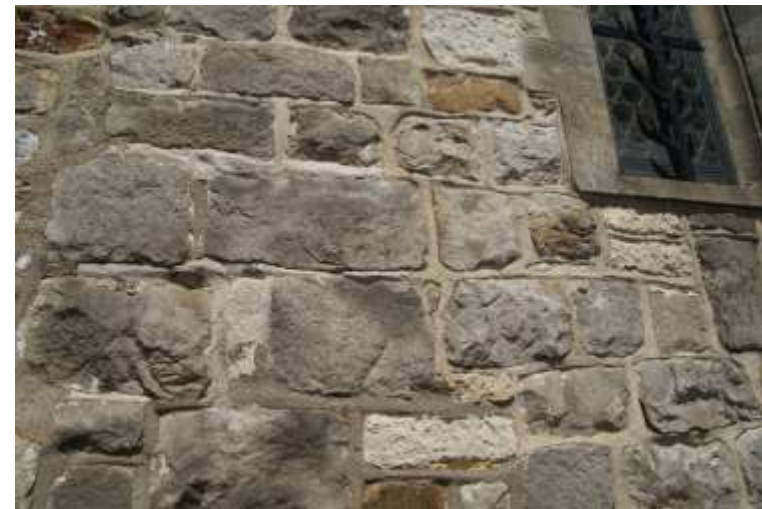
Figuur 83: H.H. Lambertus en Genovevakerk in Holset. Steen van Holset gebruikt.
