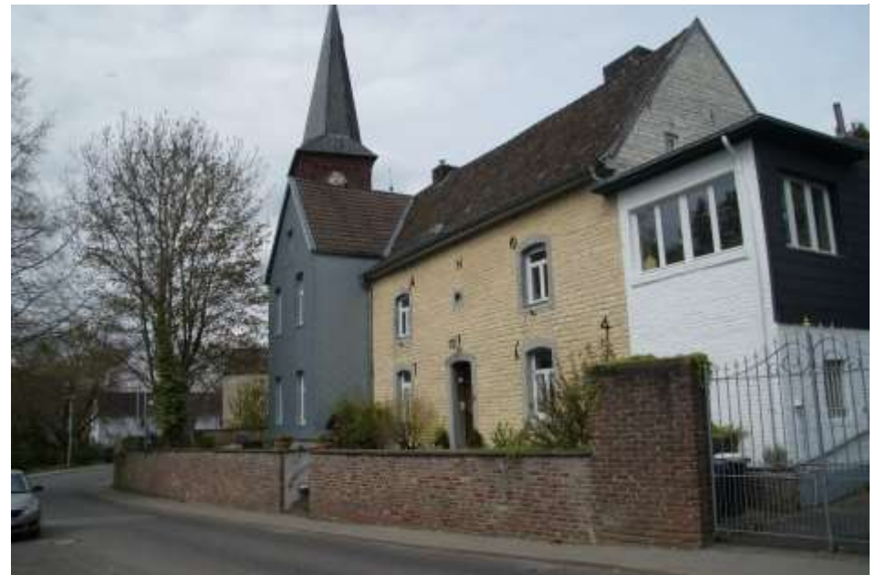
Figuur 62: Vijlense kalksteen bij de pastorie van Orsbach (D) Düserhofstraße 52 (1764) bron datering gevelankers.
