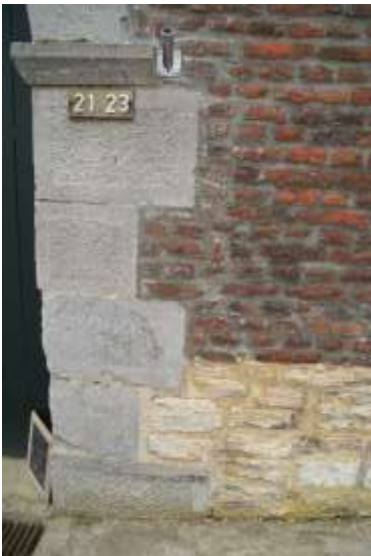
Figuur 89: Akense blauwsteen in de omlijsting van de poort (1623) van hoeve Mamelis, Mamelis 21-23. Links en rechts daarvan in de plint Viilense kalksteen.
