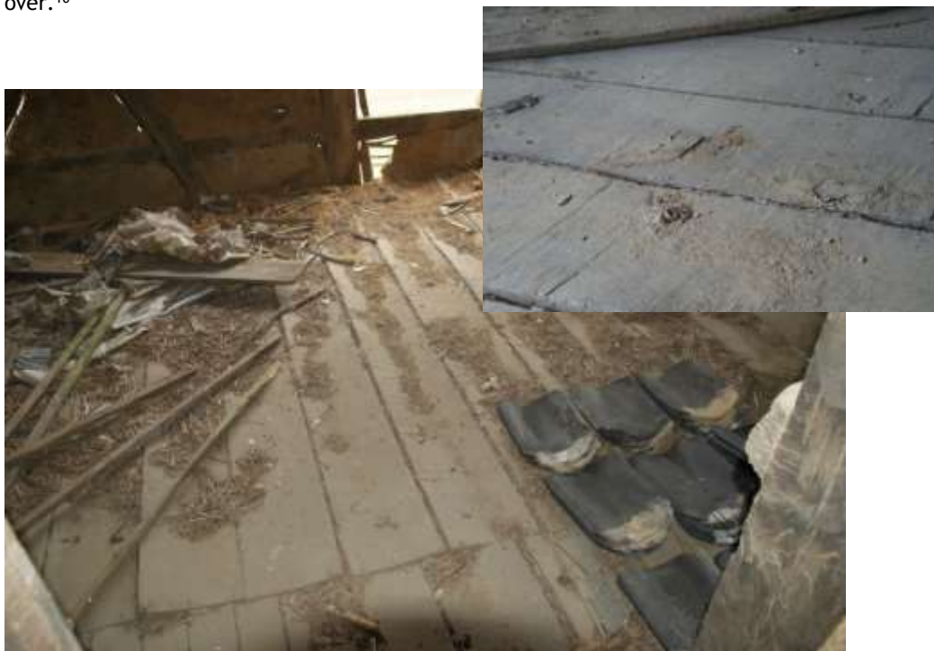
Figuur 25: Vloerplanken van perenhout op de zoldervloer van bouwdeel 3b van het vakwerkwoonhuis. Op de vloerplanken zijn de zaagsporen van de kraanzaag te zien.
