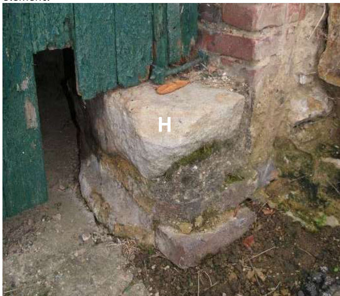
Figuur 77: De taatssteen van de poort van de grote schuur (1a) in steen van Holset (H).
