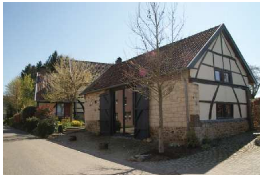
Figuur 53: Vijlense kalksteen in de straatgevel van Vijlenstraat 18 in Vijlen (XVIII). (bron datering: van Agt J.F. 1983 p. 169)
