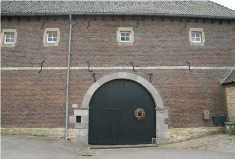
Figuur 89: Akense blauwsteen in de omlijsting van de poort (1623) van hoeve Mamelis, Mamelis 21-23. Links en rechts daarvan in de plint Viilense kalksteen.
