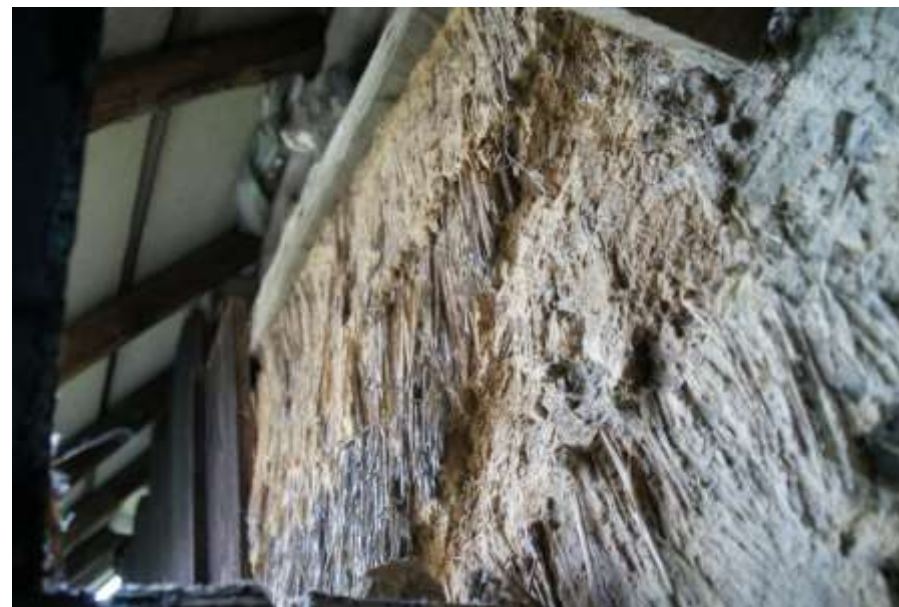
Figuur 105: Met stro afgewerkte vakken. Het stro is in horizontale banen in de leem vastgezet.
