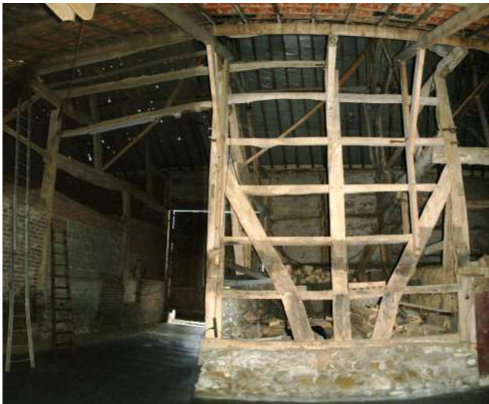
Figuur 40: Eerste en tweede travee van de achtergevel van de grote schuur (1a). De eerste travee (rechts) op een plint van vuursteen keien bij de wisj.
