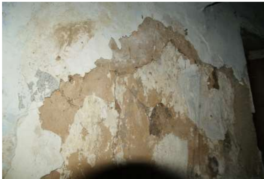
Figuur 102: leem als binnenwandafwerking daaroverheen kalkwitsel en behang
