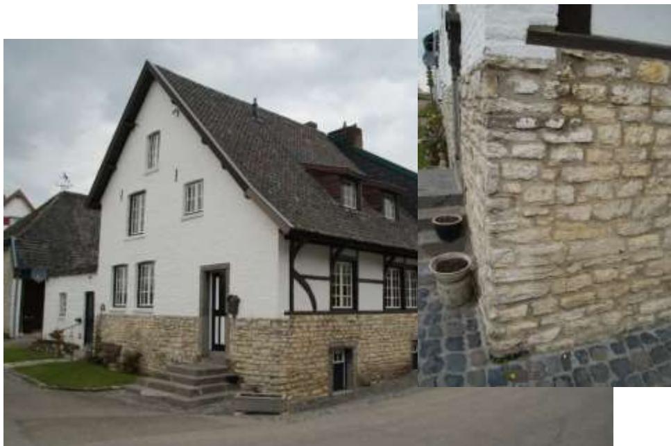
Figuur 59: Vijlense kalksteen in de plint van de Mamelis 35 (1740) bron datering: registerblad Rijksmonumentnummer: 36687;
