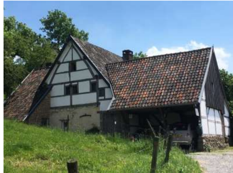
Figuur 57: Vijlense kalksteen op de begane grond onder een dwarsgebint in vakwerk bij B&B de Heerlijkheid Vijlen, Vijlenstraat 49a in Vijlen. Het pand komt al voor op de kadasterkaart van 1829.
