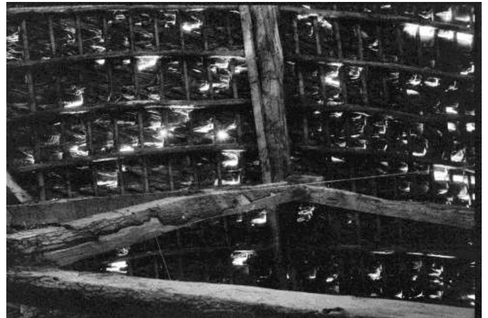
Figuur 110: Stropoppen in de kap van de grote stal (bouwdeel 1a) in 1976. De sporen en panlatten zijn later vernieuwd en daarbij zijn de stropoppen verwijderd (bron beeldbank RCE nr: 180030)
