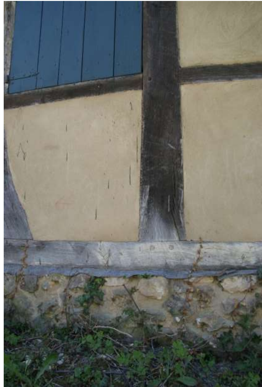
Figuur 46: Vuurstenen in de plint van de stal van hoeve Pannes Vijlenstraat 57 in Vijlen (XVIII) bron datering registerblad Rijksmonumentnr: 36709)
