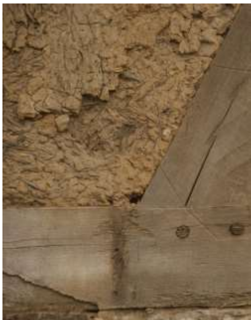
Figuur 99: vakvulling van stroleem in de achtergevel van de uitbreiding van het vakwerkwoonhuis (bouwdeel 3b).
