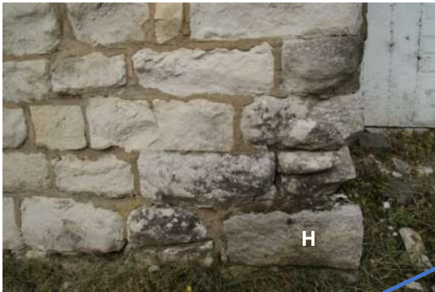
Figuur 80: Steen van Holset (H) rechts beneden in de hoek van de gevel in Vijlense kalksteen van Senserbachwea 218 in Lemiers (D)
