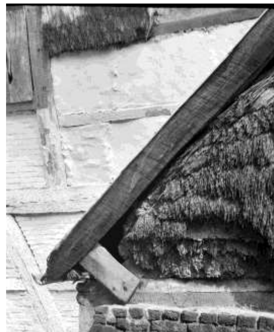
Figuur 105: Met stro afgewerkte vakken. Het stro is in horizontale banen in de leem vastgezet.
