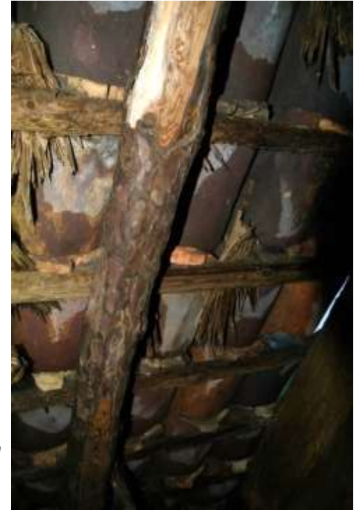
Figuur 30: Sporen en panlatten van grove den in het dak van bouwdeel 3d.
