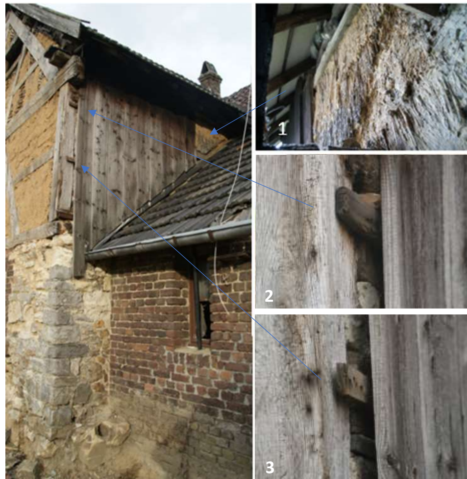
Figuur 89: Linkerzijgevel van bouwdeel 3b. Rechtsboven 1: Leemvulling waarin stro gedrukt is als wandafwerking. 2 en 3: De wandregels van de vakwerkconstructie van de linkerzijgevel zichtbaar achter de lat waarop de gevelbetimmering is vastgezet.
