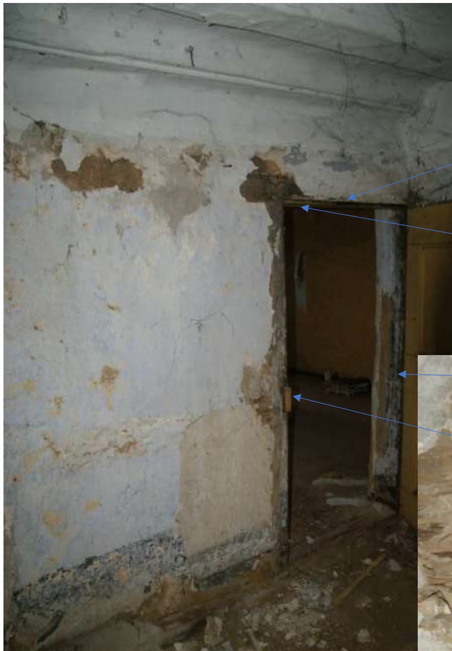
Figuur 48: De 1 e en 2 e wandregel tekenen zich af naast de deur in de wandafwerking in de 2 e travee.
