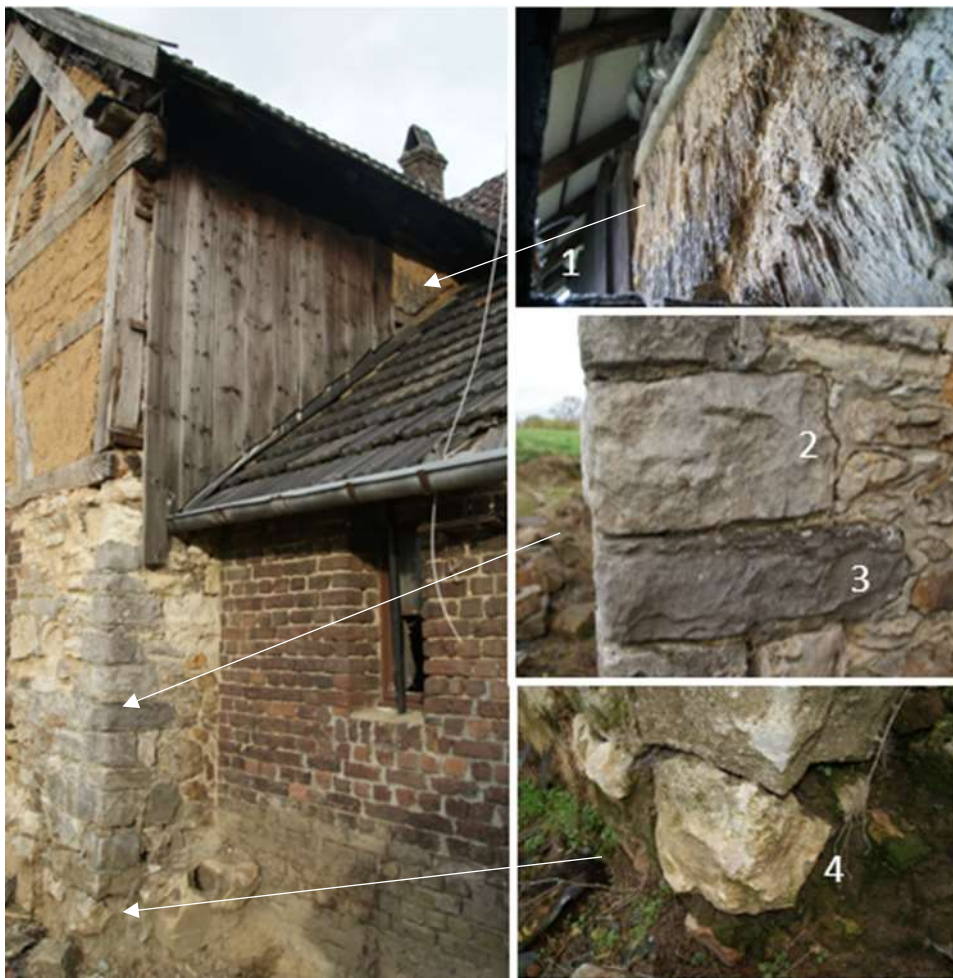
Figuur 22: Figuur 67: Linkerzijgevel van bouwdeel 3b. Rechtsboven 1: Leemvulling waarin stro gedrukt is als wandafwerking. Hoekketting met 2: steen van Holset, 3: Akense Blauwsteen. In de Fundering 4: vuursteen keien
