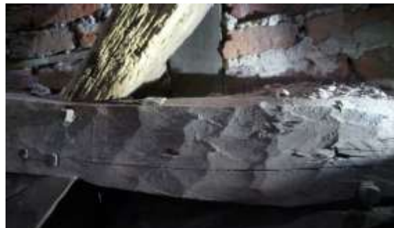
Sporen van bewerking met een bijl op de tussenbalk
