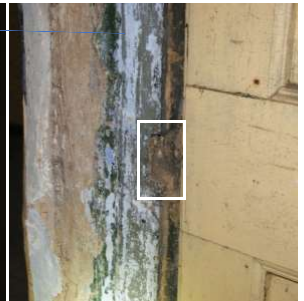
Figuur 52: De keep (wit kader) in de rechter deurstijl (stijl 2 e dwarsgebint) t.h.v. de 1 e wandregel.
