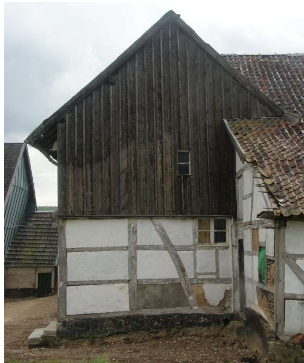
Figuur 81: De rechterzijgevel van bouwdeel 3a met het 4 e dwarsgebint. Tegen de rechter kant is bouwdeel 3d geplaatst.
