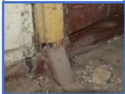
Het bovenste deel van de schoor die aansluit op de hoekstijl van het 4 e dwarsgebint
