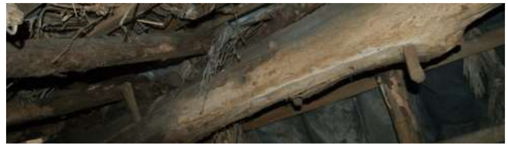
De nokbalk, die bij herplaatsing een kwartslag gedraaid is waardoor de toognagels te zien zijn waarmee ooit sporen op de nokbalk bevestigd waren.
