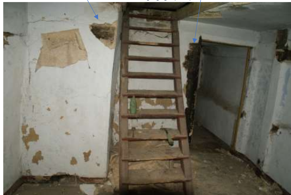
Figuur 76: De wand op de verdieping met daarin het 3 e dwarsgebint gezien vanuit de derde travee. Foto links: de wand gezien vanuit de kamer. Foto rechts de wand gezien vanuit de overloopt. Links naast de laddertrap naar de zolder het rookkanaal
