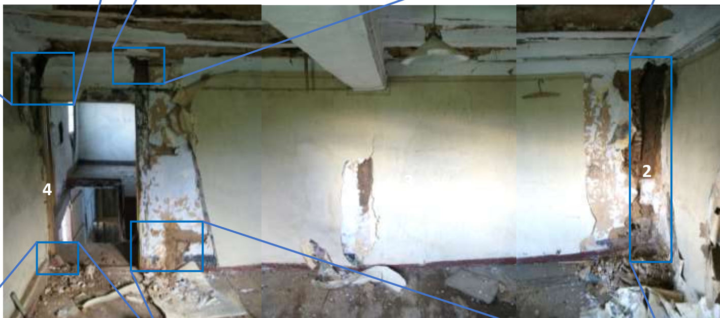
Figuur 58: Aanzicht van de achtergevel van bouwdeel 3a vanaf de ruimte op de verdieping van bouwdeel 3b. Met cijfers zijn de posities van het 2 e , 3 e en 4 e dwarsgebint aangegeven.
