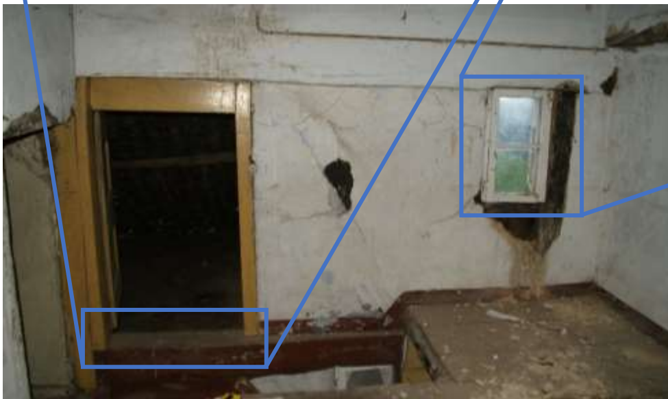
Figuur 85: Op de verdieping tekent zich de vakwerkconstructie van het 4 e dwarsgebint af achter het pleisterwerk.
