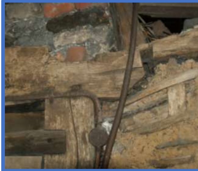
De dekbalk op de hoekstijl is aan de bovenkant ingekeept t.b.v. de oplegging van de jukplaat van de rechterzijgevel van bouwdeel 3b.
