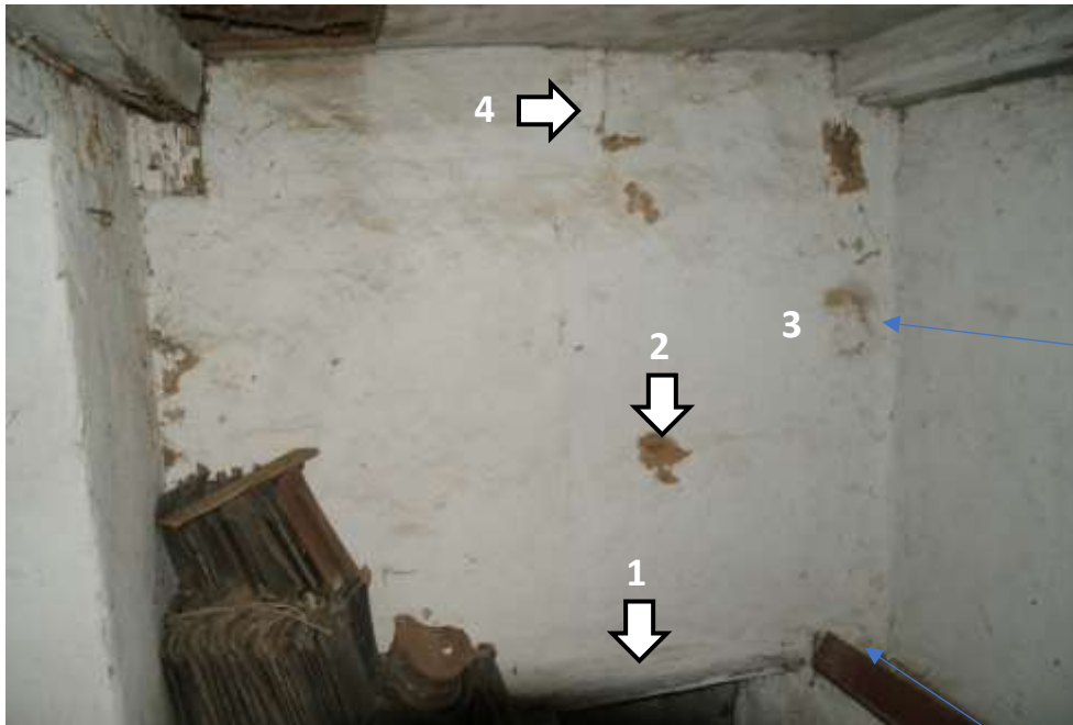
Figuur 53: Zicht op de achtergevel van bouwdeel 3a vanuit bouwdeel 3c. Stijlvoetplaat (1), 1 e wandregel (2), ankerbalkpen (3) en de stijl die op de verdieping te zien is naast het luik (4).
