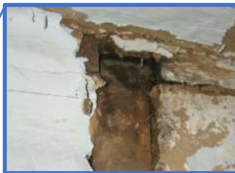
De stijl van de deur in de keep van de jukplaat
