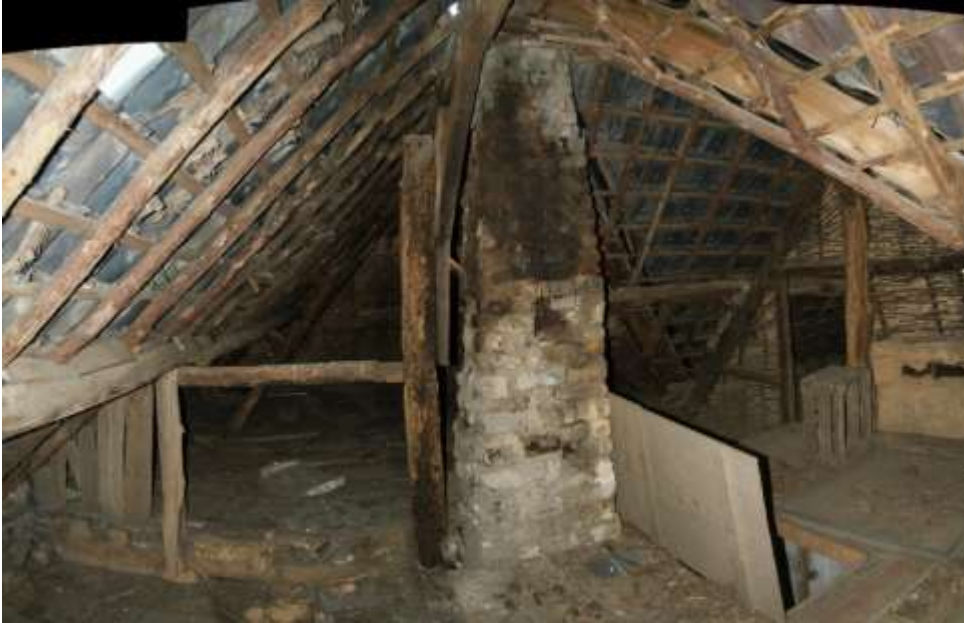
Figuur 77: Gezien vanuit de derde travee, de hergebruikte stijl met daaraan het juk waarop de gording is geplaatst. Tegen de stijl is een tweede stijl met de twee nokbalkschoren is geplaatst. Rechts naast de stijl het rookkanaal
