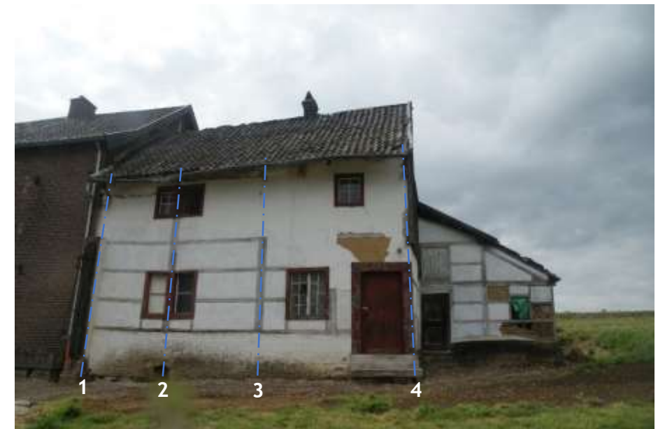
Figuur 15: De voorgevel van het vakwerkhuis (3a) voor het verwijderen van het pleister- en schilderwerk. Met blauwe streep stip lijnen zijn de begrenzingen van de 3 traveeën en met witte cijfers 4 dwarsgebinden aangegeven.
