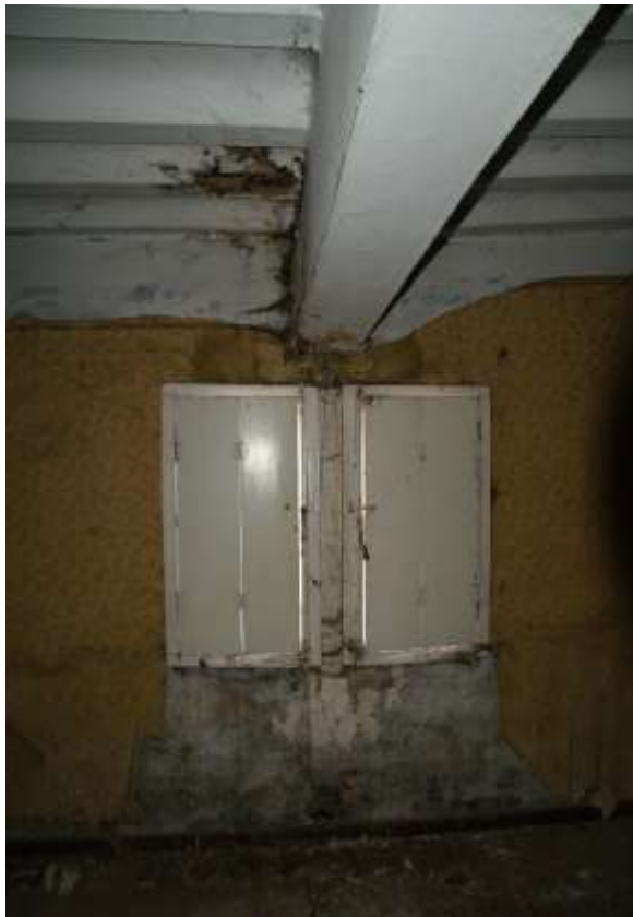
Figuur 68: De ankerbalk en de stijl (tussen de vensters) van het 2 e dwarsgebint op de begane grond in de voorgevel.
