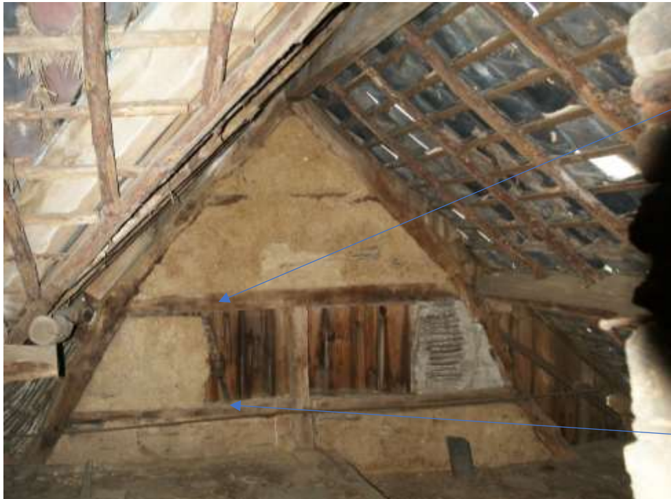
Figuur 86: Het kaspant van het 4 e dwarsgebint. De twee gevelopeningen links en rechts van de middenstijl zijn gedicht door de gevelbetimmering. Ze zijn gemaakt door de vitsen, witsen en stroleem van de oorspronkelijke vulling deels te verwijderen. De sleuf in de onderste wandregel en de gaten in de bovenste wandregel voor de vitsen zijn nog te zien.
