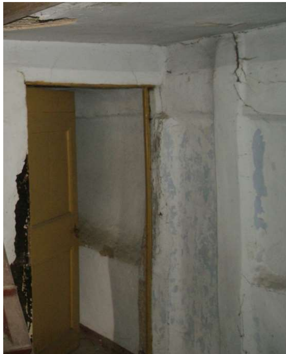
Figuur 57: De stijlen en wandregels en jukplaat van de achtergevel tekenen zich af onder de wandafwerking op de verdieping.
