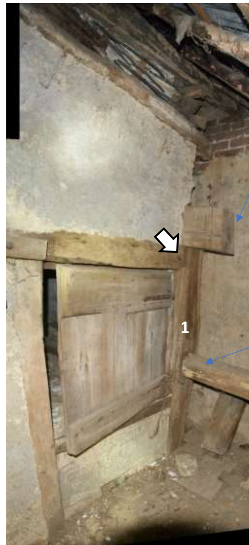
Figuur 60: Aanzicht van de 1 e travee van de achtergevel van bouwdeel 3a vanaf de zolder van bouwdeel 3c. Met cijfers zijn de posities van het 1 e en 2 e dwarsgebint aangegeven. Ook hier is de wandregel, net als in de voorgevel, met een smeedijzeren spijker op de stijl van het 1 e dwarsgebint vastgezet (pijl)
