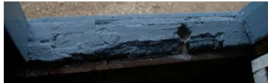
Figuur 38: De luikspinning in de onderregel, de vierkant gaten voor de diefijzers en het pengat met daarin nog de pen van de stijl van een kleiner venster op de verdieping naast de stijl van het 2 e dwarsgebind.
