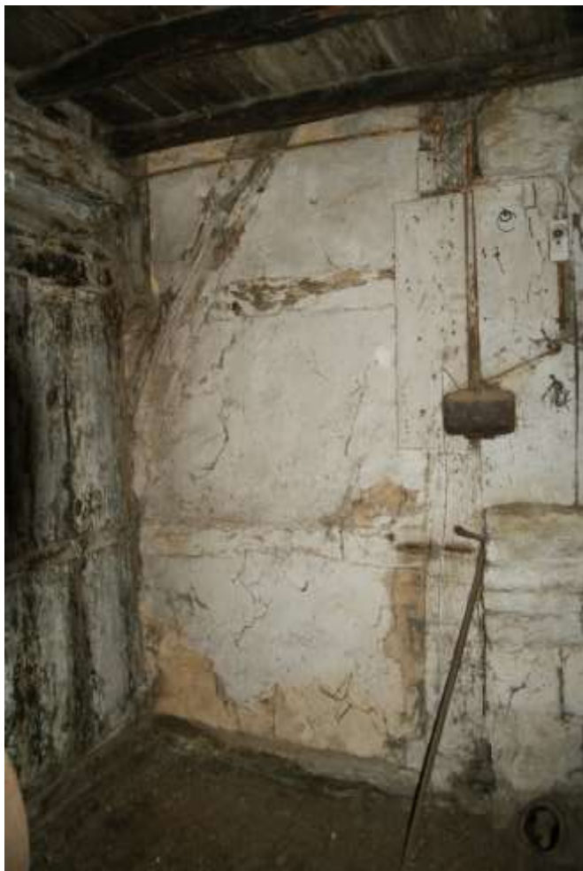
Figuur 83: Het deel van de rechtergevel dat zichtbaar is vanaf de begane grond van bouwdeel 3d.
