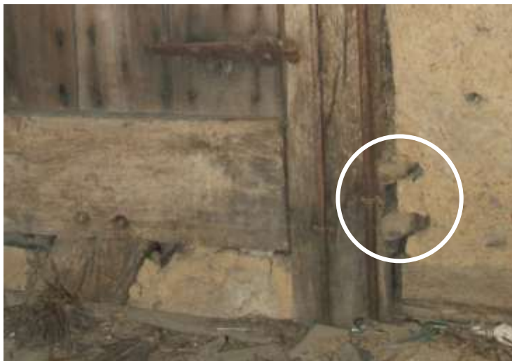
Figuur 56: De sleutels van de ankerbalk van het 4 e dwarsgebint. Gezien vanaf de zolder van bouwdeel 3d.
