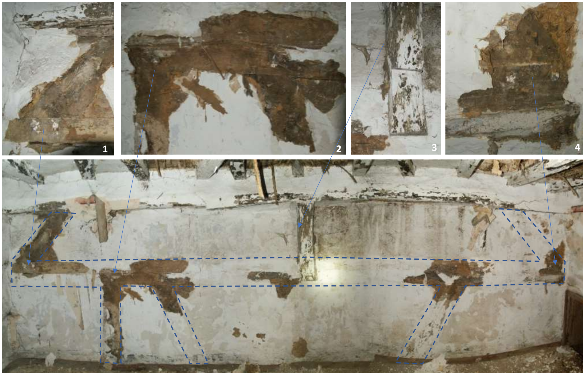
Figuur 64: Uit 6 foto's samengesteld overzicht van de wand op de verdieping met daarin de constructie van het 1 e dwarsgebint (blauwe stippellijn). Boven deze overzichtsfoto details van de verbindingen. 1. Het spantbeen links op de debalk, 2. de stijlen en de schoor onder de debalk, 3. De later toegevoegde stijl waarop de moerbalk van de vloer steunt en 4 het spantbeen rechts op de debalk. Na het verhogen van de vloer is waarschijnlijk ook de constructie boven de debalk voorzien van een vulling met stroleem op vitsen en witsen. In het kapspant op zolder is namelijk te zien dat daarin nooit een vulling gezeten heeft.
