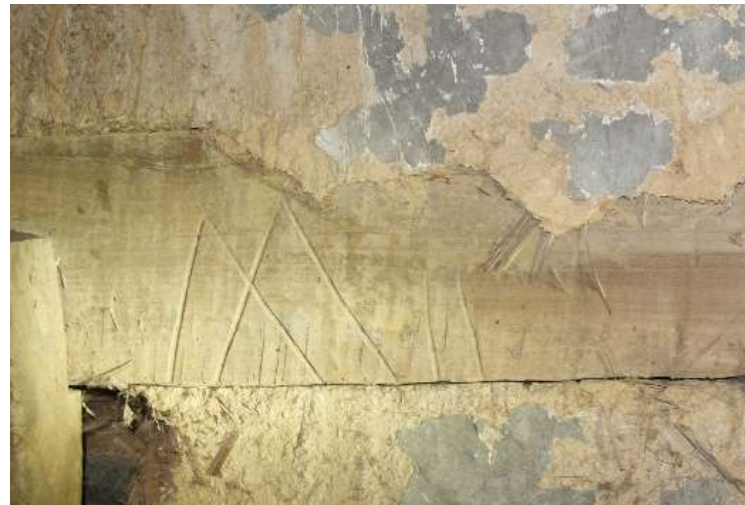
Figuur 110: Telmerk rechterzijgevel
