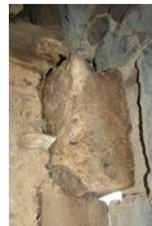
Dekbalk van het dwarsgebint van de achtergevel
