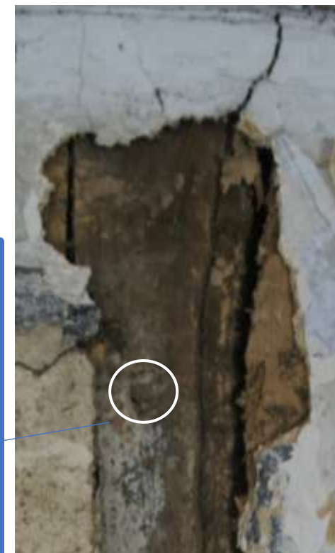
De aansluiting van de bovendorpel van de venster- of luikopening op de stijl van het venster. In de cirkel de toognagel.
