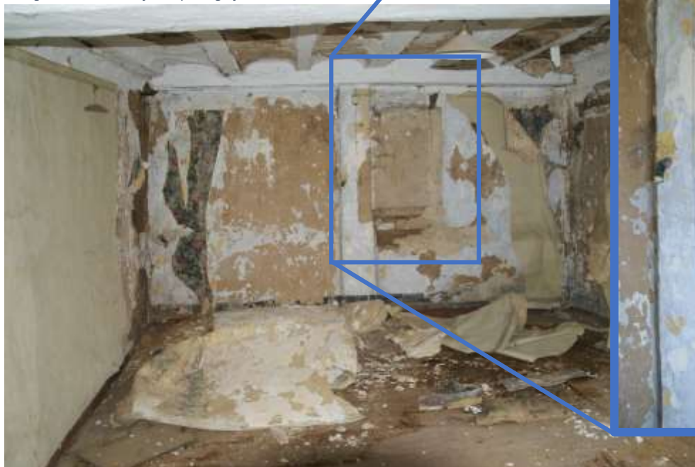
Figuur 92: Onder: De linkzijdige van bouwdeel 3b gezien vanuit de kamer op de verdieping. Na het weghalen van het behang tekent zich achter het pleisterwerk, rechts naast de middenstijl een dichtgezette venster- of luikopening af.
