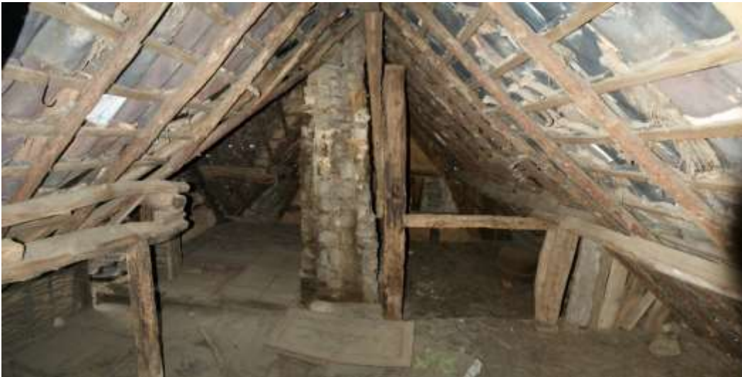
Figuur 78: Idem, gezien vanuit de tweede travee.
