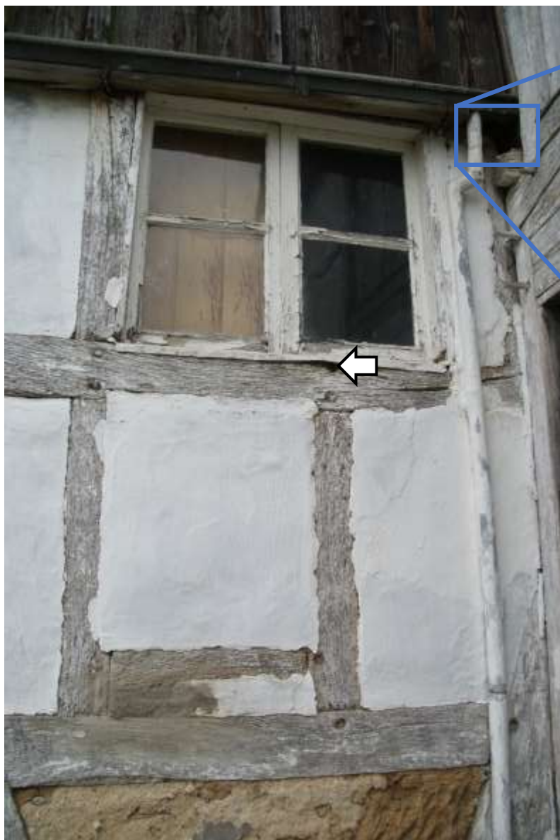
Figuur 82: Onder het venster een met stroleem gedichte luikopening. Ter plaatse van het venster zat, in het verlengde van de luikopening eronder, een kleinere voorganger van dit venster. Het toognagelgat van de middenstijl is zichtbaar (zie pijl). Rechts van de hemelwaterafvoer is nog een stijl zichtbaar. Die is aan de bovenkant met een smeedijzeren spijker in de ankerbalk bevestigd en dus later toegevoegd.
