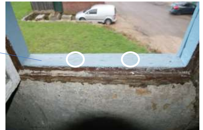
Figuur 41: Vierkante gaten voor diefijzers in de planken in de dagkanten van de boven- en onderregel van het vensters op de verdieping in de derde travee.
