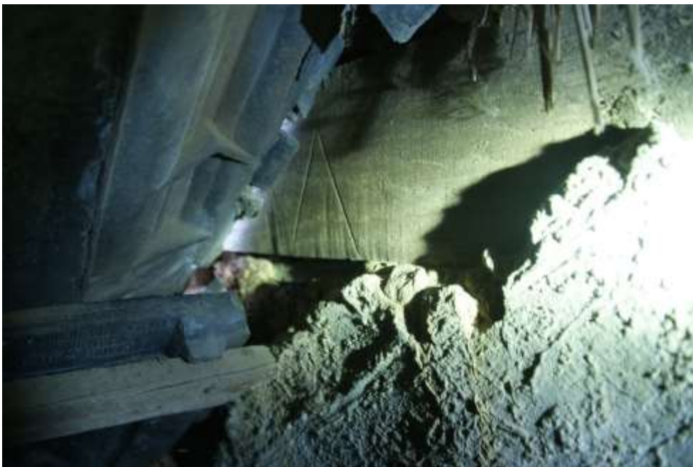
Figuur 90: Links : Het enige zichtbare telmerk op een wandregel van de vakwerkconstructie van de linkerzijgevel van bouwdeel 3b.
