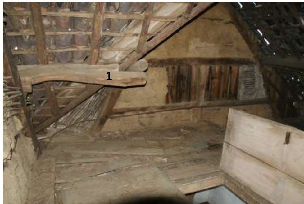
Figuur 107: De gording van bouwdeel 3b (1) die langs het 2 e dwarsgebint doorsteekt waarop de doorgezaagde gording van het achterdakvlak van bouwdeel 3a is geplaatst.
