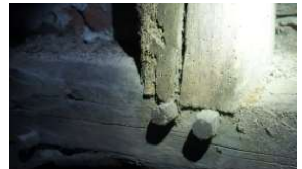
De aansluiting van de nokstijl op de dekbalk van het kaspant met bijgesneden toognagels.
