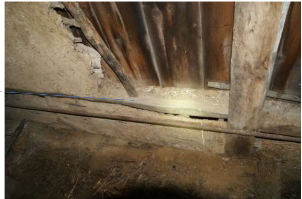
Figuur 86: Het kaspant van het 4 e dwarsgebint. De twee gevelopeningen links en rechts van de middenstijl zijn gedicht door de gevelbetimmering. Ze zijn gemaakt door de vitsen, witsen en stroleem van de oorspronkelijke vulling deels te verwijderen. De sleuf in de onderste wandregel en de gaten in de bovenste wandregel voor de vitsen zijn nog te zien.
