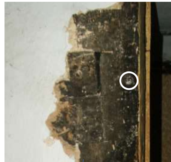
De stijl van de deur met daarin een keep waarin de afgezaagde dekbalk met smeedijzeren spijkers bevestigd is en rechts daarvan het toognagelgat (cirkel).
