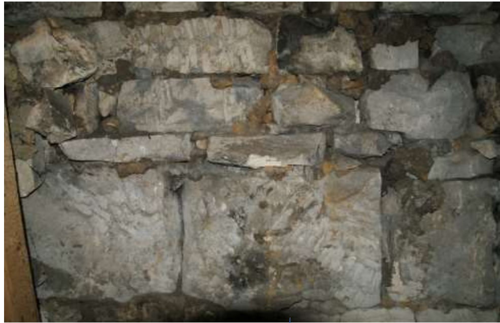
De achterwand van de haardplaats. De Vijlense kalksteen is met leemspecie gemetseld
