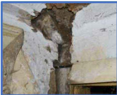
Uitkragende dekbalk en hoekstijl van het 4 e dwarsgebint
