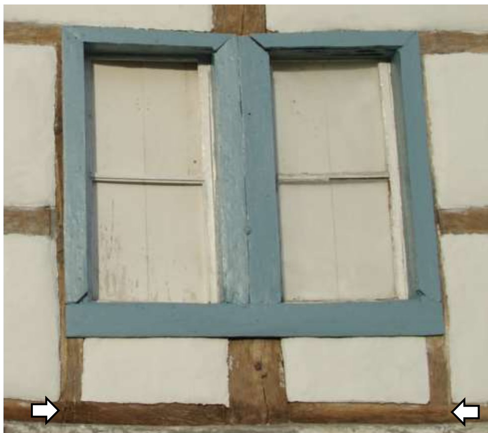
Figuur 34: Toognagels van de pen-en-gatverbinding van de stijlen van het venster met de 1 e wandregel op de begane grond bij het 2 e dwarsgebint
