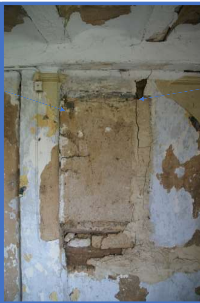
De aansluiting van de bovendorpel van de venster- of luikopening op de stijl van het venster. In de cirkel de toognagel.
