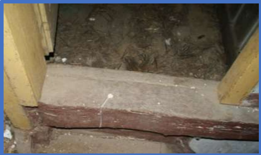
De sleuf voor de vitsen in de ankerbalk van het 4 e dwarsgebint ter plaatse van de secundaire luikopening.
