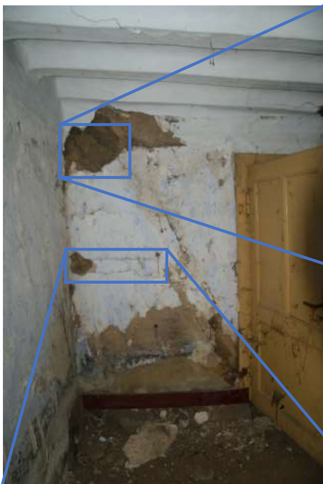
Figuur 45: Links: De schoor en wandregels van de 3 e travee tekenen zich af in de wandafwerking.
