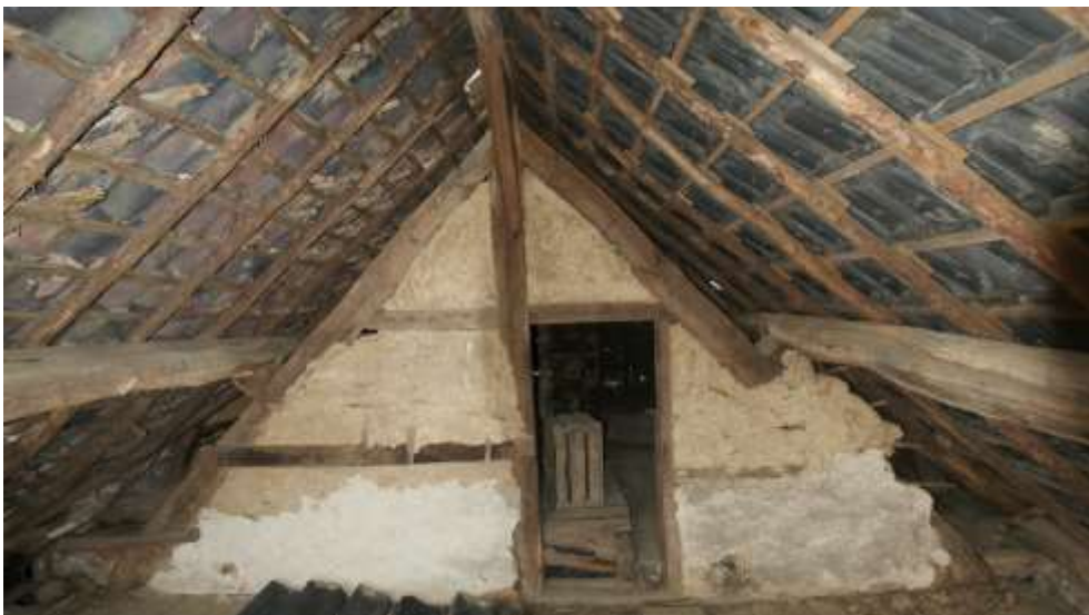
Figuur 23: Het 2e dwarsgebint van bouwdeel 3b op de achtergevel van bouwdeel 3a.
