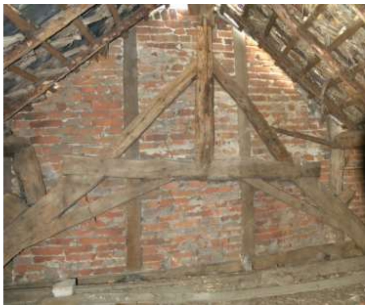
Figuur 18: Het kapgebint van het eerste dwarsgebint van bouwdeel 3a. Een restant van een voorganger
