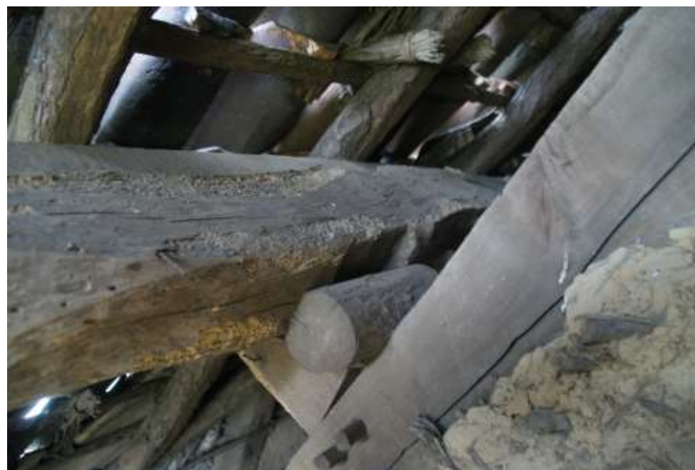
Figuur 103: De gording, met daarin de keep voor plaatsing op het spantbeen voordat de gording hoger geplaatst werd.
