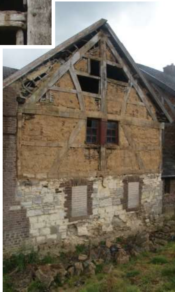
Figuur 96: De achtergevel van bouwdeel 3b. Links: voordat de bekleding met pannen werd verwijderd. Midden: Nadat de pannen werden verwijderd.
