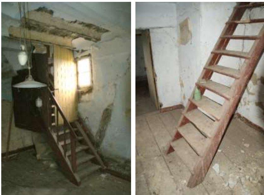
Figuur 26: Links: De trap van de begane grond naar de eerste verdieping. Rechts: de laddertrap naar de zolder. Op de achtergrond het rookkanaal van de schouw.
