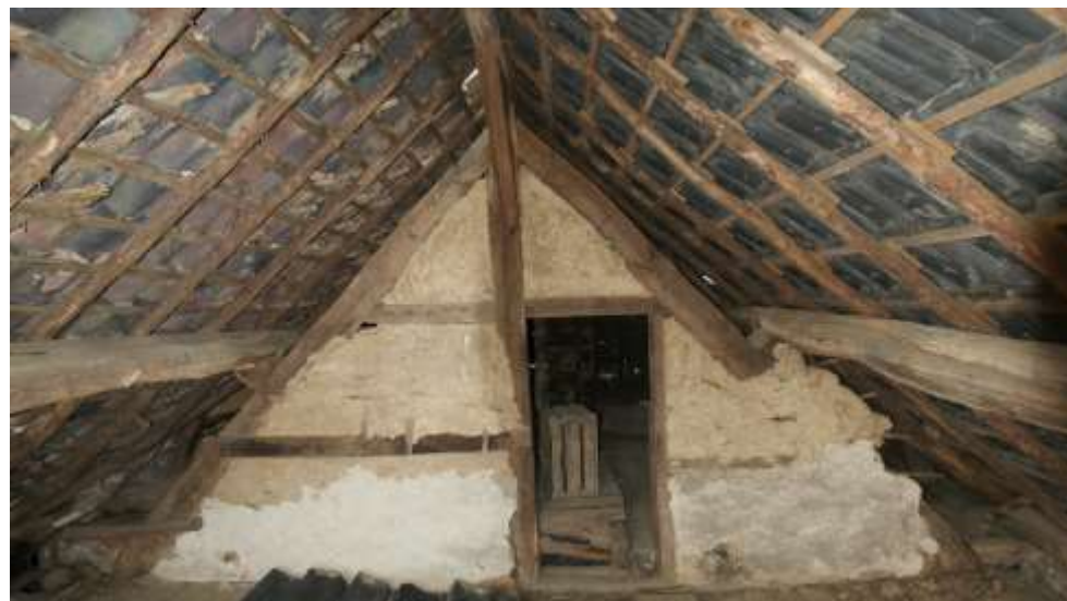
Figuur 102: Het 2e dwarsgebint van bouwdeel 3b op de achtergevel van bouwdeel 3a.
