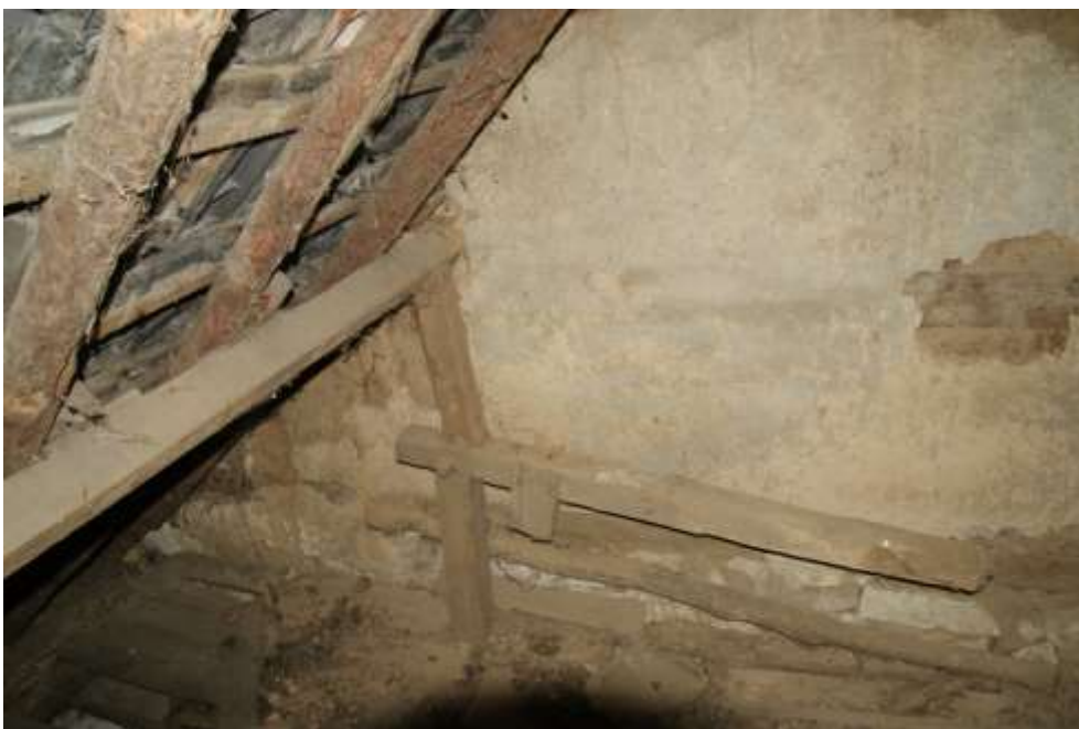
Figuur 91: Links : De linkerzijgevel van bouwdeel 3b gezien vanuit de zolder van bouwdeel 3c. Het pleisterwerk van stroleem is over de wandregels doorgezet.
