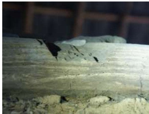
Een van de kepen voor een spoor in de oorspronkelijke gebintplaat
