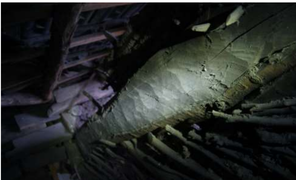
Figuur 106: Sporen van bewerking met een bijl of dissel op een van de spantbenen van het 2 e dwarsgebint van bouwdeel 3b. Ook is de schors van wilde kers herkenbaar.
