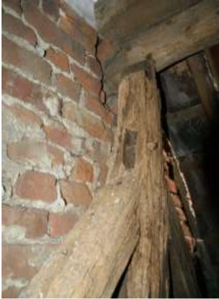
De nokbalk geplaatst op de pen van de nokstijl en de aansluiting van de nokstijlschoren met daarboven de pengaten met toognagels van een oudere verbinding.
