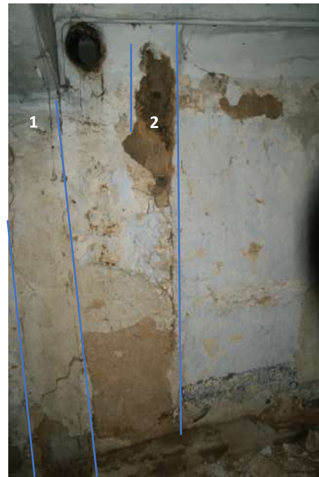
Figuur 47: De toegevoegde stijl die de moerbalk van de verdiepingsvloer van bouwdeel 3b draagt (1) en de stijl van het 3 e dwarsgebint (2) tekenen zich af in de wandafwerking.
