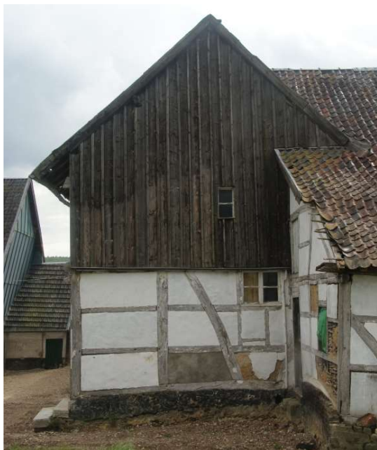
Figuur 16: De rechterzijgevel van bouwdeel 3a.
