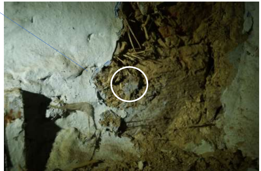
Figuur 55: Detail van de stijlvoetplaat onder de stijl van het 1 e dwarsgebint. Van de onderlinge verbinding met pen-en-gat is de toognagel te zien (witte cirkel)
