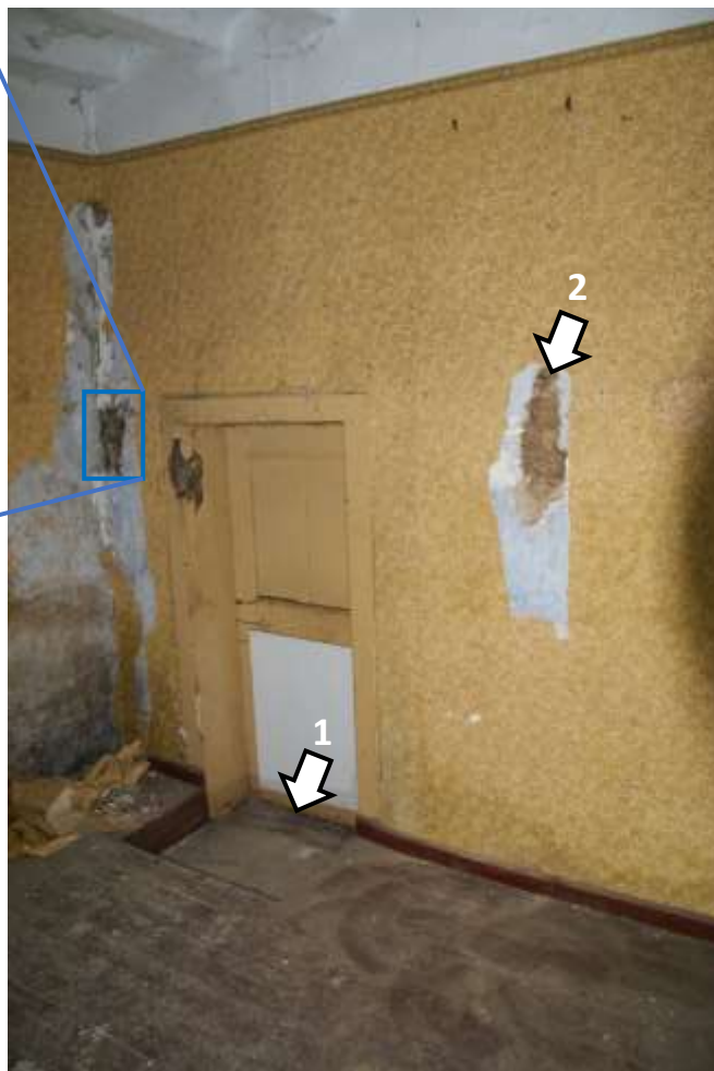
Figuur 63: Op de begane grond is op een aantal plaatsen de constructie van het 1 e dwarsgebint vrijgelegd door de wandafwerking te verwijderen. In de doorgang naar bouwdeel 2a is waarschijnlijk de stijlvoetplaat (1) te zien. De ankerbalk, met daaronder metselwerk van Vijlense kalksteen is rechts naast die doorgang aangetroffen (2).
