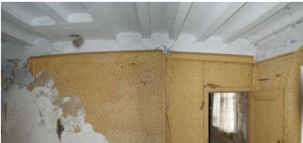
Figuur 19: Ankerbalk van het 3e dwarsgebint met de kinderbinten van de 1e verdiepingvloer
