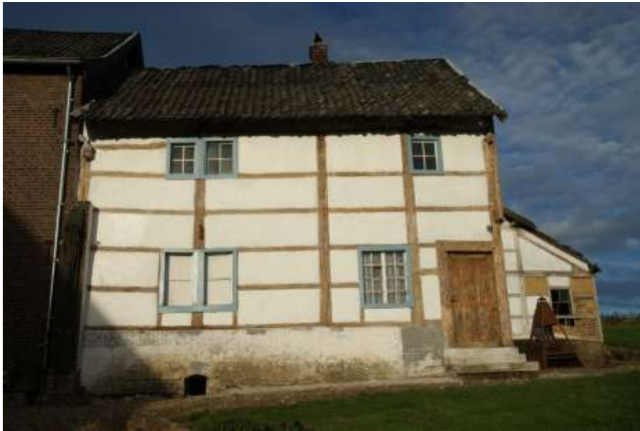
Figuur 30: De voorgevel van het vakwerkhuis (3a) voor en na het verwijderen van het pleister- en schilderwerk.
