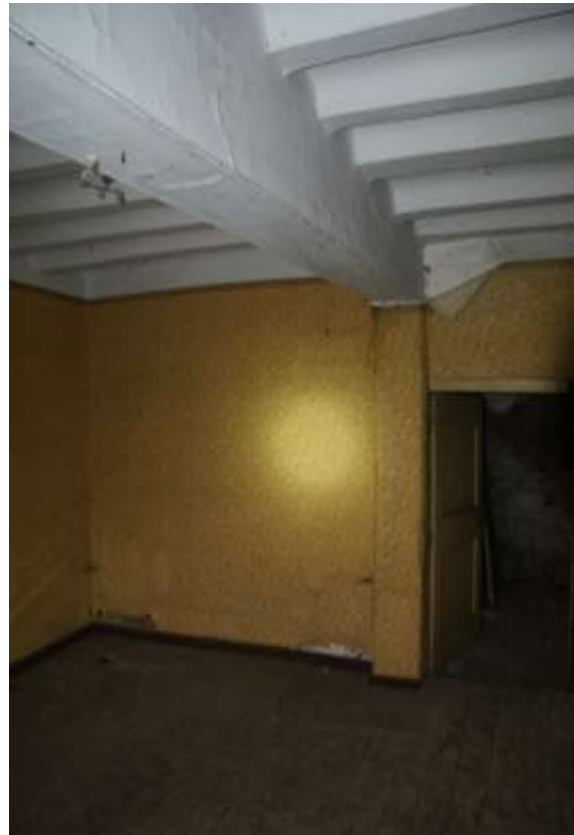
Figuur 69: De ankerbalk en de stijl van het 2 e dwarsgebint op de begane grond in de achtergevel.
