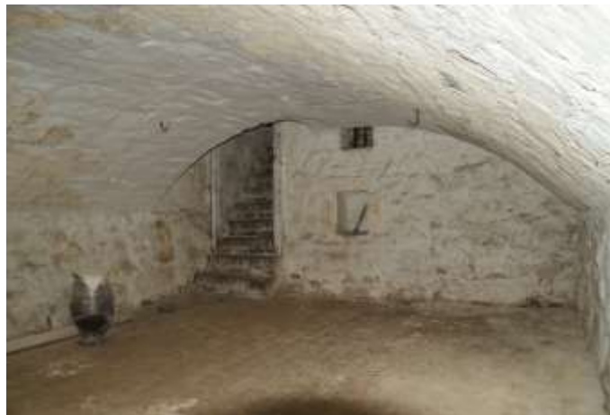
Figuur 17: De kelder van bouwdeel 3a.
