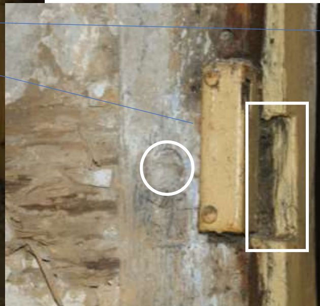
Figuur 51: De keep (wit kader) in de linker deurstijl naast de 1 e wandregel. En de toognagel van de wandregel (witte cirkel)
