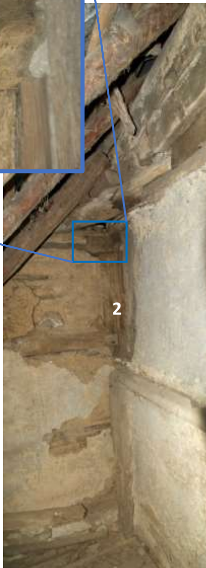
Figuur 60: Aanzicht van de 1 e travee van de achtergevel van bouwdeel 3a vanaf de zolder van bouwdeel 3c. Met cijfers zijn de posities van het 1 e en 2 e dwarsgebint aangegeven. Ook hier is de wandregel, net als in de voorgevel, met een smeedijzeren spijker op de stijl van het 1 e dwarsgebint vastgezet (pijl)
