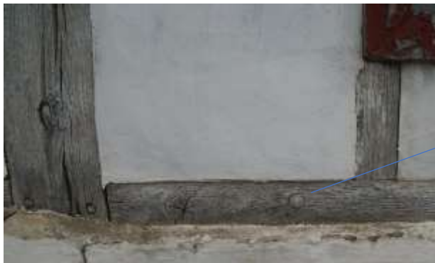
Figuur 40: Het gat (met houten plug) in de 1 e wandregel van de 3 e travee. De functie is onbekend.
