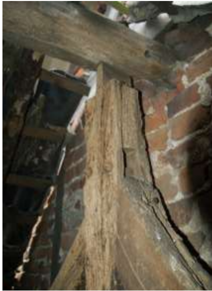
De nokbalk geplaatst op de pen van de nokstijl en de aansluiting van de nokstijlschoren met daarboven de pengaten met toognagels van een oudere verbinding.
