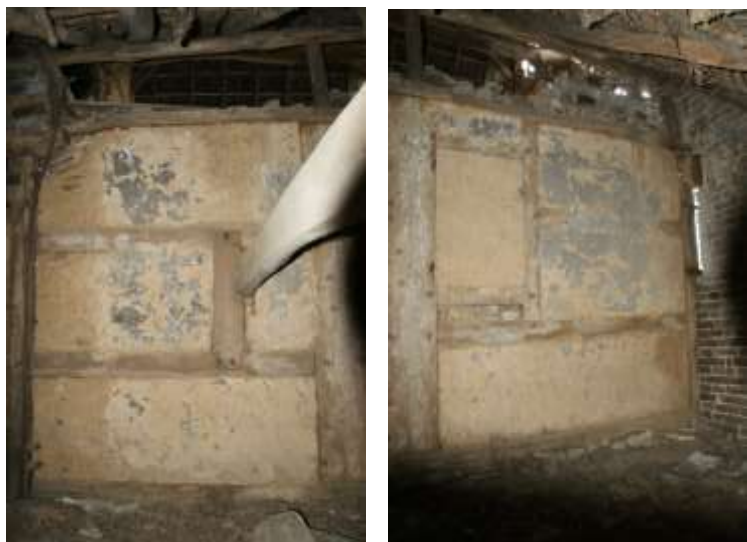
Figuur 20: De rechterzijgevel van bouwdeel 3b gezien vanaf de zolder van bouwdeel 3d. Met op de rechter foto de dichtgezette luikopening
