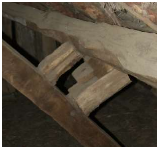
Figuur 72: Het kapsant van het 2 e dwarsgebint dat enkel bestaat uit twee spantbenen met daarop een nok (witte pijlen) ter ondersteuning van de gording
