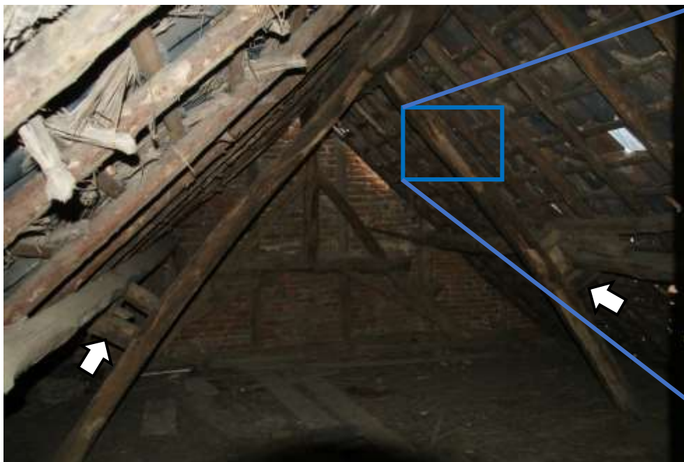
Figuur 72: Het kapsant van het 2 e dwarsgebint dat enkel bestaat uit twee spantbenen met daarop een nok (witte pijlen) ter ondersteuning van de gording
