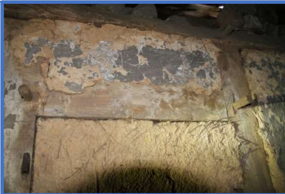
Detail van de dichtgezette luikopening, herkenbaar aan de spinningen, in de rechterzijgevel van bouwdeel 3b. Links de duim van het geheng voor het luik. Rechts op de regel een telmerk en paringstekens.
