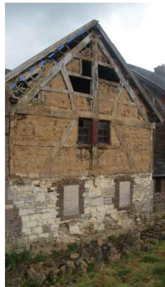
Figuur 15: De achtergevel van bouwdeel 3b. Midden: voordat de bekleding met pannen werd verwijderd. Rechts: Nadat de pannen werden verwijderd.
