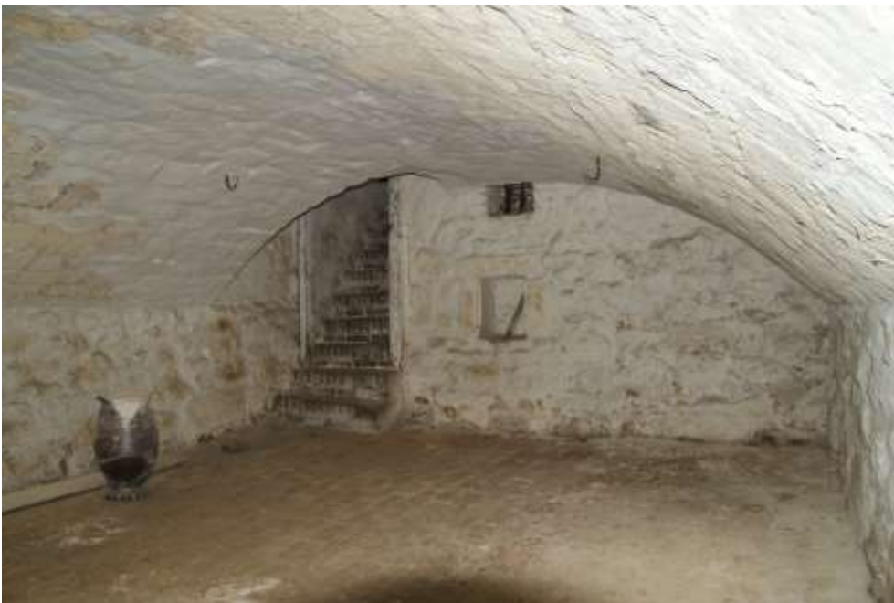
Figuur 24: De kelder van bouwdeel 3a.
