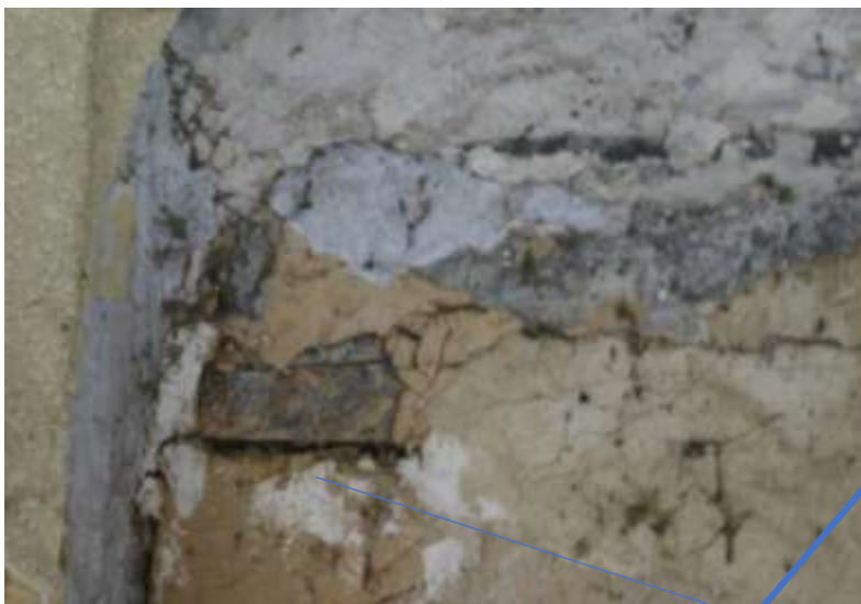
Figuur 92: Onder: De linkzijdige van bouwdeel 3b gezien vanuit de kamer op de verdieping. Na het weghalen van het behang tekent zich achter het pleisterwerk, rechts naast de middenstijl een dichtgezette venster- of luikopening af.
