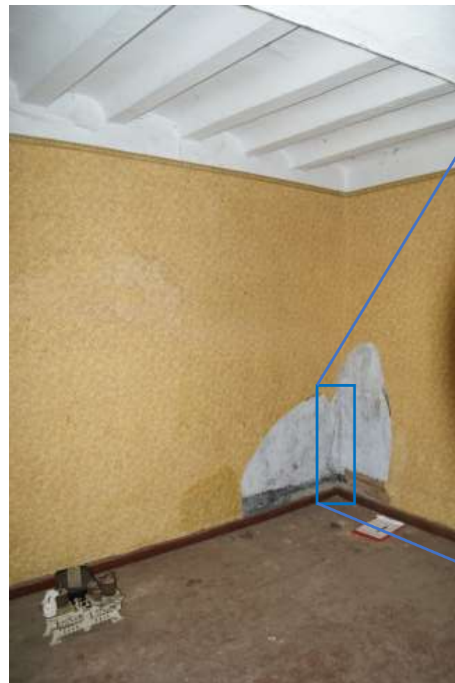
Figuur 63: Op de begane grond is op een aantal plaatsen de constructie van het 1 e dwarsgebint vrijgelegd door de wandafwerking te verwijderen. In de doorgang naar bouwdeel 2a is waarschijnlijk de stijlvoetplaat (1) te zien. De ankerbalk, met daaronder metselwerk van Vijlense kalksteen is rechts naast die doorgang aangetroffen (2).
