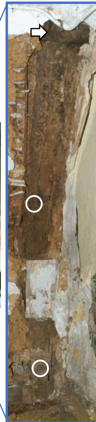
Uitkragende dekbalk (pijl) van het 2 e dwarsgebint. In de witte cirkels de toognagels van de verbinding van de stijl met de wandregels
