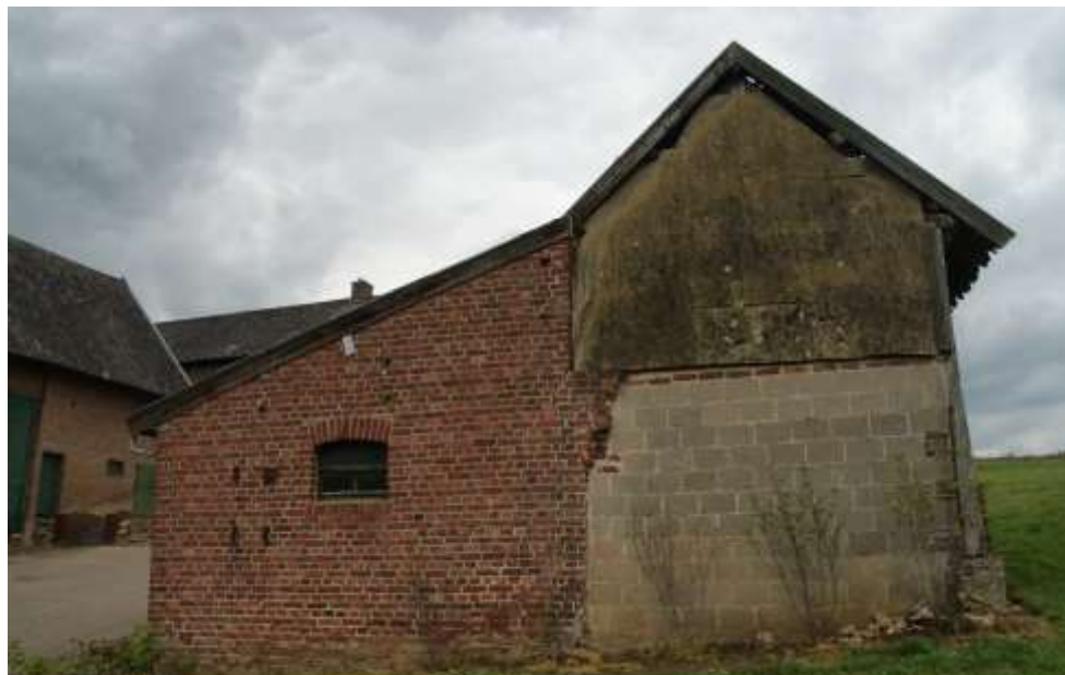
Figuur 182: Achtergevel bouwdeel 4b (links) en bouwdeel 4a rechts.
