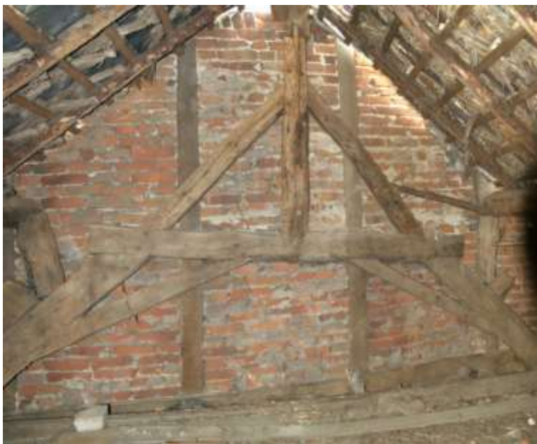
Figuur 13: Het kapspant van het overgebleven dwarsgebint van het oude woonhuis. Op de achtergrond de vakwerkgevel van bouwdeel 2a (1842) waarvan de vakken gevuld zijn met veldbrandsteen.
