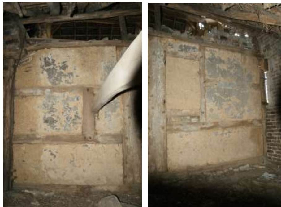
Figuur 146: De linkerzijgevel van bouwdeel 3b in vakwerk gezien vanaf de zolder van bouwdeel 3d.
