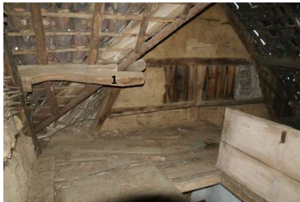
Figuur 148: De gording (1) van bouwdeel 3b steekt door langs het tweede gebint. Daarop is de afgezaagde gording van bouwdeel 3a en de kilkeper geplaatst.
