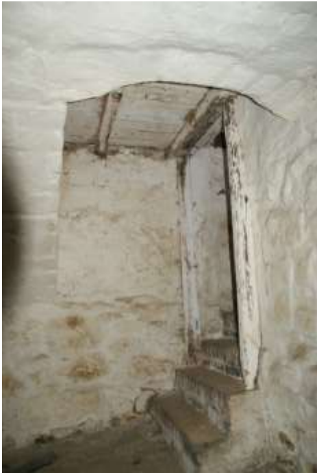
Figuur 15: De sparing in het tongewelf van de kelder afgedekt met kinderbinten en vloerplanken van de begane grondvloer. Mogelijk was dit de positie van de oorspronkelijke keldertoeegang voordat de huidige toegang vanuit bouwdeel 3c gemaakt werd die ook op de foto te zien is.
