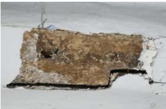
Figuur 20: De stijl links van de achterwand van de schouw. Boven een groot pengat voor de schoor van de rookvang. Links daaronder een pengat voor een wandregel van de wand tussen de gang en de keuken.
