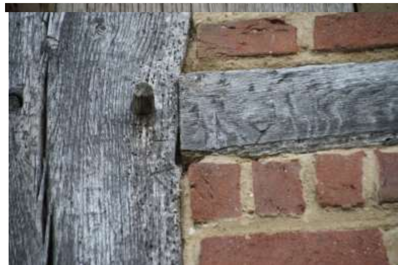
Figuur 87: Voorbeeld van een gehakt telmerk in de voorgevel
