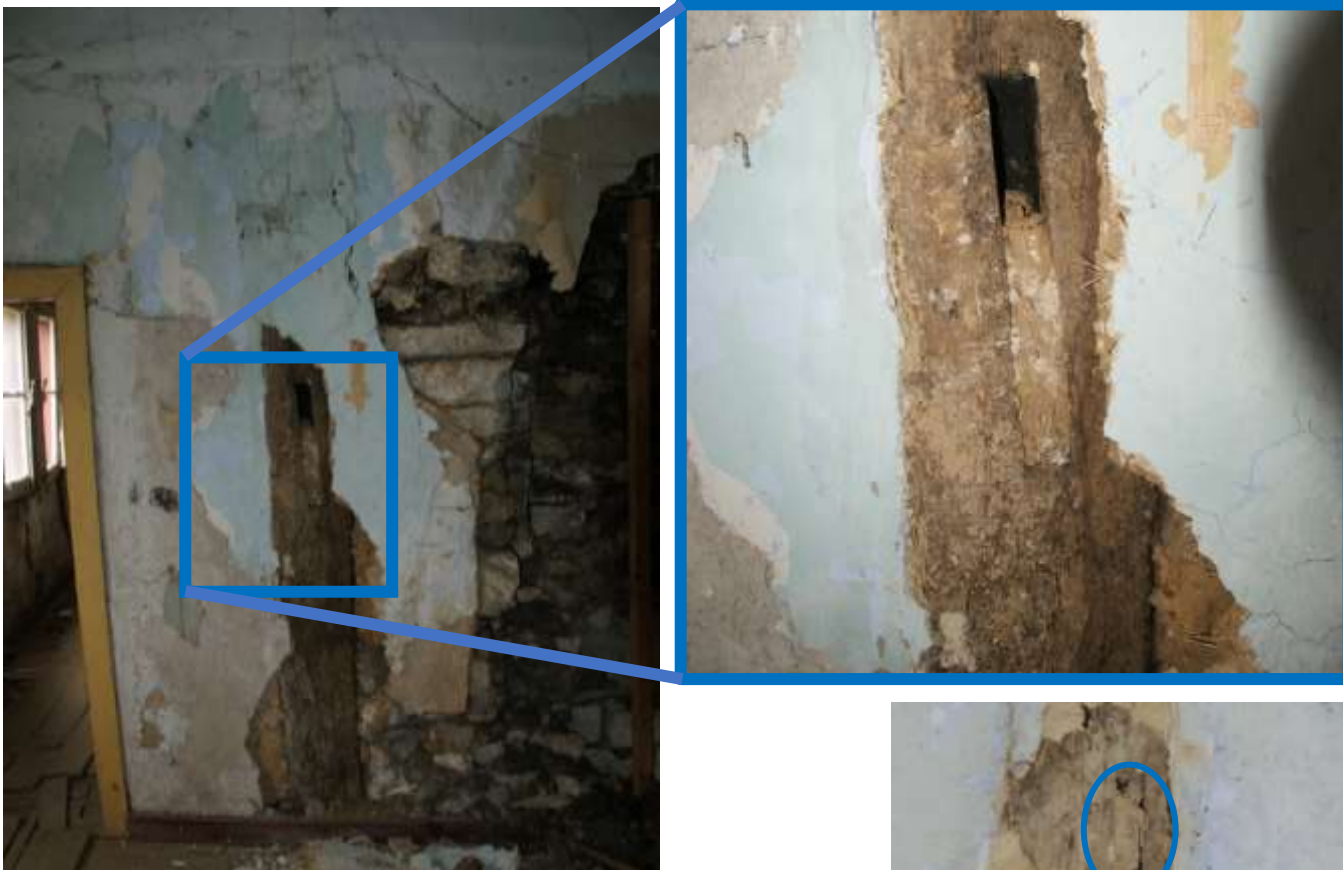
Figuur 20: De stijl links van de achterwand van de schouw. Boven een groot pengat voor de schoor van de rookvang. Links daaronder een pengat voor een wandregel van de wand tussen de gang en de keuken.
