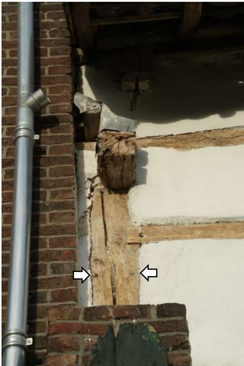
Figuur 122: De stijl van het eerste dwarsgebint. Boven de uitstekende dekbalk het verhoogde deel. Op de stijl de met een smeedijzeren nagel vastgezette wandregel. Daaronder zowel links en rechts toognagelgaten van verwijderde wandregels (zie pijl).
