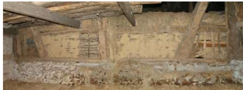
Figuur 58: De plint van vuursteen van de linkerzijgevel met daarboven het dwarsgebint gezien vanaf de binnenzijde.
