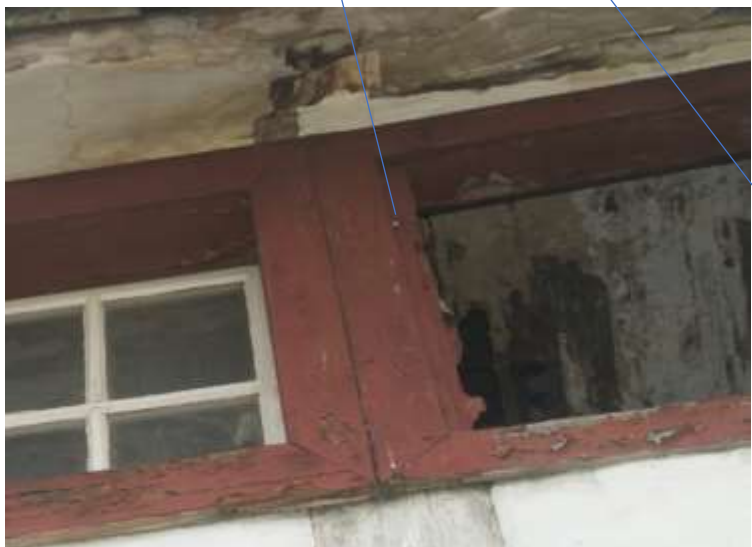
Figuur 17: Luikspinning van een voormalige kleinere luikopening
