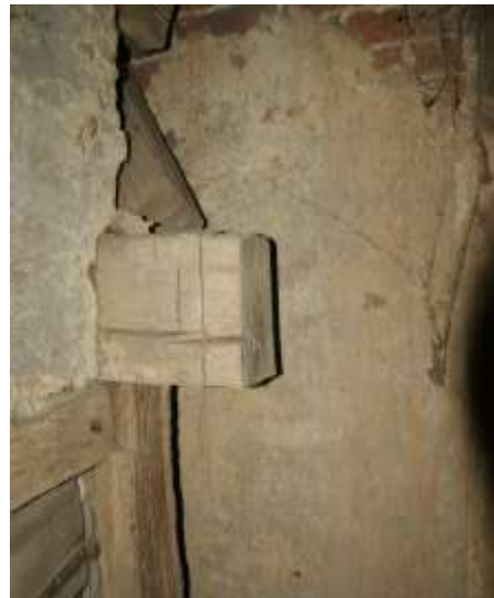
Figuur 133: De uitstekende dekbalk van het eerste dwarsgebint in de achtergevel. Daaronder is de wandregel met een smeedijzeren nagel bevestigd. Op de foto rechts is de stroleemvulling in de vakken zichtbaar naast het luik.
