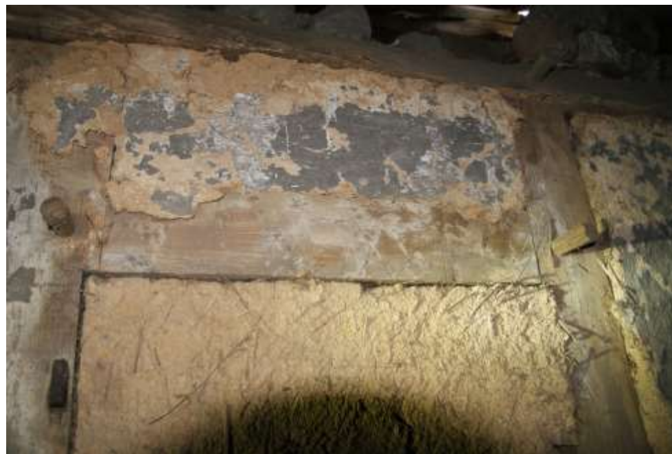
Figuur 35: Detail van de dichtgezette luikopening, herkenbaar aan de sponningen, in de rechterzijgevel van bouwdeel 3b. Links de duim van het geheng voor het luik. Rechts op de regel een telmerk en paringstekens.
