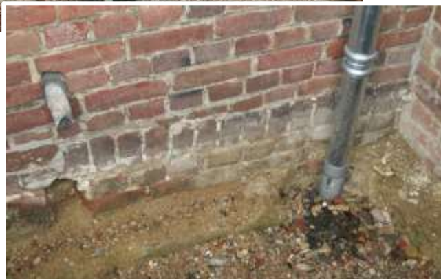
Figuur 60: De achtergevel van de afsluit bij de derde travee van de grote schuur (1a). Links boven de stalpoort is de kopse kant van de dekbalk te zien. Rechts onder (inzet) de koppenlaag in veldbrand waarop de voetstijlplaat van de vakwerkconstructie van de voorganger van deze gemetselde gevel geplaatst was.
