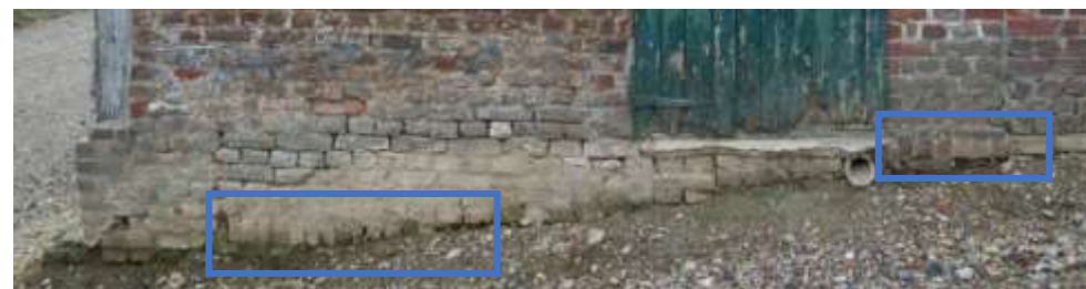
Figuur 82: De rollagen in de plint van de voorgevel van bouwdeel 1b.
