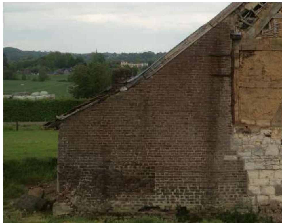
Figuur 158: De achtergevel van bouwdeel 3d.
