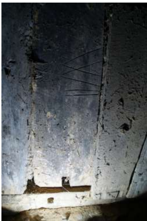
Figuur 77: De verschillende telmerken en paringstekens van de constructie van bouwdeel 1a.
