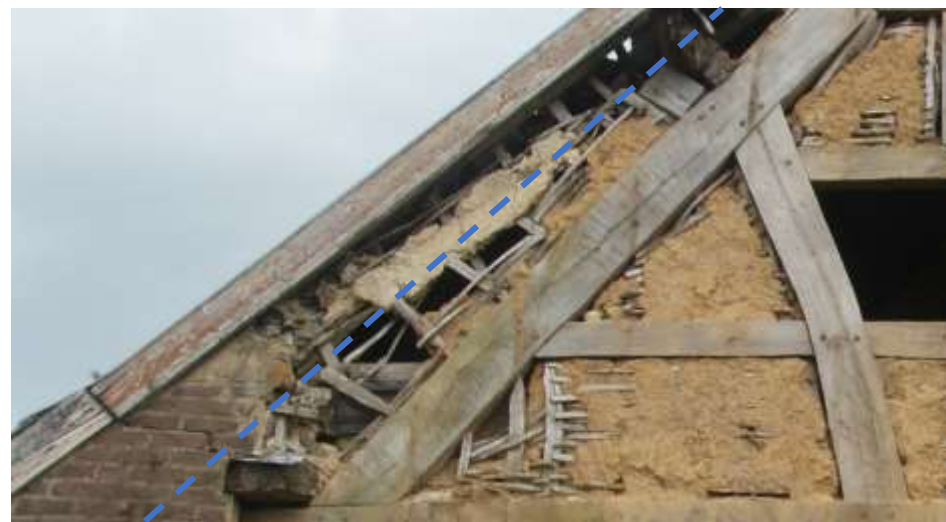
Figuur 144: Dat het dak later verhoogd is, is te herkennen aan de korte vitsen op de nokstijlschoor. De ruimte die bij de ophoging vrijkwam boven deze vitsen is opgevuld door er langere vitsen achter te plaatsen, hier witsen in te vlechten en het geheel opnieuw te vullen met stroleem.
