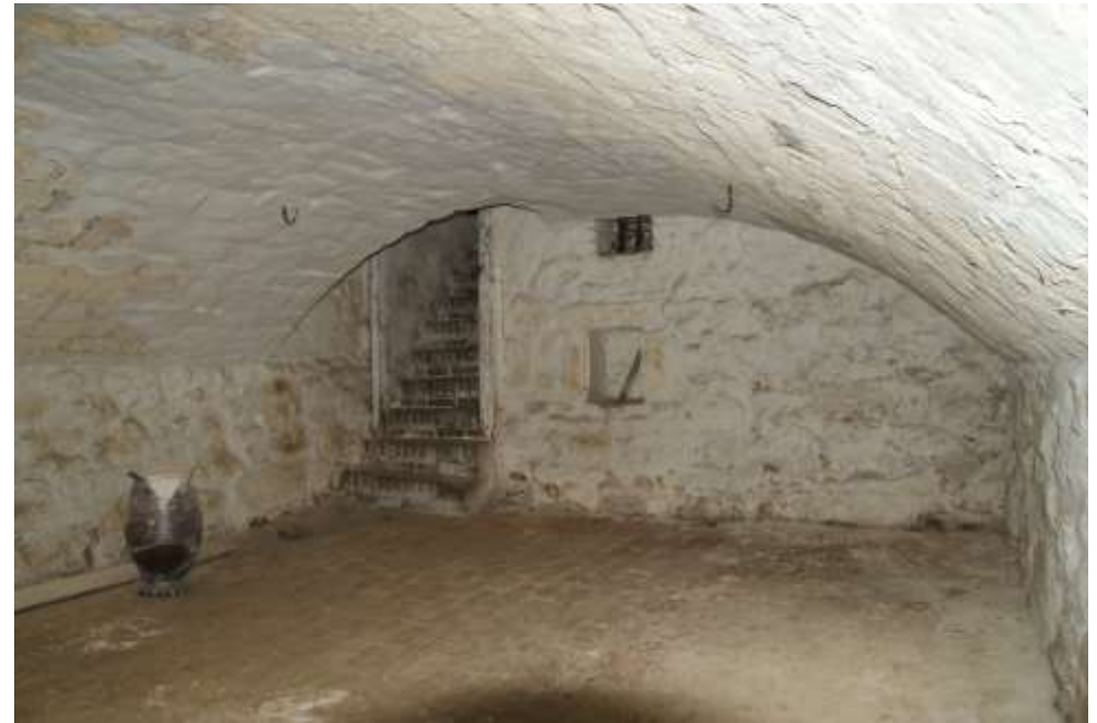
Figuur 135: De kelder van bouwdeel 3a.
