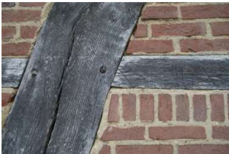
Figuur 77: De verschillende telmerken en paringstekens van de constructie van bouwdeel 1a.
