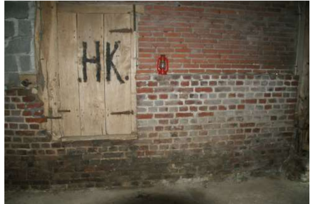
Figuur 104: Detail van de metselwerkruiling van veldbrandsteen, betonblokken en machinaal gevormde baksteen van het derde dwarsgebint in bouwdeel 1a. Daarin een opgeklampt luik.
