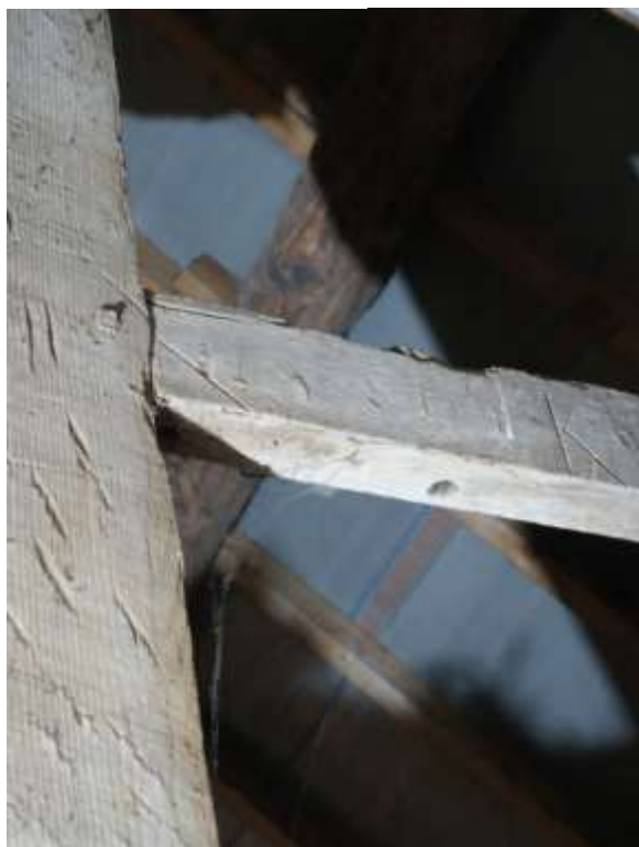
Figuur 77: De verschillende telmerken en paringstekens van de constructie van bouwdeel 1a.
