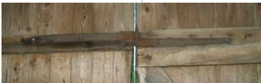
Figuur 39: Constructie van de poort. Rechts de oorspronkelijke constructie in wilde kersenhout. Pen-en-gatverbindingen en smeedijzeren toognagels voor de verbindingen. Duimgeheng voor de staldeur.
