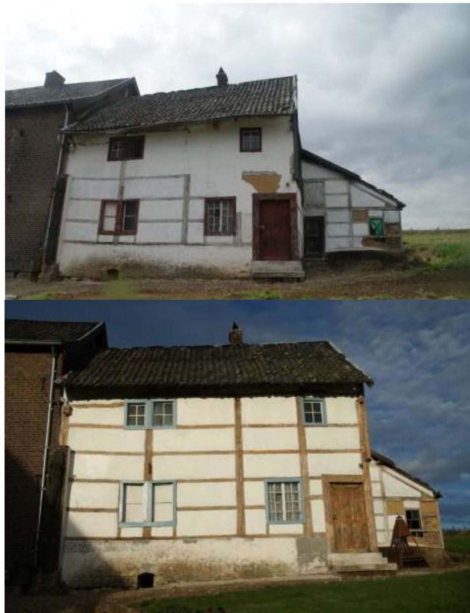
Figuur 121: De voorgevel van het vakwerkhuis (3a) voor en na het verwijderen van het pleister- en schilderwerk.
