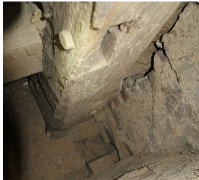
Figuur 14: Het pengat met toognagel in de stijl van het overgebleven dwarsgebint bij de achtergevel. Hierop sloot het deel van de oude woning aan dat op de plek van bouwdeel 2a stond.
