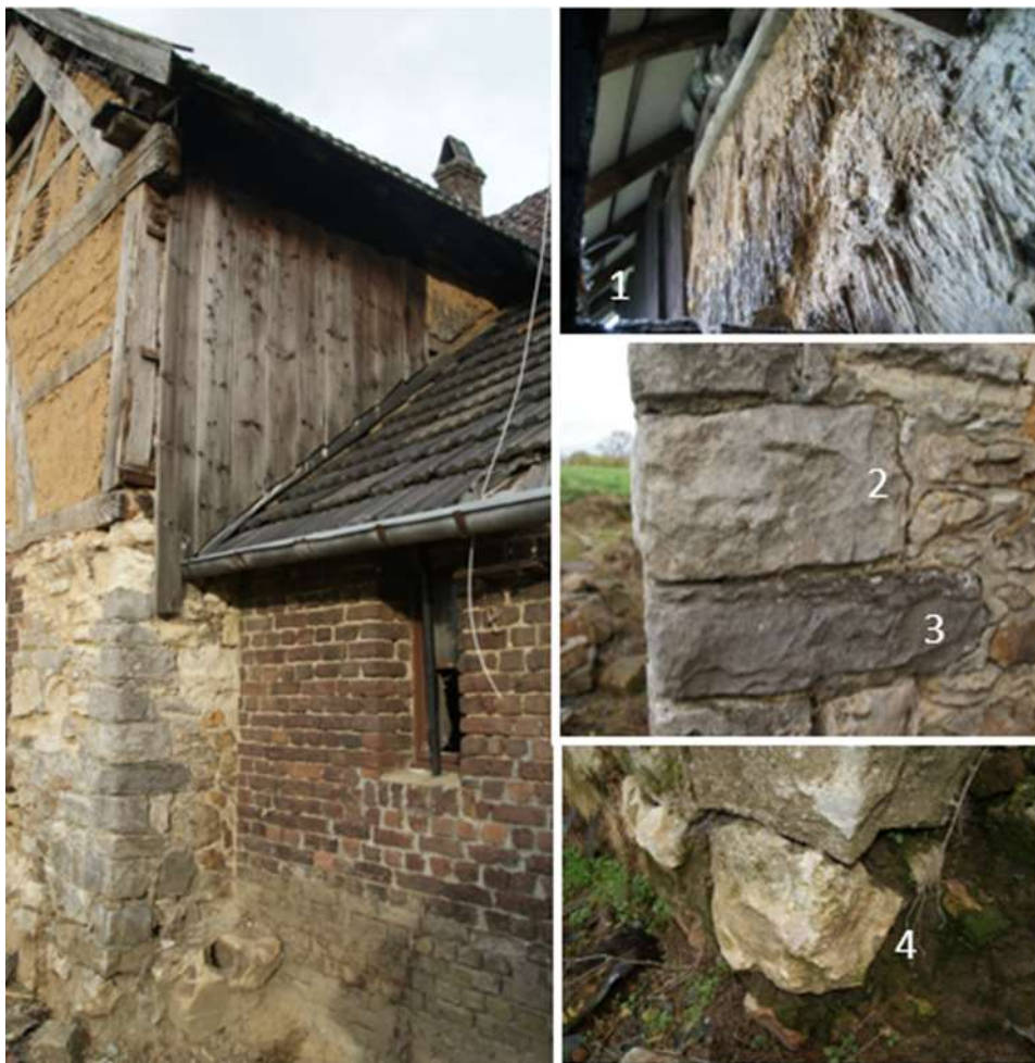
Figuur 139: Figuur 67: Linker zijgevel van bouwdeel 3b. Rechtsboven 1: Leemvulling waarin stro gedrukt is als wandafwerking. Hoekketting met 2: steen van Holset, 3: Akense Blauwsteen. In de Fundering 4: vuursteen keien
