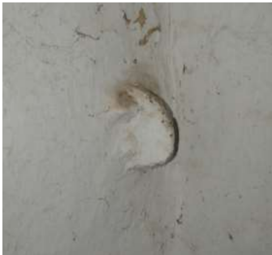
Figuur 12: De pen met sleutels van de ankerbalk van het overgeblevendwarsgebint zichtbaar vanuit bouwdeel 3c in de achtergevel van bouwdeel 3a.
