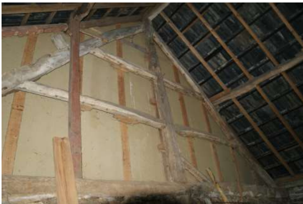
Figuur 95: Het Dwarsgebint van de kopgevel gezien van de binnenzijde. De gaten voor de vitsen zijn zichtbaar aan de onderkant van de regels.
