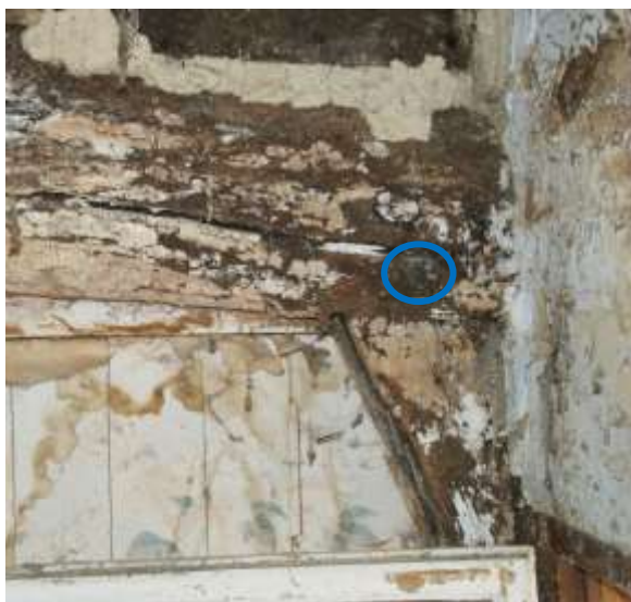
Figuur 29: De korte schoor tussen de stijl van de voorgevel en de dekbalk van de zoldervloer in het tweede dwarsgebint. Omcirkeld de toognagel
