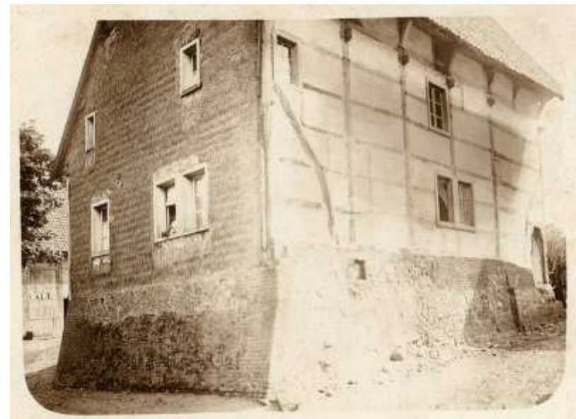
Figuur 64: Met stro beklede gevel Den Dijk 3 in Mechelen (Zuid-Limburg). De gevel is in 1904 vervangen door een gevel in baksteen (bron: Coen Eggen)
