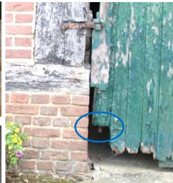
Figuur 40: Taats bij de harstijl van de linker poortvleugel.
