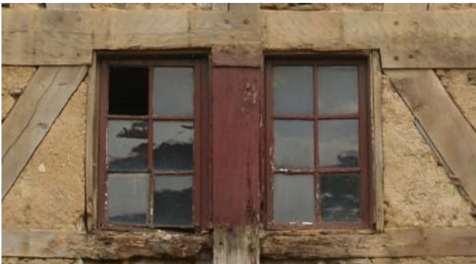
Figuur 142: De twee vensters in de achtergevel van bouwdeel 3b waarvoor de dekbalk ingezaagd werd. Tussen deze dekbalk en de wandregels daaronder werden nog twee smalle stijlen toegevoegd.
