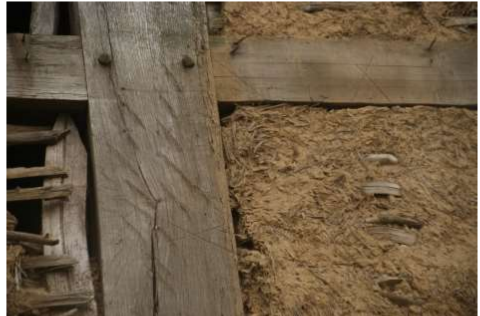
Figuur 150: Voorbeeld van telmerken en paringstekens in de achtergevel van bouwdeel 3b
