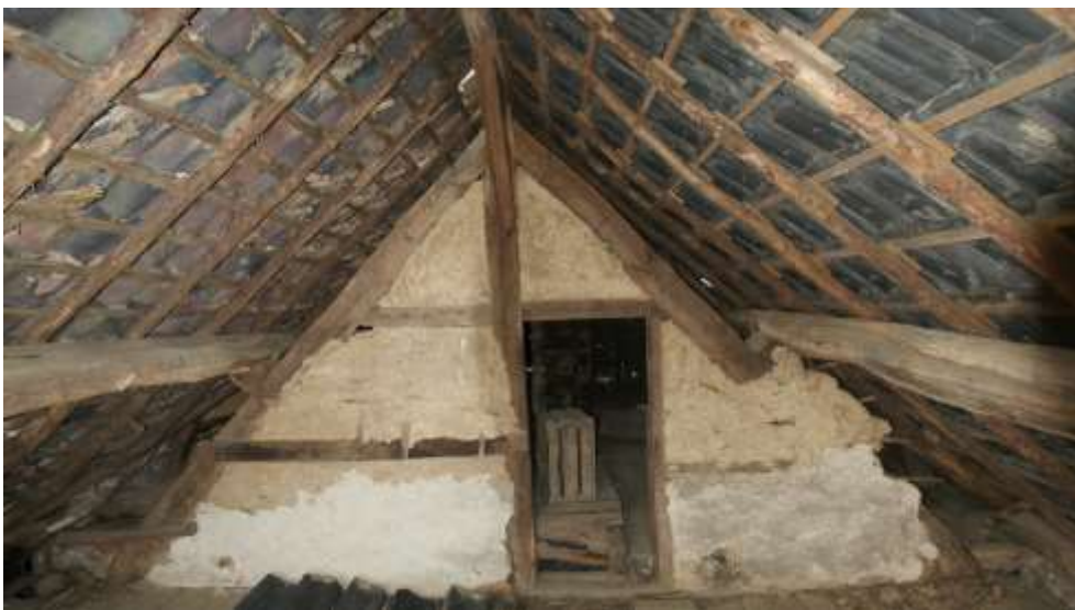
Figuur 147: Het 2e dwarsgebint van bouwdeel 3b op de achtergevel van bouwdeel 3a.
