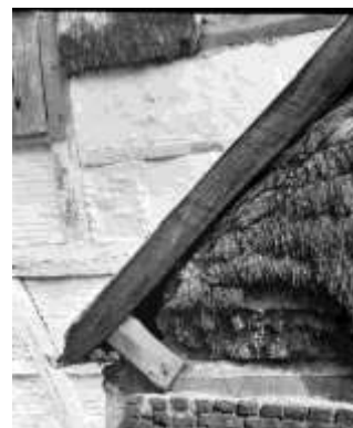
Figuur 92: De linkerhoek van de rechterzijgevel van bouwdeel 1c. Hier is de afwerking met stro in de leemvulling van de vakken te zien. (bron: RCE beeldbank)
