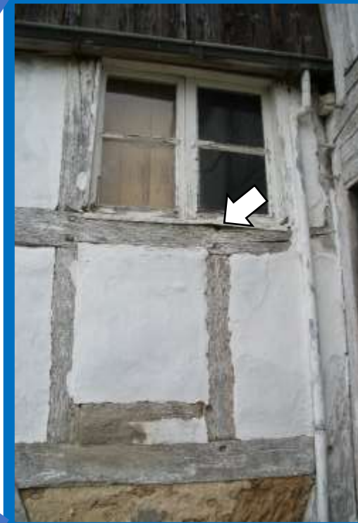
Figuur 19: Dichtgezette luikopening in de rechterzijgevel. Daarboven zat een dubbele vensteropening. Het toognagelgat duidt op een verdwenen tussenstijl (zie pijl). De rechter stijl is nog net rechts van de hemelwaterafvoer te zien.
