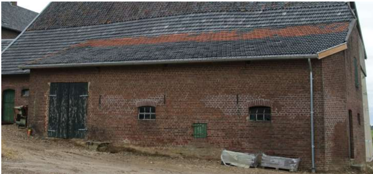
Figuur 97: De achtergevel van bouwdeel 1d
