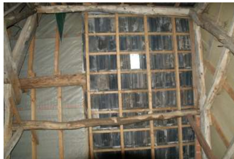
Figuur 94: Binnenzijde van het dak van bouwdeel 1c met nieuwe sporen en panlatten
