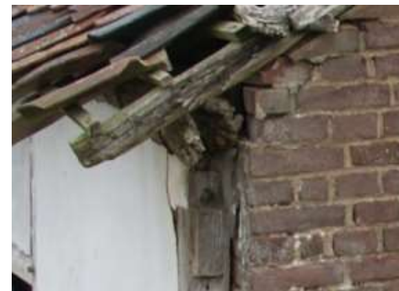
Figuur 157: De pen met toognagelgat op de rechter hoekstijl van de rechterzijgevel van bouwdeel 3d waarop de dekbalk aansloot.
