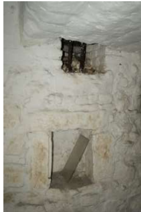
Figuur 16: Het tongewelf van de kelder gaat voor het keldervenster langs. Daaronder de lampnis.
