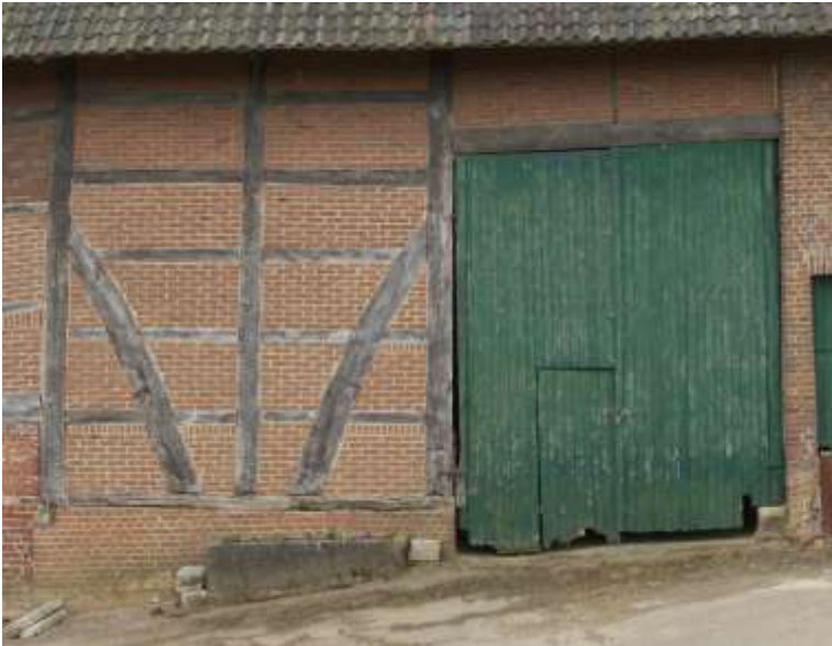
Figuur 71: De vakwerkconstructie van de 1 e en 2 e travee in de voorgevel
