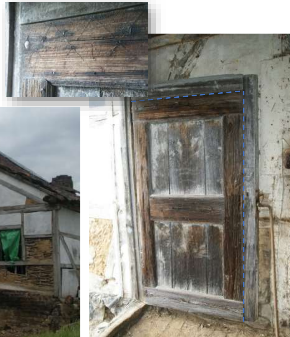
Figuur 155: De vergrootte en verkeerdom geplaatste opgeklampte deur in de voorgevel van bouwdeel 3d. De blauwe stippellijn geeft de oorspronkelijke contour van de deur aan. Inzet: de aftekening van het spijkerpatroon.
