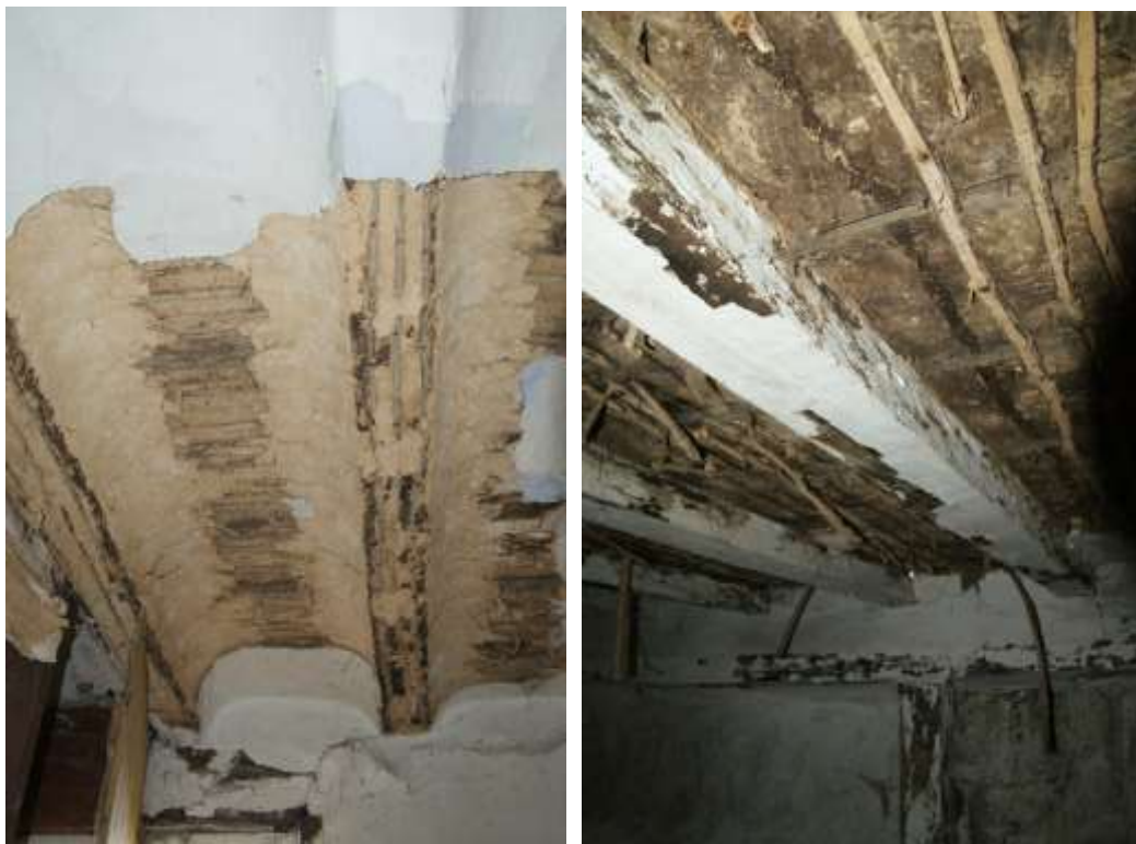
Figuur 32: Links: gespelderd plafond in de keuken. Rechts: het plafond in de eerste travee op de verdieping. Hier geen gewelfvorming met de wilgentwijgen. De twijgen zijn hier alleen tegen de vloerplanken van de zoldervloer genageld.
