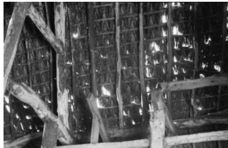
Figuur 67: De onderzijde van het dak op een foto uit 1976. Rondhoutensporen en stropoppen zijn zichtbaar (bron RCE beeldbank nr: 180026)
