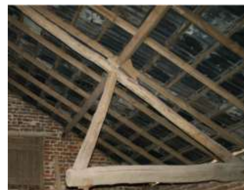
Figuur 114: Kapsant bouwdeel 2b.
