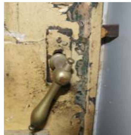
Figuur 33: Verzameling van 4 foto's van het 17 e of 18 e eeuwse hang en sluitwerk van klinkstel, schuifgrendel en duimgehang van de deur van bouwdeel 2a naar bouwdeel 3a. Bijzonder is de spiegeling van de houtnerf in de twee brede planken die op de klampen zijn gezet (onder).
