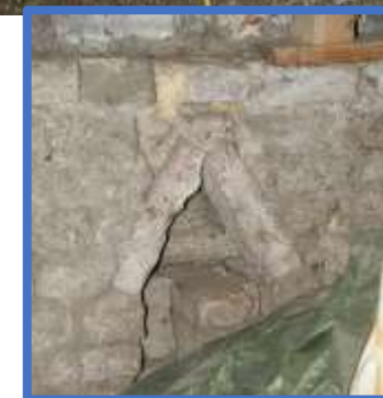
Figuur 89: De voorgevel van bouwdeel 1c. Daarin een dichtgezette nis.
