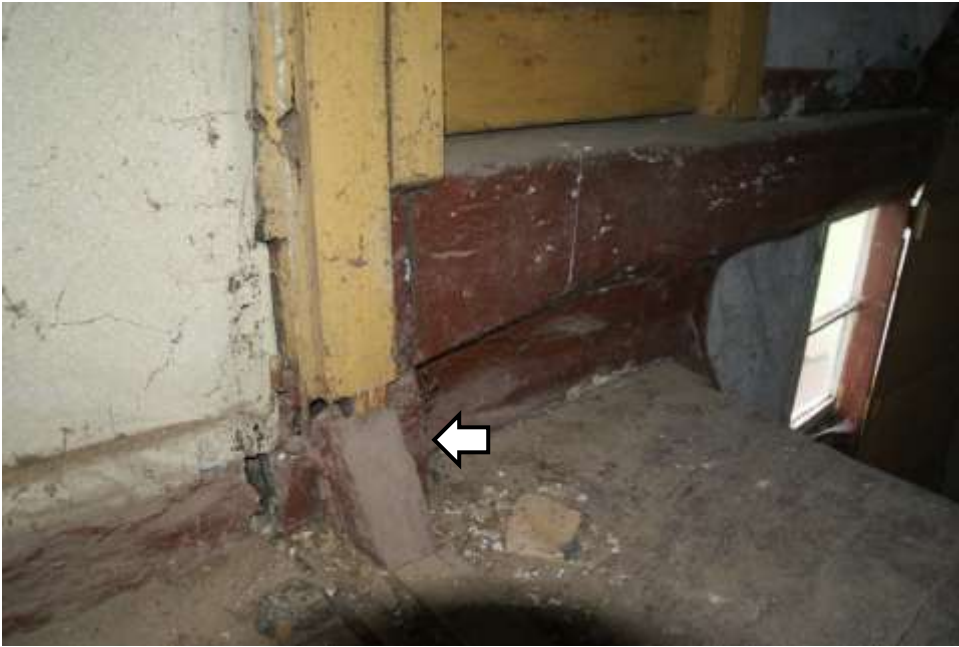
Figuur 134: Net boven de vloer steekt de bovenkant van gebintstijlschoor die aansluit op de linker hoekstijl van de achtergevel boven de vloer uit.
