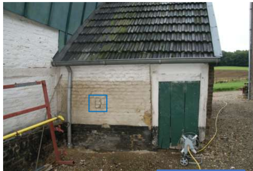
Figuur 89: De voorgevel van bouwdeel 1c. Daarin een dichtgezette nis.
