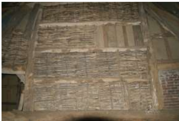
Figuur 63: De binnenkant van de rechterzijgevel (1a) Achter de trespabekleding zijn de vakvullingen met vitsen, witsen en stroleem zichtbaar.
