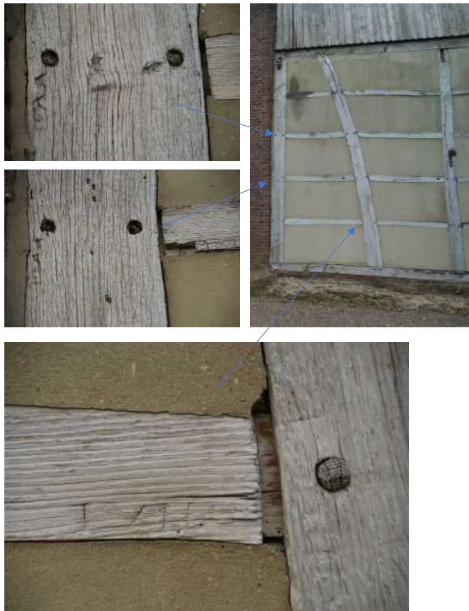
Figuur 43: Gehakte telmerken en toognagelgaten in de hoekstijl van bouwdeel 1b bij bouwdeel 1d die aantonen dat het gesloopte deel hoorde bij de oorspronkelijke opzet van bouwdeel 1b.
