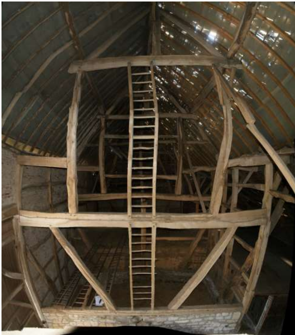
Figuur 68: Het tweede dwarsgebint en daarachter het eerste dwarsgebint. De ruimte daartussenin is de 'wisj', de opslagruimte voor geoogste gewassen zoals stro en hooi.
