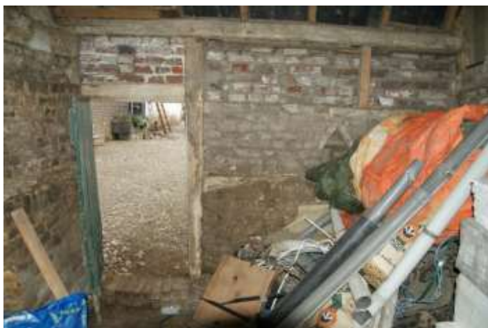
Figuur 88: De voorgevel van bouwdeel 1c gezien van binnen.
