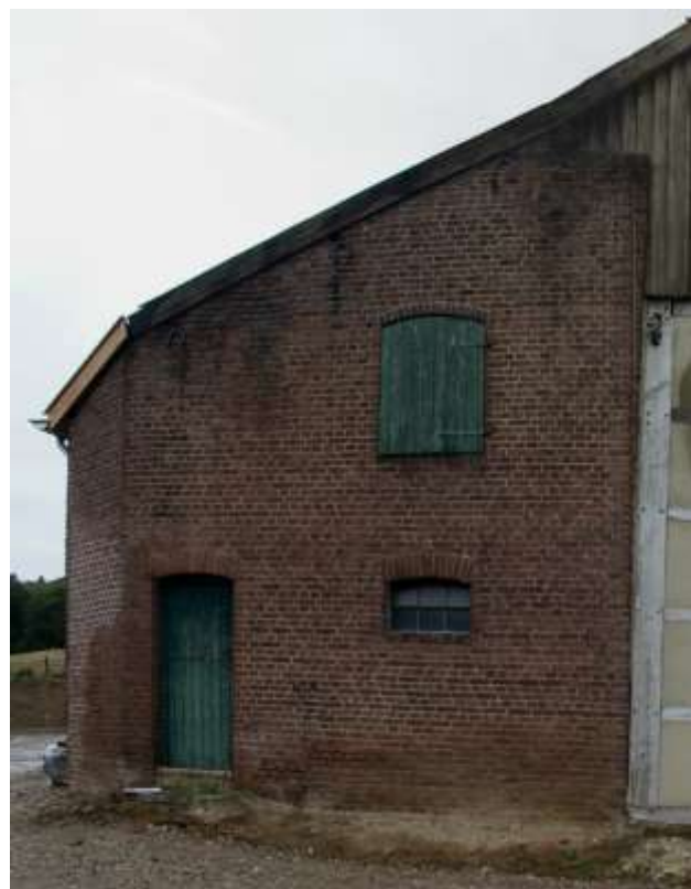
Figuur 96: De linkerzijgevel van bouwdeel 1d.
