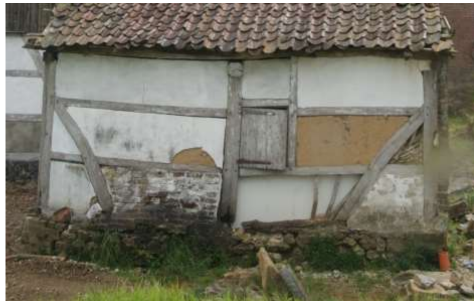
Figuur 156: rechterzijgevel van bouwdeel 3d.
