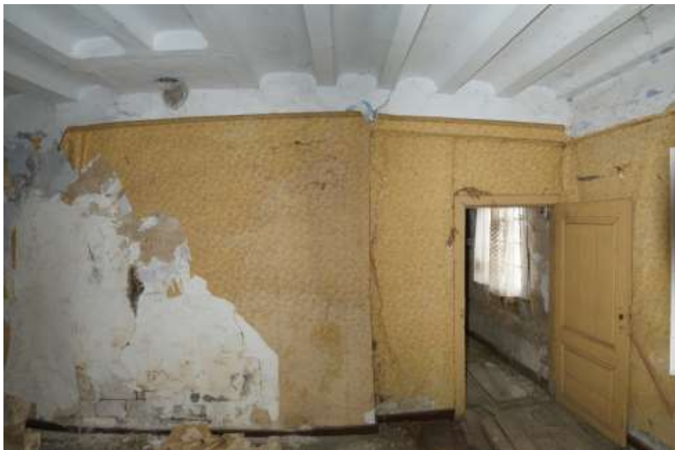
Figuur 171: Woonkamer in de eerste en tweede travee van bouwdeel 3a. In het plafond de raveling voor de rookvang van de schouw. Bij de plint is Vijlense kalksteen van de achterwand te zien.
