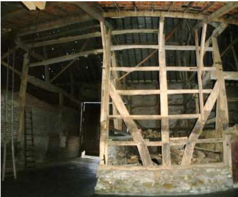
Figuur 72: De vakwerkconstructie van de 1 e en 2 e travee in de achtergevel.
