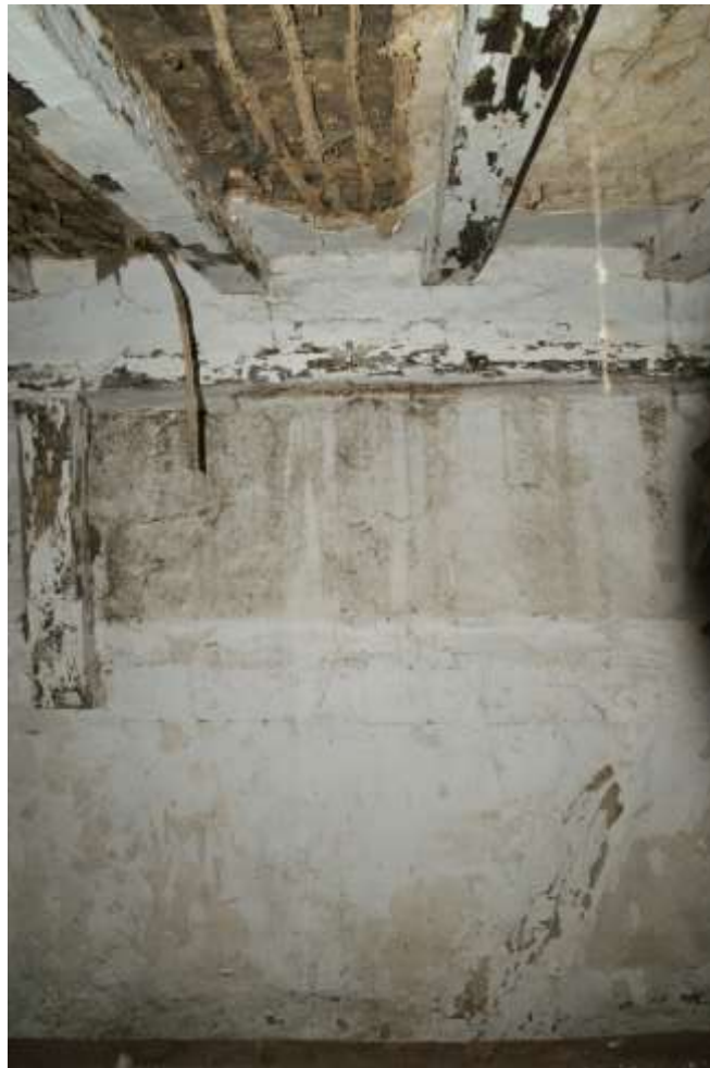
Figuur 136: De dekbalk op de eerste verdieping in de voorgevel (links), in de wand met daaronder de schoor (midden) en in de achtergevel (rechts). Rechtsonder het pengat en de toognagel van de wandregel die hier aan de kant van bouwdeel 2a op aansloot.
