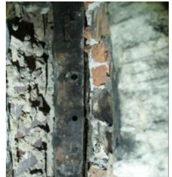
Figuur 24: De beroete stijl rechts van de achterwand van de schouw. Daarin toognagelgaten voor de schoor die de rookvang ondersteunde.
