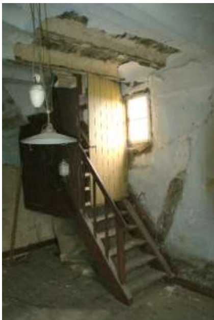
Figuur 173: Links: De trap van de begane grond naar de eerste verdieping. Rechts: de laddertrap naar de zolder. Op de achtergrond het rookkanaal van de schouw.
