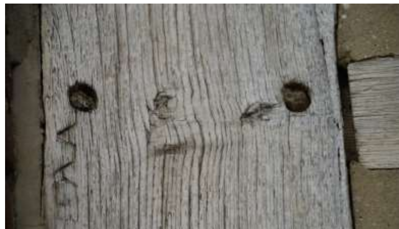
Figuur 86: Voorbeeld van een gehakt telmerk in de rechterzijgevel
