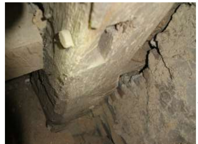
Figuur 136: De dekbalk op de eerste verdieping in de voorgevel (links), in de wand met daaronder de schoor (midden) en in de achtergevel (rechts). Rechtsonder het pengat en de toognagel van de wandregel die hier aan de kant van bouwdeel 2a op aansloot.
