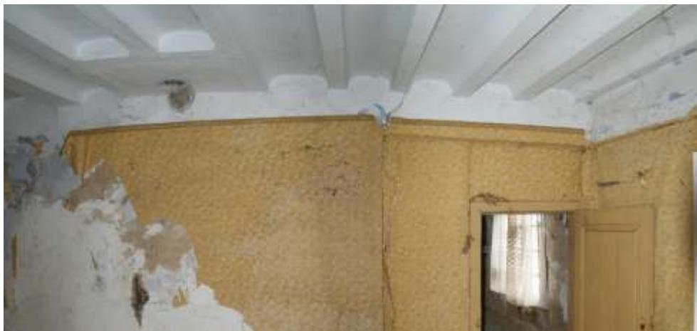
Figuur 138: Ankerbalk van het 3e dwarsgebint met de kinderbinten van de 1e verdiepingsvloer
