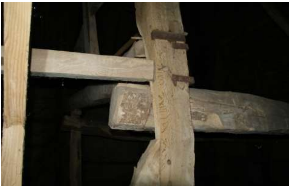
Figuur 44: De aansluiting van een van de tussenbalken van bouwdeel 1b (rechts) op de stijl van het eerste dwarsgebint van bouwdeel 1a.
