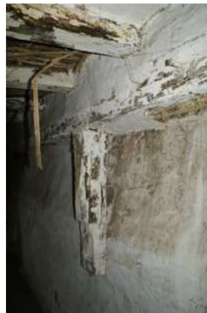
Figuur 11: De stijl op de debalk van het overgebleven dwarsgebint van het oude woonhuis. De stijl draagt de moerbalk onder de kinderbinten van de zoldervloer van bouwdeel 3a
