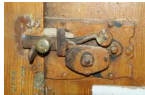
Figuur 33: Verzameling van 4 foto's van het 17 e of 18 e eeuwse hang en sluitwerk van klinkstel, schuifgrendel en duimgehang van de deur van bouwdeel 2a naar bouwdeel 3a. Bijzonder is de spiegeling van de houtnerf in de twee brede planken die op de klampen zijn gezet (onder).
