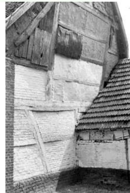
Figuur 62: De rechterzijgevel van bouwdeel 1a in 1976 in 2 vakken is in de leemvulling strogedrukt (bron: RCE beeldbank nr: 180031)
