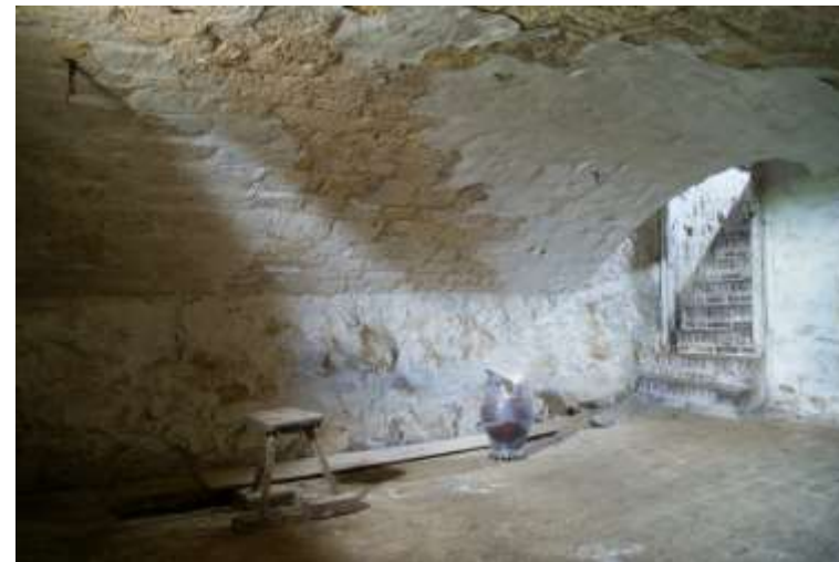
Figuur 160: De kelder onder de 1e en 2e travee van bouwdeel 3a.
