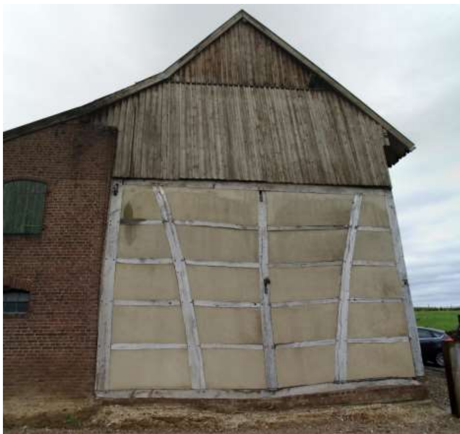
Figuur 83: De linkerzijgevel van bouwdeel 1b.
