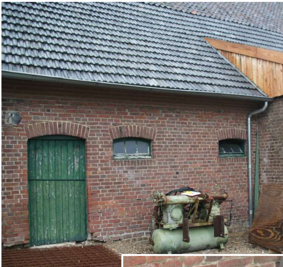
Figuur 60: De achtergevel van de afsluit bij de derde travee van de grote schuur (1a). Links boven de stalpoort is de kopse kant van de dekbalk te zien. Rechts onder (inzet) de koppenlaag in veldbrand waarop de voetstijlplaat van de vakwerkconstructie van de voorganger van deze gemetselde gevel geplaatst was.
