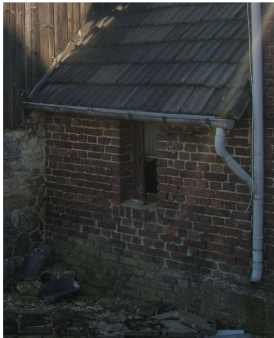
Figuur 152: De achtergevel van bouwdeel 3c.
