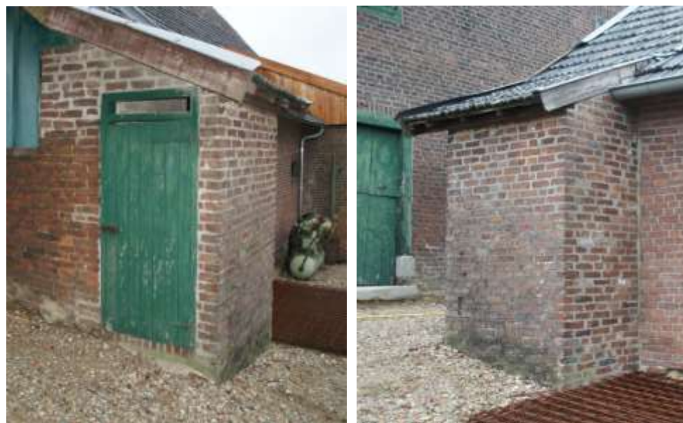
Figuur 100: De drie gevels en het dak van bouwdeel 1e.
