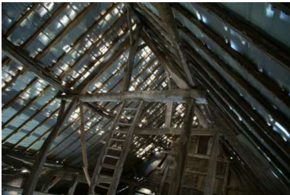
Figuur 66: De binnenzijde van het dak van de grote schuur (1a). Links de in de jaren '80 van de vorige eeuw vernieuwde daksporen van het zuidelijke dakvlak. Rechts de ronde daksporen van naalddhout die ook al in 1976 aanwezig waren. Daarbovenop de versterkte kunststoffolie.
