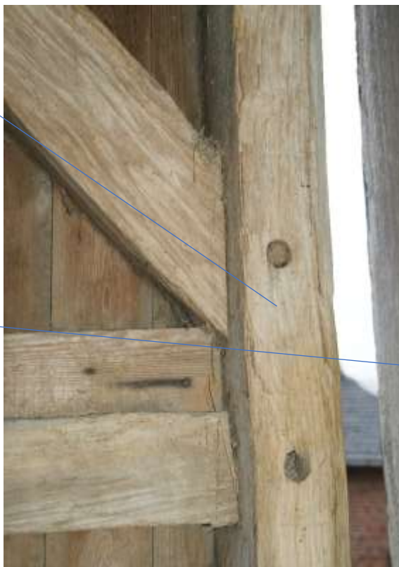
Figuur 39: Constructie van de poort. Rechts de oorspronkelijke constructie in wilde kersenhout. Pen-en-gatverbindingen en smeedijzeren toognagels voor de verbindingen. Duimgeheng voor de staldeur.
