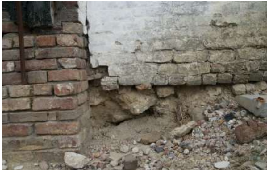
Figuur 123: De vuursteenkeien van de fundering en kelderwand zijn vrijgelegd naast de pomp.
