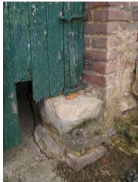
Figuur 56: De taatssteen van de poort van de grote schuur (1a)
