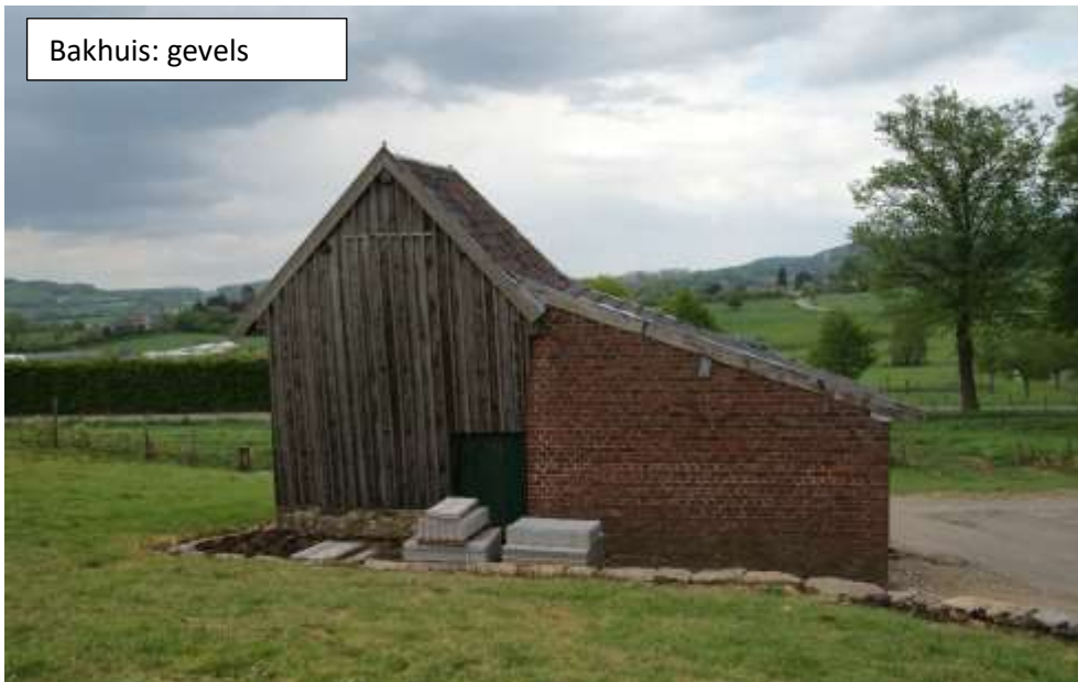
Figuur 179: Voorgevel bouwdeel 4a (links) en bouwdeel 4b rechts.
