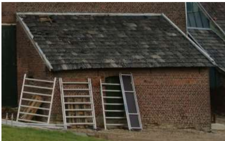
Figuur 112: Achtergevel en linkerzijgevel bouwdeel 2b.
