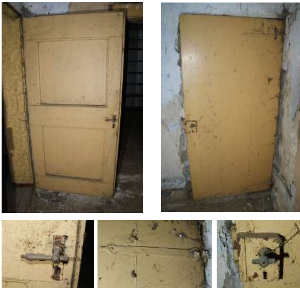
Figuur 36: De opgeklampte deur van de woonkamer van bouwdeel 3a naar bouwdeel 3b met het hang en sluitwerk.
