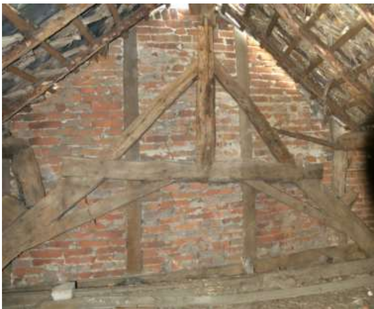
Figuur 137: De kapgebinten van bouwdeel 3a.
