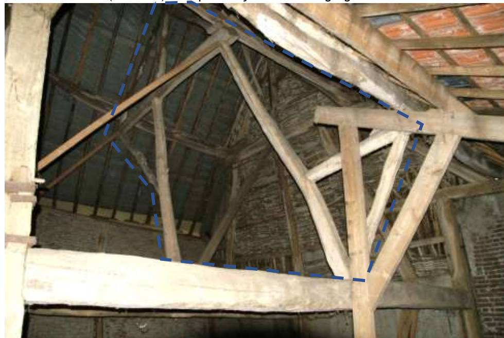
Figuur 85: Het tweede dwarsgebint (blauw gestippelde kader) op de dekbalk (voorgrond) en de ankerbalk (net zichtbaar onder de dekbalk in de achtergrond)
