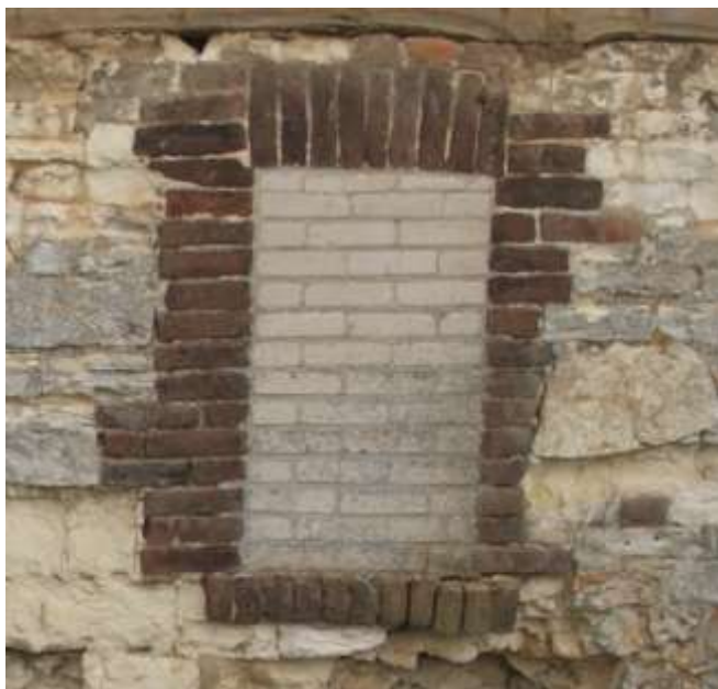
Figuur 34: Het rechter venster in de achtergevel. Met de hoekketting in veldbrandsteen is de voeg van het oorspronkelijke metselwerk in Vijlense kalksteen opgezocht. Voor de raamdorpelstenen is de kalksteen ingezaagd.
