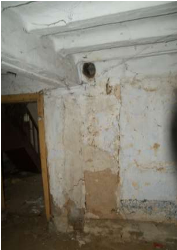
Figuur 149: Rechts beneden naast de deuropening is de stijl te zien die tegen de achtergevel van bouwdeel 3a is geplaatst en waarop de moerbalk ligt die de kinderbinten van de eerste verdiepingvloer draagt.
