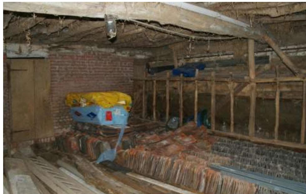
Figuur 102: Het interieur van de veestal in bouwdeel 1b. Met de muur van moderne baksteen in de achtergrond
