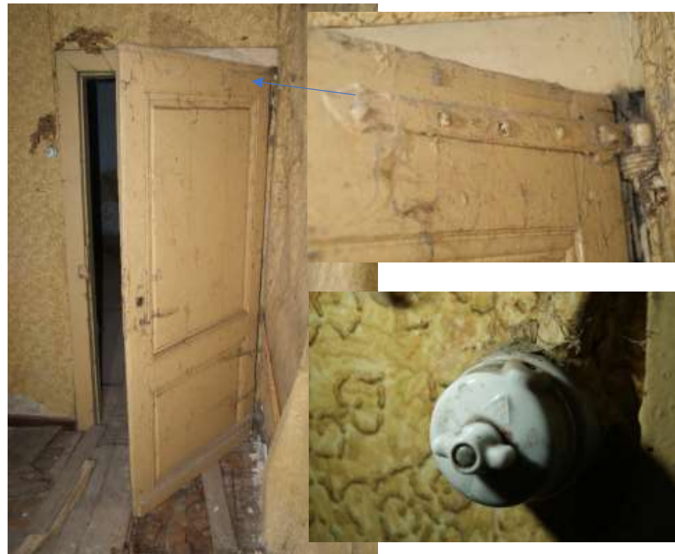
Figuur 174: De deur van de woonkamer naar de keuken. Inzet: duimgeheng en een porseleinen schakelaar.
