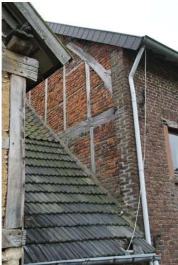
Figuur 109: Rechterzijgevel van bouwdeel 2a. Het vakwerkgebint is gevuld met zachte veldbrandstenen. De achtergevel steekt iets
