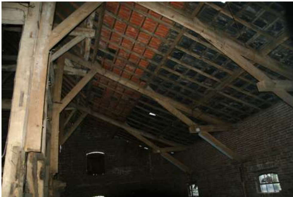
Figuur99: De kapconstructie van bouwdeel 1d nadat de trek balken en de verdiepingsvloer zijn weggehaald.
