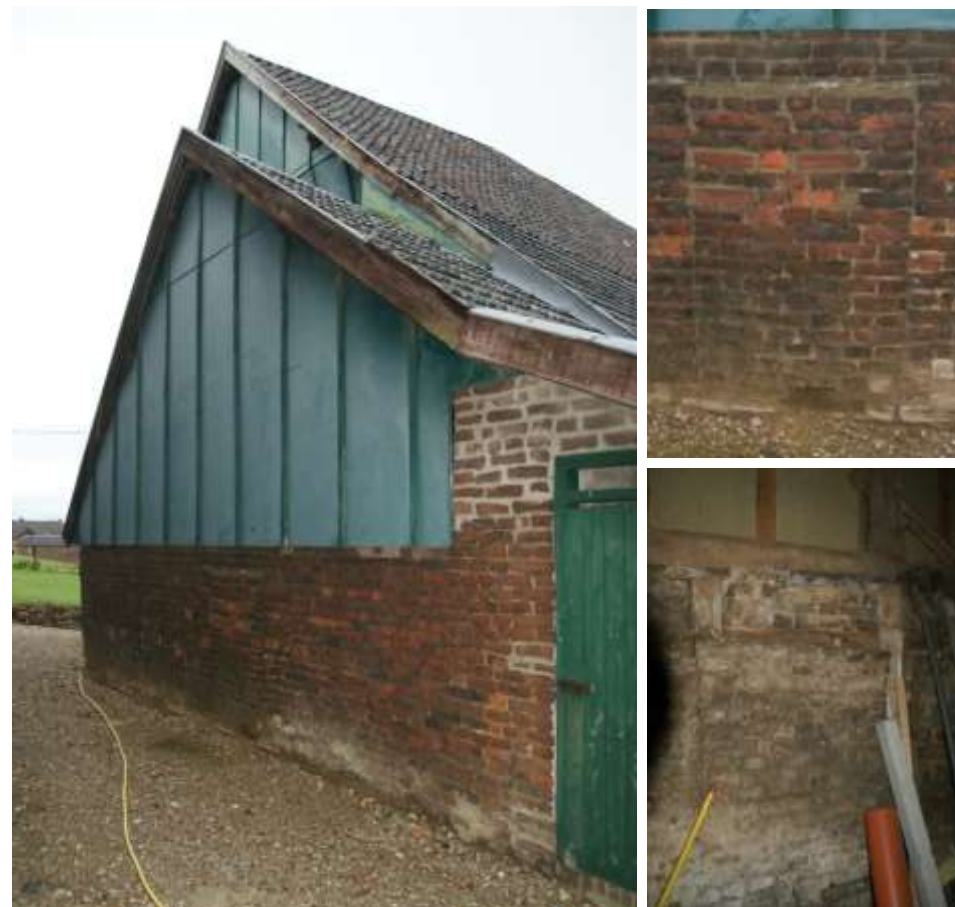
Figuur 91: De rechterzijgevel van bouwdeel 1c. Rechtsboven de dichtgezette deur in de buitenkant van de gevel. Rechtsonder diezelfde dichtgezette deuropening aan de binnenzijde.
