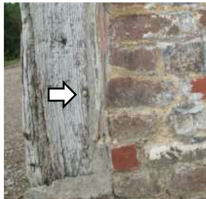
Figuur 39: Één van de voorgeboorde gaten voor de smeedijzeren nagels waarmee de houten regel aan de hoekstijl bevestigd was.
