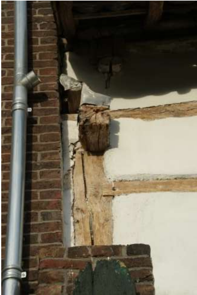
Figuur 136: De dekbalk op de eerste verdieping in de voorgevel (links), in de wand met daaronder de schoor (midden) en in de achtergevel (rechts). Rechtsonder het pengat en de toognagel van de wandregel die hier aan de kant van bouwdeel 2a op aansloot.
