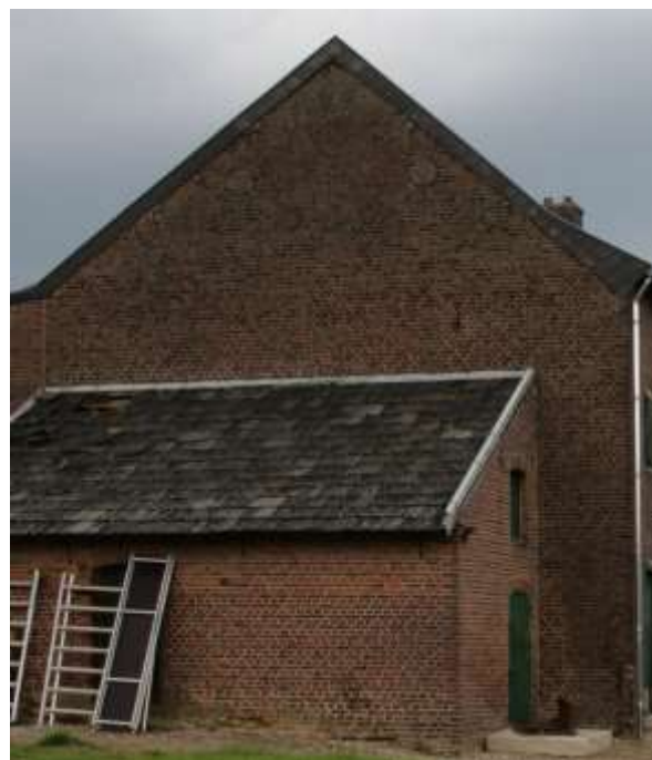
Figuur 106: Linkerzijgevel van bouwdeel 2a
