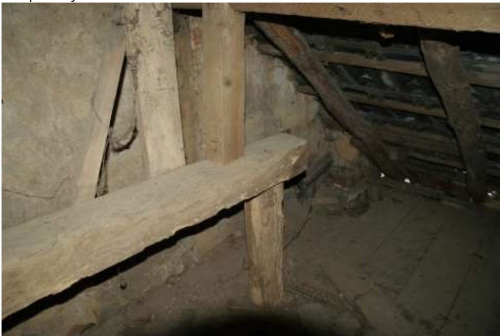
Figuur 153: De kapconstructie van bouwdeel 3c.
