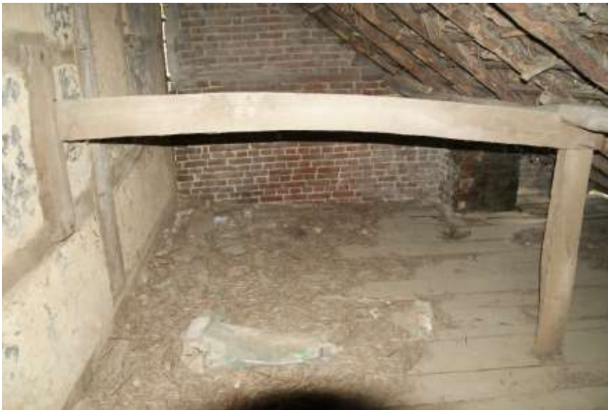
Figuur 159: De stijl met de dekbalk en de gording die de draagconstructie van de kap vormen. links vastgezet op de rechterzijgevel van bouwdeel 3b.
