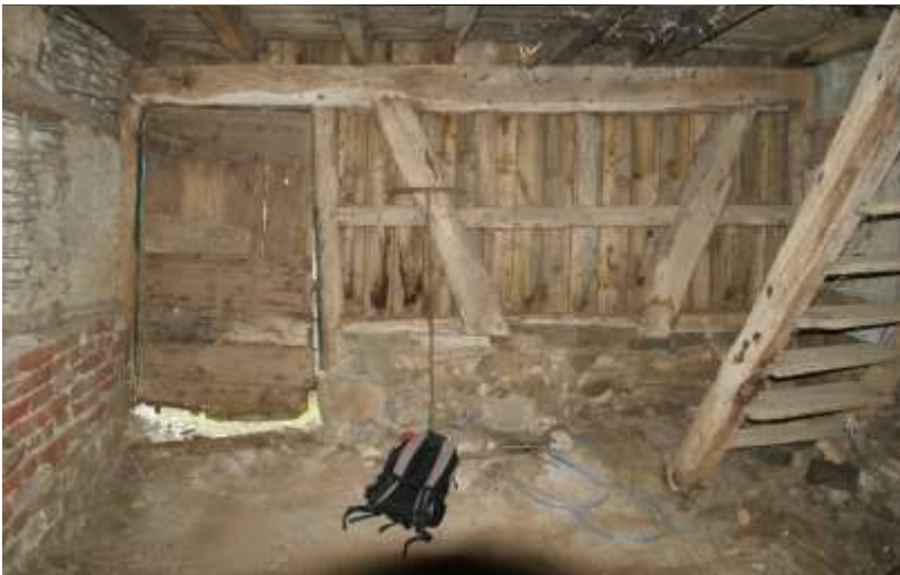
Figuur 184: Zicht vanaf de begane grond op de voorgevel van bouwdeel 1a
