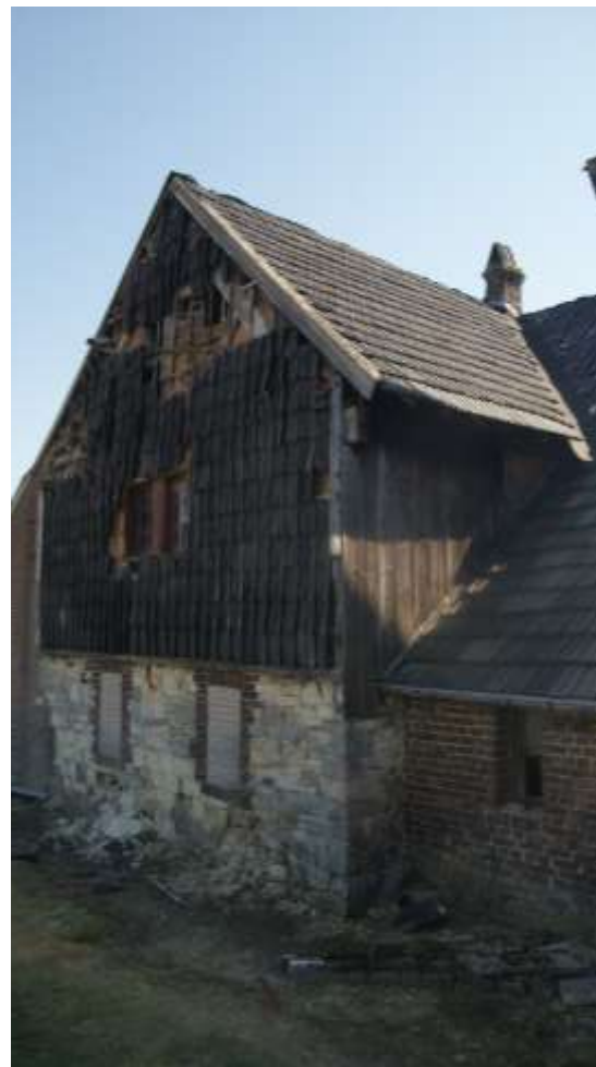
Figuur 140: De achtergevel van bouwdeel 3b. Midden: voordat de bekleding met pannen werd verwijderd. Rechts: Nadat de pannen werden verwijderd.
