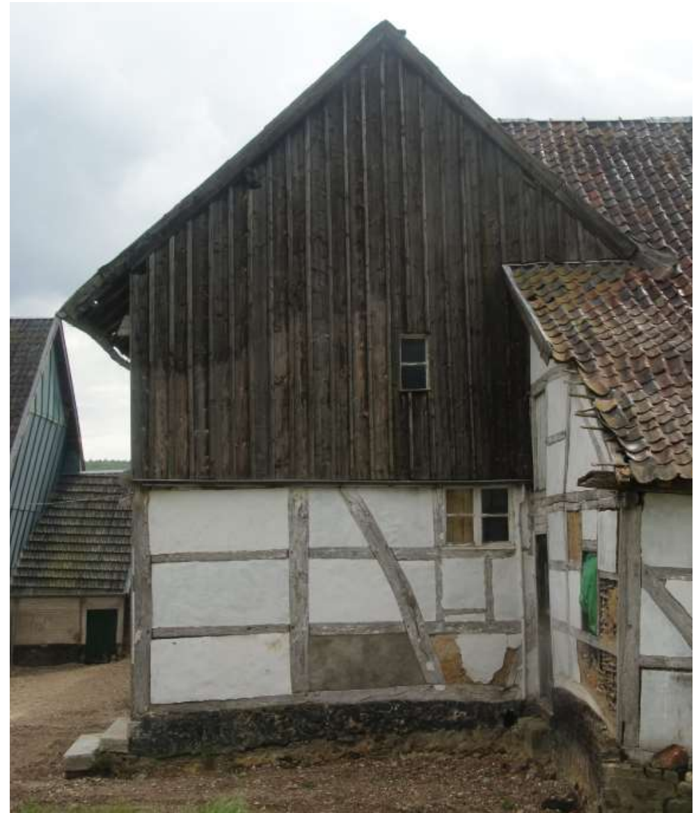
Figuur 127: De rechterzijgevel van bouwdeel 3a
