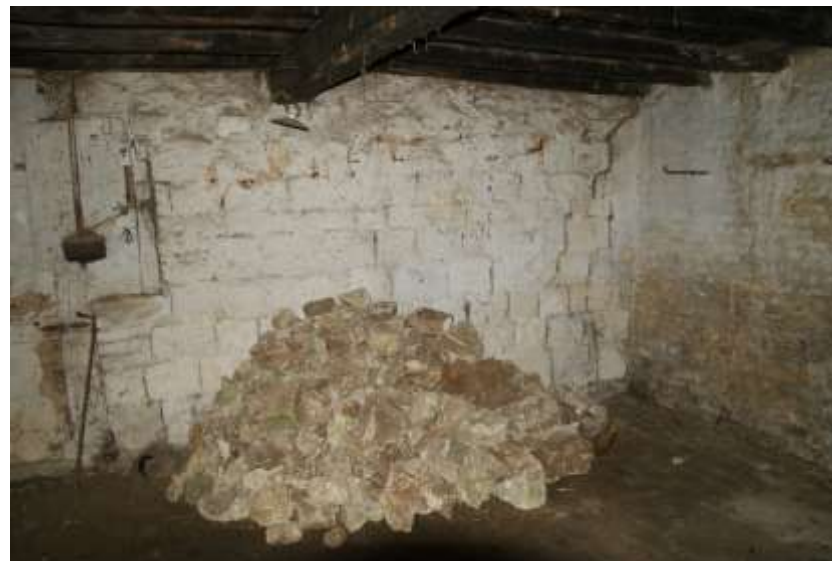
Figuur 145: De linkerzijgevel van bouwdeel 3b in witgekalkte Vijlense kalksteen gezien vanaf de beganegrond van bouwdeel 3d.
