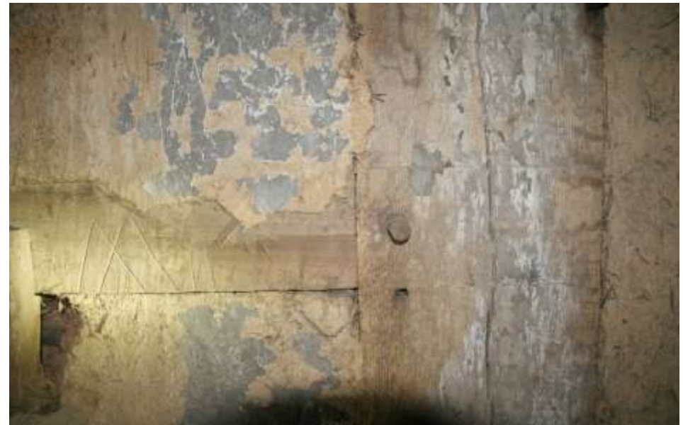
Figuur 151: Voorbeeld van telmerken en paringstekens in de rechterzijgevel van bouwdeel 3b
