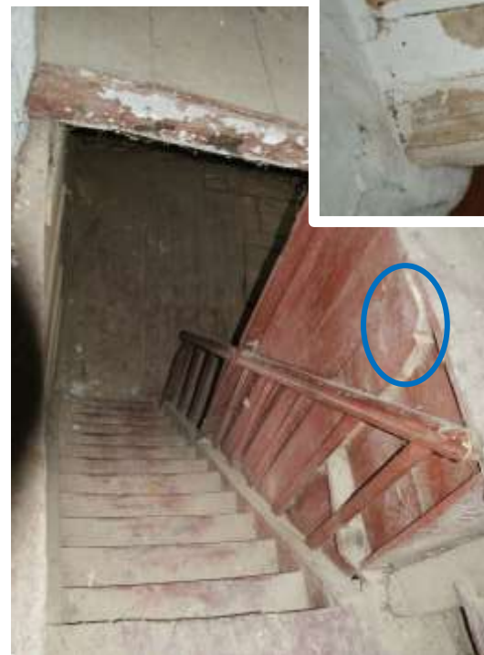
Figuur 26 (boven): De raveling van de trap in de 1 e verdiepingvloer. Die sluit rechts aan op de kinderbint die later is doorgezaagd om het trapgat te vergroten.
