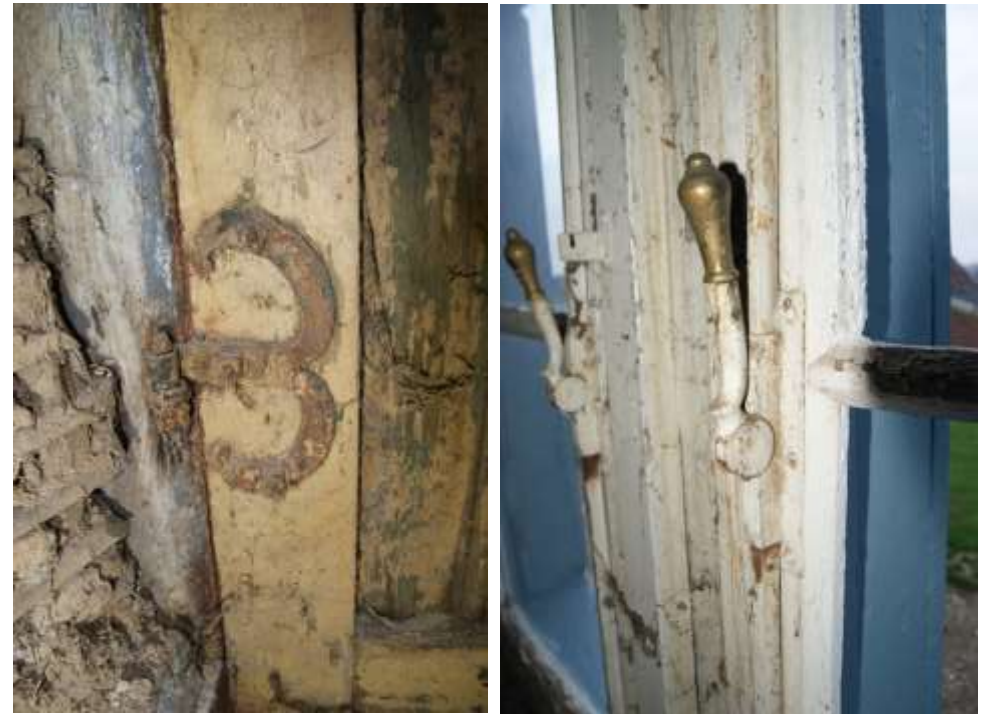
Figuur 126: Links: Duimgehang van de voordeur. Rechts: dubbelwerkende pompespagnolet bij het venster op de begane grond.
