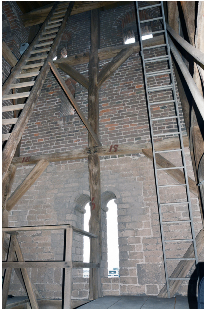
Afb. 3 Het vakwerk is opgebouwd uit hoekstijlen en middenstijlen met afgeschoorde tussenbalken. (foto K. Emmens)
