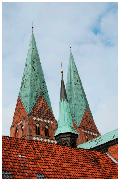
Afb. 17 De Marienkirche in Lübeck heeft twee westtorens waarop de oudst dateerbare houten naaldspitsen uit 1350 voorkomen. Ook hier zijn nog vier topgevels onderdeel van de torenbekroning. De oorspronkelijke constructie was overigens al in de negentiende eeuw sterk aangepakt en na de verwoesting tijdens de Tweede Wereldoorlog zijn ze in oude vorm herbouwd. Het kleine torenspitsje op de voorgrond is van het naast de kerk gelegen stadhuis. (foto K. Emmens)
