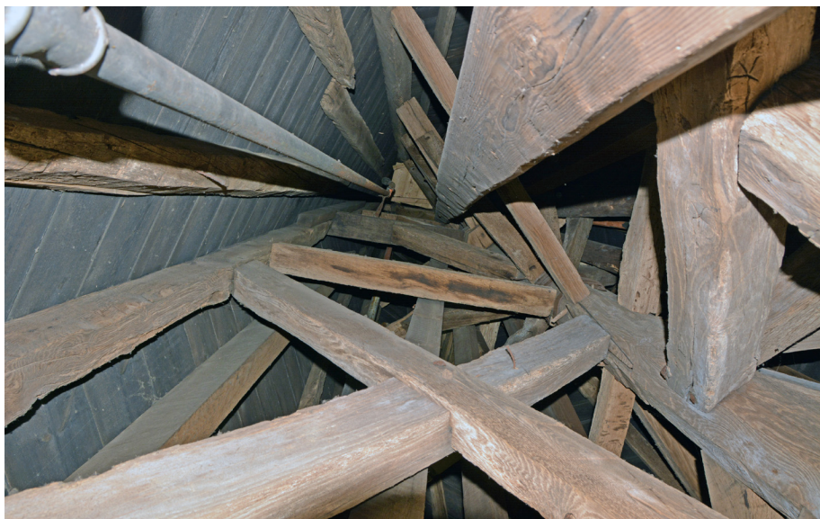
Afb. 10 Zicht naar boven in de spits, met links het dakvlak. Op de voorgrond een van de kruisschoren tussen de hoekkeper en de middenstijl. Daarboven eerst een tussenbalk, gevolgd door afgeschoorde tussenbalken op enkele niveaus. (foto K. Emmens)
