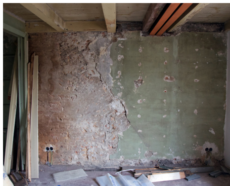
Afb. 3 De oude topgevel van het buurpand tekent zich duidelijk af in de linker zijgevel. (foto auteur, mei 2017)
