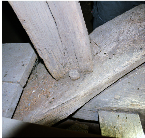
Afb. 12 Het lijkt erop dat de spantbenen niet in de overhoekse balk en de daaronder gelegen dekbalk gepend zijn, maar slechts aan de achterzijde door een toognagel die door beide balken steekt zijn gefixeerd. Rechts een blokkeel dat in de dekbalk steekt en met een toognagel is gezekeerd. (afb. K. Emmens)
