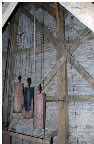
Afb. 19 Vakwerk als torenverband komt ook in de kerk van Wüllen (achter Enschede) voor. Hier echter niet ten behoeve van de torenbekroning maar van de klokkenstoel. De ouderdom is onbekend, de oudste klok stamt uit 1496 en die datum vormt een terminus ante quem . (foto K. Emmens)
