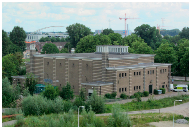
Afb. 1 Het 50kV-schakelstation. (foto Willard van Reenen)
