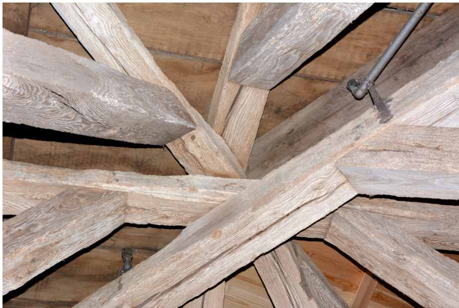
Afb. 8 De tussenbalken van de vier spanten zijn op elkaar gestapeld. Op het middelpunt staat de koningsstijl. (foto K. Emmens)
