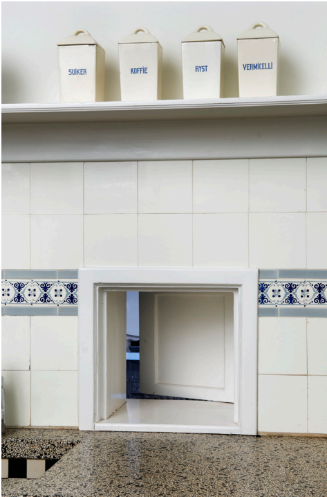
Afb. 2 Sommige huizen en naoorlogse flats hebben in plaats van een doorgeefluik een doorgeefkast. Van doorgeefluiken zijn voldoende voorbeelden. De Lairessestraat 37 te Amsterdam, doorgeefluik (draailuik) in keuken. (Rijksdienst voor het Cultureel Erfgoed, foto J. van Galen)
