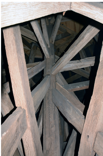
Afb. 9 In het midden staat de achzijdig afgewerkte koningsstijl, die met kruisschoren (links en rechts op de foto) op de spantbenen is gefixeerd. Boven deze kruisschoren zijn eerst de tussenbalk en dan de afgeschoorde tussenbalk te zien. Op de voorgrond (bovenzijde van de foto), is een klein deel van de kruisschoren zichtbaar die ook op dit niveau als een soort langsverband op de spantbenen zijn genageld. (foto K. Emmens)
