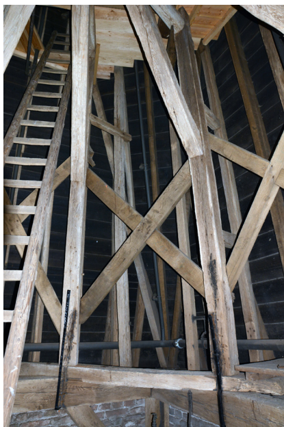
Afb. 7 Als een soort langsverband zijn kruisschoren op de spantbenen genageld. Deze kruisen en de korbeels van de spanten zetten van links naar rechts gezien telkens op een iets hoger niveau aan. De verklaring daarvoor is te zien op afb. 10. (foto K. Emmens)
