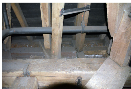
Afb. 11 Op de muurkroon liggen twee muurplaten. Op de voorste staan de hoekkepers, de achterste dient voor de oplangers. De blokkeels waarop de hoekkepers staan zijn nu eens diagonaal (gericht op het middelpunt van de spitsconstructie) en dan weer haaks op de muren gepositioneerd. Ook varianten daar tussenin komen voor. (foto K. Emmens)
