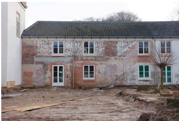
De dienstvleugel voor het aanbrengen van de verlaag. Tal van sporen zijn zichtbaar waaronder de trappen uit de jaren zestig. (foto P.J. Bosman)
