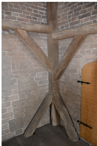
Afb. 5 In de hoeken zijn de stijlen afgeschoord op de voetbalken en de tussenbalken op de hoekstijlen. De tussenbalken liggen iets verschoven ten opzichte van elkaar. (foto K. Emmens)
