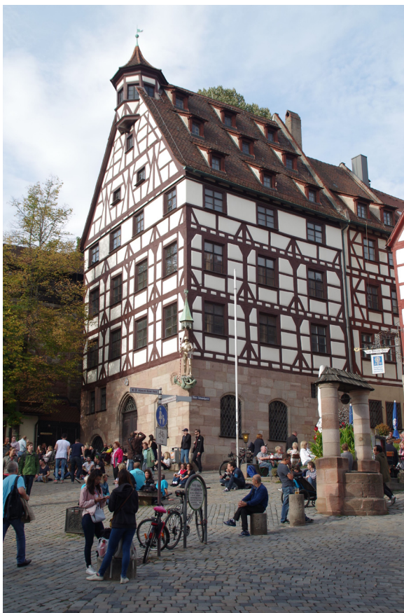
Het Pilatushuis in de binnenstad van Nürnberg, gebouwd in 1489 met vakwerk op een stenen onderbouw. Of het erkerje in de top al dan niet later is toegevoegd, was onderwerp van de nodige discussie. (foto R. Stenvert)
