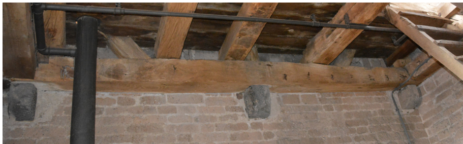
Afb. 4 Het vakwerk staat op voetbalken, die gedragen worden door ingemetselde consoles van trachiet. (foto K. Emmens)
