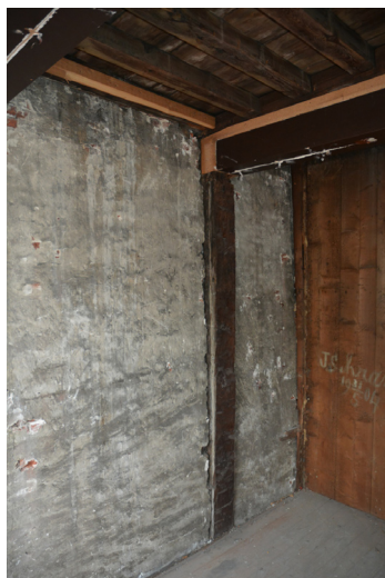
Afb. 10 Breestraat 97 (kort na 1606), ongeschilderde grenenhouten samengestelde balklaag op een houtskelet zonder decoratieve sleutelstukken op de tweede verdieping. (Dröge, Bureau voor Bouwhistorie, J. Dröge)
