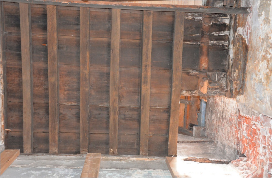
Afb. 4 Breestraat 66 (1570 d.), ongeschilderde eikenhouten samengestelde balklaag met consoles en ongeschilderde naaldhouten vloerdelen boven de begane grond. (ELO, P.J. De Vos)
