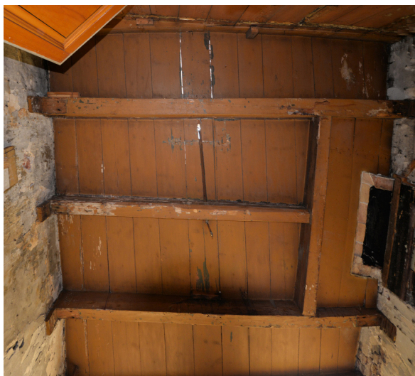
Afb. 6 Nieuwsteeg 17 (1592 a.), geschilderde grenen-houten enkelvoudige balklaag boven eerste verdieping. (ELO, P.J. De Vos)
