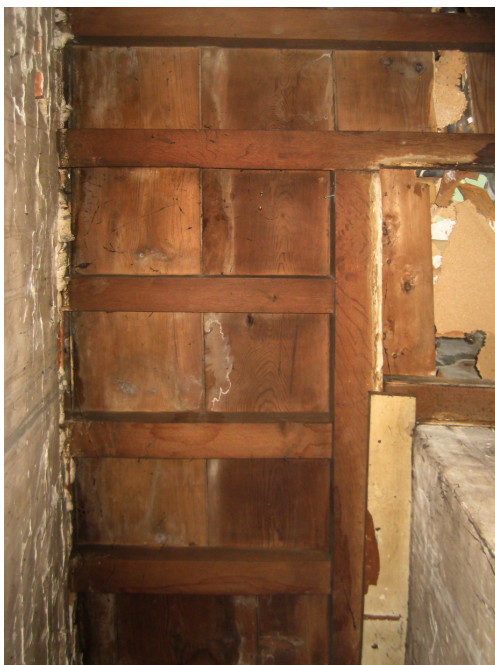
Afb. 7 Oude Rijn 19 (1603 d.), ongeschilderde samengestelde eiken balklagen met ongeschilderde naalddhouten vloerdelen boven begane grond. (ELO, E.D. Orsel)
