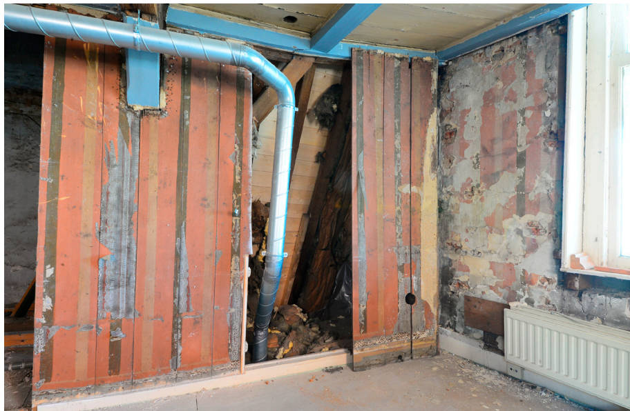
Afb. 1 De 'striepte' wand in de zolderkamer van het voorhuis Aalmarkt 11.
