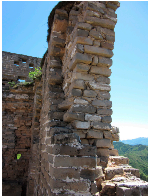
Afb. 2 Detail van de Chinese Muur in de buurt van Jinshanling. De muur is deels opgetrokken in Vlaams verband, stenen voor zichtwerk en opvulling zijn zorgvuldig geselecteerd. (foto auteur)
