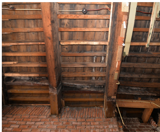
Afb. 9 Hogewoerd 97 (ca. 1600), samengestelde balklaag met eiken moerbalken, grenen kinderbinten, grenen kopschotjes en grenen vloerdelen, grotendeels ruw en ongeschilderd en deels geschilderd, boven begane grond. (ELO, P.J. De Vos)
