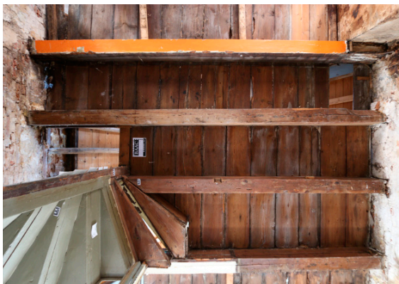
Afb. 13 Mandemakersteeg 1 (1650), ongeschilderde enkelvoudige grenenhouten balklaag met grenenhouten vloerdelen boven tweede verdieping. (BAAC, M. van Dam)
