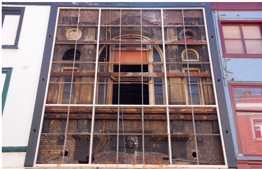
Afb. 22 De voorgevel zoals deze op 14 maart tevoorschijn is gekomen na verwijdering van het glas uit de vliesgevel. (foto P.J. Bosman, maart 2016)
