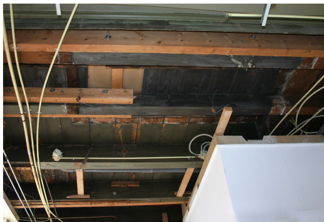
Afb. 11 Apotheekersdijk 37 (17de eeuw), rechts ongeschilderde grenenhouten balklaag op de overloop van de eerste verdieping. (ELO, E.D. Orsel)
