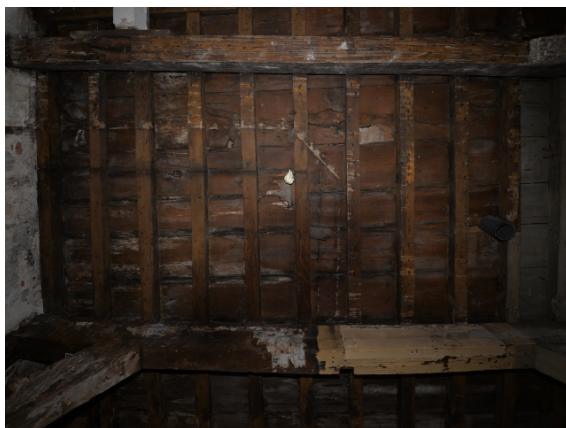
Afb. 5 Aalmarkt 13, (1585-1601 a.), ongeschilderde eikenhouten samengestelde balklaag met houtskelet en ongeschilderde naaldhouten vloerdelen op de tweede verdieping. (ELO, P.J. De Vos)
