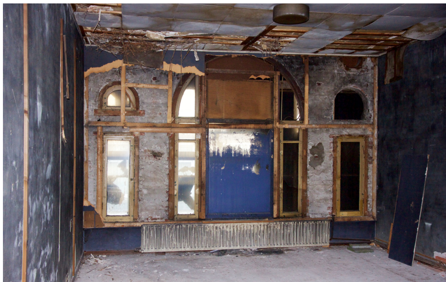
Afb. 8 Voorgevel op de eerste verdieping. De gehele gevel werd in 1957 ook aan de binnenzijde weggewerkt, op het grote schuifraam na. Na de brand in 1980 is er niets meer gewijzigd. (foto P.J. Bosman, december 2015)
