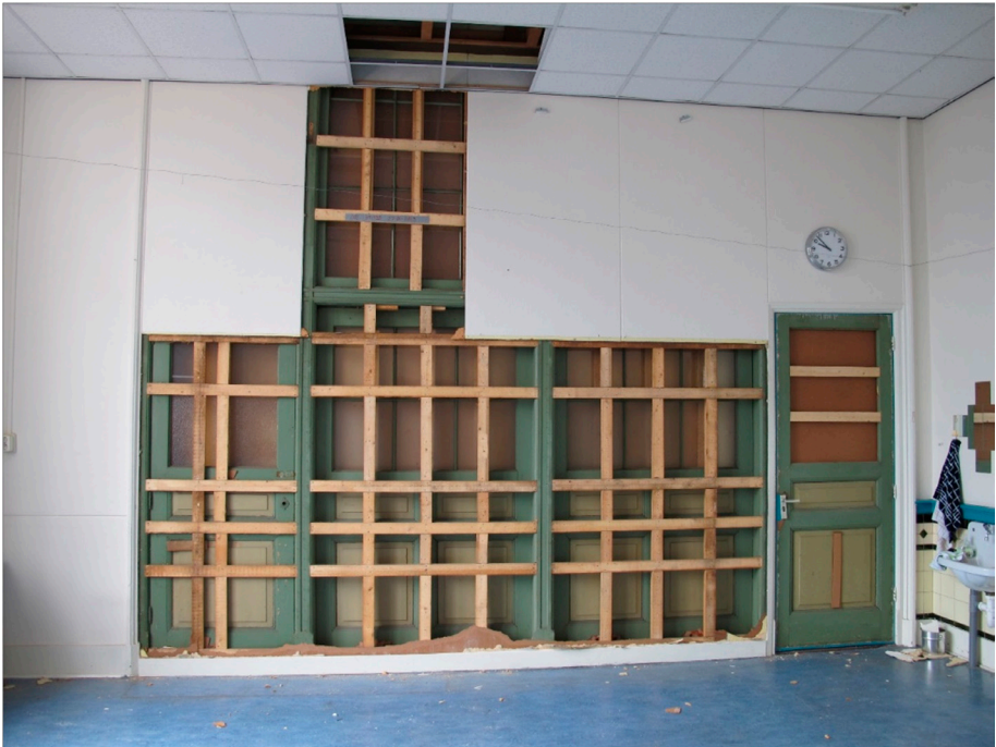
De ontdekking van de oorspronkelijke scheidingswanden.
