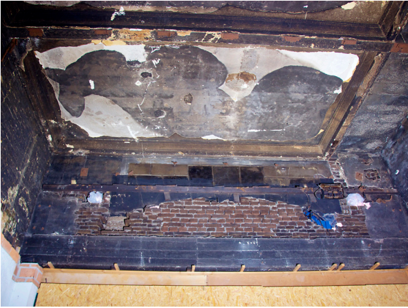
Afb. 11 Vloerconstructie na verwijdering van het systeemplafond gezien richting de voorgevel. (foto P.J. Bosman, december 2016)
