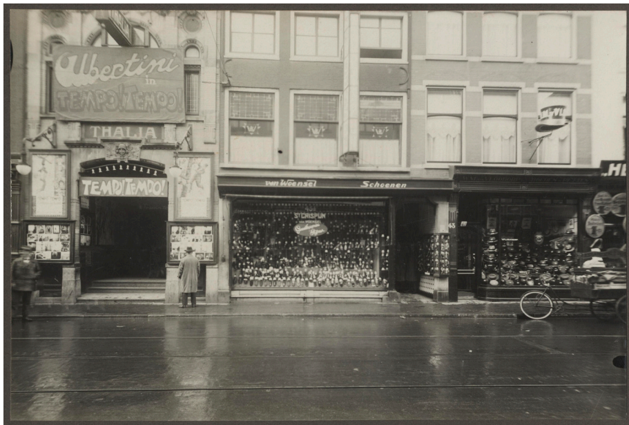
Afb. 25 Foto van Boekhorststraat 47, 45 en 43 rond 1930. Afkomstig uit het archief van bouw- en woningtoezicht, vermoedelijk genomen vanwege de zonder vergunning aangebrachte reclame. De bolvormige glaskappen in de ronde openingen zijn reeds verwijderd. (herkomst Haags Gemeentearchief)
