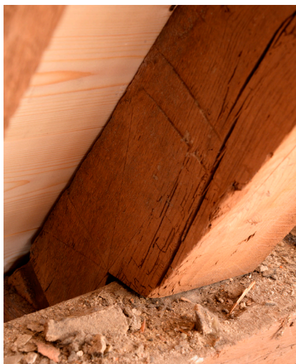
Afb. 2 Ingekraste uitzetlijnen op een spantbeen van Aalmarkt 11 (1455-1456 d.). Tevens zichtbaar gehaald telmerk II en een doorgezaagd vlotgat. (foto P.J. De Vos, ELO)
