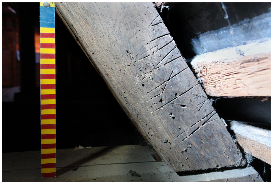
Afb. 4 Breitenfelde, merktekens in de kapconstructie van de kerk uit 1878, naar ontwerp van C.A.W. Lohmeyer. (foto Bernd Adam)
