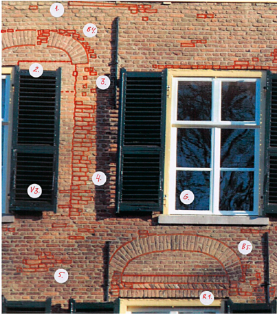
Afb. 1 Bouwsporen in de westgevel. Boven het kozijn zijn twee rollagen met daartussen een stroomlaag.
