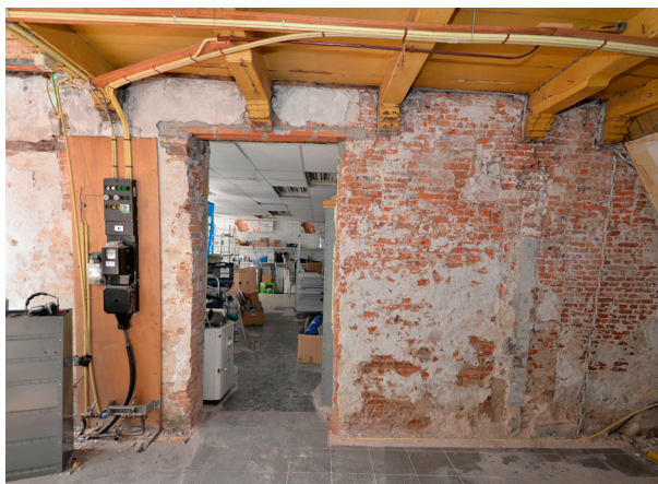
Afb. 5 Overzicht voorhuis linker bouwmuur begane grond. (foto auteur)
