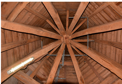
Afb. 22: Onderaanzicht van de draagconstructie van de makelaar. (foto en tekening auteur)
