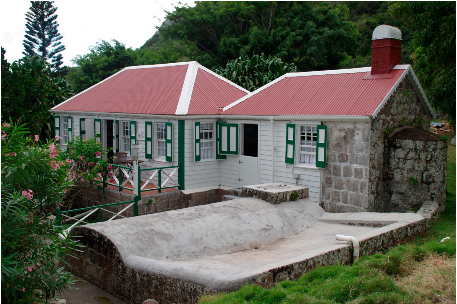
Afb. 16: Het Saba-museum, Park Lane Street, Windwardside op Saba met op de voorgrond de cisterne met dek voor de extra opvang van water. (foto auteur 2014)
