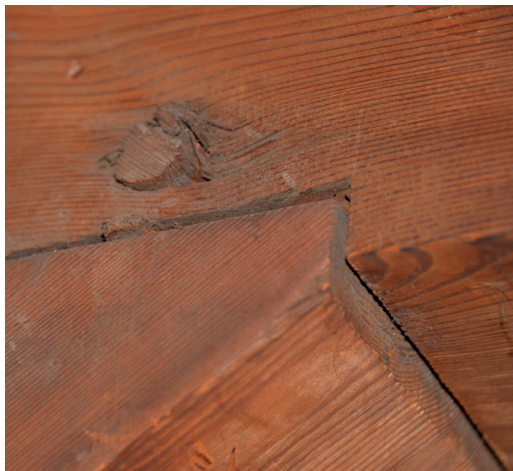
Afb. 5: Wigje in aansluiting verbinding van Breestraat 49 van omstreeks 1750. (foto ELO, Edwin Orsel)
