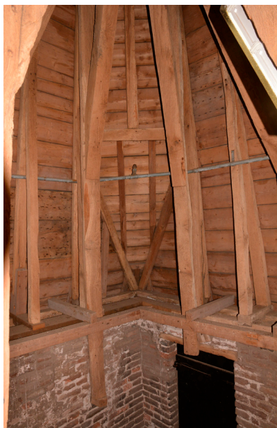
Afb. 23: Overzicht van de dakvoet met de hoekkepers, stijlen, korbeels, sporen en muurplaten. (foto auteur)
