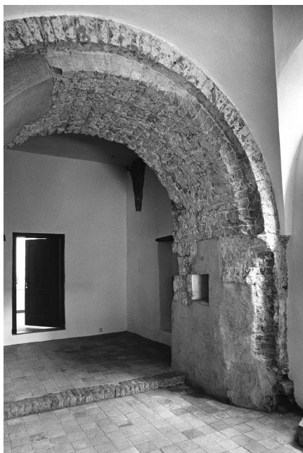
Afb. 3: Hal van Sandrasteeg 8 met de tijdens de restauratie in 1992 gevonden en destijds in het zicht gelaten boog. (foto SAB Deventer)
