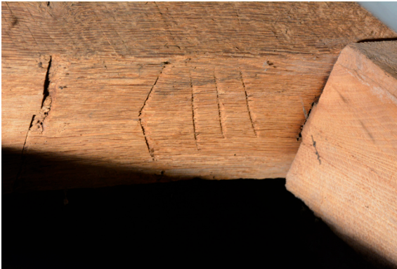
Afb. 15: Telmerk op het meest oostelijke halfspant in de noordzijde van de koorsluiting. (foto auteur)
