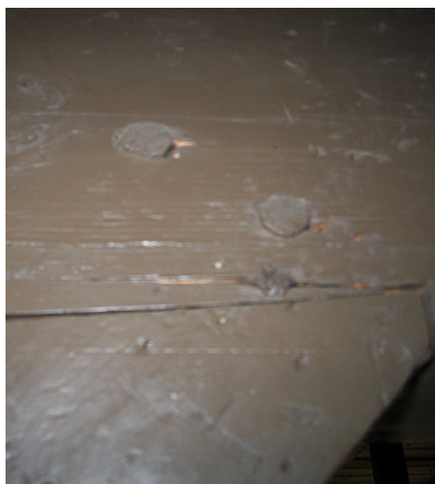
Afb. 3: Wigje onder een houten nagel in de dekbalk van Breestraat 19 uit 1791. (foto ELO, Edwin Orsel)
