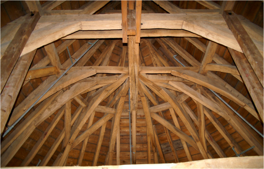
Afb. 16: Beeld van de hoekkeperconstructie in de koorsluiting boven de halfspanten. Op de voorgrond is het bovenste juk van spant 4 te zien. (foto auteur)
