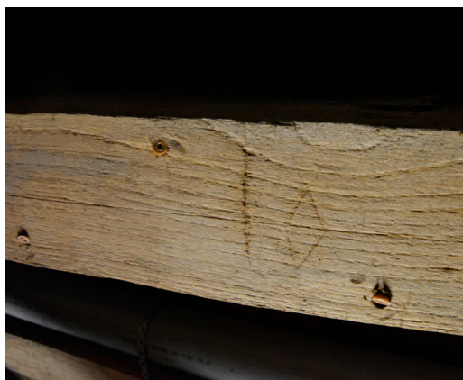
Afb. 3: De gesneden telmerken zijn aan de noord-zijde voorzien van een 'visje' als richtingsteken, zoals hier op spant 1. (foto auteur)
