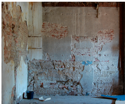
Afb. 14: Stromarkt 19: strek boven de genoemde doorgang naar Sandrasteeg vlak boven de verdiepingsvloer. (foto W. Bloemink)
