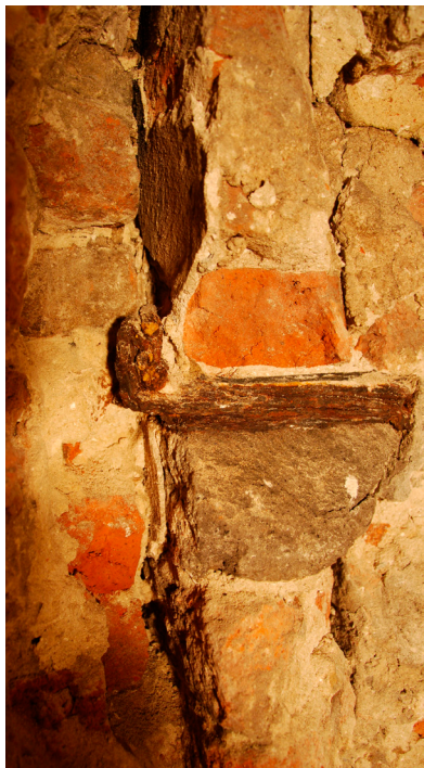
Afb. 12: Duimblok met duim en gehengrest in voormalige traptoren. Na de stadsbrand van 1334 is deze doorgang in gebruik gebleven en is de dagkant met baksteen hersteld. (foto Wijnand Bloemink)
