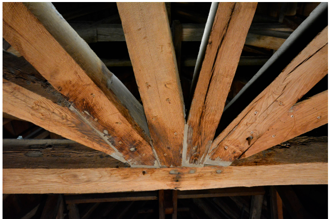
Afb. 14: Detail van de aansluiting van de dekbalken van de halve spanten op de dekbalk van spant 4. (foto auteur)
