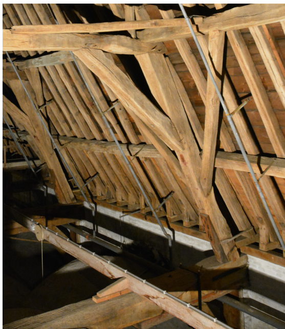
Afb. 9: Detail van het schipdak met de kleine standzoontjes en de extra gording achter de spantbenen. (foto auteur)
