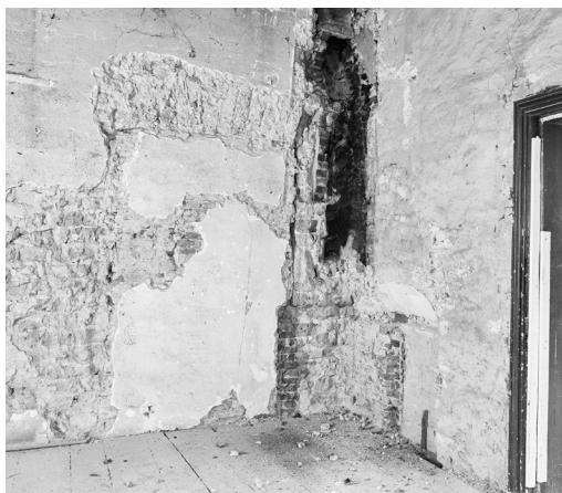
Afb. 13: Sandrasteeg 8: dichtgemetselde doorgang op de verdieping. (foto RCE)
