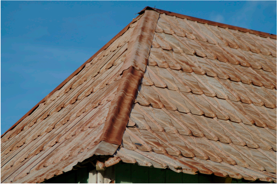
Afb. 21: Detail van een relatief moderne golfplaat, gestanst in de vorm van een dakpan, op een klein woonhuis in Scharloo, Willemstad op Curaçao. (foto auteur 2014)
