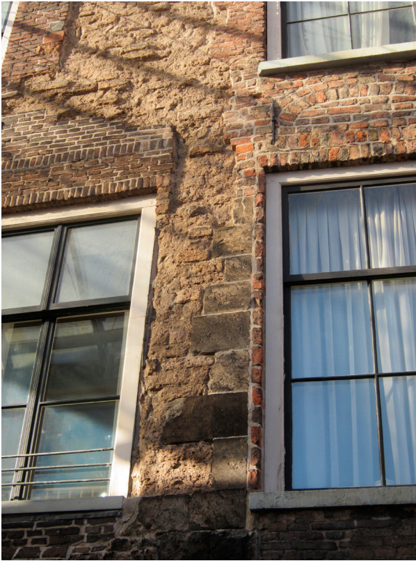
Afb. 8: Zorgvuldige aansluitingen van tufsteenmuurwerk en trachiet hoekblokken boven de verjonging. (foto auteur)
