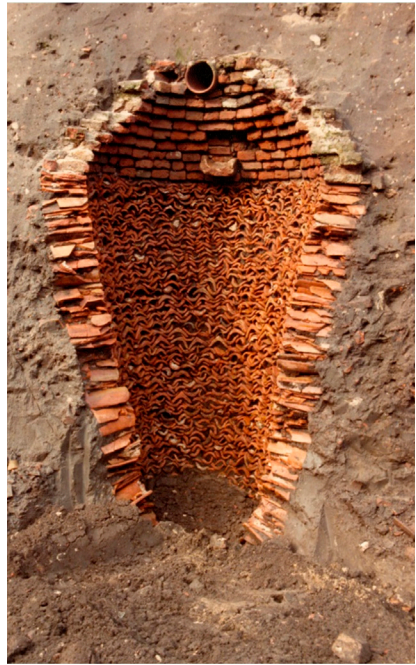
Doorsnede van een zogenaamde dakpan-put, gevonden in Deventer.
