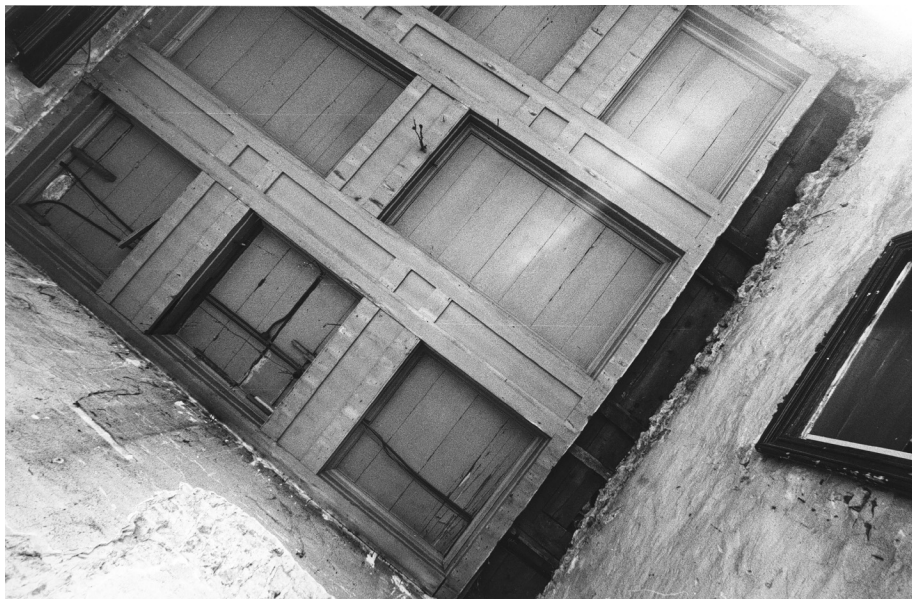
Afb. 17: Het cassettenplafond op de eerste verdieping boven de hal van Sandrasteeg 8; rechts de omtimmerde balkjes nog in het zicht en links op de muur de moet van een korbbeelstel. (foto SAB Deventer)
