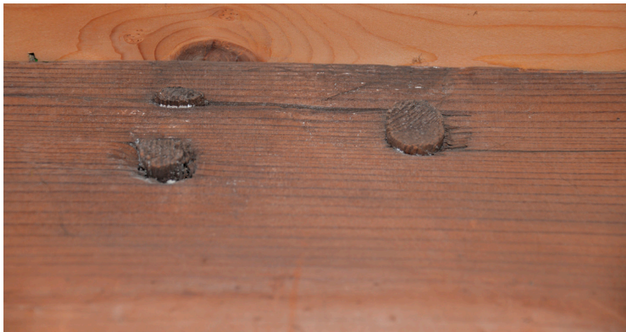
Afb. 4: Wigje bij een houten nagel in de dekbalk van Breestraat 49 van omstreeks 1750. (foto ELO, Edwin Orsel)
