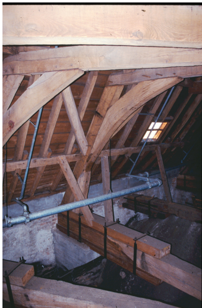
Afb. 7: Dia uit 2003 van de 'tussenfliering' die gepend was in de spantbenen van de onderste jukken. In 2004 zijn ze vervangen door 'tussengordingen'. (dia auteur)
