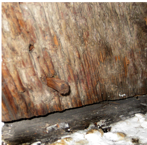
Afb. 2: Pennetje in het spantbeen van Stille Mare 4 uit 1830. (foto ELO, Edwin Orsel)
