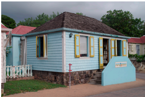
Afb. 15: De op een stenen basement staande voormalige Rumshop, Van Tonningeweg, Oranjestad op Sint Eustatius. (foto auteur 2014)
