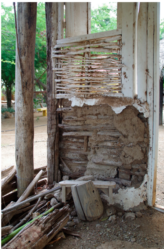
Afb. 20: Detail van een wandvulling, aan de bovenzijde gemaakt van gevlochten kalebastakken en onderaan van de houtige kern van de kadushi (zuilcactus). Reconstructie in de kruidentuin van Dinah Veeris te Curaçao. (foto auteur 2014)
