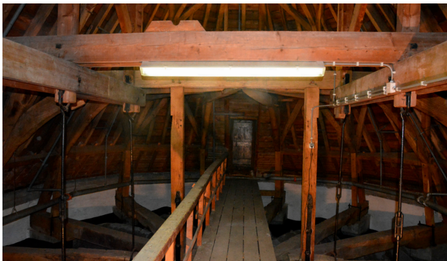
Afb. 12: Detail van spant 4, waar alleen de stijlen zijn overgebleven van de oorspronkelijke versterkingsconstructie, met de kepen en pengaten van de verdwenen schoren. Zichtbaar is de hulpconstructie met dubbele platen en ijzeren ankers uit 1939. (foto auteur)
