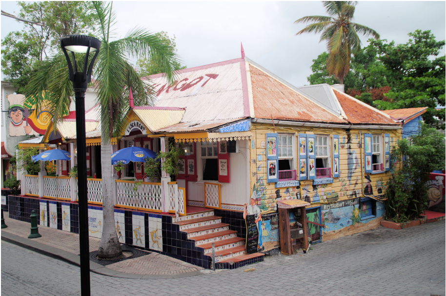
Afb. 14: Extérieur van het restaurant l'Escargot op Sint-Maarten. De veranda heeft een daklijst versierd met gingerbread . (foto auteur 2014)
