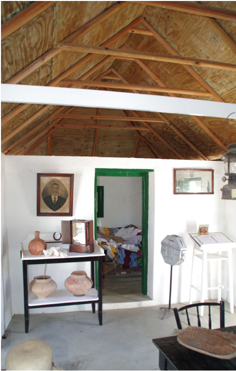
Afb. 8: Interieur van het cas di palu di maishi , Dokterstun te Curaçao bestaande uit twee kamers met daartussen een niet tot in de nok doorlopende muur. (foto auteur 2014)
