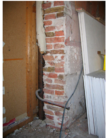
Afb. 7. Detail zijgevel Hoogstraat 3 met twee eikenhouten regels: 1486 ± 6 jr. en 1504 of kort daarna (d.). (foto ELO, E.D. Orsel)
