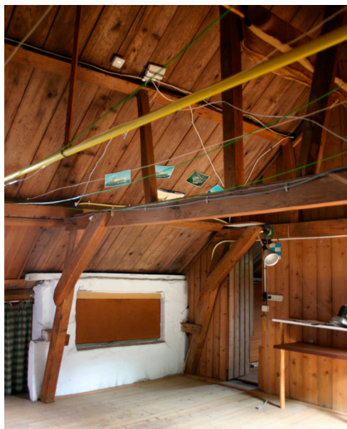
Afb. 07 Opname van één van de kapspanen boven het woonhuis. (M. van Dam, BAAC bv)
