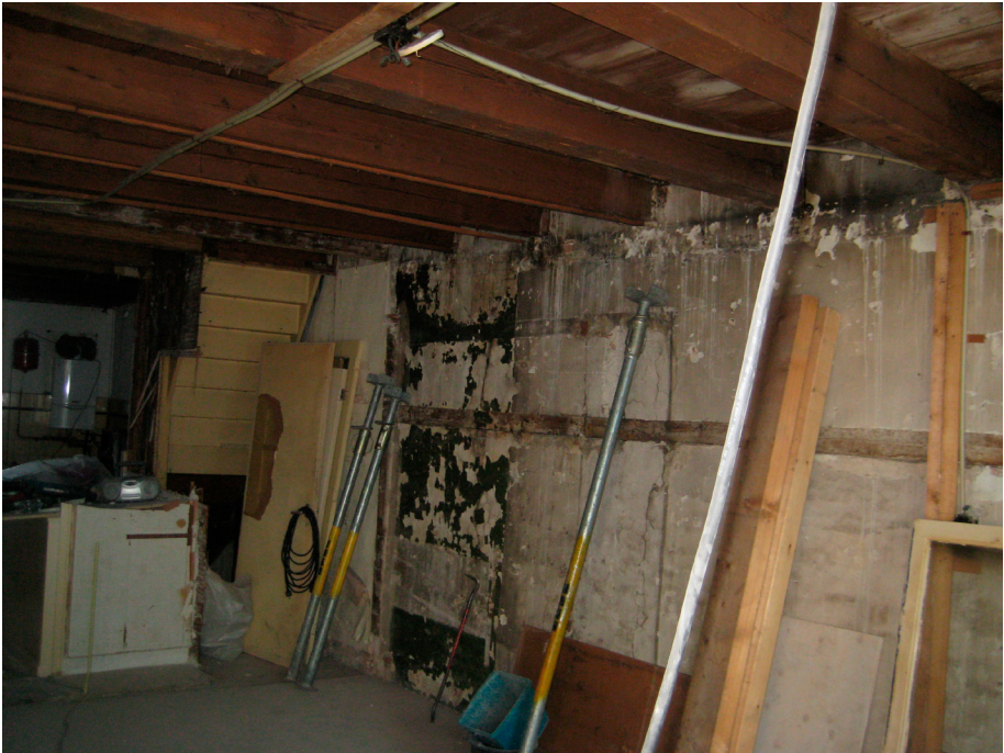
Afb. 2. Zijgevel van Lange Mare 94 met daarin de muurplaat van de lagere voorganger. (foto ELO, E.D. Orsel)
