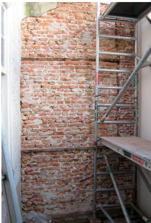
Afb. 4. Detail voormalige binnenzijde achtergevel van Donkersteeg 19 uit de tweede helft van de 14de eeuw, met daarin twee wandregels. (foto ELO, E.D. Orsel)
