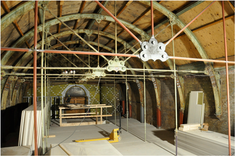
Afb. 4. Overzichtsfoto na renovatie. De onderste trekstaven werden bij de renovatie opgehoogd. (P.J. De Vos, dec. 2013)
