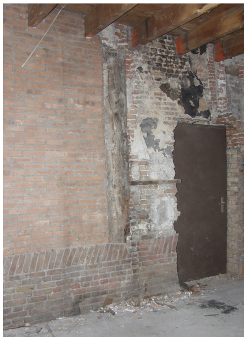
Afb. 3. Detail zijgevel van Breestraat 86 met daarin een muurstijl (1376 ± 8 jr. (d.) en een eikenhouten regel. (foto ELO, E.D. Orsel)
