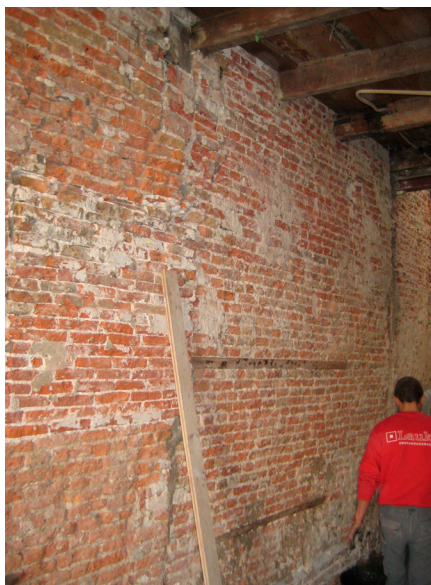
Afb. 5. Detail zijgevel van Vliet 29 van rond 1400, met daarin twee wandregels. (foto ELO, E.D. Orsel)
