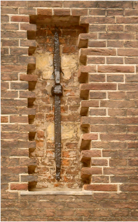
De 16de-eeuwse muur van het Schiedamse stadhuis is plaatselijk zichtbaar gemaakt via enkele 'kijkgaten' in het jongere metselwerk. (foto J.A. Nipius)
