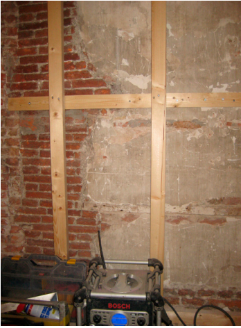
Afb. 6. Detail achtergevel van Breesstraat 117 uit 1429 (d.) met dichtgezette muurstijlsleuf en een houten regel. (foto ELO, E.D. Orsel)
