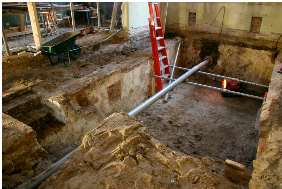
Afb. 2. Opname van het aangetroffen kelder restant. Opname vanaf de linker zijmuur in de richting van de voorgevel. (foto M. van Dam, BAAC bv)
