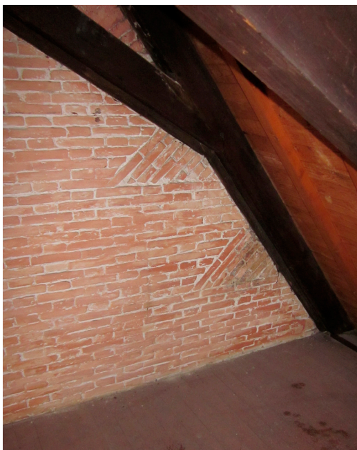
Afb. 2. Vlaams verband in de zijmuur van het pand Kerkstraat 183 te Amsterdam. (foto G. van Tussenbroek)
