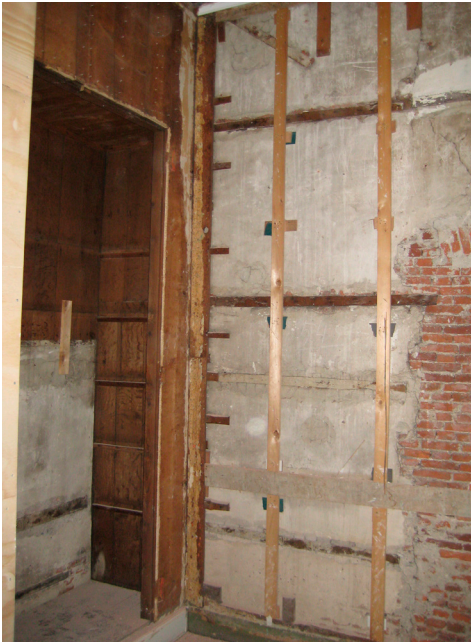
Afb. 8. Detail muurwerk Rapenburg 67 uit de eerste helft van de 16de eeuw. Zichtbaar zijn houten regels en wagenschot wandbetimmering. (foto ELO, E.D. Orsel)
