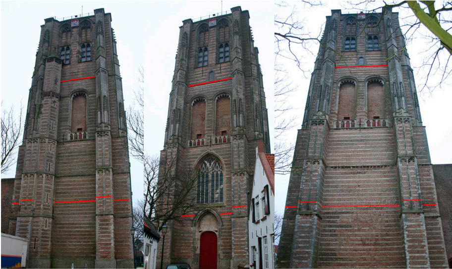
Afb. 2. De zwarte lijnen geven de overgang aan van een wisselend aantal lagen metselwerk tussen de natuurstenen spekbanden. (foto's Maarten Enderman)
