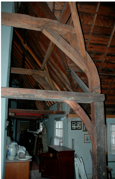
Afb. 4: Een kapspant van vroegmodern eikenhout op een 'onderslag' van secundair verwerkt 18de- en 19de-eeuws hout, Droogzolder zuidvleugel. (foto auteur, 2009)
