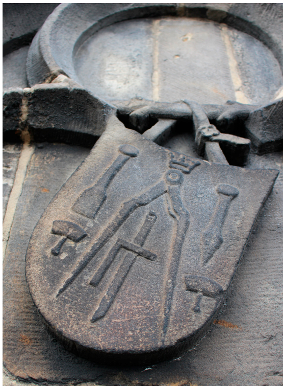
Een wapenschildje uit 1495 met gereedschappen van de steenhouders, op één der bekronende gevels van de torenlantaarn van de Nieuwe Kerk te Delft. (foto D.J. de Vries)
