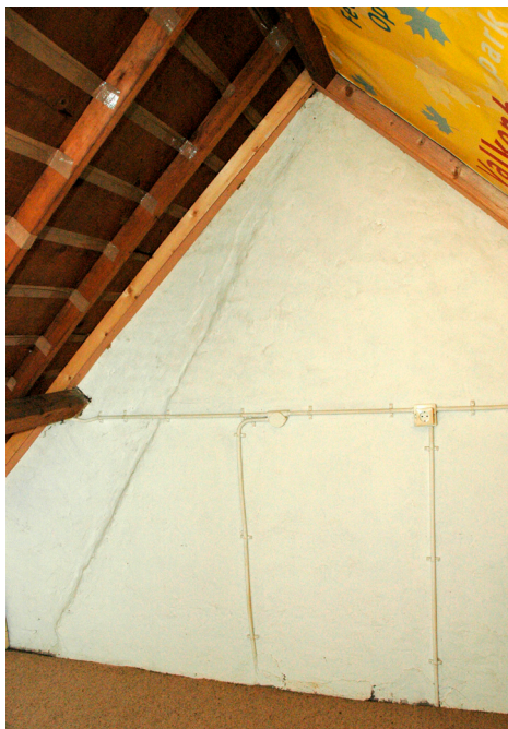
Afb. 9: De 16de-eeuwse daken waren steiler dan de huidige, ongeveer 60 graden tegen ongeveer 45 graden. (foto auteur, 2013)
