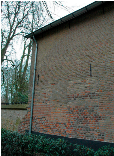
Afb. 8: Muurwerk aan de parkzijde, op de noordwesthoek van het Begijnhof. Het metselwerk in koppen oftewel patijs verband is uitgevoerd met stenen uit de middeleeuwse stadsmuur, vermoedelijk halverwege de 19de eeuw. (foto auteur, 2014)
