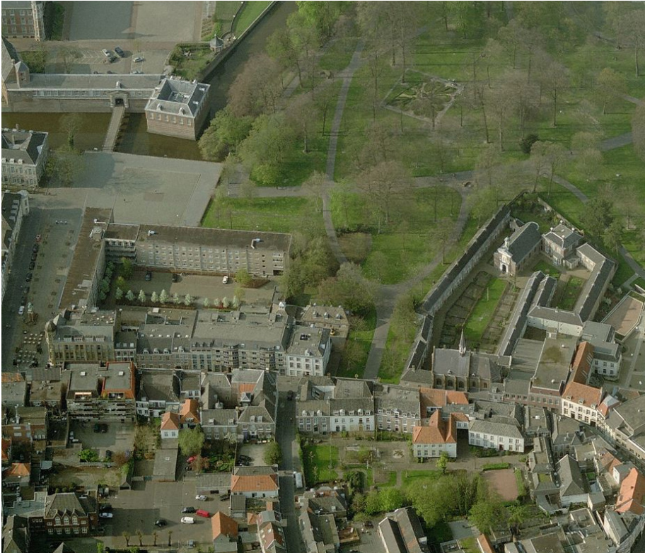
Afb. 1: Luchtfoto van het Begijnhof en het park Valkenberg tot aan het kasteel, vanuit het zuiden. Het middeleeuwse Begijnhof lag bij het stenen plein en het vierkante Blokhuis. (foto Bing Maps, 2010)
