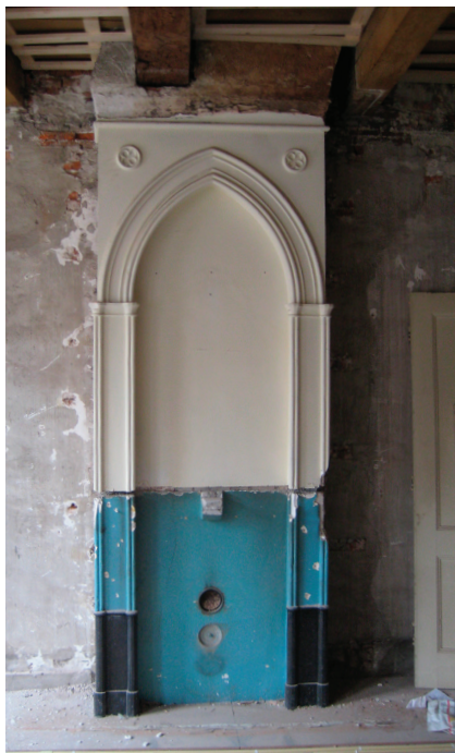
Afb.2 Kachelnis na ontmanteling (foto E.D. Orsel)
