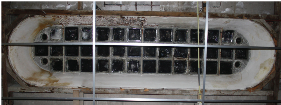
Alle zestien oorspronkelijke daklichten van prismaglas in beton zijn nog aanwezig. (foto C. Weijs)
