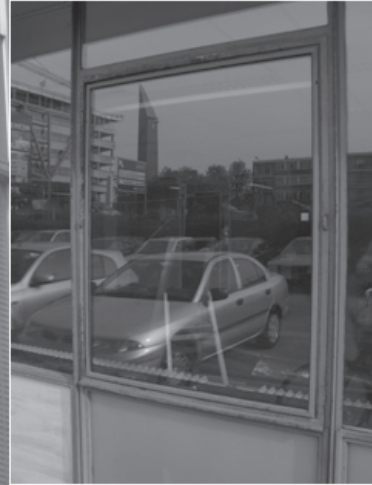
Details vliesgevel GAK gebouw Amsterdam. (foto BMA Amsterdam)
