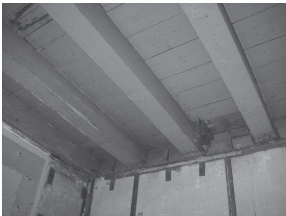
Afb. 2 Enkelvoudige balklaag van Breestraat 117 uit 1762. (foto E.D. Orsel)
