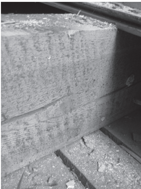
Afb. 1a en b Enkelvoudige platen-balklaag van Breestraat 117 uit 1777. (foto E.D. Orsel)
