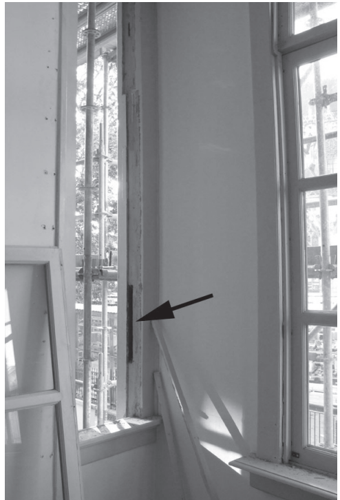
Afb. 2 – Venster in de voorgevel van Hinthamerstraat 74, waarin aangegeven de opening voor het stopstuk. (foto BAM)
