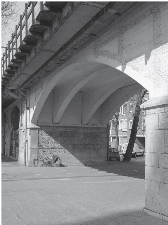
Boog in het Hofpleinviaduct te Rotterdam uit 1905-1906. (foto R. Stenvert 2009)
