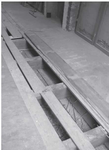
Afb. 1a en b Enkelvoudige platen-balklaag van Breestraat 117 uit 1777. (foto E.D. Orsel)
