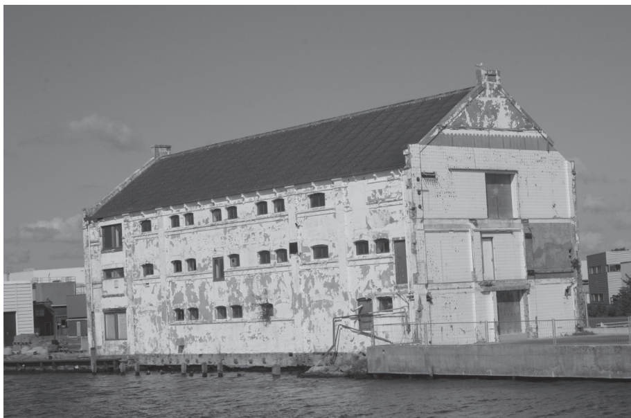
Het pakhuis Wormerveer in deplorabele staat. De huidige eigenaar vecht de monumentenstatus aan. (foto J. Kingma, 2008)
