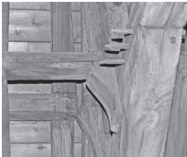
Detail van de kap van de St. Joriskerk boven het middenschip, de koude aansluiting en de ondersteuning met klossen van de flieringen. (foto K. Emmens)
