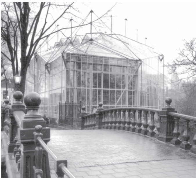
De drieklimatenkas in de Hortus Botanicus van Amsterdam. Een goede conservering van het ijzerwerk (thermisch verzinken) zoals bij deze vochtige, warme kas is een voorwaarde voor duurzaam gebruik. (foto G.J. Dukker 2001, collectie RCE)
