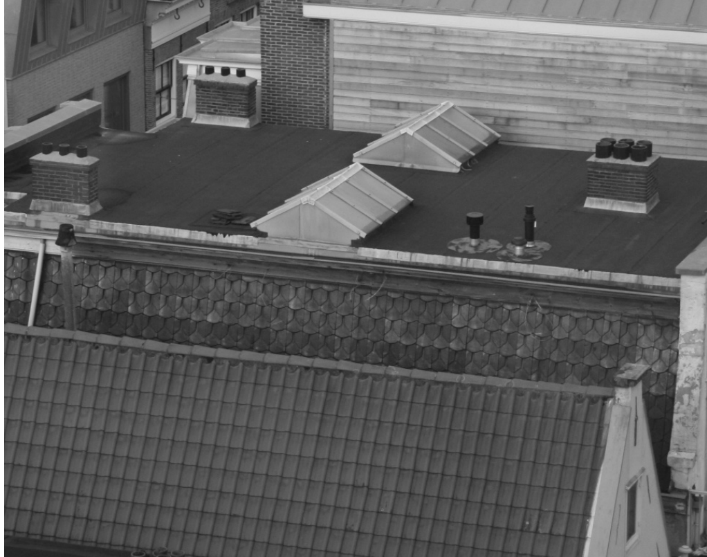
Amsterdam, Nieuwendijk. Dakvlak gedekt met Lucas IJsbrandszpannen. (foto Bureau Monumenten & Archeologie/ Michel van Dam)
