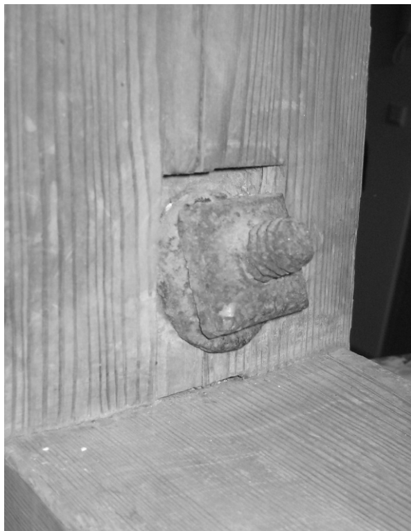
De moerbout in de kapconstructie van Rapenburg 65 (1749). (foto E.D. Orsel, M&A)
