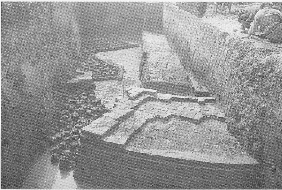
Detail van de opgegraven fundering met baksteen op slieten in Aduard. (foto collectie A. Reinstra)
