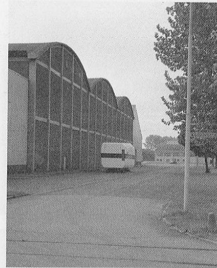
afb. 2 - Stroloods voor de AKU te Arnhem uit 1941. (foto R. Stenvert 2009)
