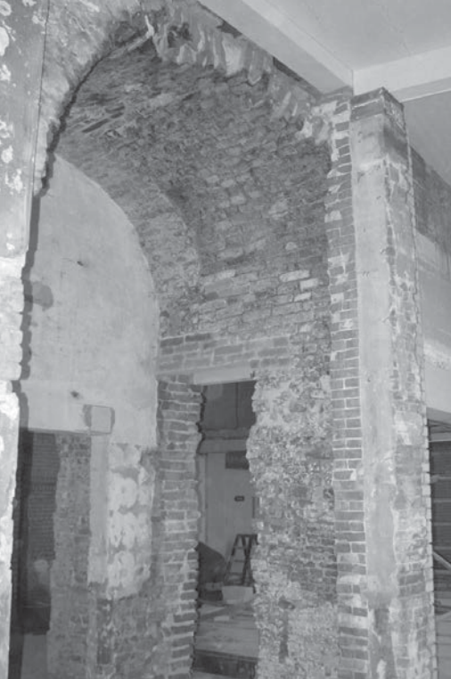
De in 2009 teruggevonden weergangsboog van de stadsmuur in het pand Riche te Arnhem. (foto F. Haans)
