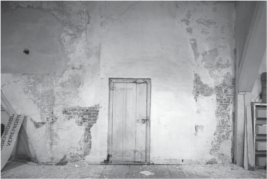
Op de zolder van het koor tekent de spitsboog van het voormalige kapelvenster zich duidelijk af in de muurafwerking. De deur dateert uit 1754, rechts daarvan een afgehakte, natuurstenen console vanwaar de gewelven ontsproten. (foto G. Oldenmenger)
