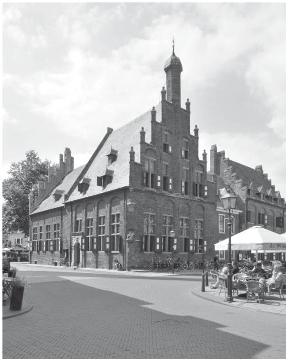
Het stadhuis op de hoek van de Koepoortstraat en de Roggestraat. Aan de voorzijde het Schepenhuis en aan de achterzijde het Wijnhuis. (foto P. Boer)
