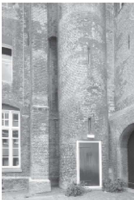
Het onderste deel van de traptoren sluit aan op een dichtgezette vensteropening. (foto G. Oldenmenger)
