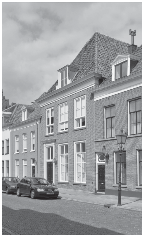
Voorgevel van Koepoortstraat 20. (foto P. Boer)
