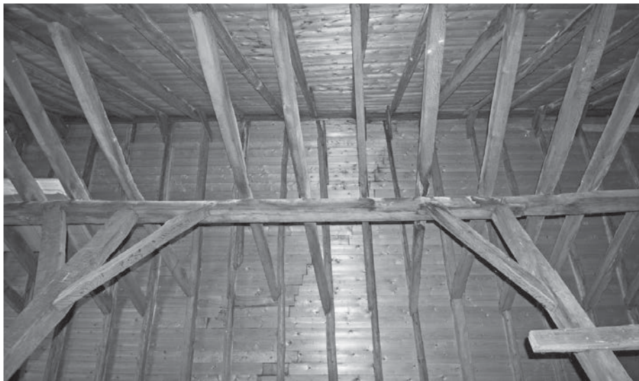
Het bovenste deel van de daksporen van de kapconstructie van het voorhuis van Koeportstraat 20. Opvallend is de geringe doorsnede van de rondhouten daksporen. (foto P. Boer)
