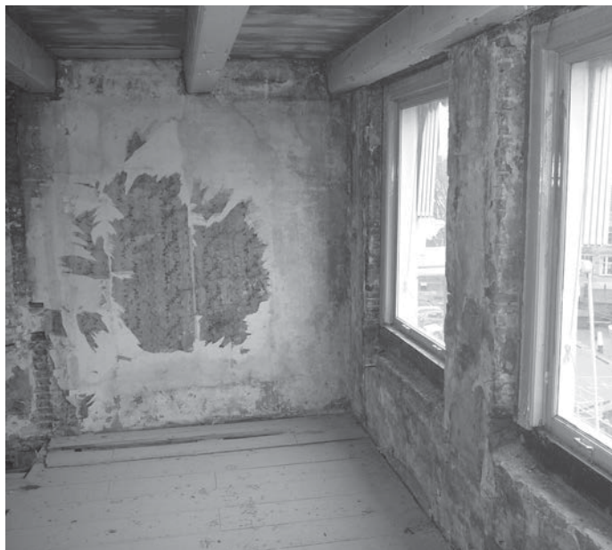
Een deel van het behang zoals het werd aangetroffen. Het papier is direct op de gestucte muur bevestigd. (foto J.A. Nipius)
