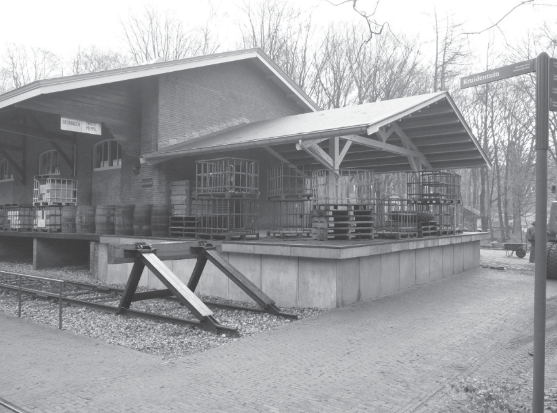
fig. 2 - Van Gend & Loos loods in Arnhem na verplaatsing, gezien vanaf de spoorzijde. (foto M. de Visser)
