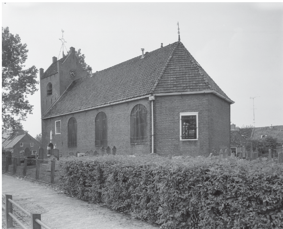
De kerk te Engwierum (Frl) met beschermende en zonwerende luiken opgebouwd uit scherm-latten. (foto Rijksdienst voor het Cultureel Erfgoed)
