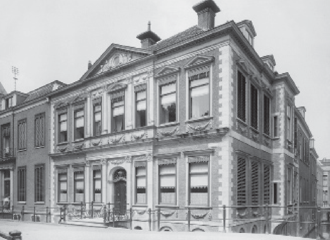
Janskerkhof 13 te Utrecht omstreeks 1900. Verschillende vormen van zonwering verwerkt in een gebouw. Persiënnes (rechts), jaloezieën boven de vensters, rolgordijnen binnen, lage gordijnen, gewone gordijnen en vouwblinden. (foto Rijksdienst voor het Cultureel Erfgoed)
