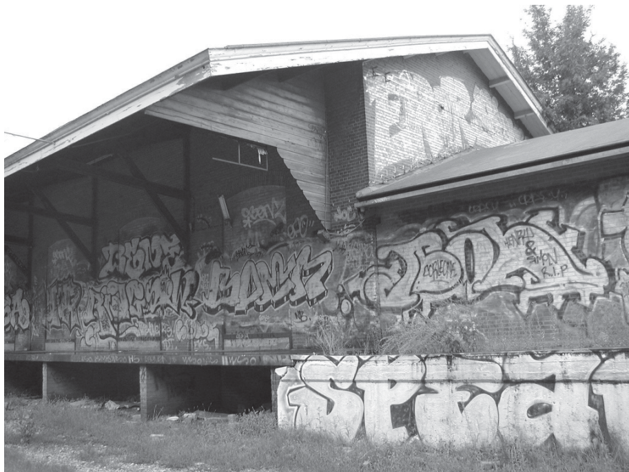
fig. 1 - Van Gend & Loos loods in Tiel, gezien vanaf de spoorzijde. (foto M. de Visser)
