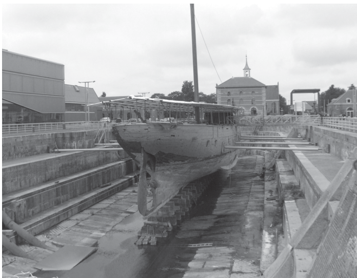
Rijkswerf Willemsoord droogdok met drooggelegd schip en pomphuis en ophaalbrug op de achtergrond. (foto C. van Emstede)
