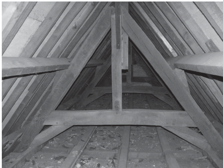
De kapconstructie van de refter. (foto B. Dukers)
