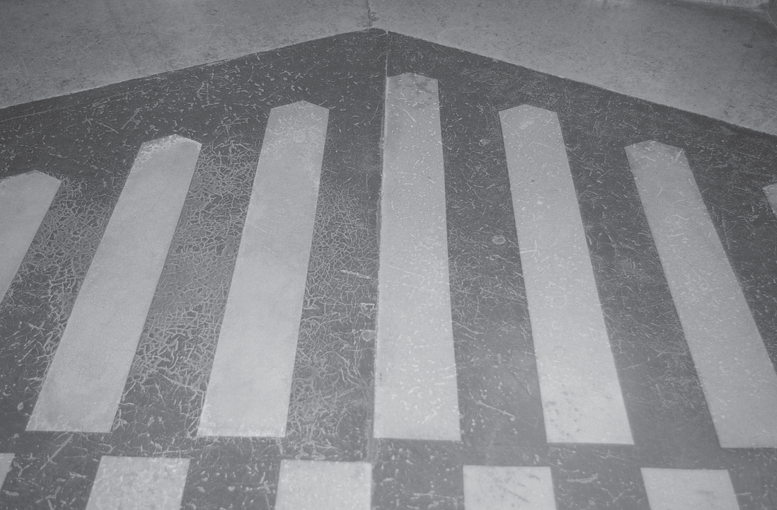
Detail van linoleum met een inlay van witte stroken, in het trapportaal van het Amsterdamse Scheepvaarthuis uit 1913-1916. (foto R. Stenvert)
