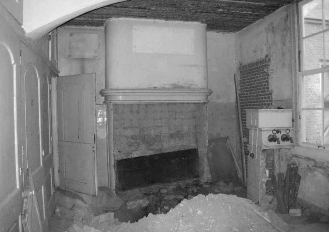
De keuken van het pand Oude Delft 73 in zijn huidige toestand. Let op de pomp met de fraaie kranen rechts. (foto M.E. Stades-Vischer)
