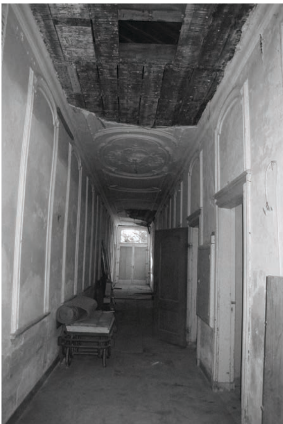
De lange gang van het pand Oude Delft 73. Het stucplafond zal worden gerestaureerd. (foto M.E. Stades-Vischer)
