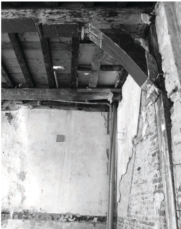
Draagconstructie op de verdieping: korbeelstel (t.p.v. de achtergevel) met muurstijl, peerkraalsleutelstuk en korbeel. (foto I. Dekker)
