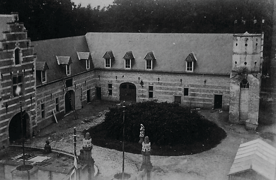
Heeswijk, circa 1895. Fazantenhoek (rechts) met dak van zinken of verzinkte golfplaten op de Benedenplaats van Kasteel Heeswijk. Afgebroken rond 1939 bij de aanleg van de Copijntuin. (foto auteur)
