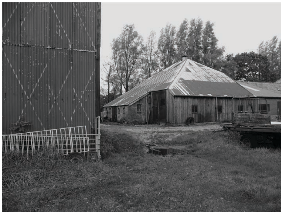
Noordbergum, 2008. Blikkene pleats: achterste deel van gelede Friese boerderij, gebouwd in de crisistijd, rond 1930, met van oorsprong een dak van ijzeren golfplaten. Inmiddels vervangen. De jongere schuur links is onder meer samengesteld uit restanten van de oorspronkelijke golfplaten en uit deuren van een romneyloods van het militaire vliegveld Leeuwarden. (foto auteur)
