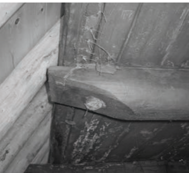
Afb. 6 - De hangconstructie met spiebout met verdikte kop in het vaste achterhuis van Steenschuur 14 uit 1618/1620 ± 6 (d). (foto E.D. Orsel)
