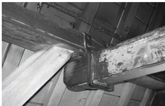
Afb. 4 - De hangconstructie met gesmede strop in het voorhuis van Hogewoerd 177, van direct na 1658. In de zijkant van de fliering is een groef aanwezig, behorend bij een vloer. (tekening E.D. Orsel)
