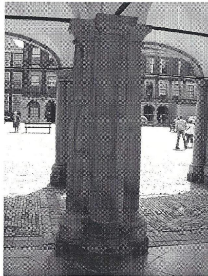
Zandstenen zuil op het Binnenhof, ‘gebruist’ met silicaatverf. (foto H. Tolboom)
