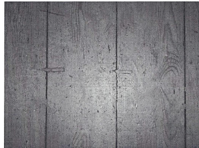
Grenenhouten vloerdelen met speciale deuwelconstructie. Tripenhuis Amsterdam, 1660 - 1662. (foto D.J. de Vries)
