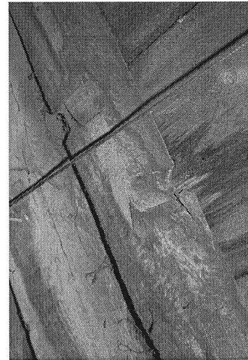
Afb. 8. Haaks op elkaar staande gaten in een balk, die na demontage van het vlot in vier delen is gezaagd. Voorbeeld uit de Schreierstoren (foto auteur).
