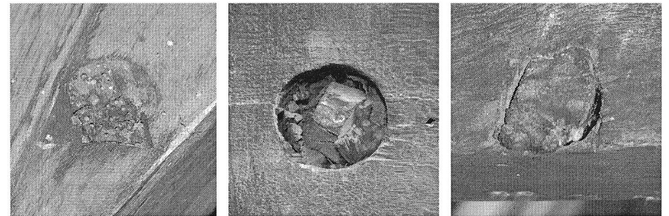
Afb. 9. a-b-c. Voorbeelden van zeventiende-eeuwse vlotverbindingen uit Kloveniersburgwal 95 en Oudezijds Achterburgwal 247 (foto auteur).
