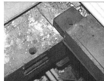
Afb.4. Detail van kinderbint van de samengestelde eikenhouten balklaag boven begane grond. (foto Enderman bureau voor bouwhistorie)
