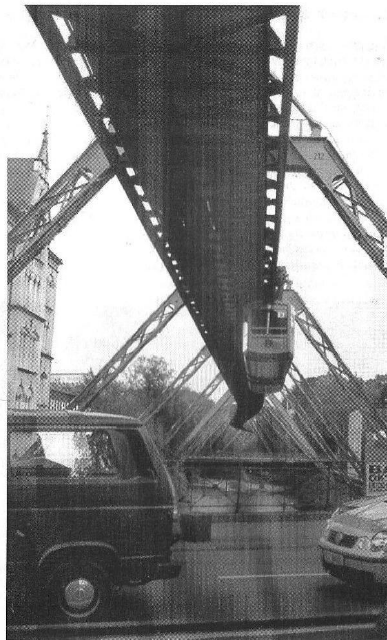
Wuppertal. De Schwebebahn uit 1900. (Foto D.J. de Vries)
