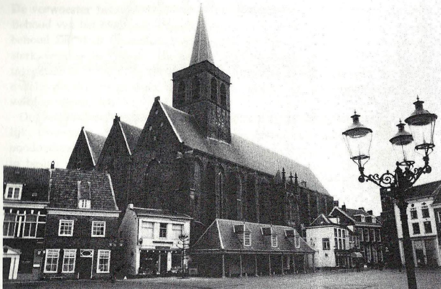
Afb. 2 Het exterieur van de kerk gezien vanuit het zuidwesten, op het plein de Hof. Duidelijk is te zien dat de toren in de zuidbeuk staat. Rechts van het grote portaal begint het hallenkoor (foto auteur).
