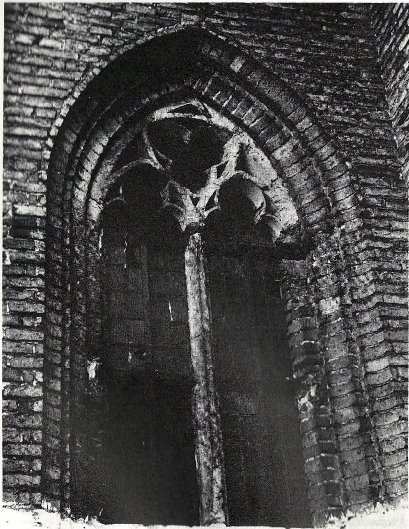
Afb. 6 Het venster met de oorspronkelijke tracering, dat zich bevindt in de ruimte tussen het hoofdkoor en de zuidkoorsluiting (Foto Bell, Amersfoort (1962), herkomst: archief Dekhuijzen).
