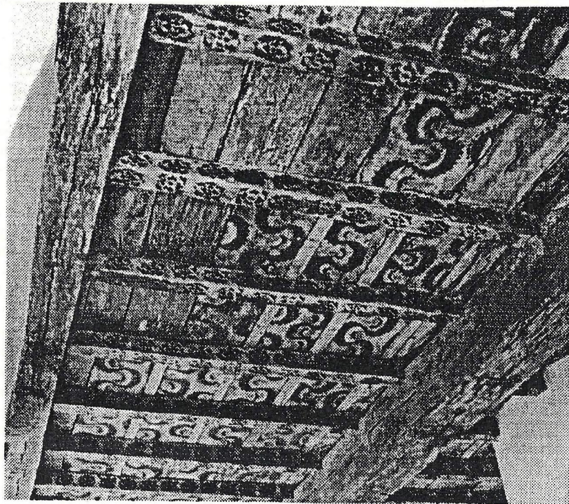
Afb. 4 Zoldering met moer- en kinderbalken plus schildering, eerste verdieping Brink 47 te Deventer, ca. 1500 (Uit: I.M. Breedveldt Boer, Plafonds in Nederland 1300-1800 ).
