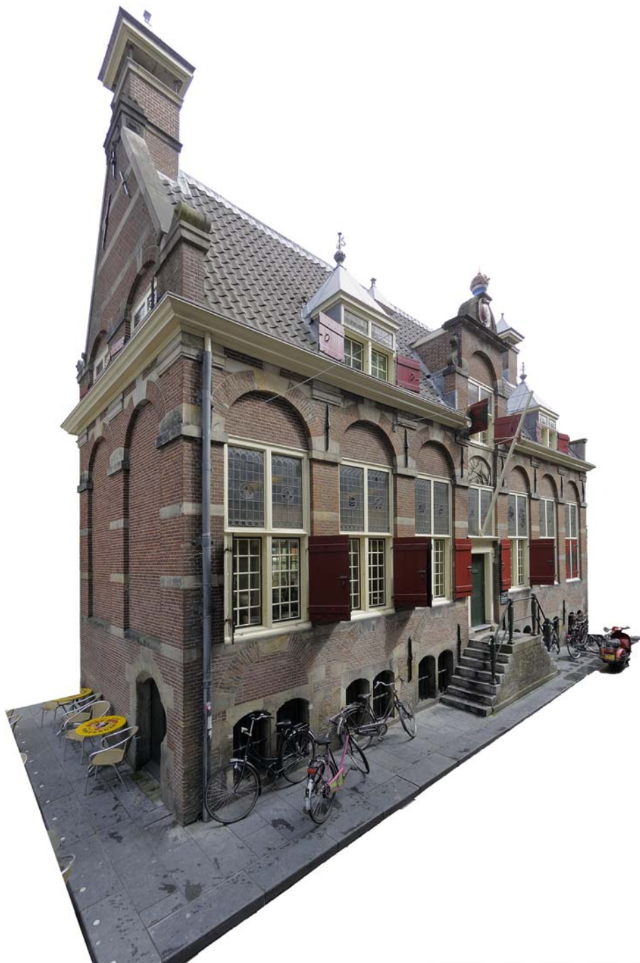
Nieuwezijds Kolk 28 (Korenmeetershuis) vanuit het zuidwesten.
