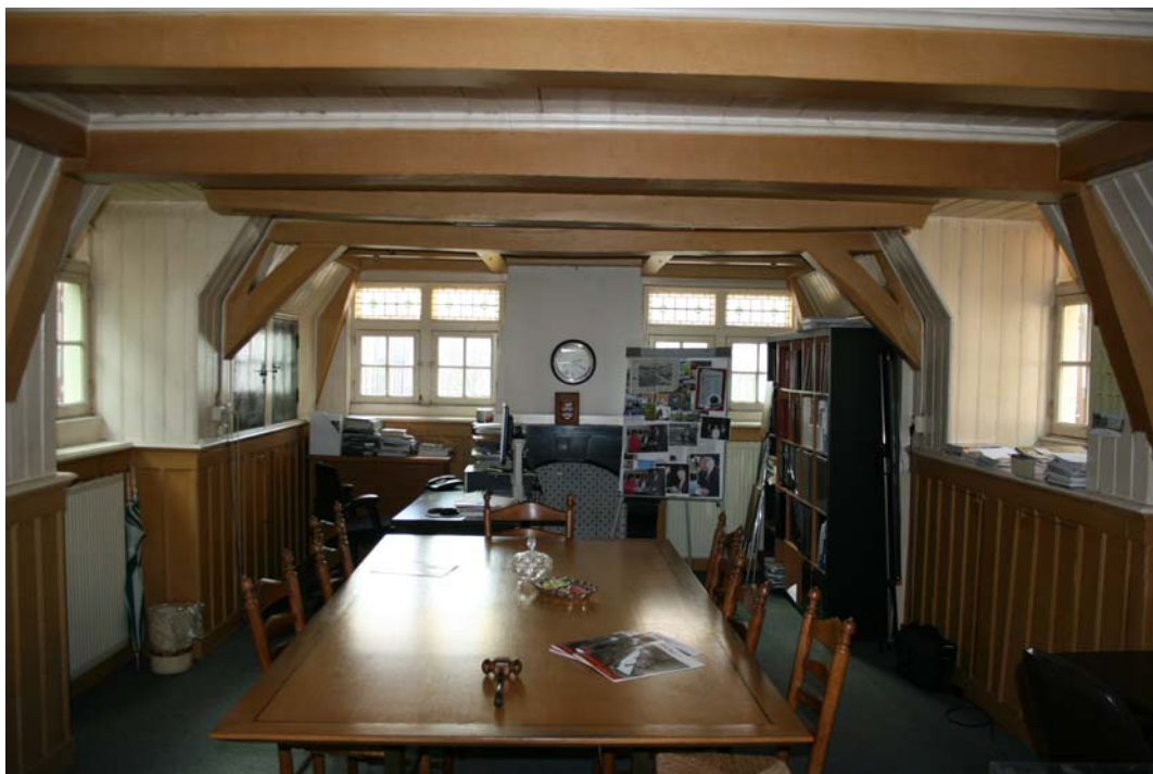
Ruimte 2.1, naar westen gezien.
