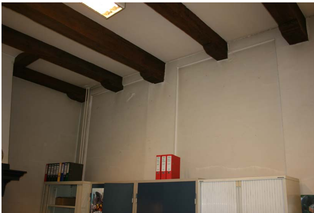
Ruimte 1.1. Alternerende balklaag met sleutelstukken, naar noorden gezien.
