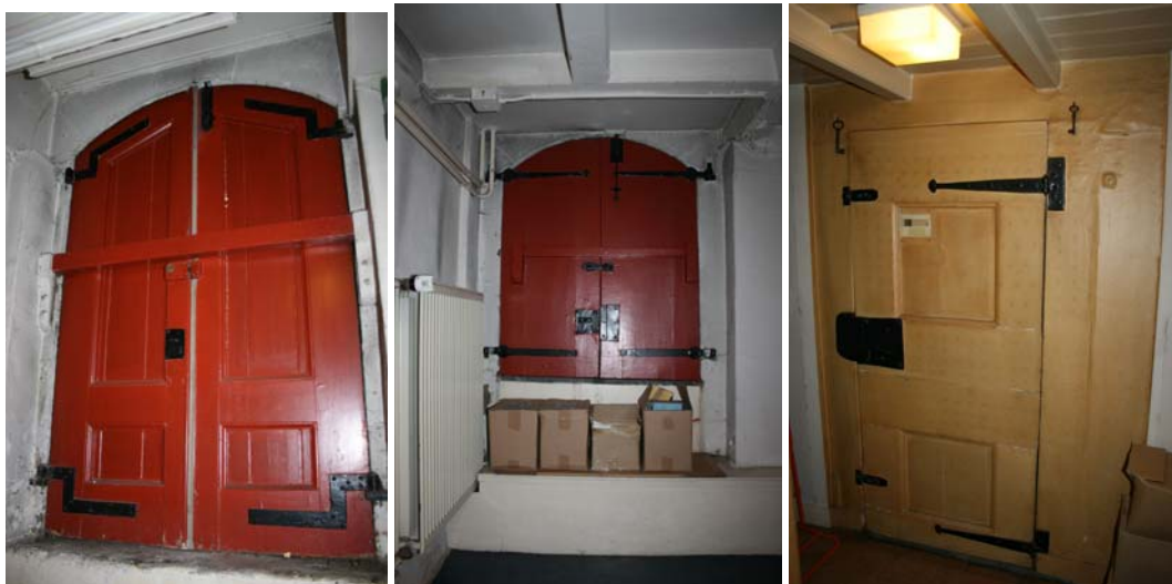
Deur in ruimte 0.1, westgevel; deur in ruimte 0.2, noordgevel en deur in ruimte 1.2, noordgevel.
