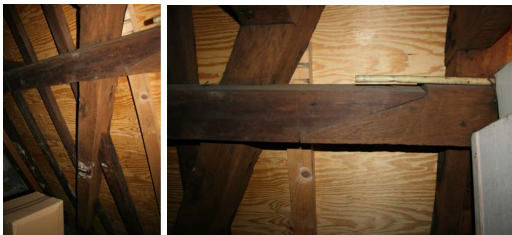
Niveau 3, westzijde noordelijk dakvlak. Restant van dakschild en liplas. Links grenenhout, rechts eikenhout.
