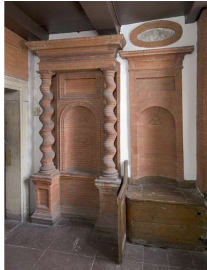
90. De ruimte naast de metselaarsgildekamer in de Waag op de Nieuwmarkt. Behalve geslepen baksteen voor de meesterproeven is er in de rijk gedecoreerde ruimten van het Metselaarsgilde wit marmer uit Carrara, zwart geaderd Portoromarmmer, lichte zandsteen uit Bentheim en rode kalksteen van het Zweedse eiland Öland te vinden.
