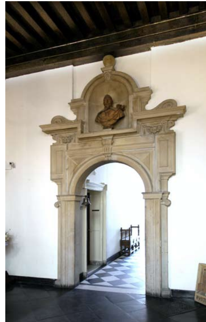
103. Keizersgracht 123, hardstenen vloer in het voorhuis. De poort naar achteren is gemaakt van Bentheimer zandsteen en voorzien van een buste van koning Gustav II Adolf van Zweden.
