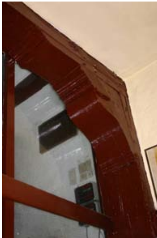
Warmoesstraat 42, zwanenhalskorbelen in het voorhuis (foto's BMA).
