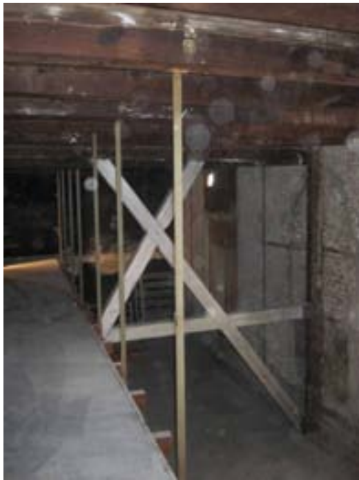
De steunconstructie in Reguliersdwarsstraat 42, achter het centrale veld aan de tuinzijde (foto David Derksen/ BMA).
