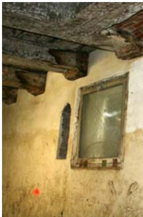
Kromme Waal 16; voorgevel en balklaag met consoles in het souterrain (foto's BMA).
