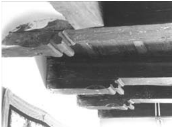
Het Houten Huys op het Begijnhof aan het begin van de twintigste eeuw en enkele sleutelstukken in het souterrain in 1994 (foto's BMA).
