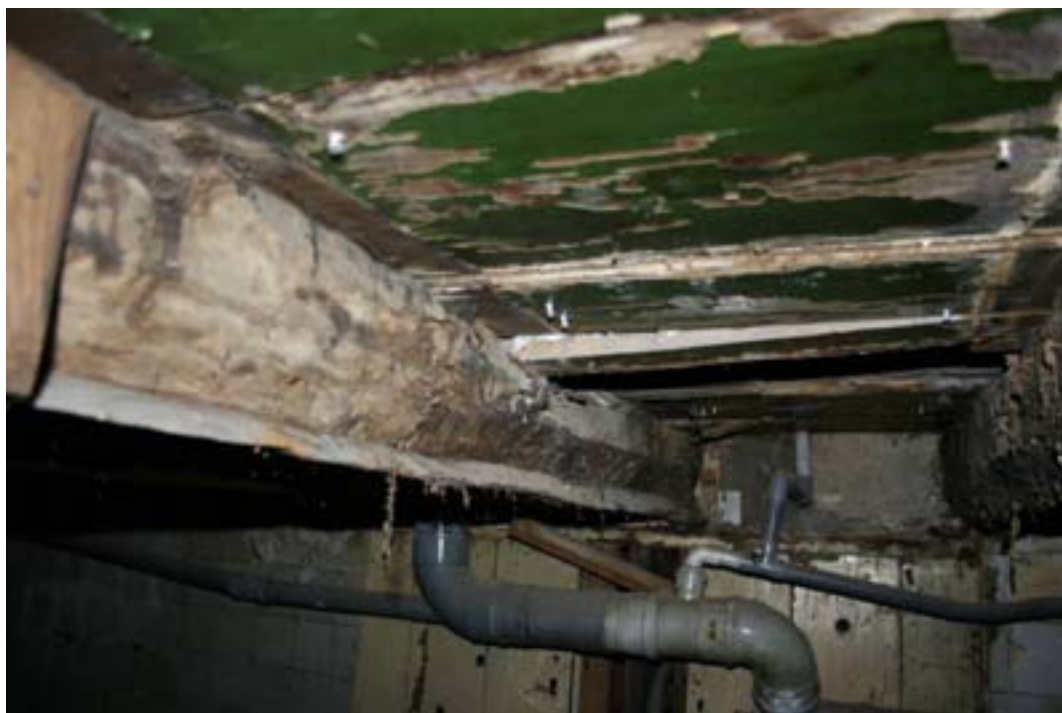
Blik in de kelder met een van de moerbalken die het troggewelf heeft gedragen (foto BMA).
