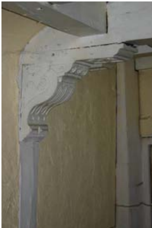
Warmoesstraat 42, zwanenhalskorbelen in het voorhuis (foto's BMA).
