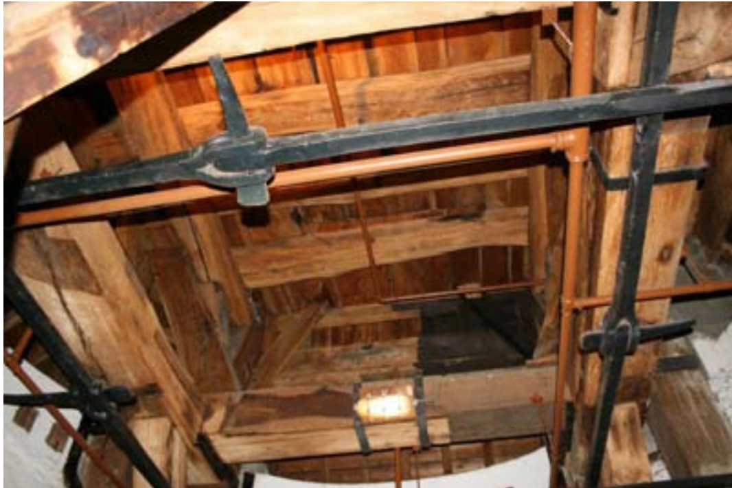
De houten constructie van de Munttoren.
