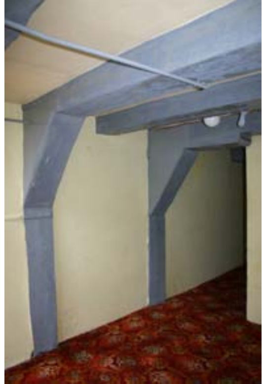
Warmoesstraat 38, kapconstructie van het voorhuis met eiken kromstijlen van rond 1540 (1) en stijlen van dennenhout van rond 1650 (2). Rechts de alternerende constructie van het achterhuis van rond 1555 (foto's BMA).
