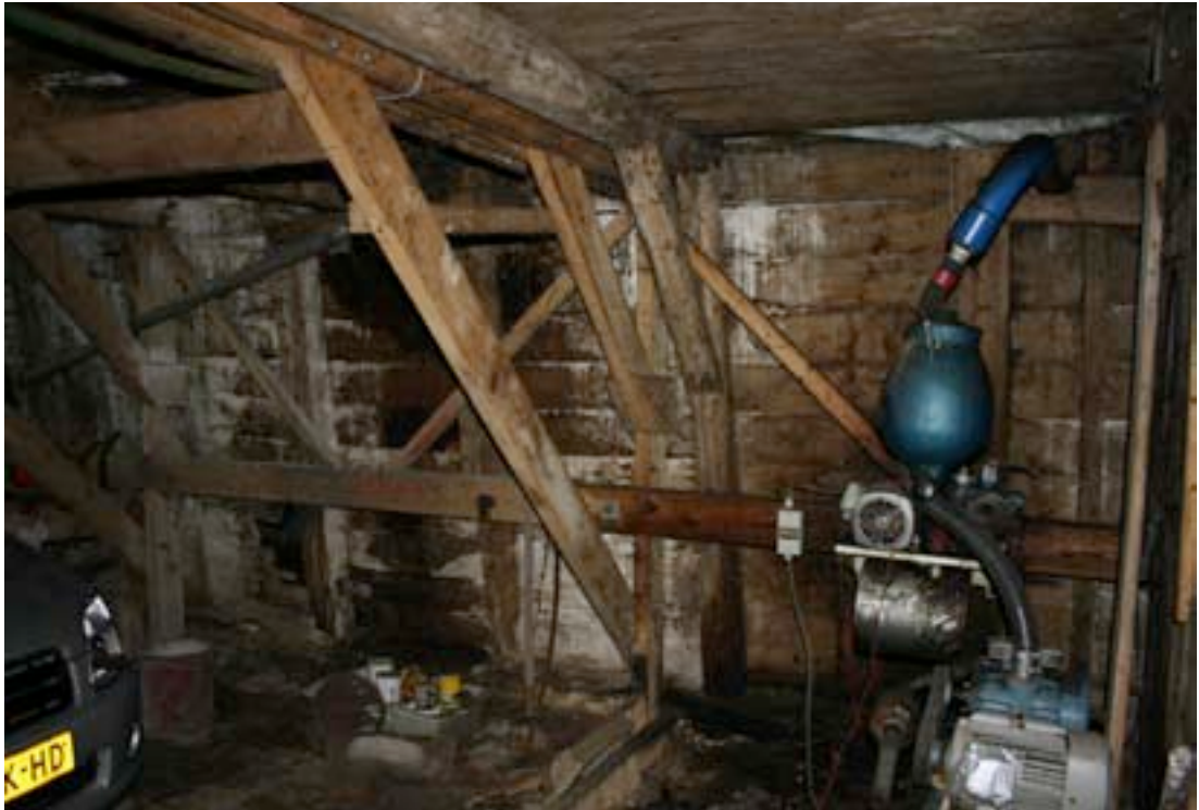
Blik in de noordelijke stal. Dekbalkgebinten met latere steunconstructie.
