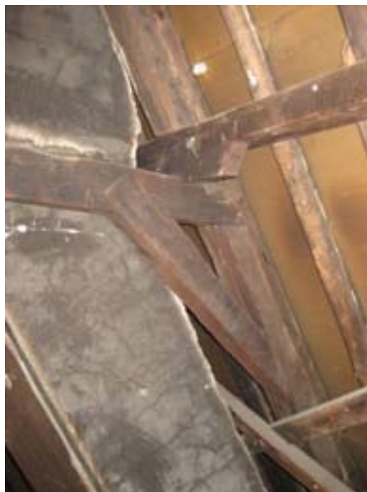
Oudezijds Voorburgwal 14, voorgevel en detail halfhoutse verbindingen op vloeringniveau.
