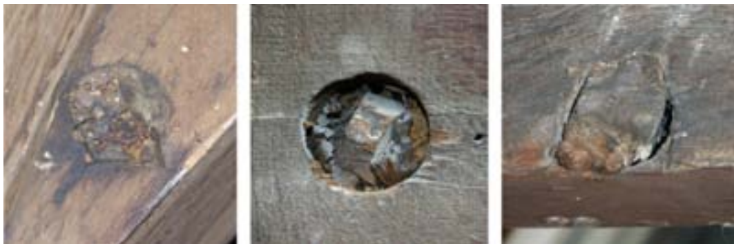
Voorbeelden van zeventiende-eeuwse vlotverbindingen uit Kloveniersburgwal 95 en Oudezijds Voorburgwal 247.
