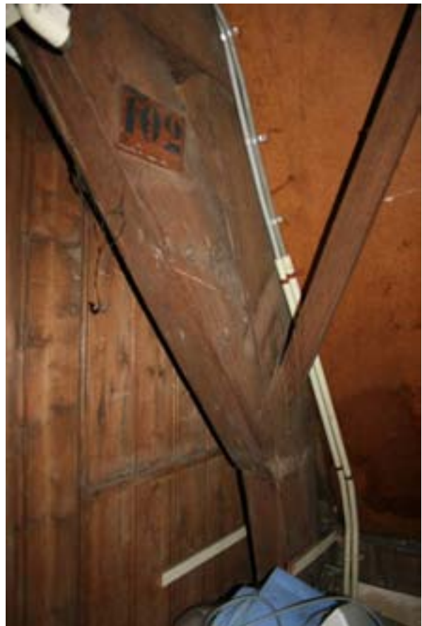
Singel 124, voorgevel en krommer in de kapconstructie (foto's BMA).
