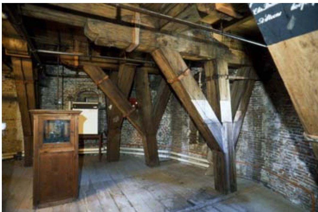
Achttiende-eeuwse steunconstructie in de Montelbaanstoren (foto BMA/ Han van Gool).
