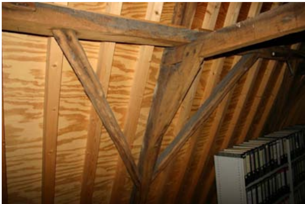
Kloveniersburgwal 47; blik in de kapconstructie van het rechter bouwdeel. De korbelen zijn met halfhoutse verbindingen aan de dekbalken bevestigd.
