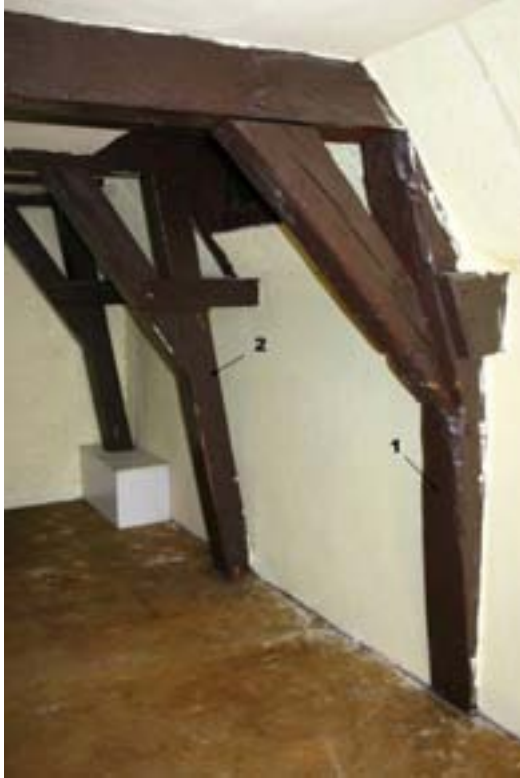
Warmoesstraat 38, kapconstructie van het voorhuis met eiken kromstijlen van rond 1540 (1) en stijlen van dennenhout van rond 1650 (2). Rechts de alternerende constructie van het achterhuis van rond 1555 (foto's BMA).
