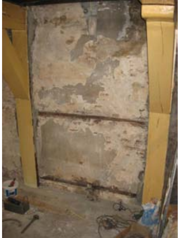
Warmoesstraat 90, rechts de rechter bouwmuur op de eerste verdieping, met regels die waarschijnlijk het restant vormen van een vakwerkwand uit de bouwtijd.
