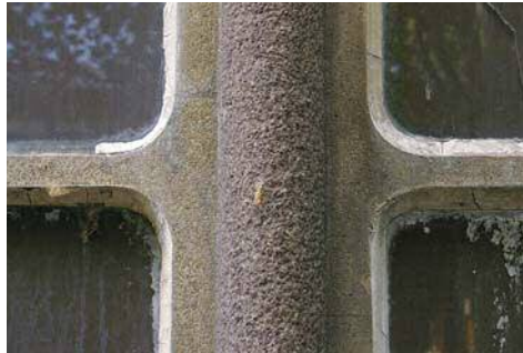
10 ▼ - ROTTERDAM, DETAIL VAN DE RIVIËRAHAL IN DE DIERGAARDE BLIJDDORP MET SCHOKBETON VENSTERS EN LICHT PAARS GEKLEURD SCHOKCRETE SIERBETON.
