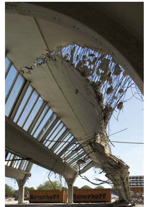
16 – HENGELO, SLOOP VAN DE SHEDSCHALEN VAN DE KON. WEEFGOEDERENFABRIEK, 2008. FOTO 2008 JAAP KROMMENDIJK
