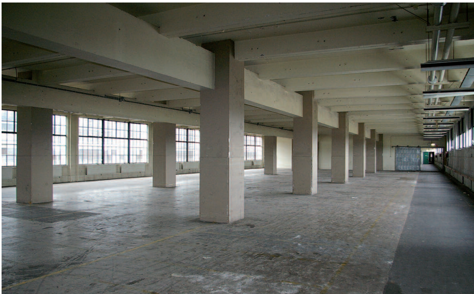
10 – EINDHOVEN, HENNEBIQUE-CONSTRUCTIE IN PHILIPSGEBOUW SBP OP FABRIEKSCOMPLEX STRIJP UIT 1930. FOTO 2008
