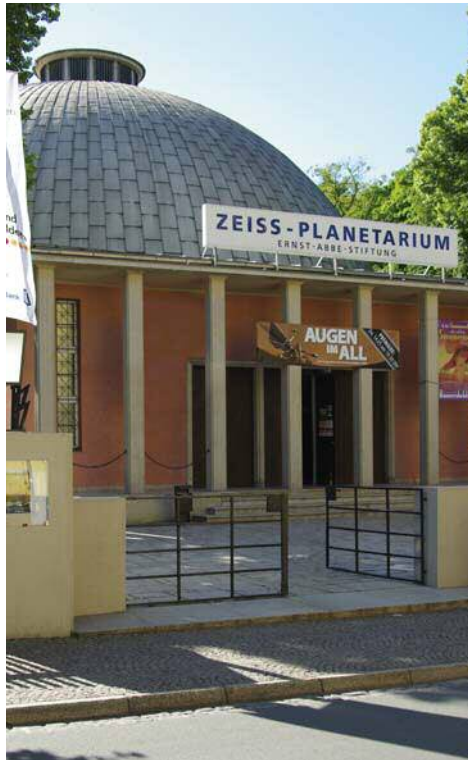
2 – JENA, PLANETARIUM GEBOUWD VOLGENS HET ZEISS-DYWIDAG-SYSTEEM, 1926.
