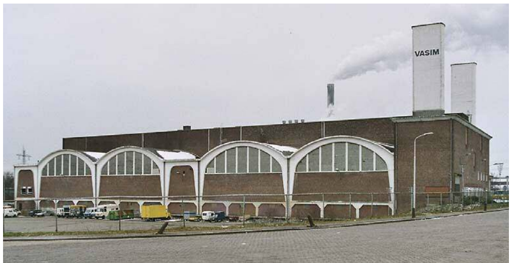
4 – NIJMEGEN, CONTINUESPINNERIJ VAN DE NYMA MET TWEE KEER VIER TONSCHALEN, 1948.
