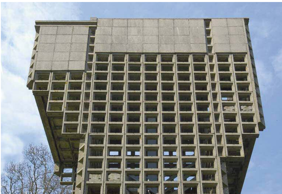
12 - OUDEMIRDUM, LUCHTWACHTTOREN VOLGENS HET RAAT-SYSTEEM, 1953. FOTO 2009
