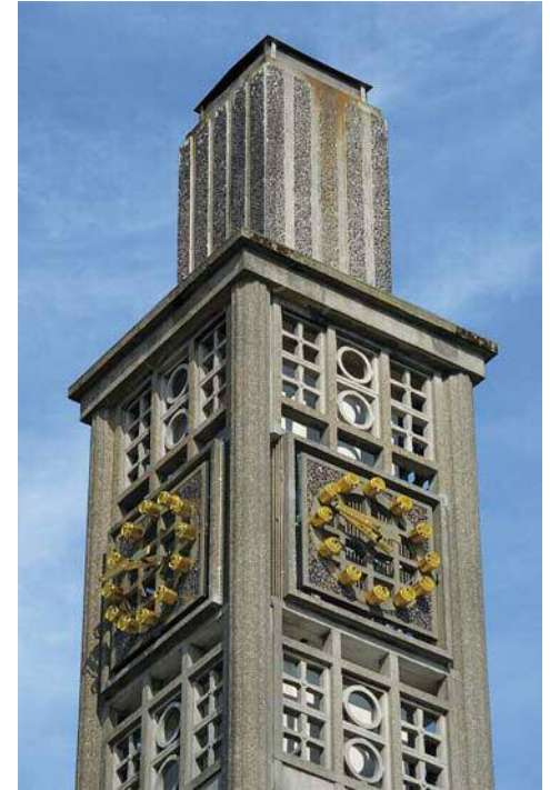
10 ▼ - ROTTERDAM, DETAIL VAN DE RIVIËRAHAL IN DE DIERGAARDE BLIJDDORP MET SCHOKBETON VENSTERS EN LICHT PAARS GEKLEURD SCHOKCRETE SIERBETON.
