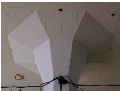
12 – ROTTERDAM, VAN NELLE FABRIEK UIT 1926-1930, DETAIL VAN EEN PADDENSTOELVLOER. FOTO 2008
