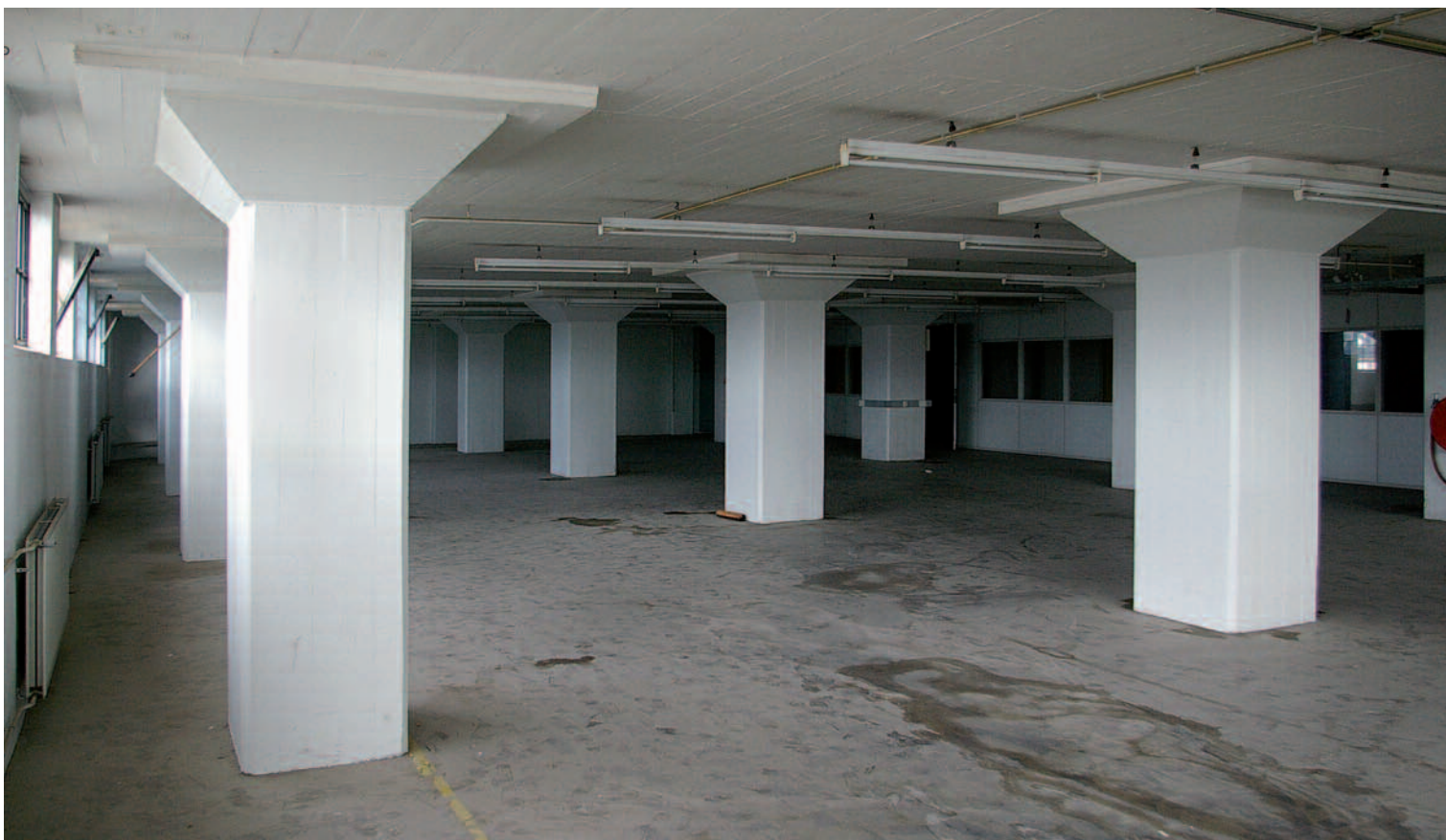
13 – EINDHOVEN, PADDENSTOELVLOERCONSTRUCTIE IN VEEMGEBOUW (GEBOUW SBM) OP FABRIEKSCOMPLEX STRIJP S VAN PHILIPS UIT 1941-1942. FOTO 2008
