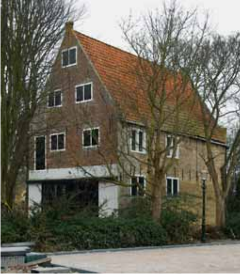
12 Speicher Paktuinen 12 des Kleinkrämers Jacob Moll, der als einziges Gebäude des ganzen Blockes F33 alle Abrisswut überstanden hat. Foto Ronald Stenvert
