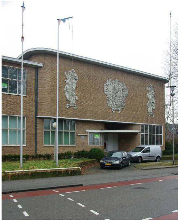
Afb. 10: Voorgevel met stalen vensters van de KRO-studio te Hilversum uit 1936-1939
