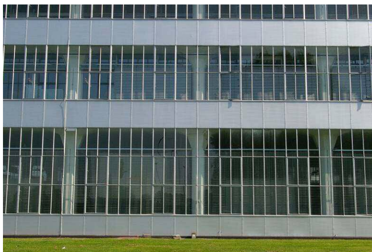
Afb. 7: Vliesgevel van stalen ramen met daarachter de paddestoelvloer van de Van Nellefabriek te Rotterdam uit 1926-1930
