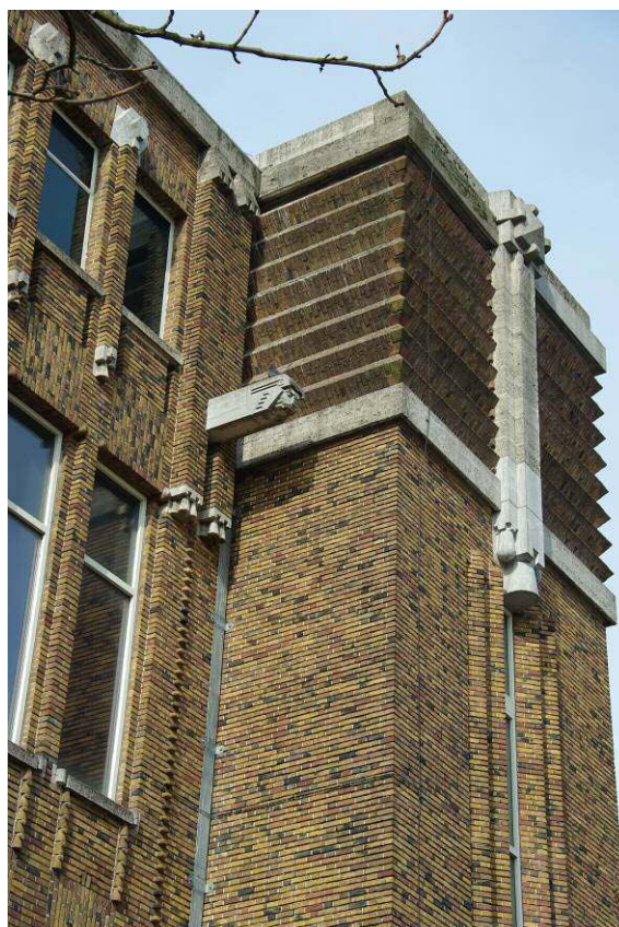
Afb. 5: Deel van het trappenhuis van hoofdkantoor te Utrecht uit 1918-1924
