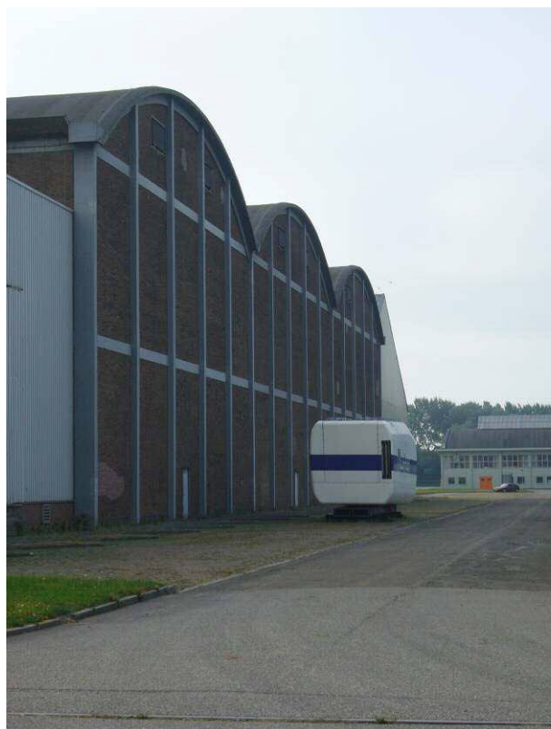
Afb. 17: Dunne tonschalen van de driebeukige strooloods voor de Algemene Kunstzijde Industrie te Arnhem uit 1942.
