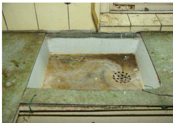
Afb. 15: Deel van het aanrecht met gietijzeren wasbak en asbesten aanrechtblad van de kampcommandantwoning te Westerbork uit 1939
