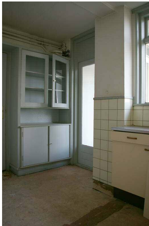
Afb. 9: Deel van een keuken met een vloer van houtcement in het flatgebouw Ungerplein 2 te Rotterdam uit 1932-1933.
