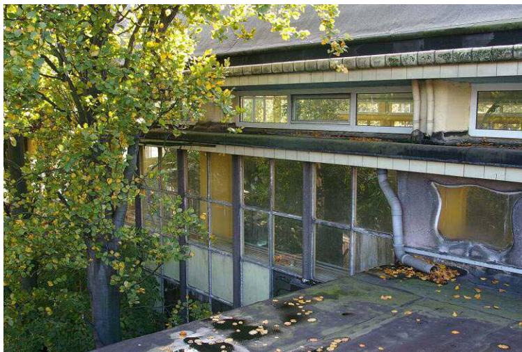
Afb. 18: Deel van de Rivierahal van de Diergaarde Blijdorp te Rotterdam uit 1940 met schokbetonnen vensters en tussenstijlen van Schockcrete
