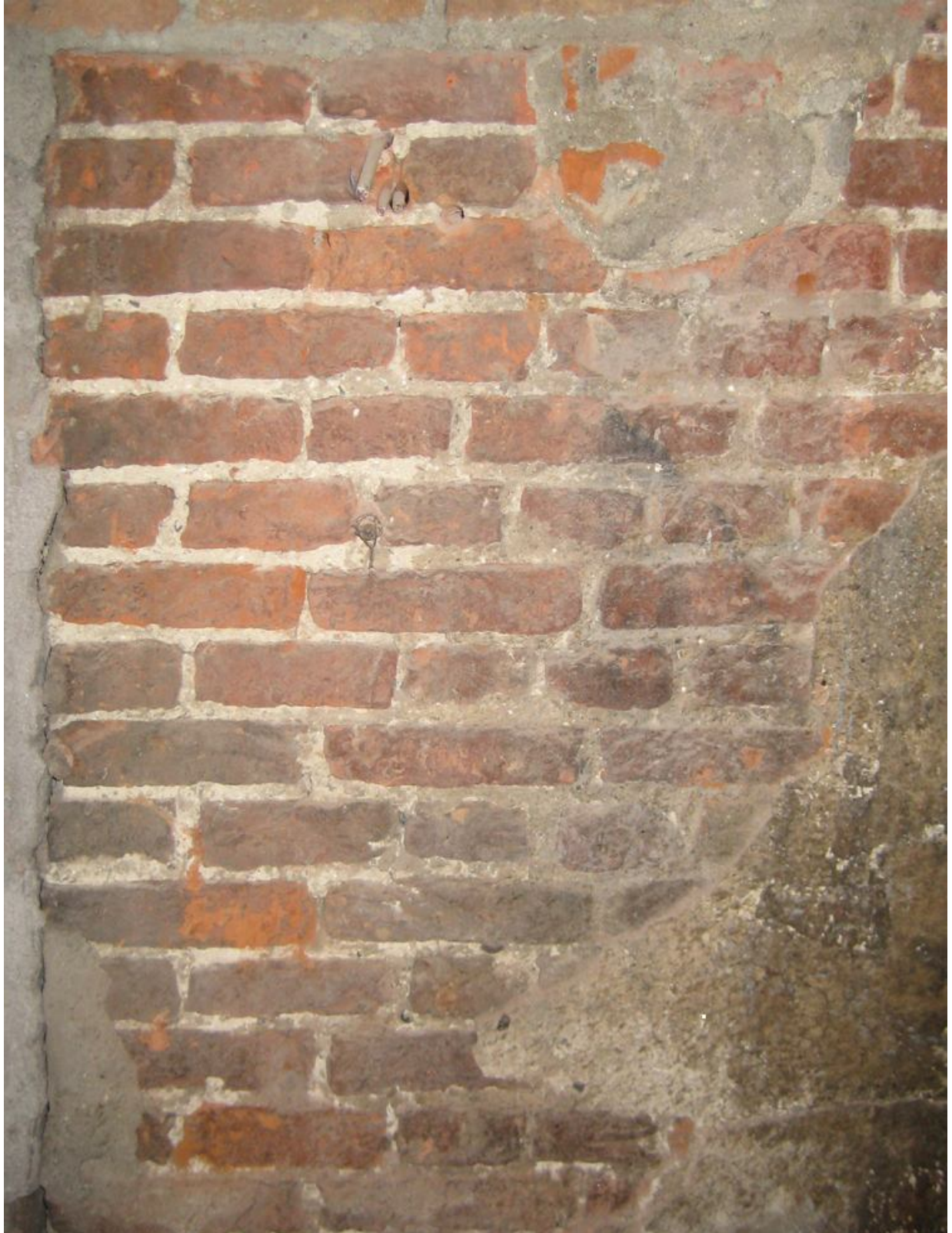
Hooglandsekerkgracht 21 Leiden, zijgevel met drieklezoren in de koppenslagen van het staand verband. [Foto E. Orsel, 2008]
