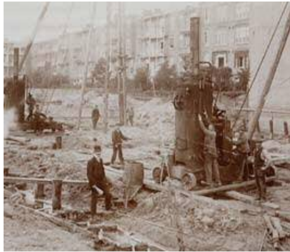
AFB. 2 DE LAIRESSESTRAAT HOEK CONCERTGEBOUWPLEIN IN 1913 TIJDENS DE HEIWERKZAAMHEDEN TEN BEHOEVE VAN DE BOUW VAN HET KANTOOR VAN DE NEDERLANDSCH-INDISCHE MAATSCHAPPIJ
