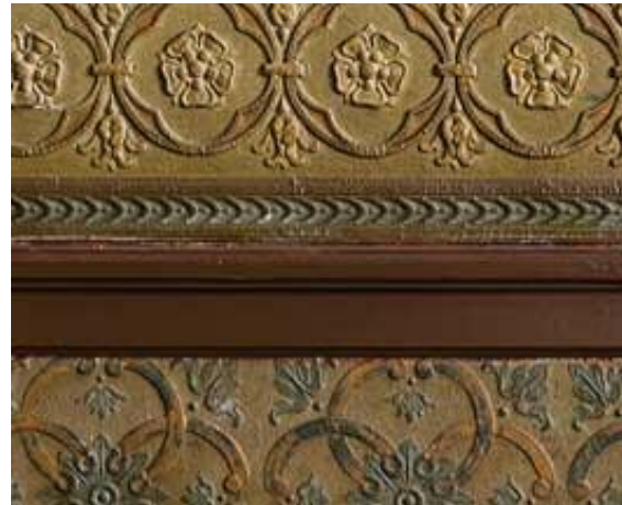
AFB. 7 PAULUS POTTERSTRAAT 44, LAMBRISERING VAN LINCRUSTA, EEN IN RELIËF GEPERSTE LINOLEUMVARIANT
