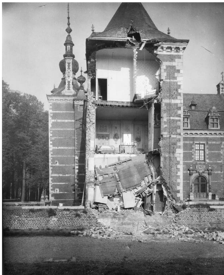
1. Deel van de oostgevel van kasteel Eijsden uit 1636, na instorting van een deel van de muur in 1952 waardoor ongepland voor een deel de scheiding tussen openbaar en privé tijdelijk werd opgeheven
