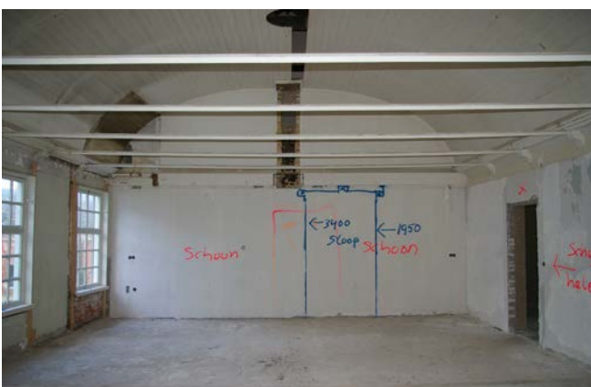
15. De oostelijke slaapzaal op de verdieping van het Academiegasthuis in Franeker tijdens de verbouwing van 2007 met zichtbare bouwsporen en aanwijzingen voor de aannemer (foto rs)
